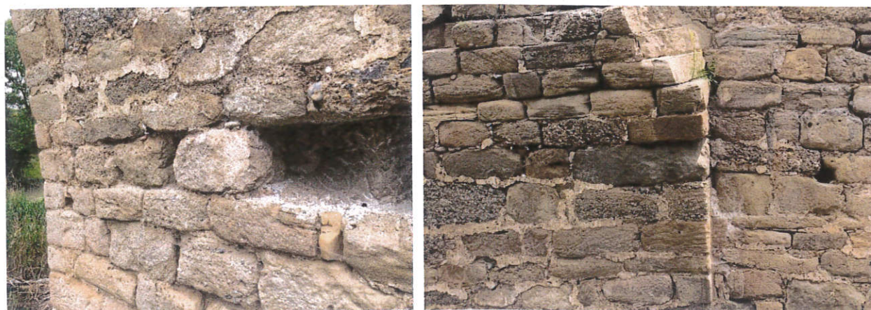
Σχήμα 2.1: Ενδεικτικές φωτογραφίες στις οποίες διακρίνεται ο τρόπος δόμησης των εξωτερικών παρειών των βάθρων της γέφυρας.
