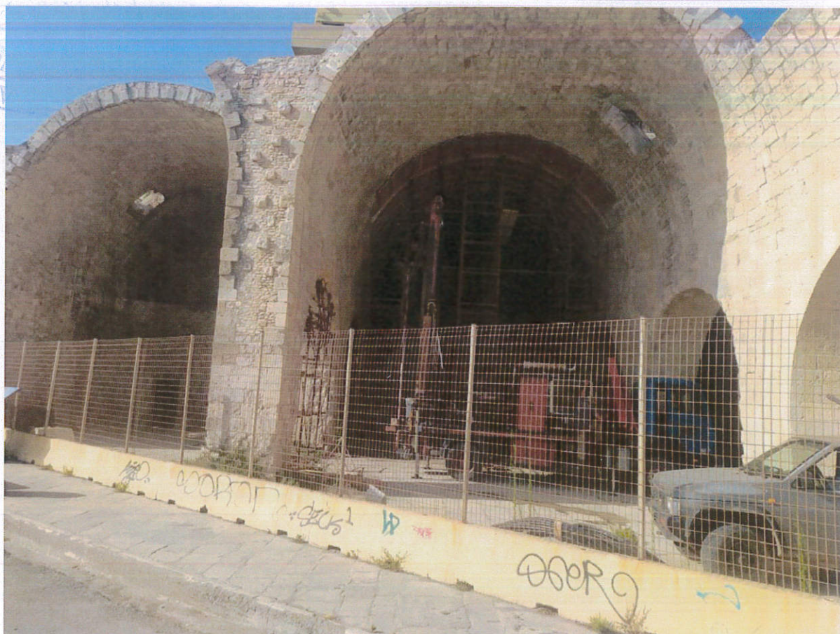
Γεώτρηση Γ1 - ΔΥΤΙΚΑ ΝΕΩΡΙΑ
