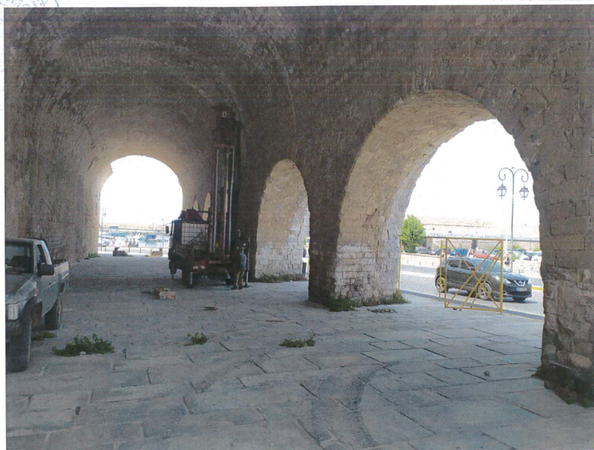
Γεώτρηση Γ1 - ΑΝΑΤΟΛΙΚΑ ΝΕΩΡΙΑ
