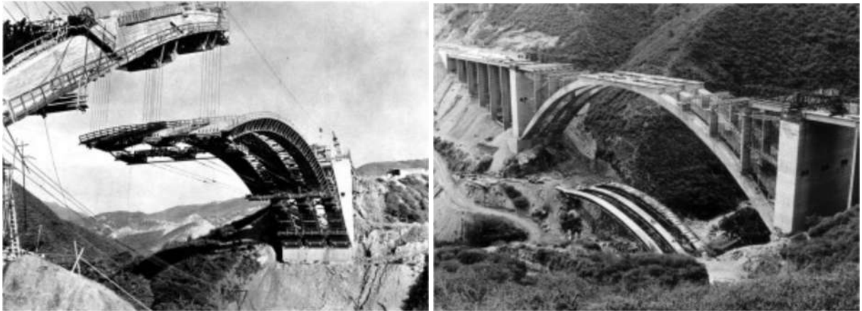
Εικ. 9 Ξυλότυπος με περιστροφή-ανάρτηση-ανέλκυση, Γέφυρα La Guaira - Βενεζουέλα (1953)
