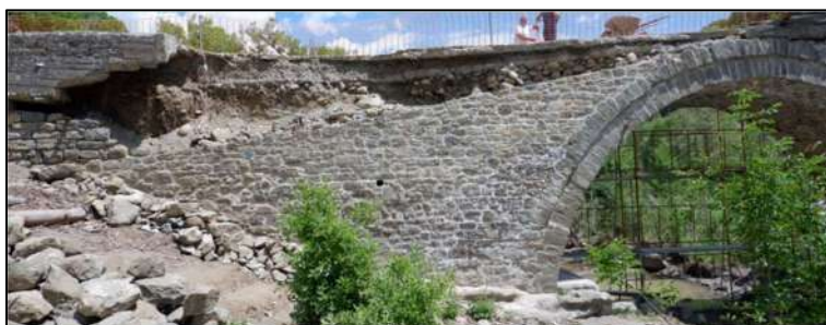
Εικ. 8 Επεμβάσεις στα ακρόβαθρα της γέφυρας.
