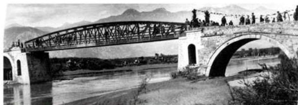
Γέφυρα Αλαμάνας π. Σπερχειού 1930 Φωτογραφία: Γιώργος Παπακώστας, πηγή: Νίκος Δαβανέλος, «ΛΑΜΙΑ, το χρονικό της πόλης»
