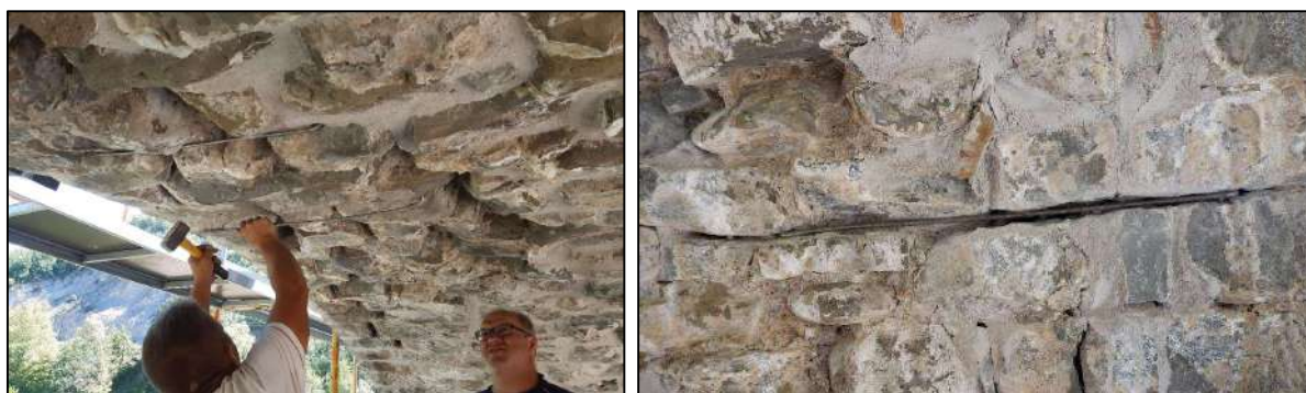
Εικ. 40 Επισκευή και ενίσχυση ρωγμών.
