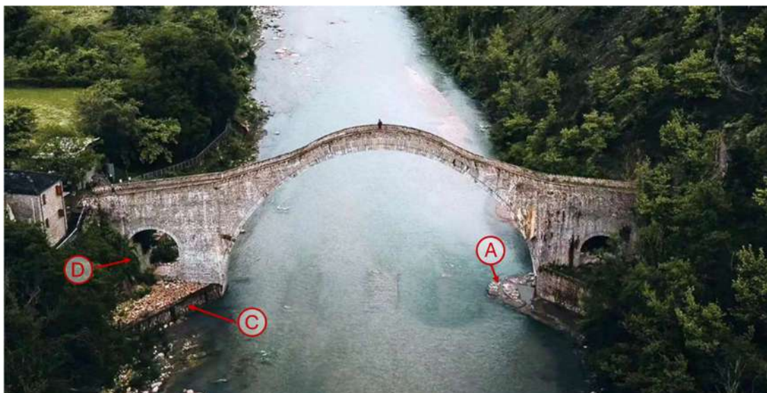
Εικόνα 4.17 Η γέφυρα μετά την αποκατάσταση της - Όψη Ανάντη (φωτογραφία: ΤΑΚΗΣ).
