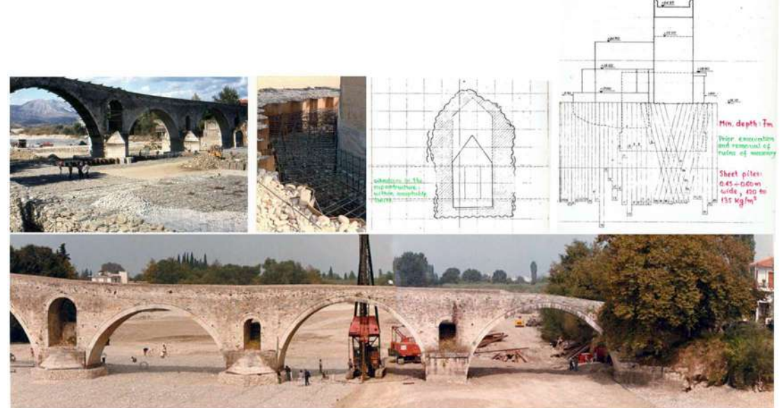
Εικόνα 6.2 Μέτρα αποκατάστασης ιστορικής γέφυρας Άρτας (πηγή: Αρχείο Καλλίεργος ΟΤΜ Α.Ε.)
