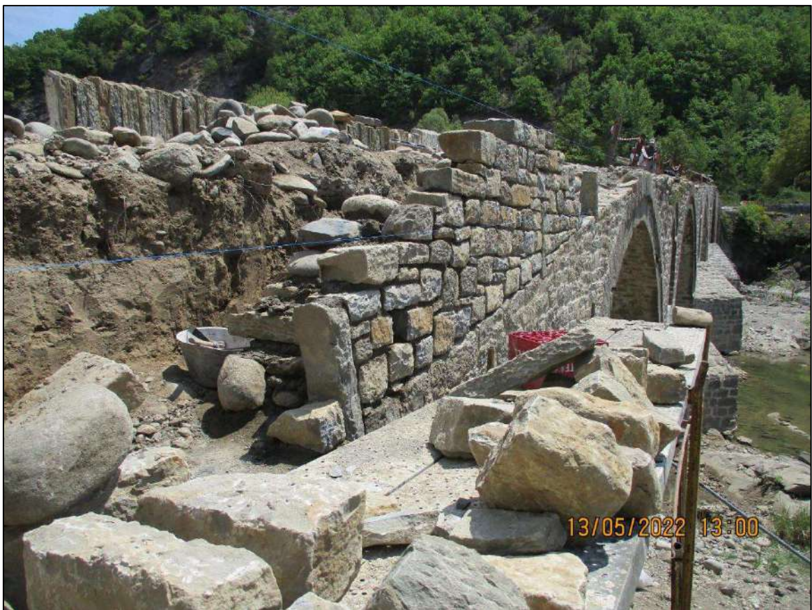
Εικ. 39 Καθαίρεση και εκ νέου κατασκευή πρόσθετων τμημάτων.
