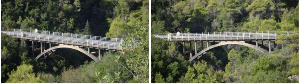
Εικ. 29 Γέφυρα Κοσκάραγας (1920).
