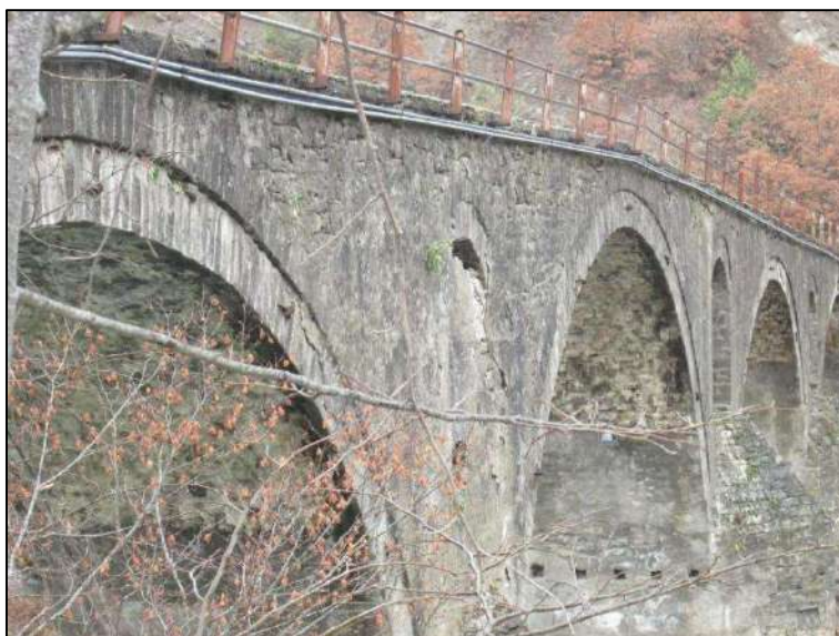
Εικ. 14 Οι Καμάρες της γέφυρας.
