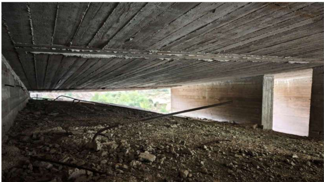
Εικ. 25 Γέφυρα Διποτάμων.
