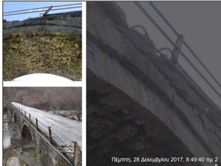
Εικ. 22 Ηλεκτρολογική εγκατάσταση.
