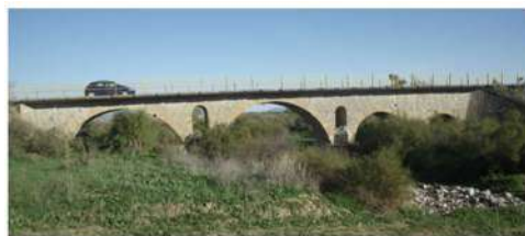
Γέφυρα π. Βοιωτικού Κηφισού προς Μόδι - τέλη 19ου αι.
