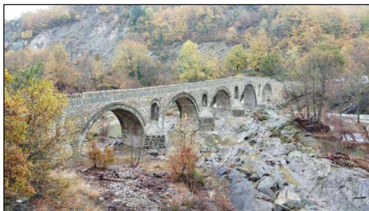
Εικ. 42 Γενική άποψη γέφυρας από ανάντη μετά τις εργασίες.
