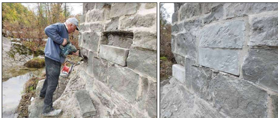
Εικ. 37 Τοπικές εργασίες αντικατάστασης φθαρμένων λίθων.
