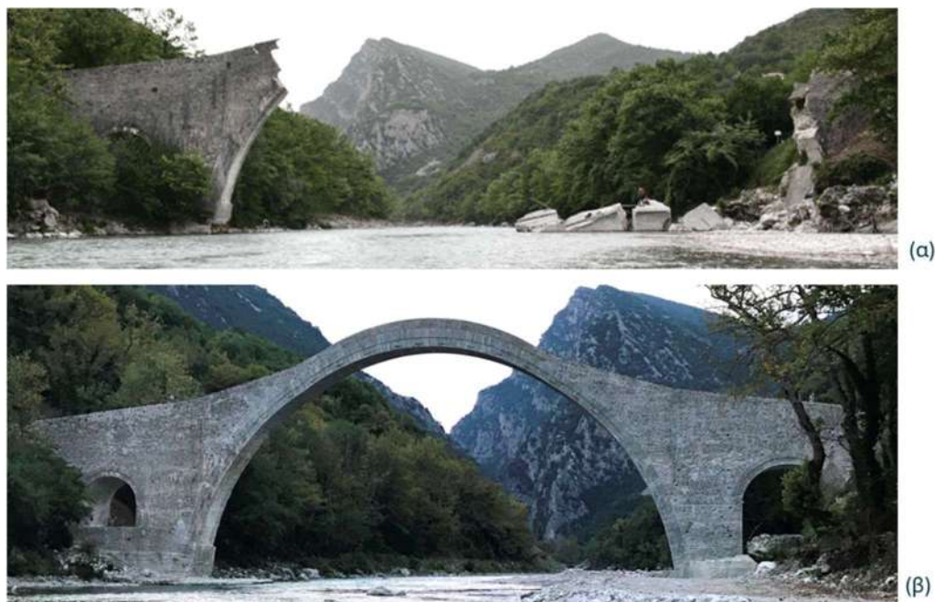
Εικόνα 2.1 Γέφυρα Πλάκας (α) Μάιος 2015 και (β) Αύγουστος 2021, μετά την αποκατάσταση της
