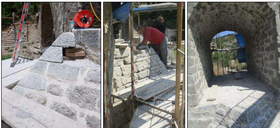
Εικ. 41 Επισκευές εμβόλων και ανακουφιστικών τόξων.
