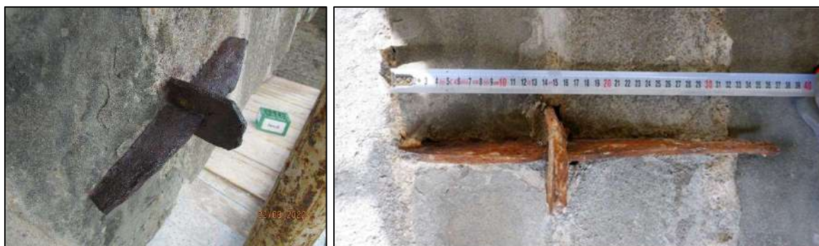
Εικ. 15 Ελκυστήρες γέφυρας.
