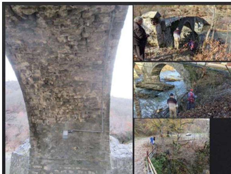
Εικ. 26 Αποδιοργάνωση λιθοδομών.
