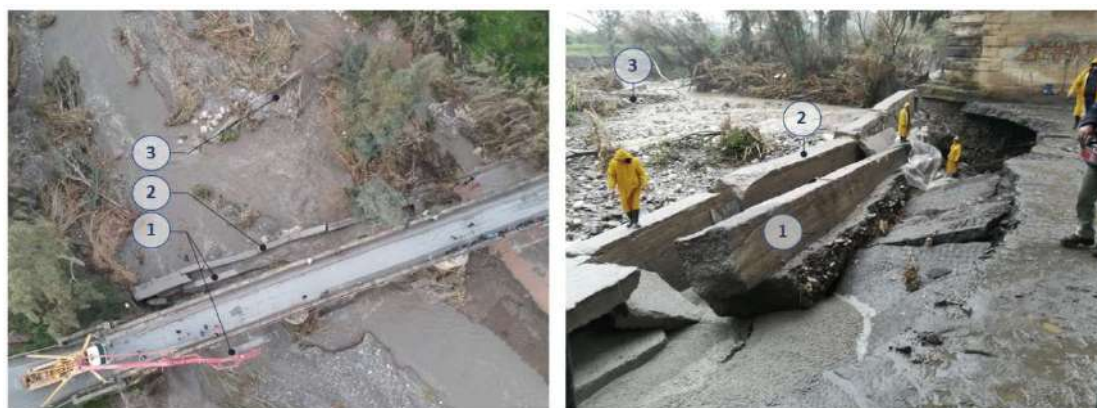
Εικόνα 5.4 Παλαιότεροι χαλινοί εντός της κοίτης οι οποίοι αποκαλύφθηκαν μετά την κακοκαιρία στις αρχές του Φεβρουαρίου 2019: (α) κάτοψη περιοχής γέφυρας και (β) άποψη της περιοχής κατάντη από το δυτικό τόξο (T1). [πηγή: Αρχείο Περιφερειακής Ενότητας Χανίων]
