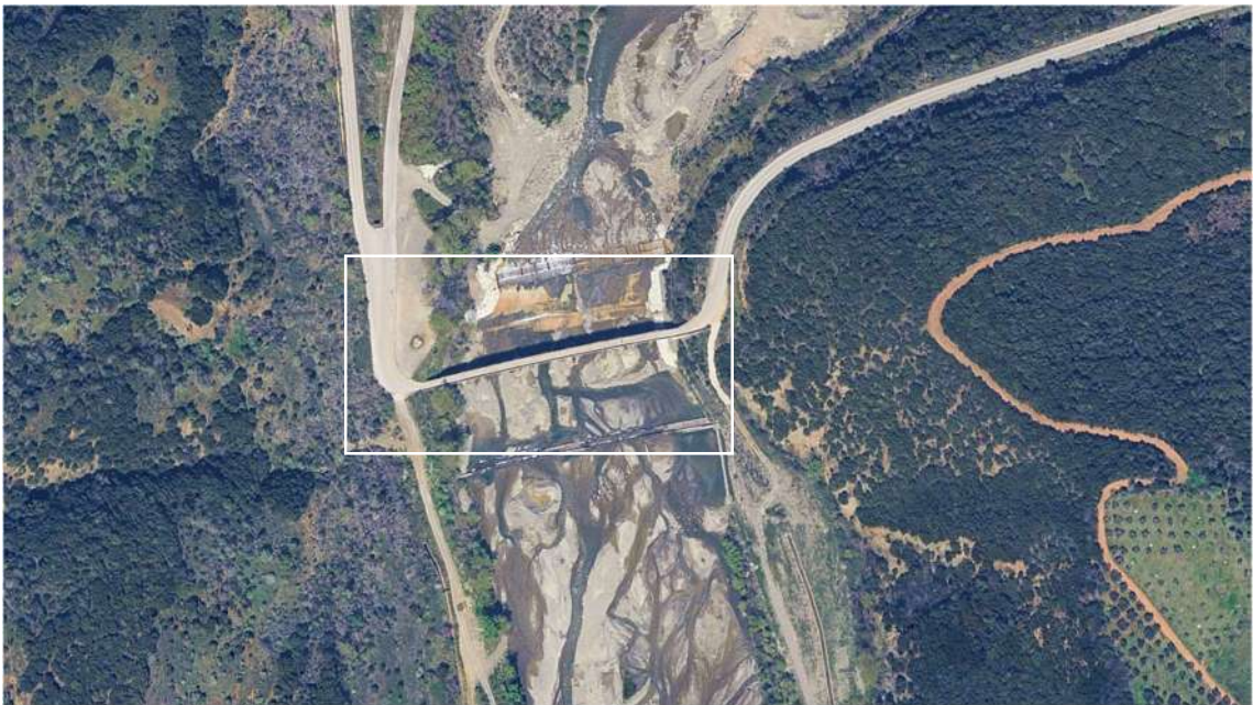
Εικ. 21 Γέφυρα Βίστριζας, Ποταμός Ινάχος, Υπάτη, Επαρχιακή οδός Μακρακώμης-Υπάτης.
