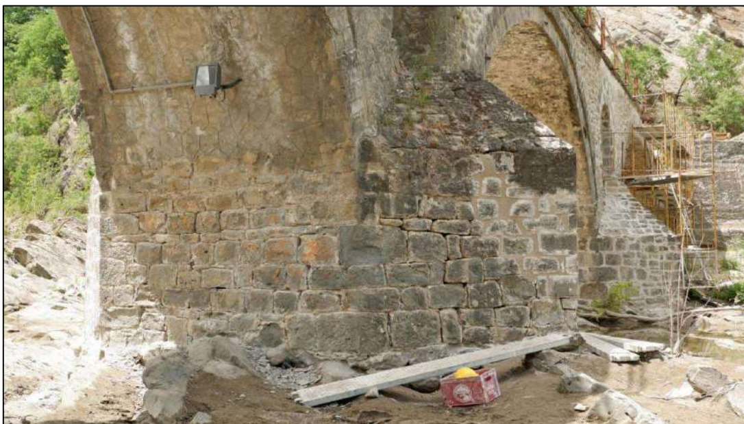
Εικ. 36 Επισκευή και ενίσχυση πλευρικών τοιχοποιιών.
