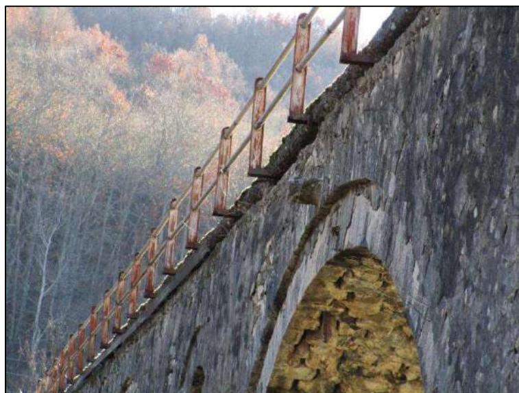
Εικ. 18 Μεταλλικά κιγκλιδώματα.
