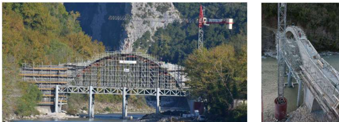
Εικόνα 1.1 Εργασίες αποκατάστασης της ιστορικής Γέφυρας Πλάκας (Οκτώβριος 2019)
