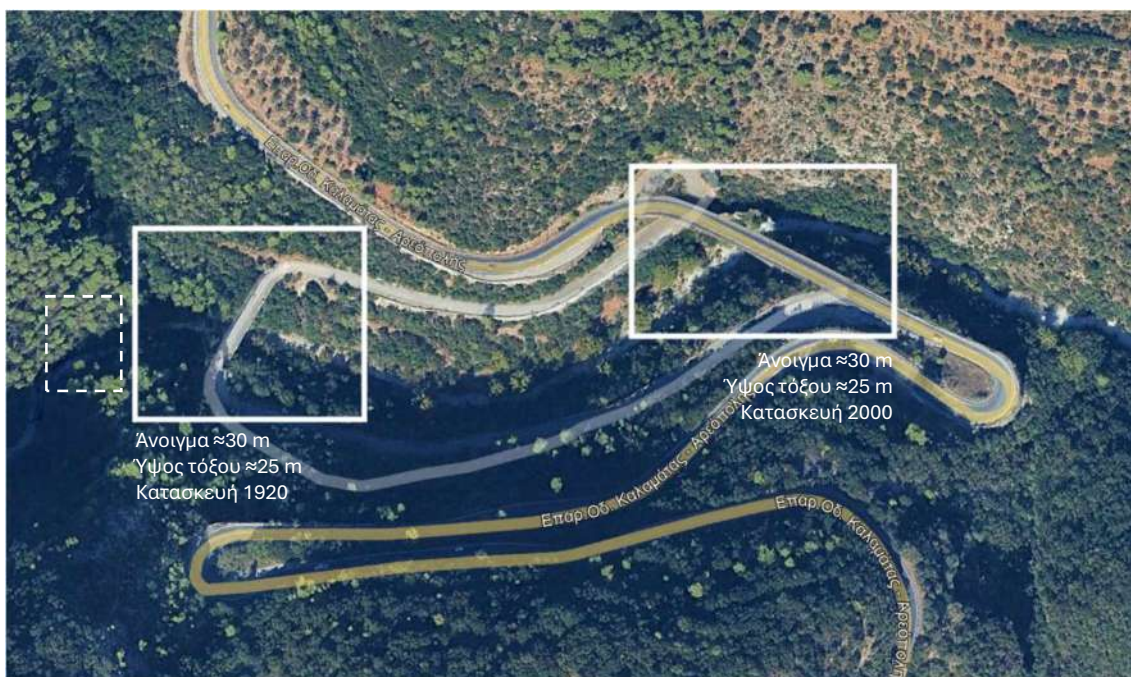
Εικ. 27 Γέφυρες Κοσκάραγας, Ρέμα Μύλοι, Δροσσοπηγή, Επαρχιακή Οδός Καλαμάτας -Αρεόπολης.
