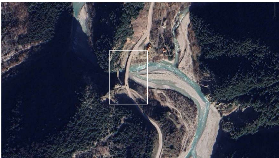
Εικ. 24 Γέφυρα Διποτάμων, Ρέμα Κρικελιώτη, Ευρυτανία, Επαρχιακή οδός Καρπενησίου -Προυσού-Καλλιθέας, Κατασκευή 1993.
