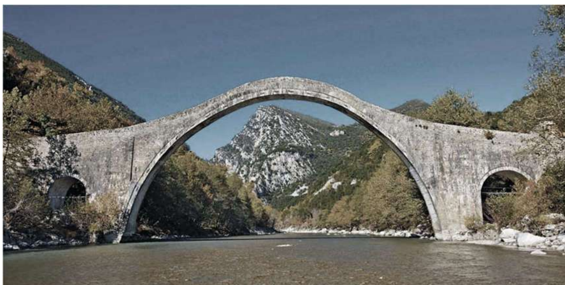
Εικόνα 4.1 Η γέφυρα Πλάκας πριν την μερική κατάρρευσή της τον Φεβρουάριο του 2015 (πηγή: Αρχείο ΕΜΠ)
