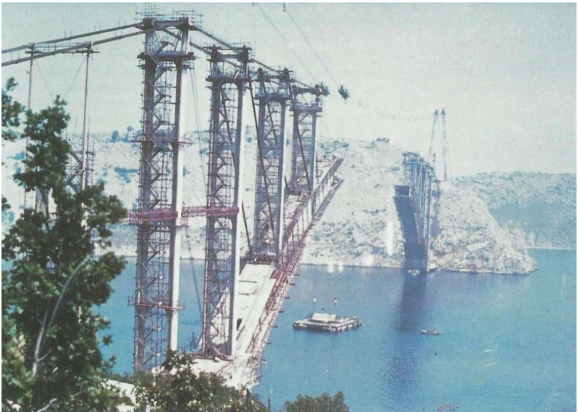
Εικ. 12 Ανάρτηση και προβολοδόμηση, Γέφυρα Krk - Κροατία (1980)
