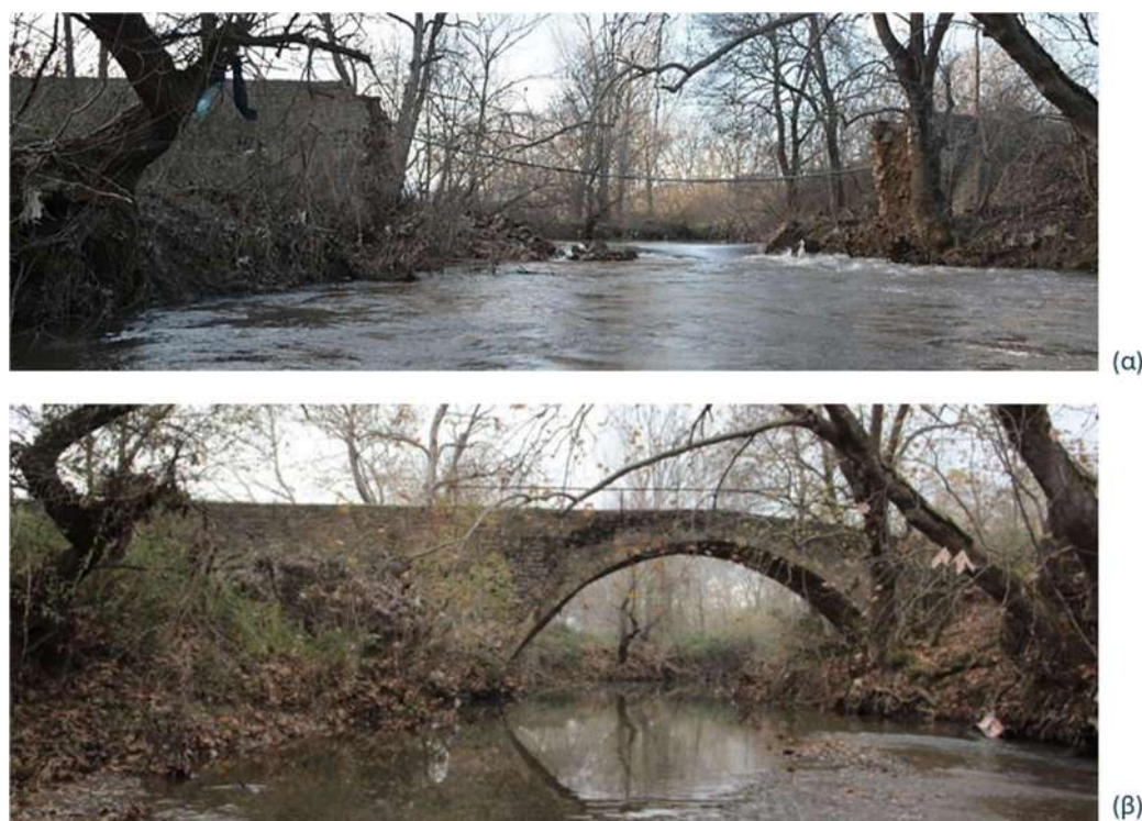
Εικόνα 2.2 Γέφυρα π. Βοιωτικού Κηφισού στην θέση Νερούτσου Μύλος (α) Μάιος 2015 και (β) Αύγουστος 2021, μετά την αποκατάσταση
