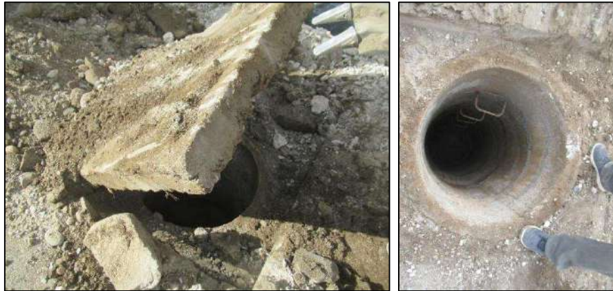
Εικ. 25 Κατασκευή κατακόρυφων φρεατίων.
