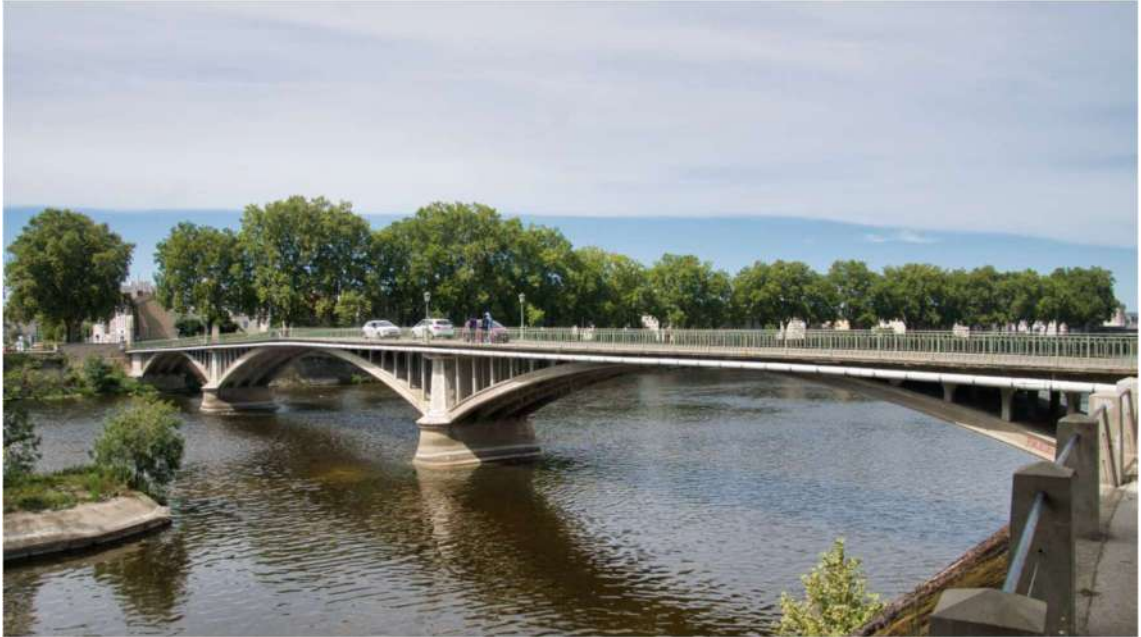
Εικ. 7 Γέφυρα Chatelleraux - Γαλλία (1898)
