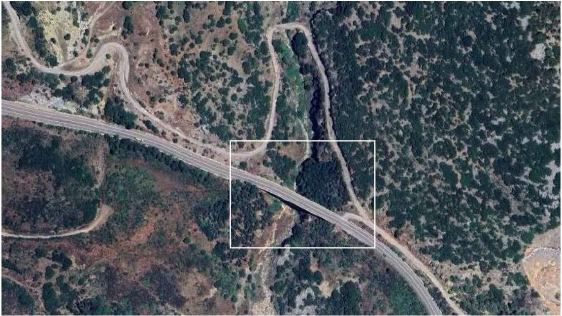
Εικ. 31 Γέφυρα Ζεμενού ή Τούμπρης, Αράχωβα, Εθνική οδός Λιβαδειάς –Αμφισσας.
