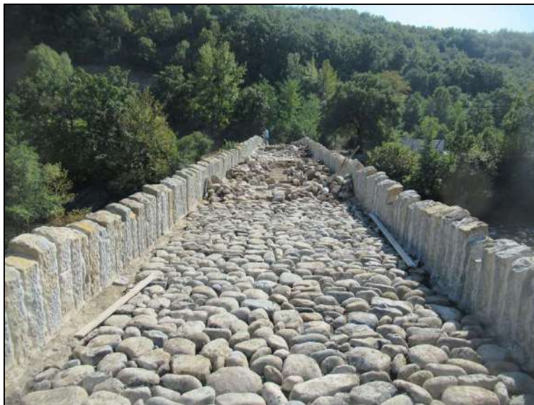
Εικ. 43 Κατασκευή λιθόστρωτου.
