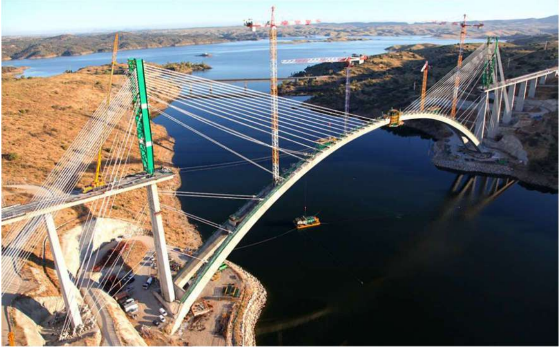
Εικ. 11 Ανάρτηση και προβολοδόμηση, Γέφυρα Almonte-Ισπανία (2016)
