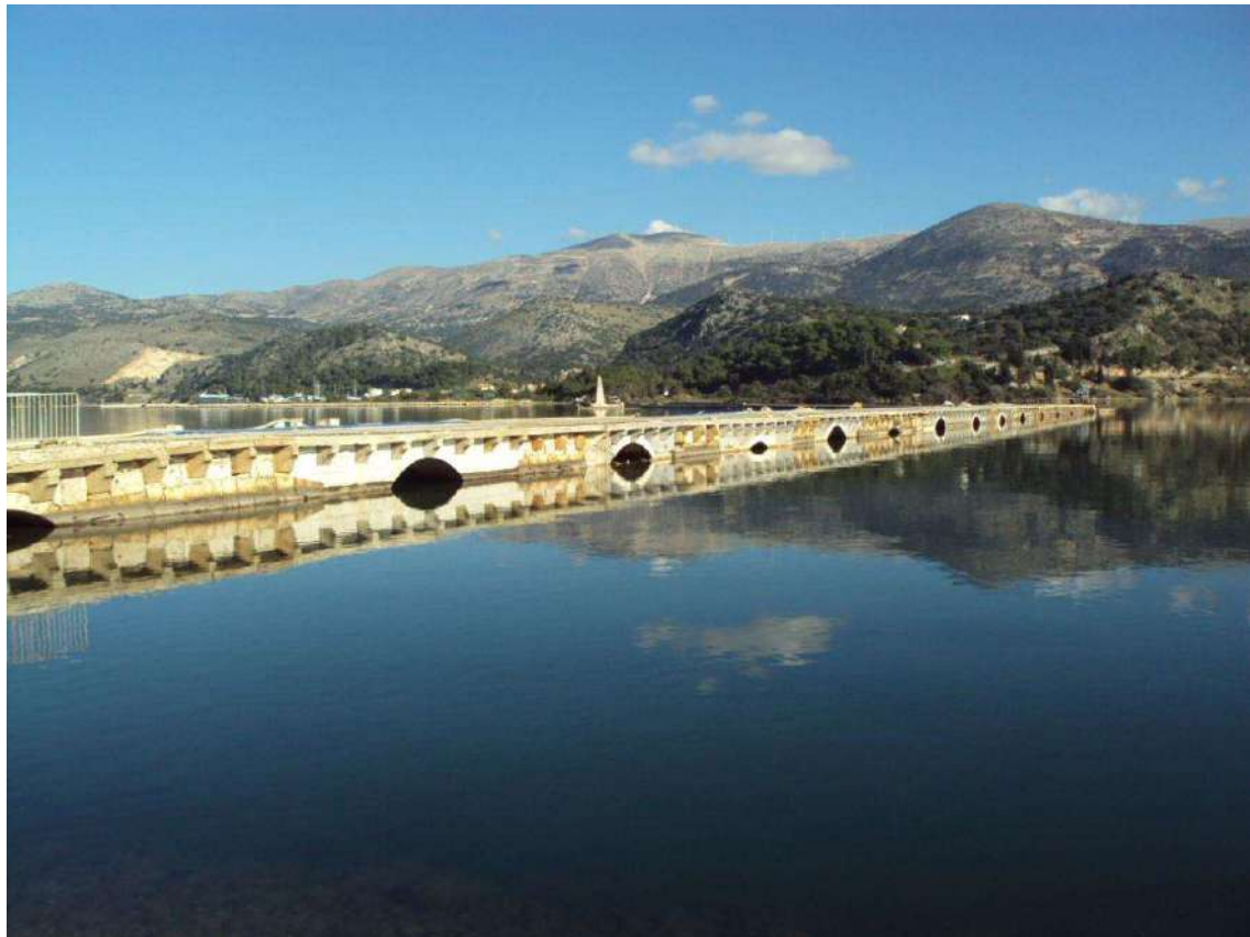
Εικ. 22 Γενική άποψη της γέφυρας κατά την διάρκεια των εργασιών. (Φωτ. Α. Αλεξίου).
