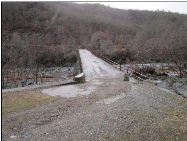
Εικ. 7 Επεμβάσεις στο οδόστρωμα της γέφυρας.
