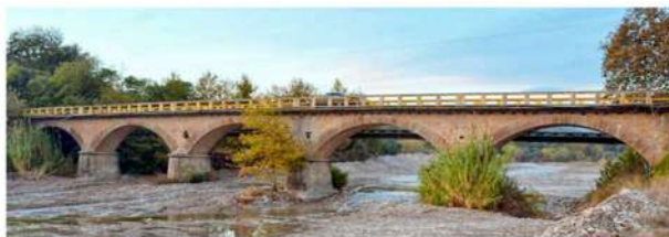
Γέφυρα Αβόρανης (Αγρίνιο) - τέλη 19ου αι.
