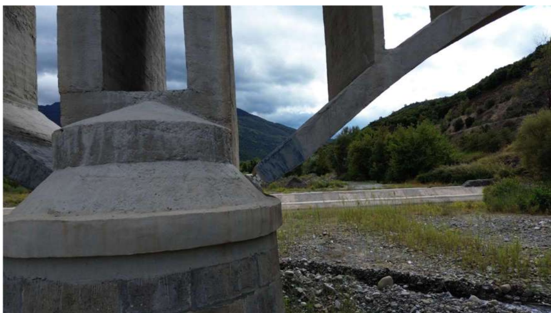
Εικ. 23 Γέφυρα Βίστριζας.
