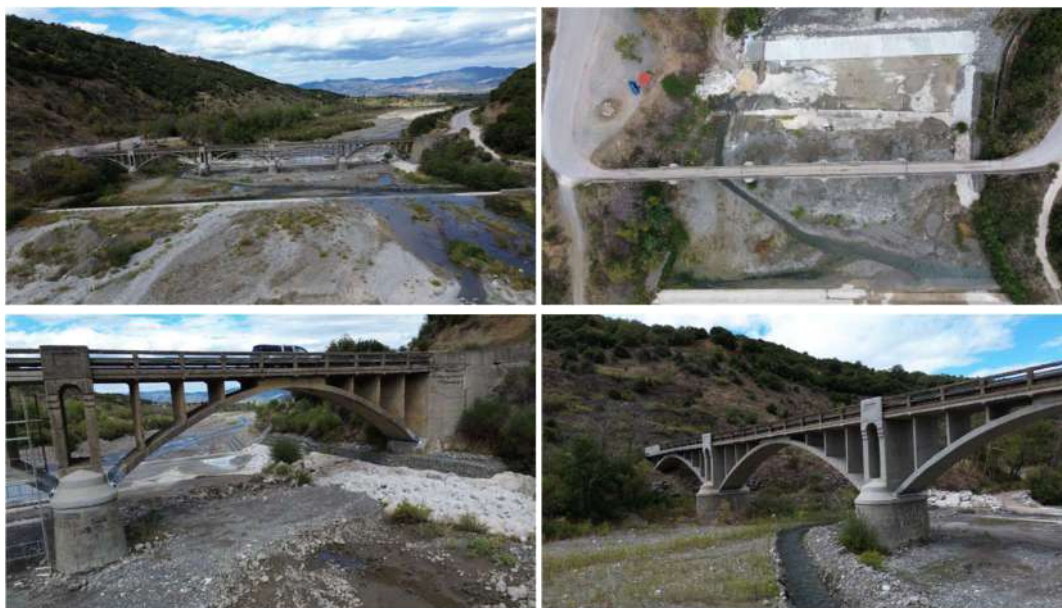
Εικ. 22 Γέφυρα Βίστριζας.
