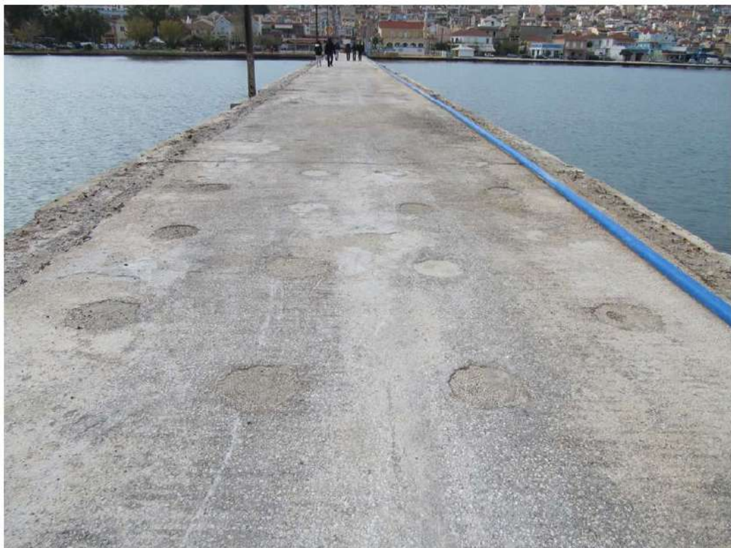
Εικ. 20 Οι απολήξεις των πασσάλων επί της πλάκας του οπλ. σκυροδέματος.
