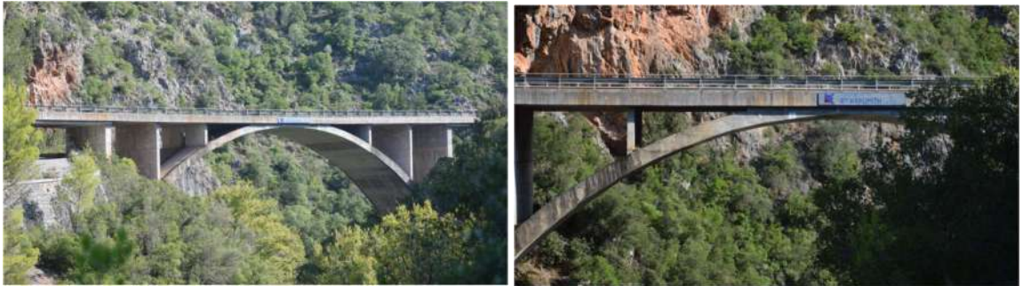
Εικ. 30 Γέφυρα Κοσκάραγας (2000).
