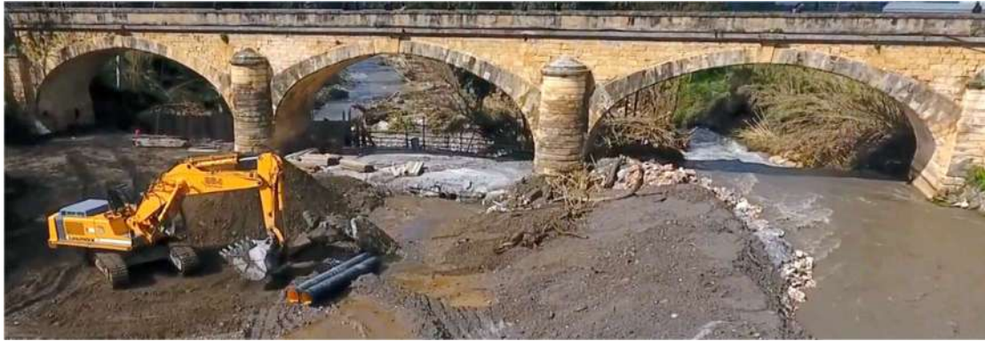
Εικόνα 5.5 Εργασίες επέμβασης στην κοίτη στα μέσα του Φεβρουαρίου 2019 κατά τις οποίες η δίαιτα του ποταμού εξυπηρετούνταν από το ανατολικό άνοιγμα.
