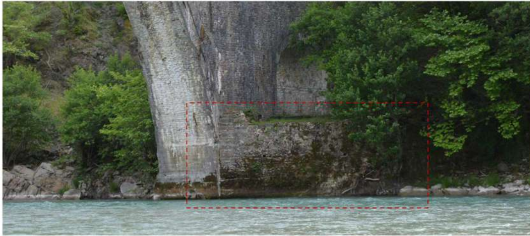
Εικόνα 4.13 Τοίχος για την υδραυλική προστασία του δυτικού βάθρου της γέφυρας Πλάκας.
