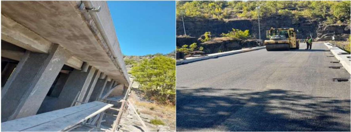
Εικ. 20 Γέφυρα Ελευθοχωρίου.
