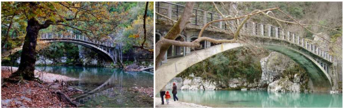
Εικ. 17 Γέφυρα Αρίστης
