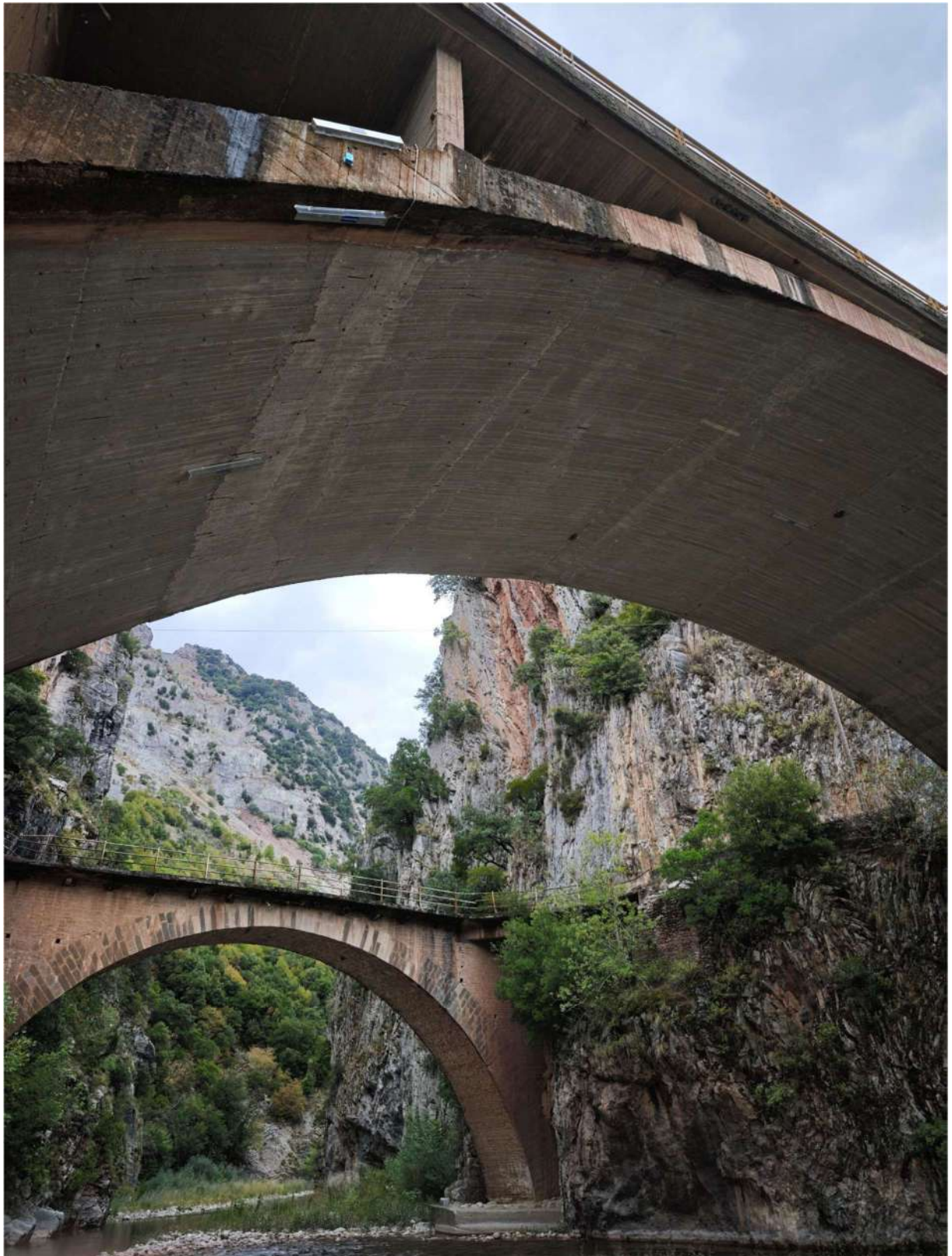
Εικ. 26 Γέφυρα Διποτάμων.
