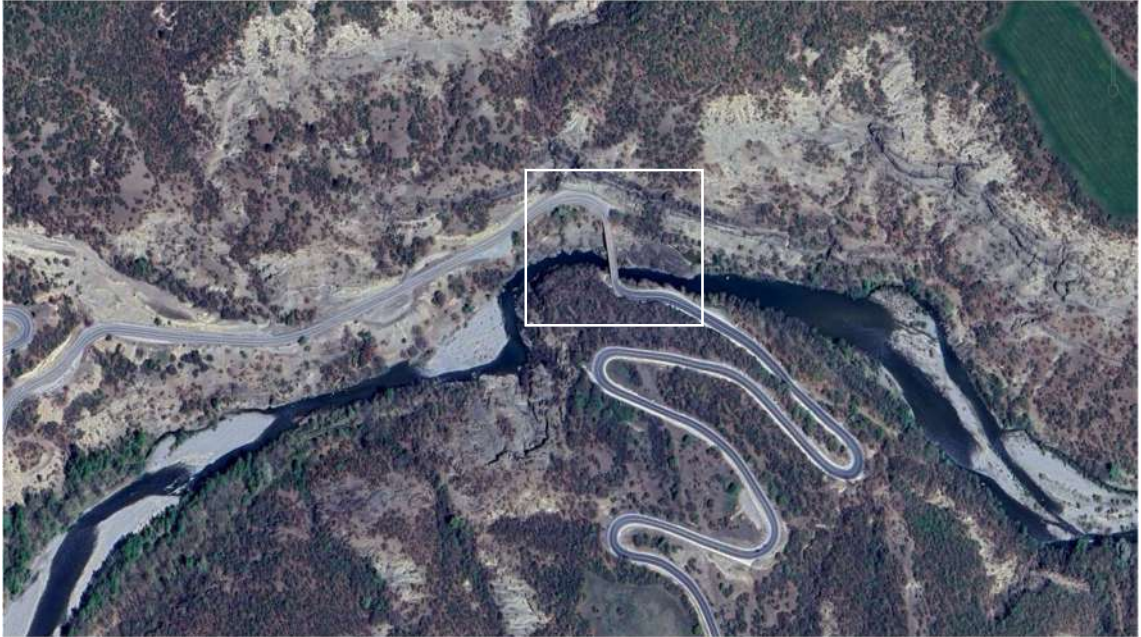
Εικ. 18 Γέφυρα Ελευθεροχωρίου, Ποταμός Βενέτικος, Γρέβена, Εθνική οδός Καλαμπάκας-Γρεβενών, Κατασκευή δεκαετία 1950.
