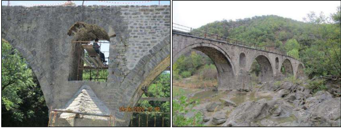
Εικ. 16 Τοιχοποιίες της γέφυρας.
