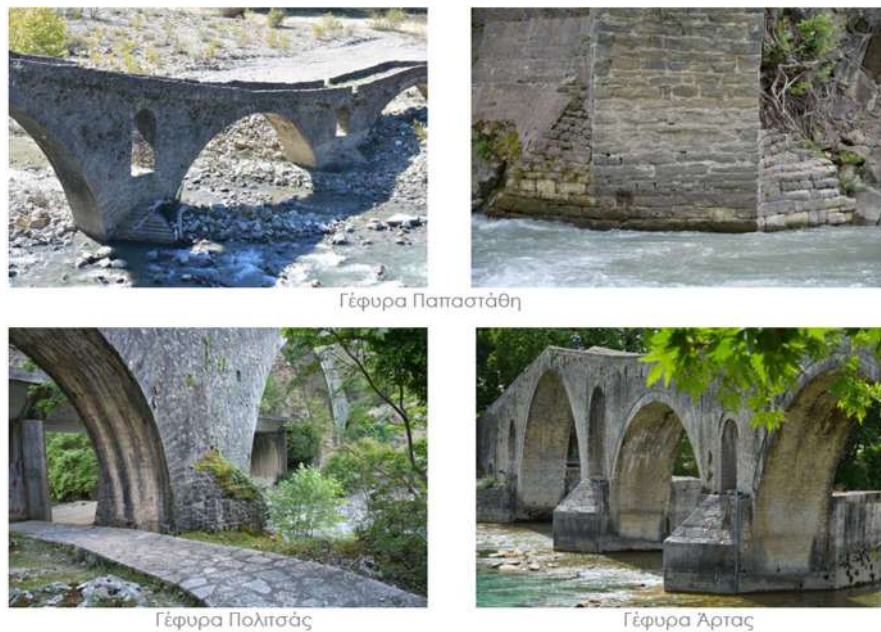
Εικόνα 4.12 Διατάξεις υδραυλικής προστασίας (προρίνια και μεταρίνια) σε όλα τα βάθρα των ιστορικών λίθινων γεφυρών του π. Αράχθου
