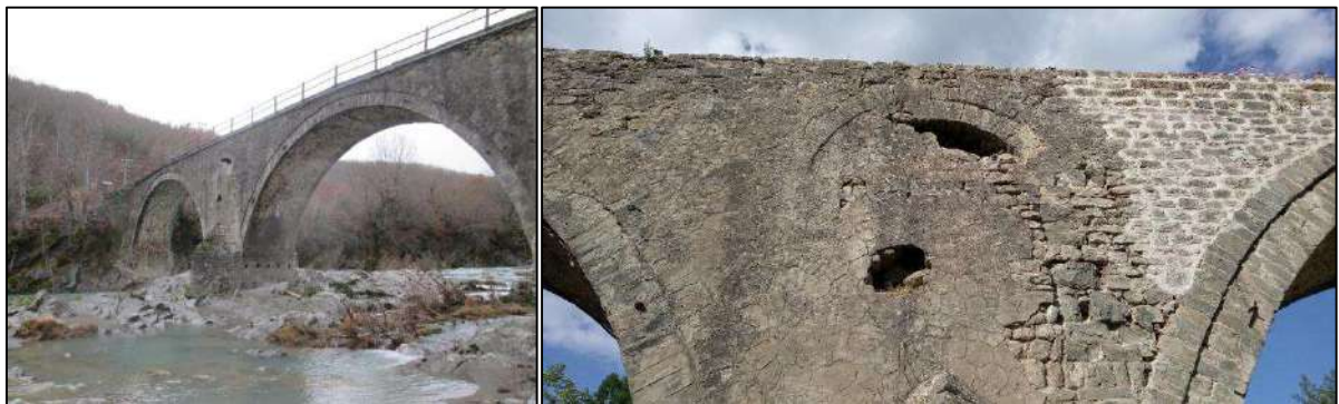
Εικ. 21 Σφράγιση ανοιχτών μετώπων.
