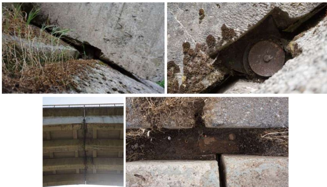
Εικ. 37 Γέφυρα Καρύταινας, πρόβλεψη τριαρθρωτού τόξου.
