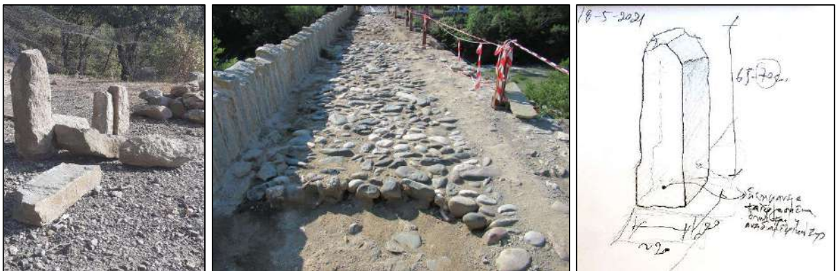
Εικ. 17 Αρκάδες και το λιθόστρωτο δάπεδο οδοστρώματος.
