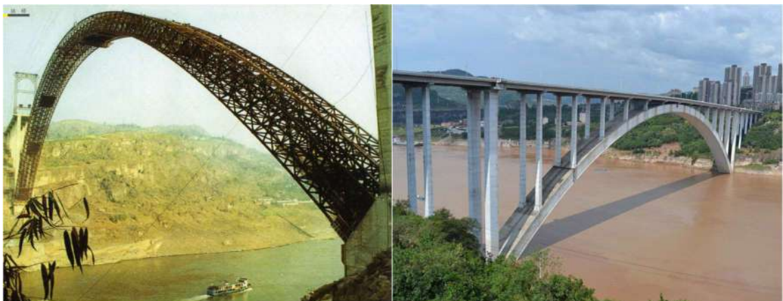
Εικ. 10 Τόξο Mellan, Γέφυρα Wanxian - Κίνα (1997)
