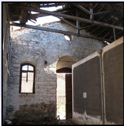
Φωτ.14: Άποψη από τις παλιές δεξαμενές που αποξηλώθηκαν
