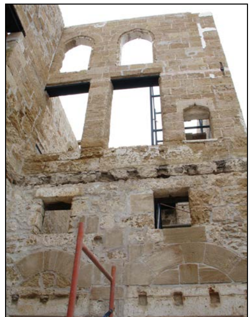
Εικ.23 Παρουσία ξυλοδεσιάς στη λιθοδομή ορόφου. Αρχοντικό οδού Ιεροκλέους, Μ.Π.Ρόδου.
