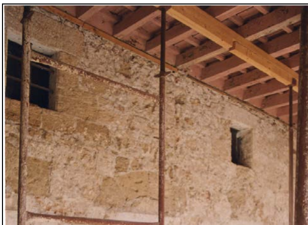
Εικ.25 Μεσοπάτωμα με δοκούς και δοκίδες, Αρχοντικό Οδού Ιεροκλέους Μ.Π.Ρόδου.
