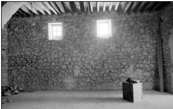
Εικ.52 Βορειοανατολική αίθουσα, με ορθογώνιους φεγγίτες για τον απαραίτητο φωτισμό και αερισμό του χώρου.
