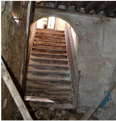
Εικ.105 α Ξύλινη σκάλα πρόσβασης στον όροφο.
