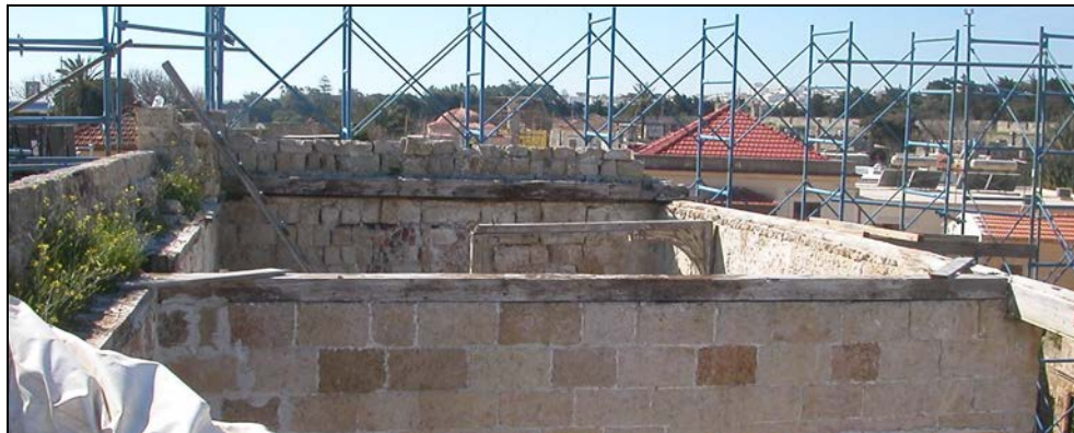
Εικ.30 Στάθμη έδρασης των δοκαριών του δώματος με ξυλοδεσιές – στρωτήρες, και χρήση μεταλλικών καρφιών για τη σύνδεσή τους με την υποκείμενη λιθοδομή.
