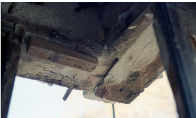
Εικ. 133 Γωνιακή σύνδεση ξυλοδεσιών σε εξωτερική λιθοδομή του ορόφου.
