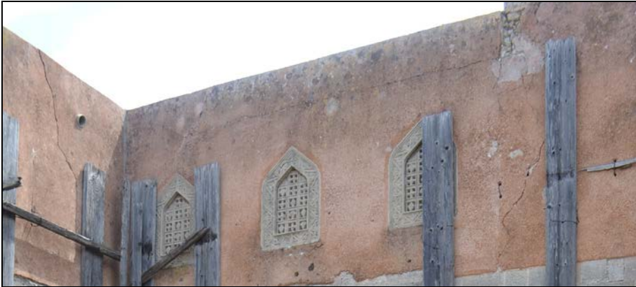
Εικ.140 Τμήμα των όψεων με επικάλυψη υδραυλικού κονιάματος «κουρασάνι».
