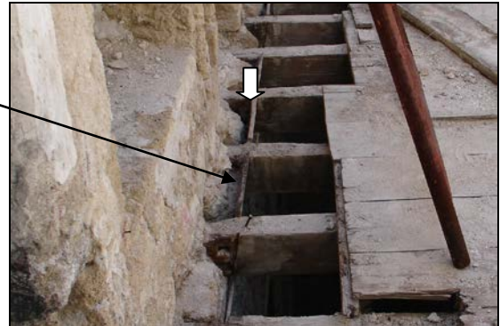
Εικ.28-29 Προσπάθεια ενίσχυσης της διαφραγματικής ακαμψίας του μεσοπατώματος και σε πολλές περιπτώσεις και του δώματος, με λοξές τοποθετημένες σανίδες μεταξύ των δοκών, στο σημείο της επιφάνειας της λιθοδομής.
