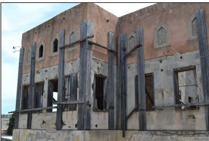
Εικ.124 Τμήμα της δυτικής όψης
