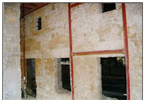
Εικ.20-21 Τοξοστοιχία ισογείου και ανακουφιστικά τόξα ανοιγμάτων. Αρχοντικό οδού Ιεροκλέους, Μ.Π.Ρόδου.
