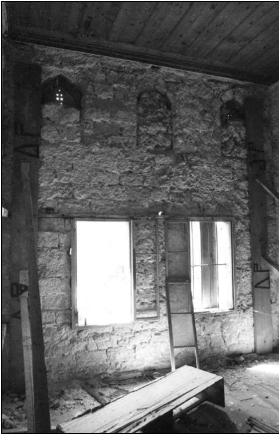
Εικ.62 Άποψη της δυτικής λιθοδομής στο χαγιάτι, διακρίνονται οι φραγμένοι φεγγίτες και το ξύλινο ταβάνι.
