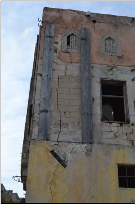
Εικ. 122-123 Ρηγματώση στη βορειοανατολική γωνία του κτιρίου.
