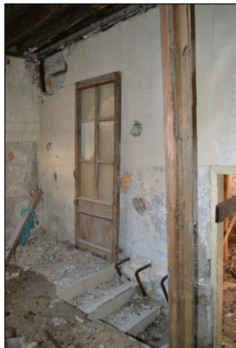
Εικ.44. Κτιστή κλίμακα που συνδέει τον κεντρικό χώρο με τον αρχικό ημιυπαίθριο, τοξωτό χώρο του ισόγειου.
