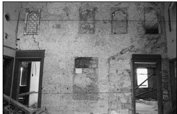
Εικ.60 Φραγμένο παράθυρο και φεγγίτες, Διάνοιξη πόρτας και τοποθέτηση ελαφρών διαχωριστικών τοίχων, στο χαγιατί.
