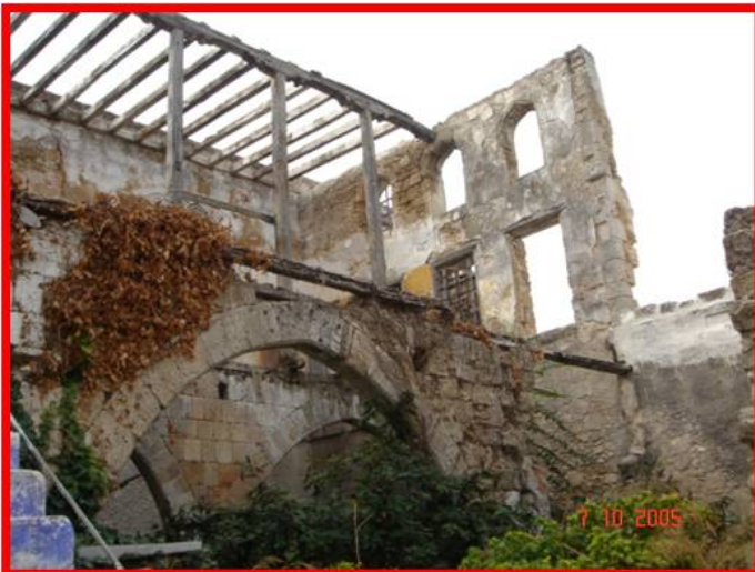
Εικ.22 Λεπτομέρεια ισόδομης λιθοδομής ορόφου. Αρχοντικό οδού Αλεξανδρίδου, Μ.Π.Ρόδου
