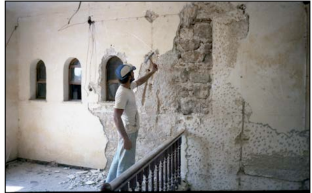
Εικ.111 Καθαίρεση επιχρισμάτων στον όροφο.
