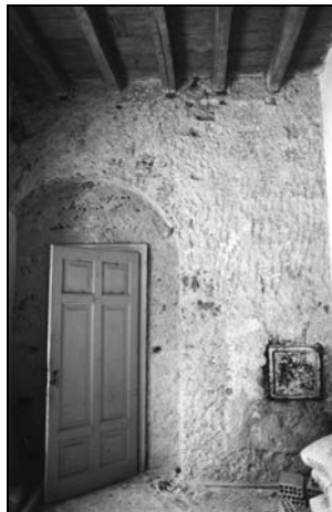
Εικ.96 Ταμπλαδοτή πόρτα ισογείου
