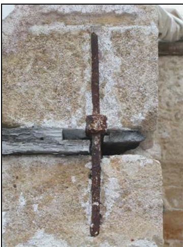
Εικ.22 Λεπτομέρεια ισόδομης λιθοδομής ορόφου. Αρχοντικό οδού Αλεξανδρίδου, Μ.Π.Ρόδου
