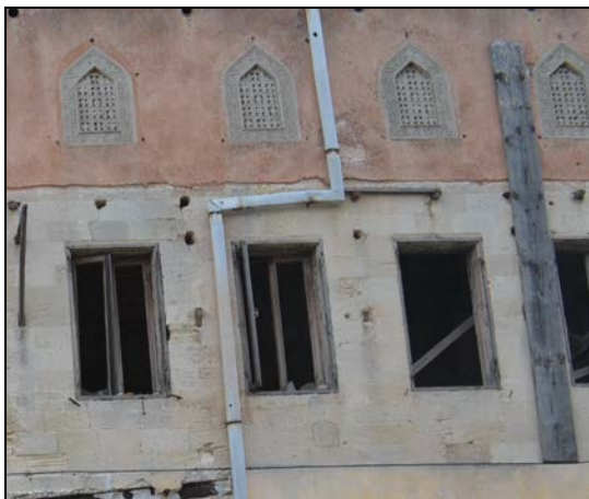
Εικ.98 Ανοιγόμενα παράθυρα του ορόφου
