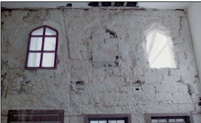
Εικ. 129-130. Αποψη εσωτερικών λιθοδομών του ορόφου, με ρωγμές και τμηματική απώλεια λίθων.
