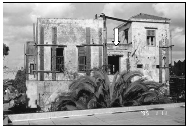
Εικ.38 Προσθήκη χώρου στην νότια όψη με στοιχεία οπλισμένου σκυροδέματος
