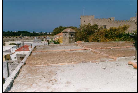
Εικ.32- 33 Το δώμα καλύπτεται με πατελιά και χωρίζεται σε τμήματα με χαμηλά στηθαία ως προέκταση των λιθοδομών του ορόφου.
