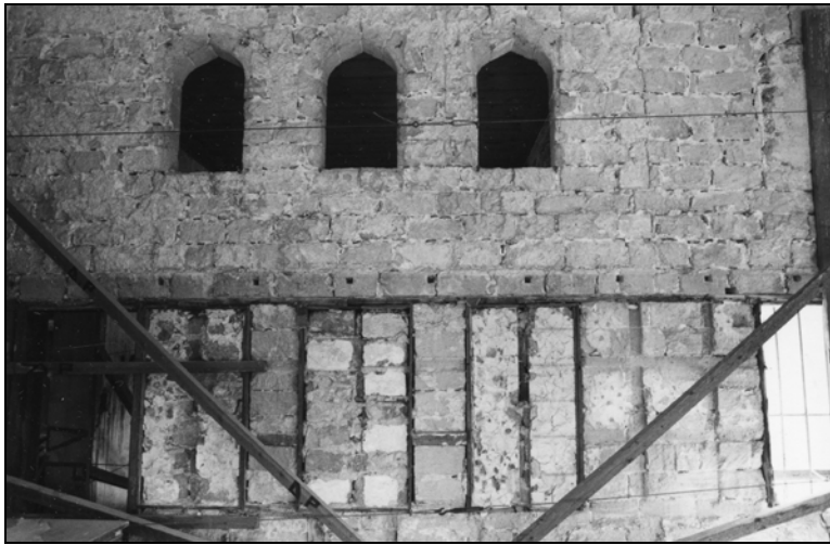
Εικ.61 Φραγμένα παράθυρα στην μεσοτοιχία μεταξύ χαγιατιού και οντά.
