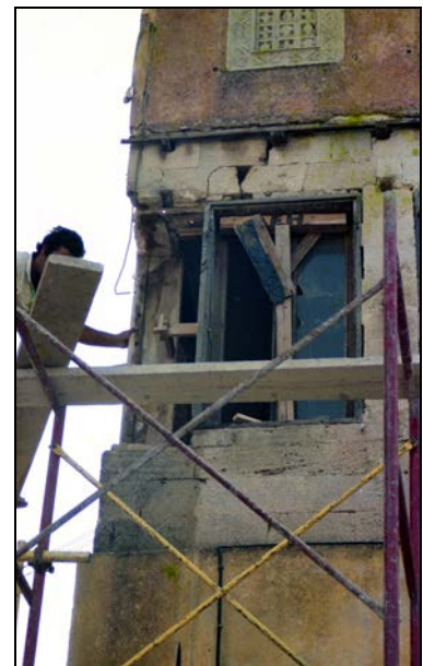
Εικ.114 Αποκατάσταση λιθοδομής.
