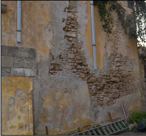
Εικ.82 Ακανόνιστη λιθοδομή του ισογείου
