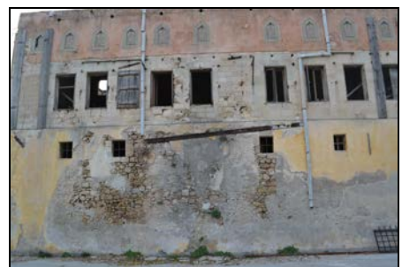
Εικ. 137 Εξωτερικά επιγρίσματα με χρήση μαύρου τσιμέντου.
