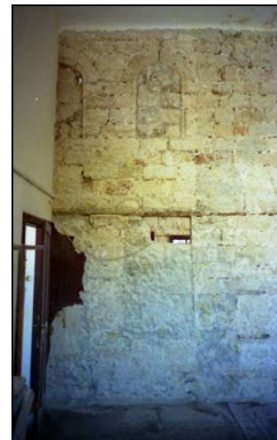
Εικ. 129-130. Αποψη εσωτερικών λιθοδομών του ορόφου, με ρωγμές και τμηματική απώλεια λίθων.
