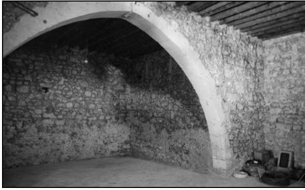
Εικ.54. Η βορειοδυτική αίθουσα με κυρίαρχο στοιχείο το οξυκόρυφο τόξο, παρουσιάζει μια μικρή υποχώρηση της δυτικής λιθοδομής σχηματίζοντας έτσι δύο ορθογώνια τμήματα. Στη βόρεια λιθοδομή διανοίγονται δύο ορθογώνιοι φεγγίτες, όπως και στη βορειοανατολική αίθουσα, ενώ στη δυτική όψη τέσσερις θυρίδες (πολεμίστρες), σήμερα φραγμένες.
