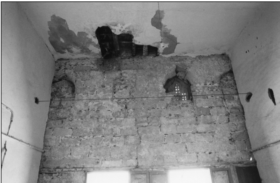
Εικ.64 Τμήμα λιθοδομής στο βόρειο οντά. Διακρίνεται η διαίρεση του χώρου με την τοποθέτηση ελαφρών διαχωριστικών τοίχων για τη δημιουργία αιθουσών, την φραγή των φεγγιτών και το επιχρισμένο ταβάνι.
