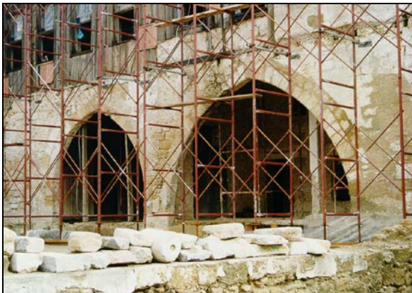
Εικ.20-21 Τοξοστοιχία ισογείου και ανακουφιστικά τόξα ανοιγμάτων. Αρχοντικό οδού Ιεροκλέους, Μ.Π.Ρόδου.
