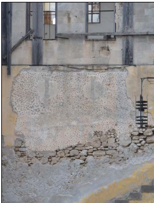
Εικ.93 Επιχρίσματα του ισόγειου με χρήση θραυσμάτων κεραμικών.
