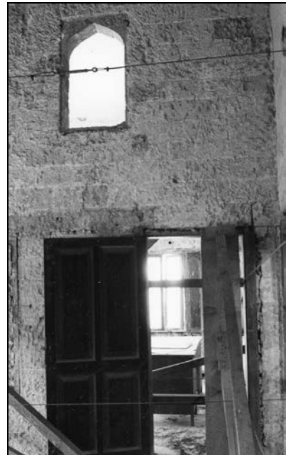
Εικ.84-85 Εξωτερική και εσωτερική όψη ισόδομων λιθοδομών με καλή επαφή μεταξύ των λιθοσωμάτων.
