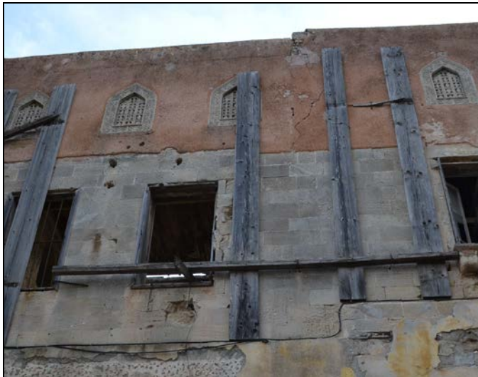
Εικ.84-85 Εξωτερική και εσωτερική όψη ισόδομων λιθοδομών με καλή επαφή μεταξύ των λιθοσωμάτων.
