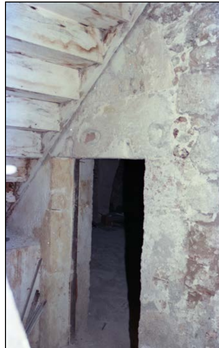
Εικ.50 Πόρτα με λίθινο πρέκι και ανακουφιστικό τόξο, που οδηγεί σε μία από τις δύο μεγάλες αίθουσες του ισογείου
