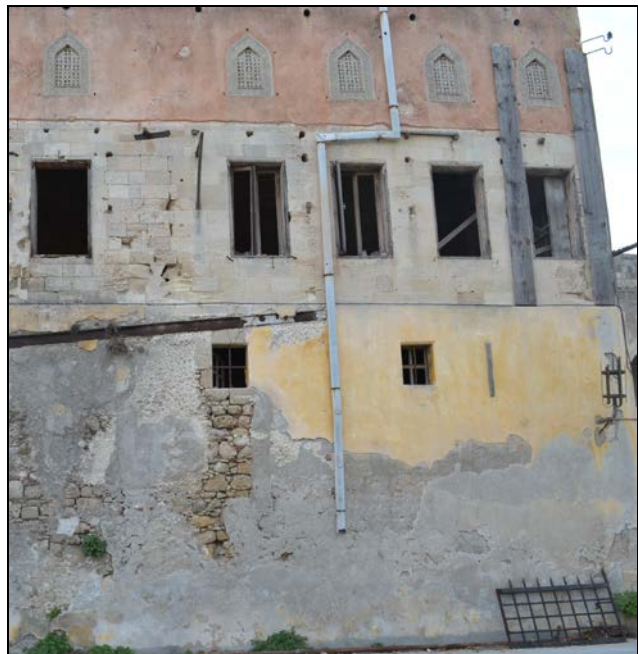
Εικ.94 Πρόσφατα επιχρίσματα με χρήση μαύρου τσιμέντου.
