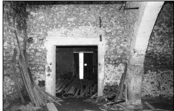
Εικ.53 Διάνοιξη θύρας για την επικοινωνία των αιθουσών του ισογείου.
