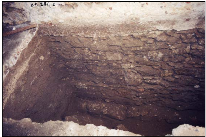
Εικ.80 -81. Αποψη των τομών για την διερεύνηση των θεμελίων. Διακρίνονται οι προγενέστερες λιθοδομές στις οποίες εδράζεται η θεμελίωση του κτιρίου.
