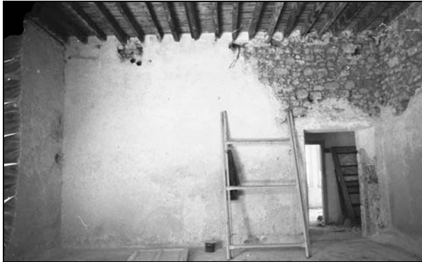
Εικ.110 Καθαίρεση επιχρισμάτων στο ισόγειο
