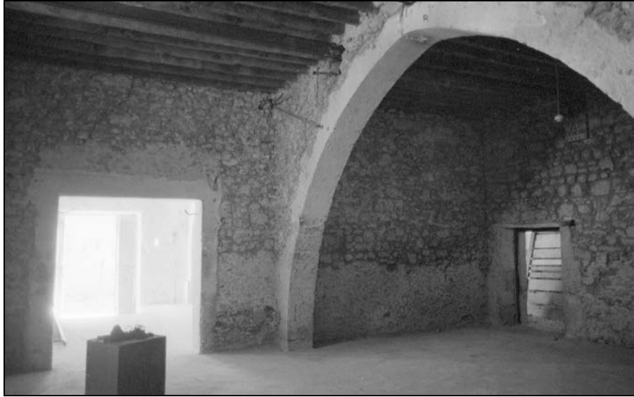
Εικ.51 Οξυκόρυφο τόξο σε μεγάλη αίθουσα στο ισόγειο, όπου εδράζεται σε αυτό η βόρεια λιθοδομή στο χαγιάτι του ορόφου.
