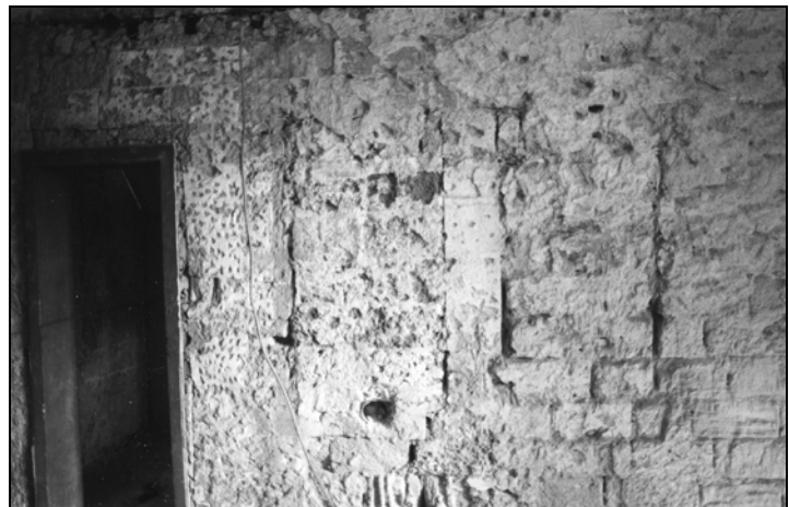
Εικ.92 Ύλη ασβεστοκονιαμάτων στις λιθοδομές του ορόφου, μετά την καθαίρεση των πρόσφατων επιχρισμάτων.
