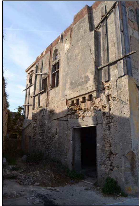
Εικ.63 Τα δύο μεταγενέστερα παράθυρα που διανοίχτηκαν στην ανατολική λιθοδομή στο χαγιάτι
