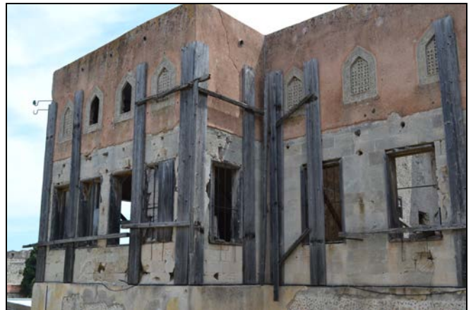
Εικ.72 Τμήμα που αντιστοιχεί στη λιθοδομή του χαγιατιού, όπου τρεις φεγγίτες είναι τοποθετημένοι έκκεντρα σε σχέση με τα δύο παράθυρα.
