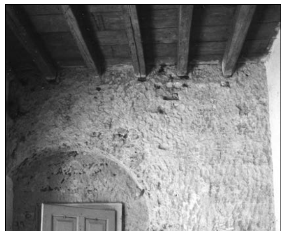
Εικ.26 Μεσοπάτωμα χωρίς δοκίδες, Αρχοντικό Χασάν Μπέη, Μ.Π.Ρόδου
