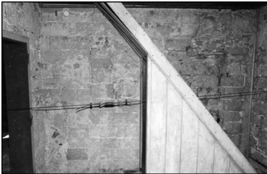
Εικ.57 Εσωτερικό του βοηθητικού χώρου, διακρίνονται τα φραγμένα ανοίγματα στην βόρεια λιθοδομή.
