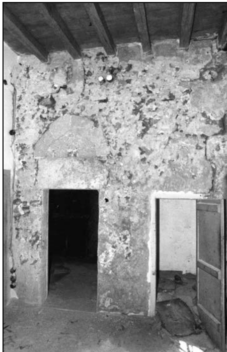
Εικ.49 Πόρτες με λίθινα πρέκια που οδηγούν σε χώρους υγιεινής του ισογείου
