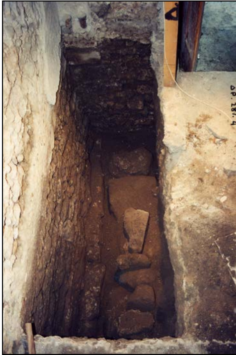
Εικ.80 -81. Αποψη των τομών για την διερεύνηση των θεμελίων. Διακρίνονται οι προγενέστερες λιθοδομές στις οποίες εδράζεται η θεμελίωση του κτιρίου.
