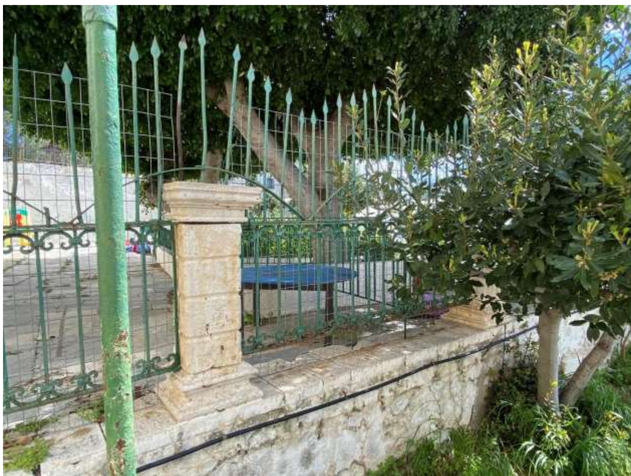
Εικ.107: Κιγκλίδωμα αυλόγυρου, τμήμα μεταξύ 3 ου και 4 ου πεσσού
