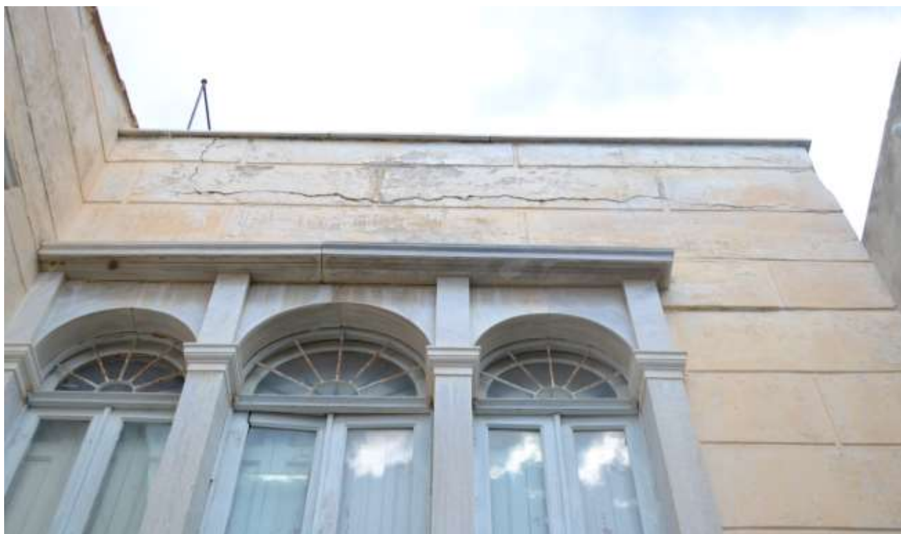
Εικ.55: Νότια όψη, λεπτομέρεια περιθυρωμάτων ανοιγμάτων χώρου Α5
