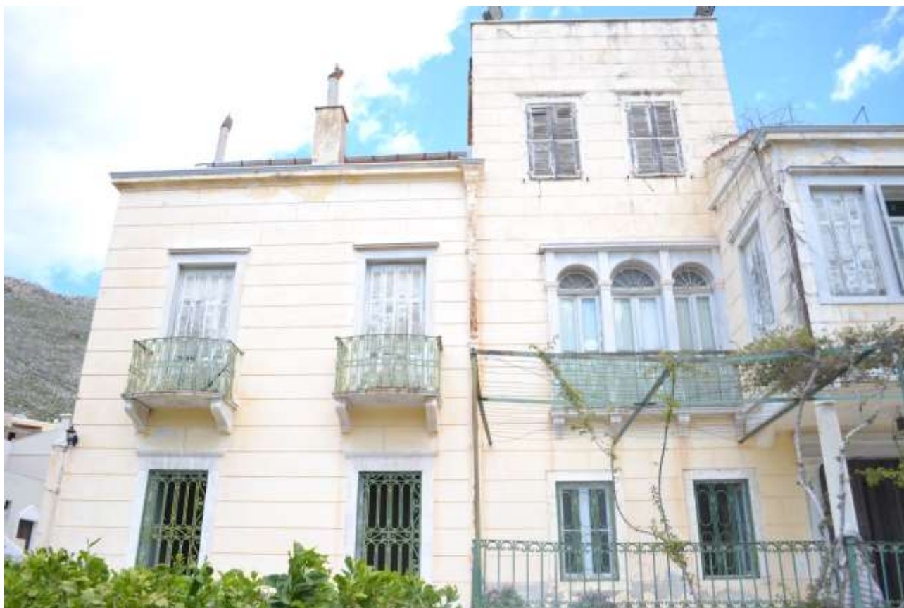
Εικ.21: Δυτικό τμήμα της νότιας όψης
