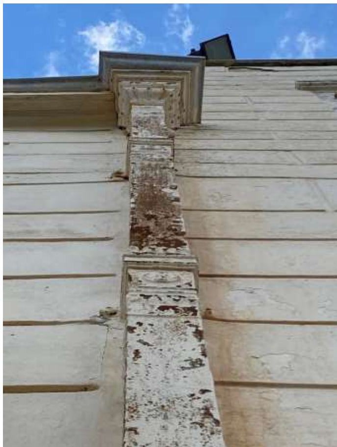
Εικ.46: Υδρορροή νότιας όψης - λεπτομέρεια
