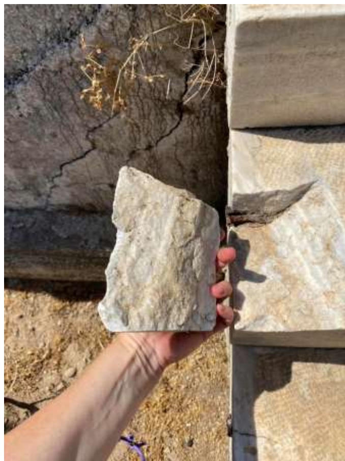
Εικ.165-166: Σέρα. Μαρμάρινη σκάλα. Αποκολλημένο τμήμα.
