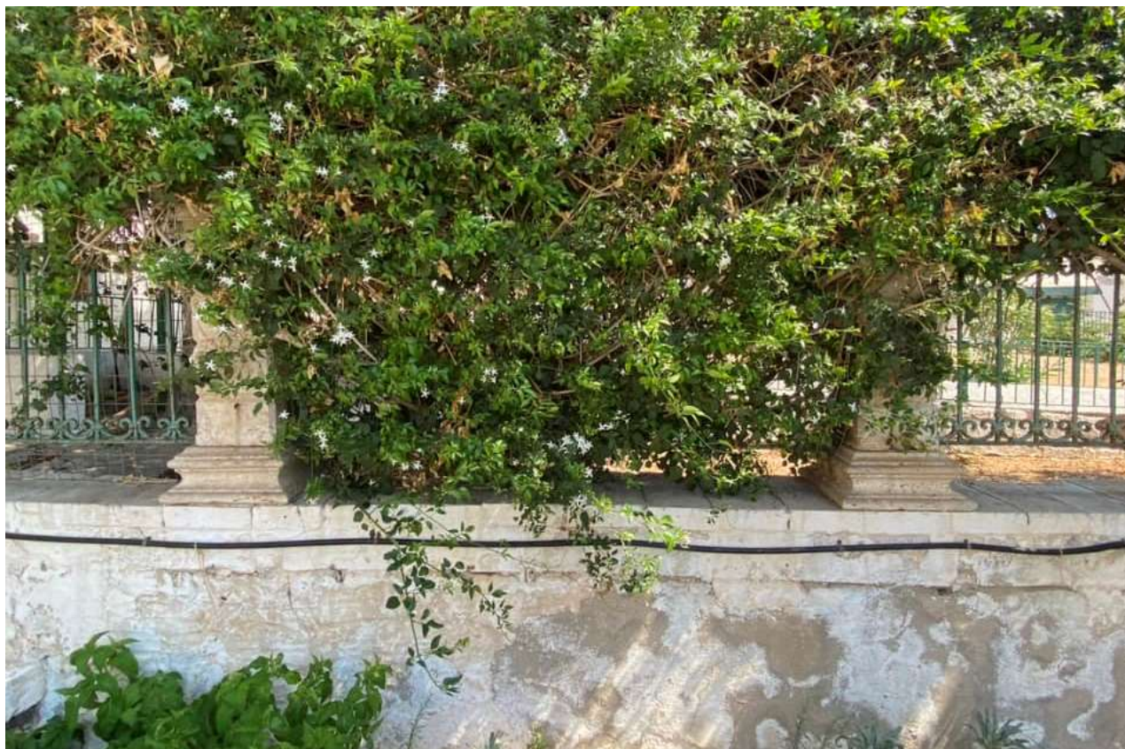
Εικ.111: Κικκλίδωμα αυλόγυρου, τμήμα μεταξύ 5 ου και 6 ου πεσσού
