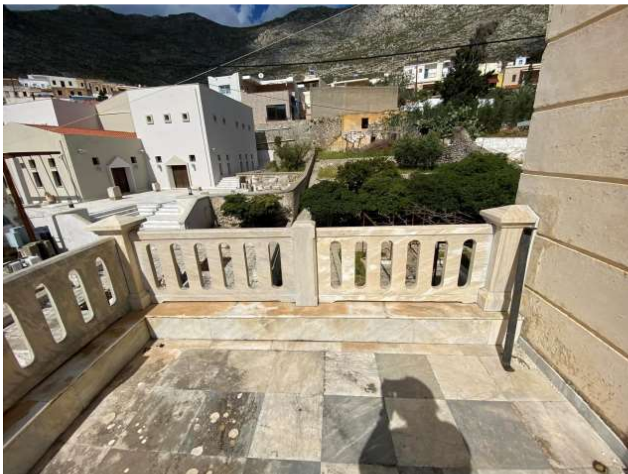
Εικ.69: Βόρειο τμήμα βεράντας δυτικής όψης
