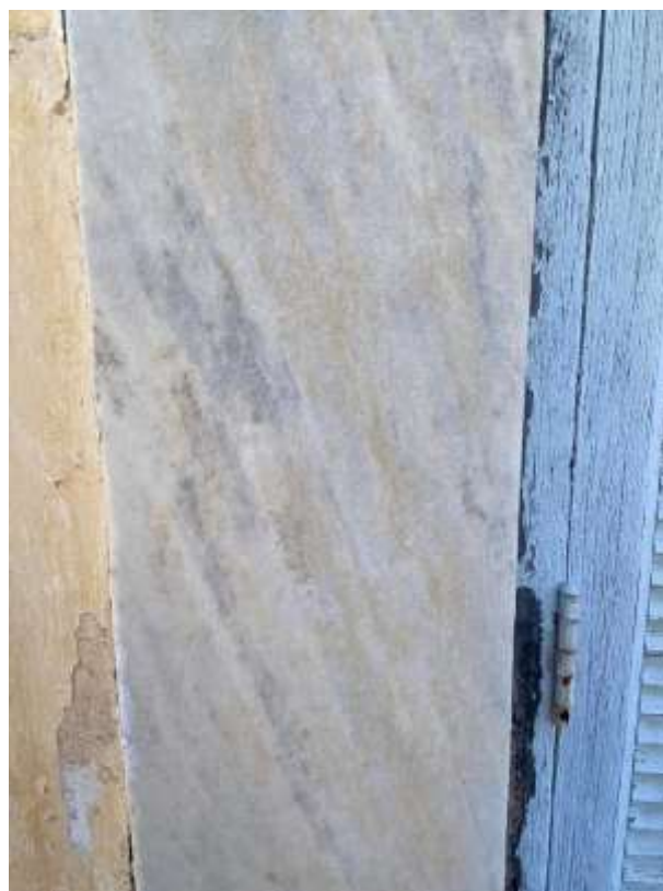
Εικ.74: Λεπτομέρεια μαντώματος δυτικής εξώθυρας χώρου Α2
