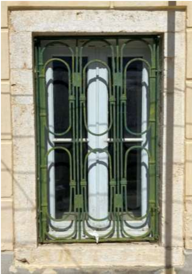
Εικ.28: Παράθυρο νότιας όψης του χώρου ΙΣ2 (1° από δυτικά)
