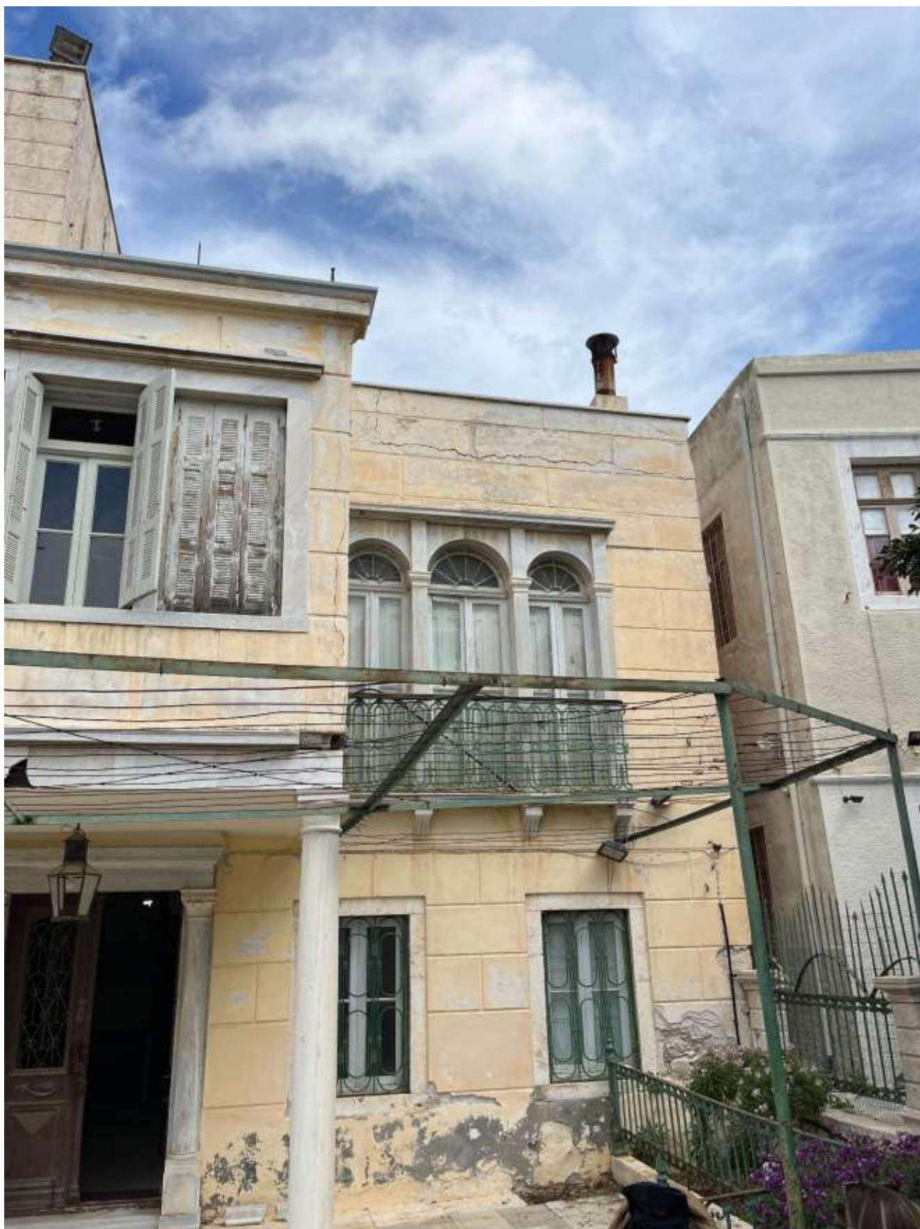
Εικ.53: Νότια όψη, ανατολικό τμήμα
