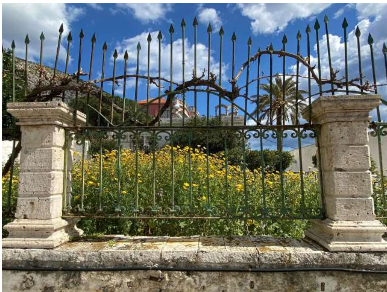
Εικ.117: Κιγκλίδωμα αυλόγυρου, τμήμα μεταξύ 9 ου και 10 ου πεσσού
