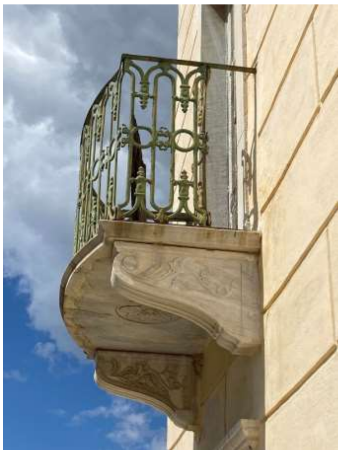
Εικ.38: Ανατολική όψη εξώστη νότιας όψης χώρου Α2 (1 ου από δυτικά)
