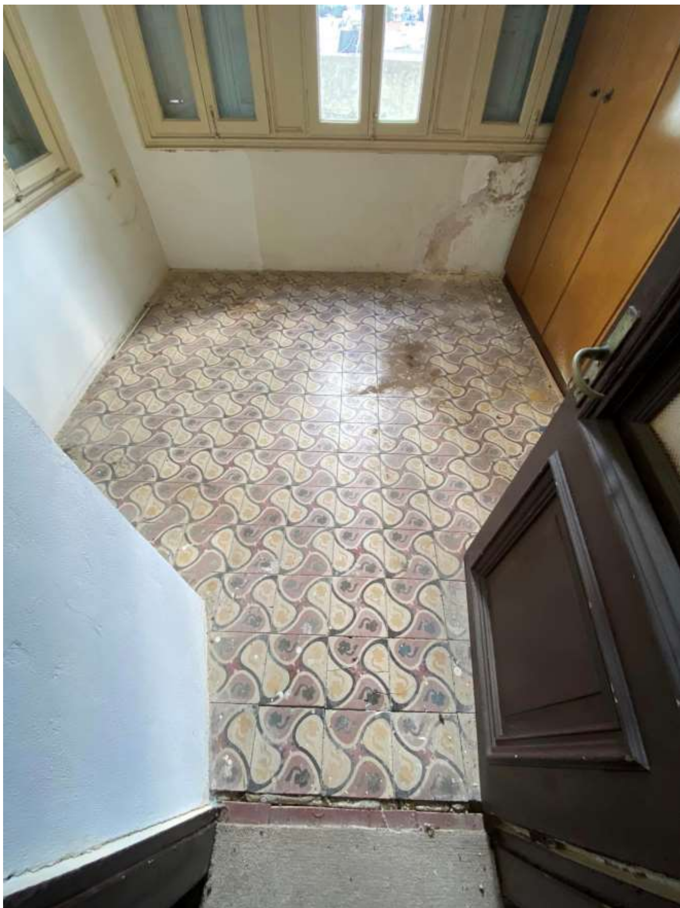
Εικ.223: Τσιμεντοπλακίδια στο δάπεδο του χώρου Α4
