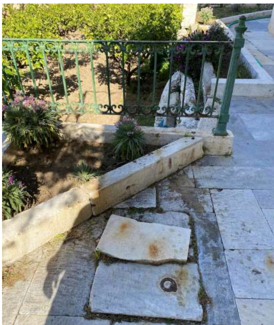
Εικ.150: Κιγκλιδώματα προαύλιου, δυτικό τμήμα, λεπτομέρεια
