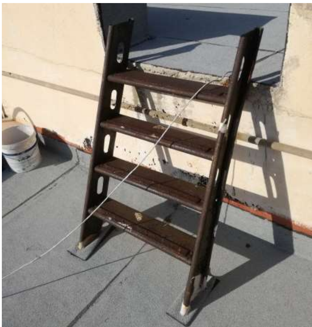
Εικ.60: Μικρή μεταλλική σκάλα στο δώμα του χώρου B1
