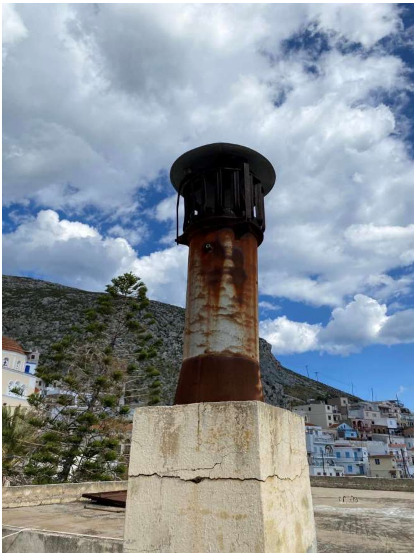
Εικ.63: Μεταλλική καμινάδα στο δώμα του χώρου Α5. Αντιστοιχεί το τζάκι του χώρου ΙΣ3
