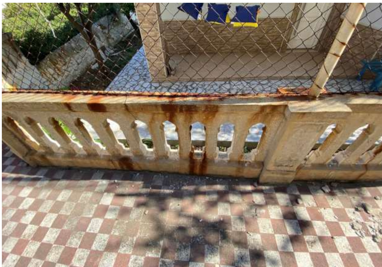
Εικ.87: Στηθαίο βεράντας βόρειας όψης - λεπτομέρεια
