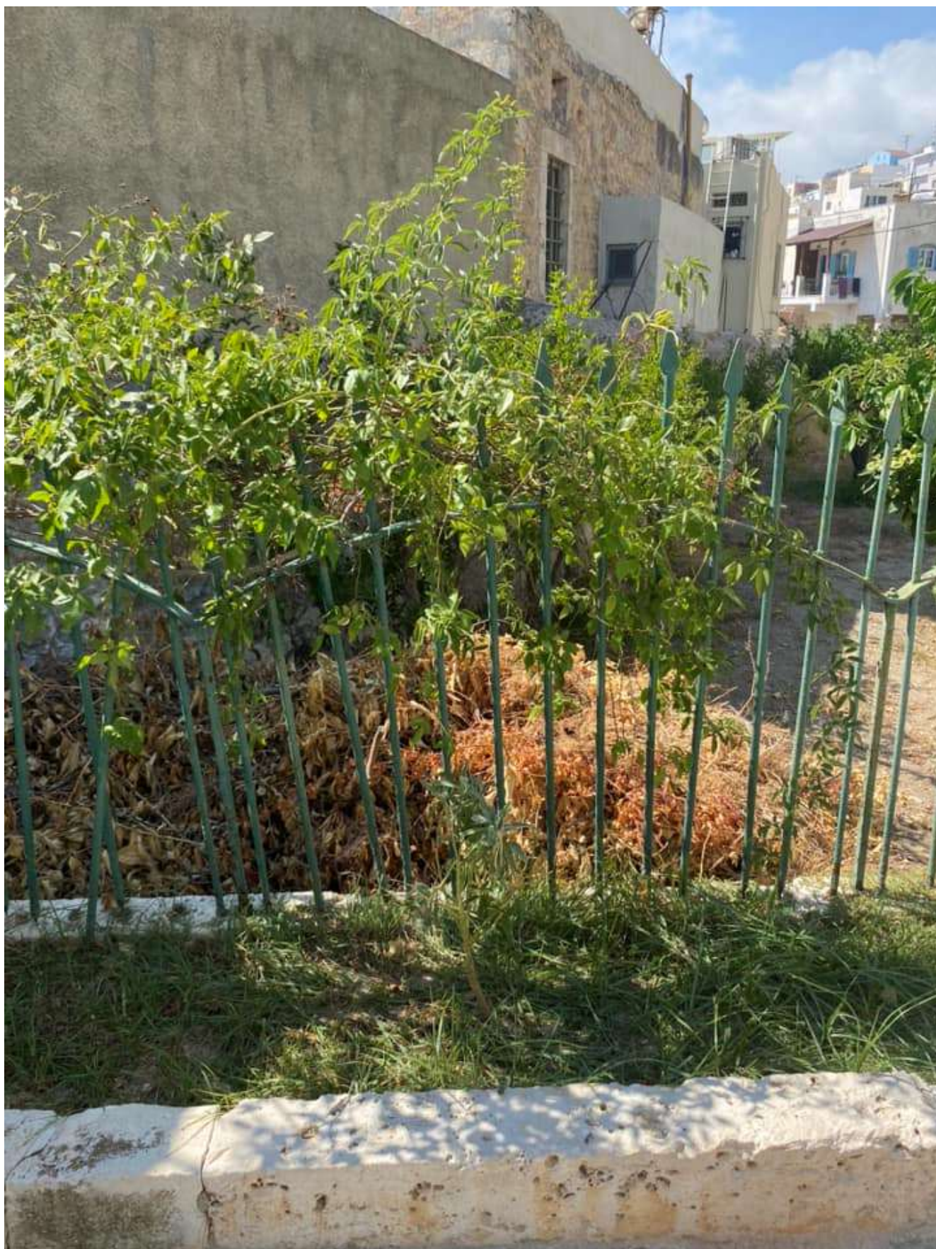
Εικ.129: Κιγκλίδωμα περιβολιού, 2 ο τμήμα.
