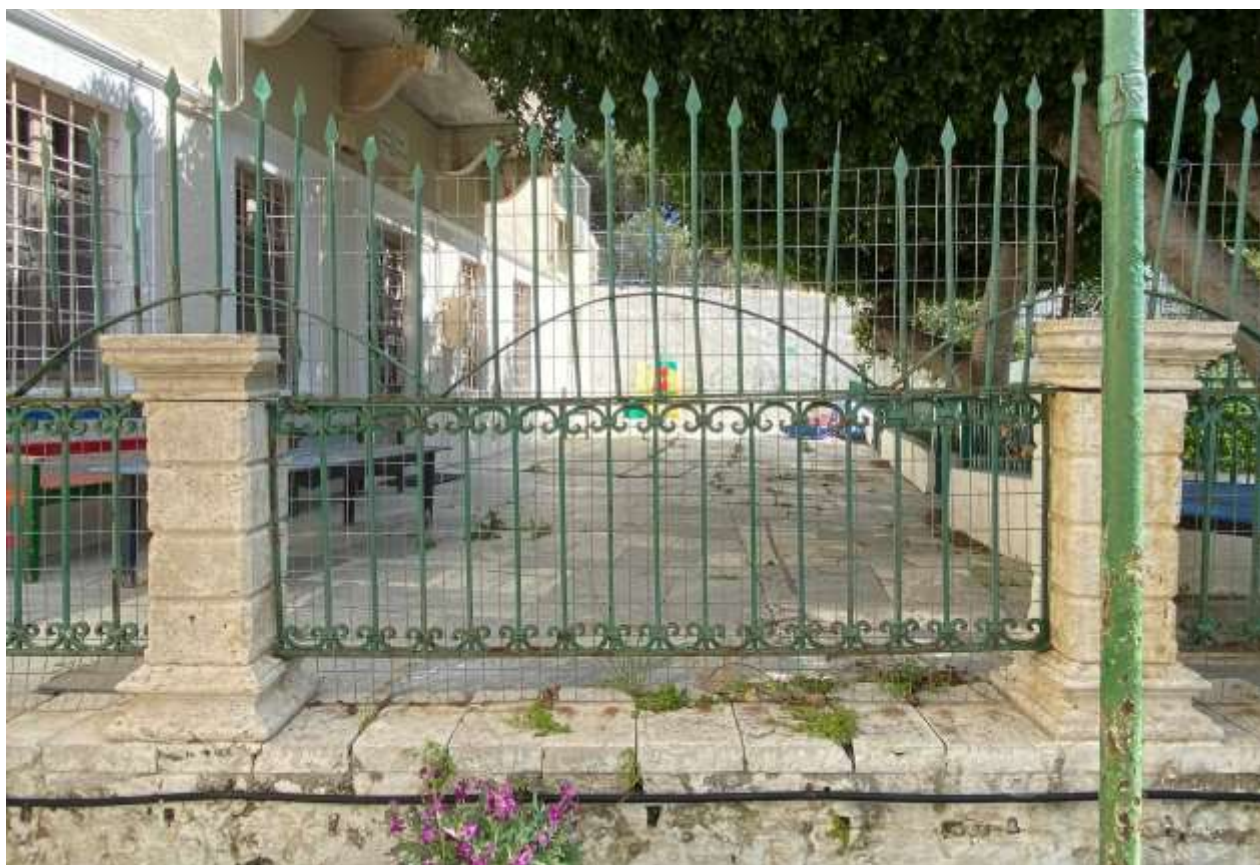
Εικ.106: Κιγκλίδωμα αυλόγυρου, τμήμα μεταξύ 2 ου και 3 ου πεσσού
