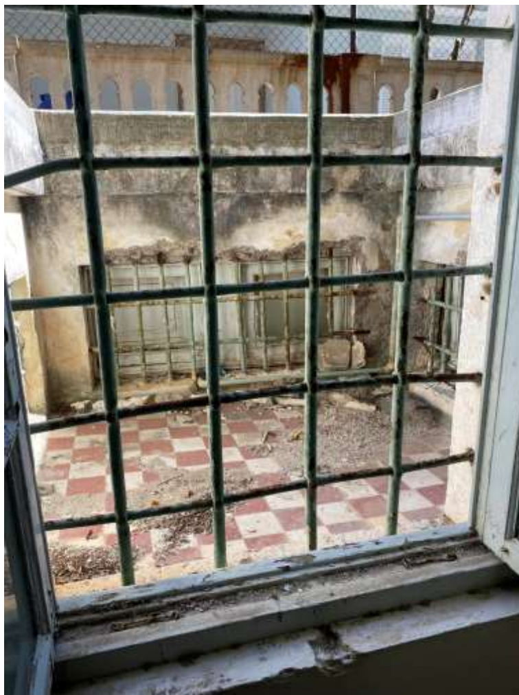
Εικ.172: Παράθυρο κλιμακοστασίου
