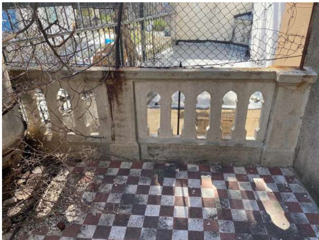
Εικ.90: Στηθαίο βεράντας βόρειας όψης - λεπτομέρεια
