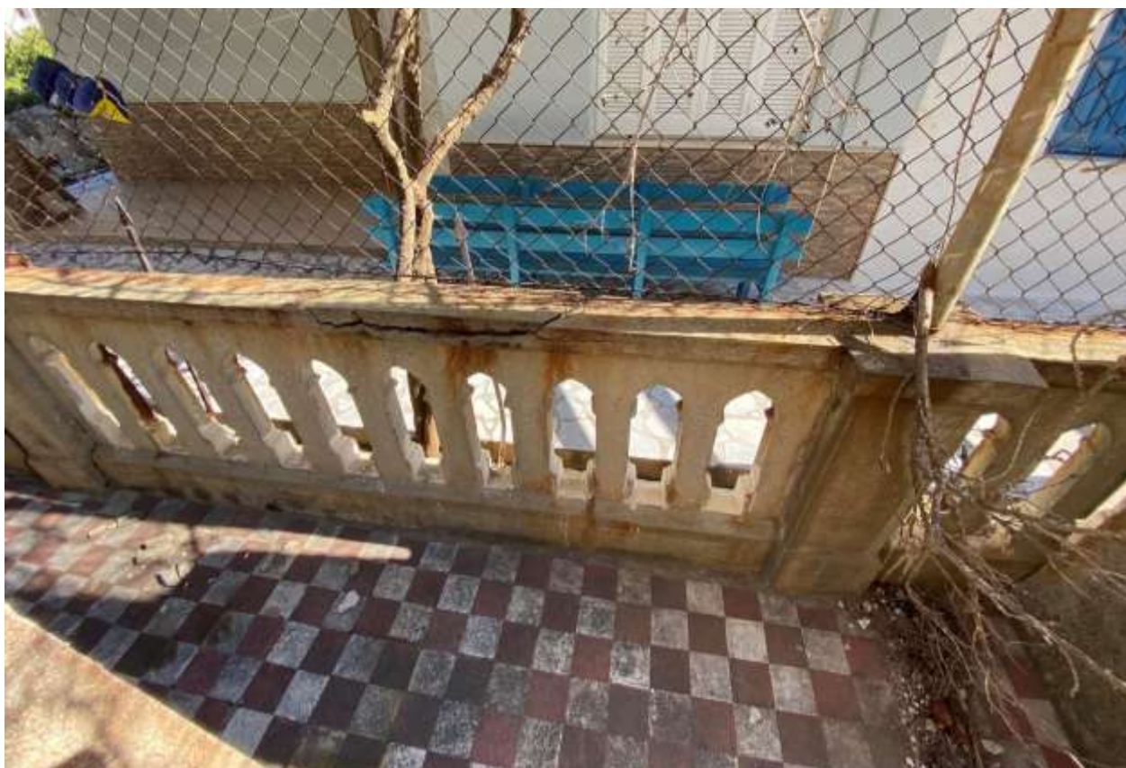
Εικ.89: Στηθαίο βεράντας βόρειας όψης - λεπτομέρεια
