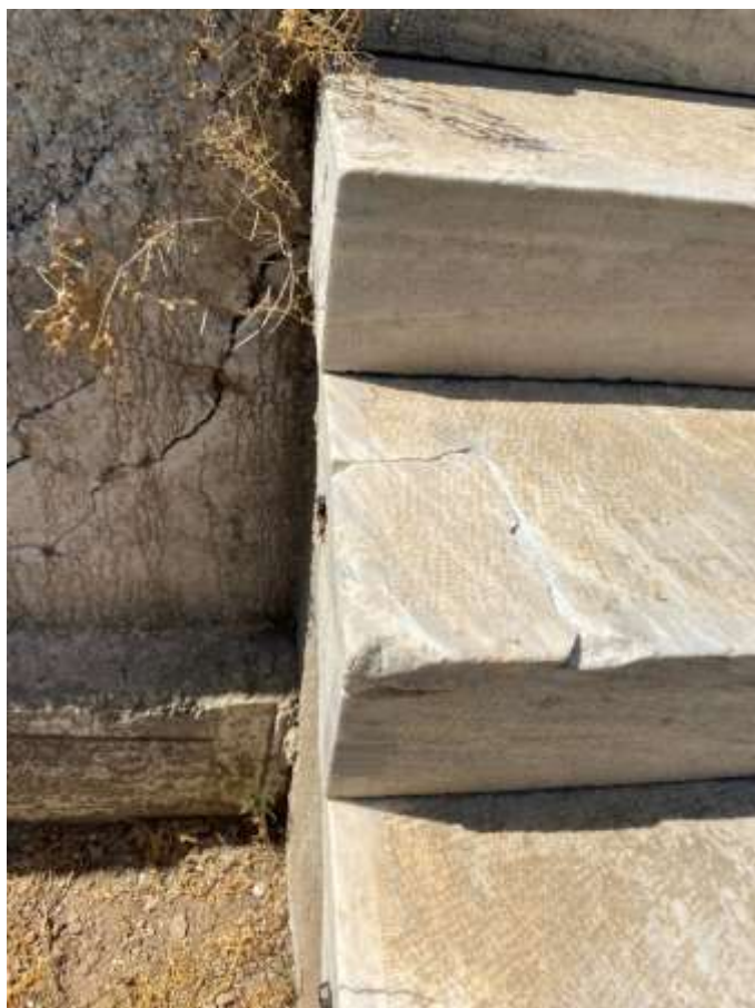
Εικ.165-166: Σέρα. Μαρμάρινη σκάλα. Αποκολλημένο τμήμα.
