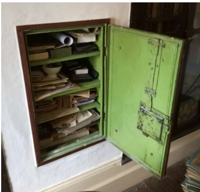
Εικ.176: Εντοιχισμένο χρηματοκιβώτιο στο δυτικό τοίχο του χώρου ΙΣ2
