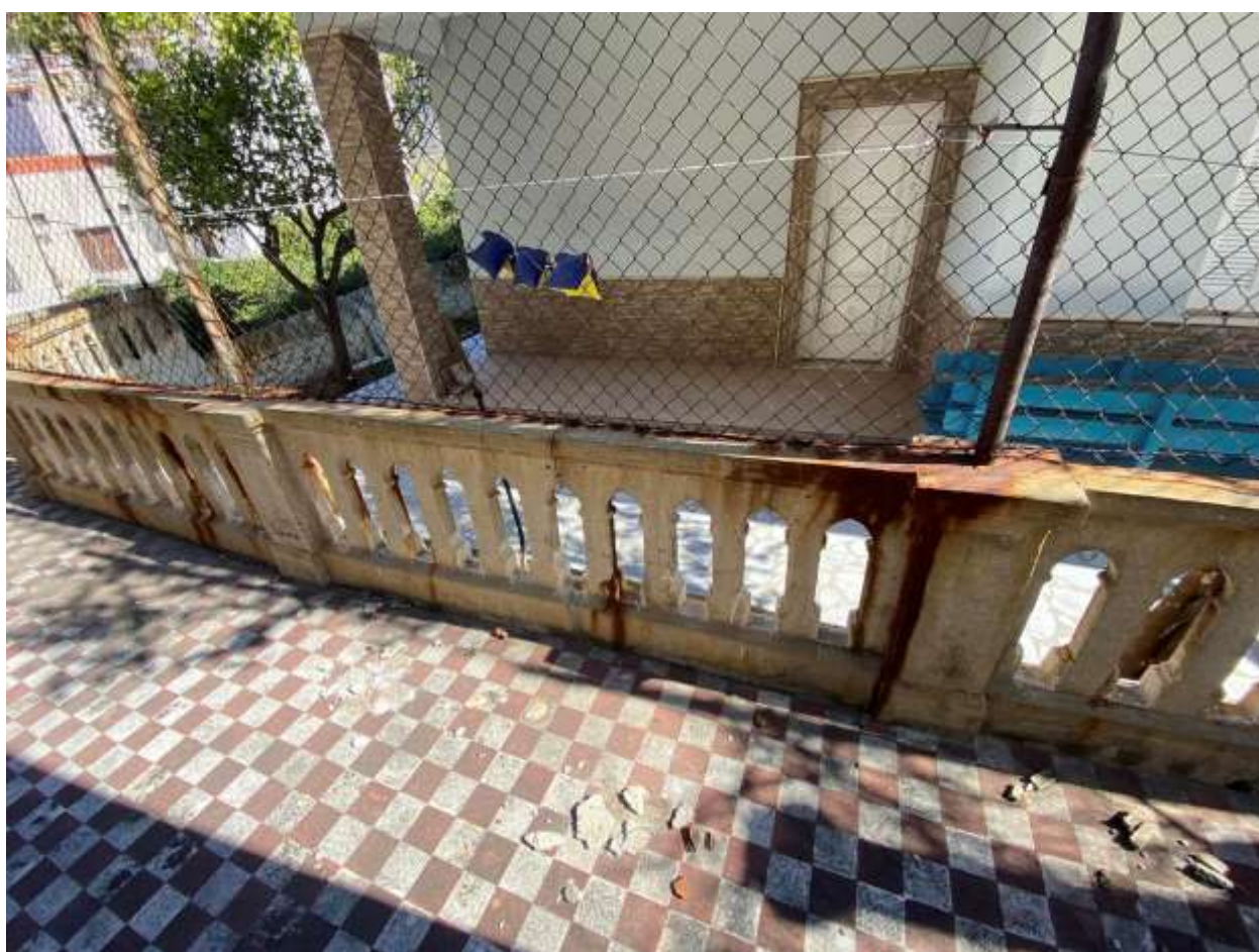
Εικ.88: Στηθαίο βεράντας βόρειας όψης - λεπτομέρεια
