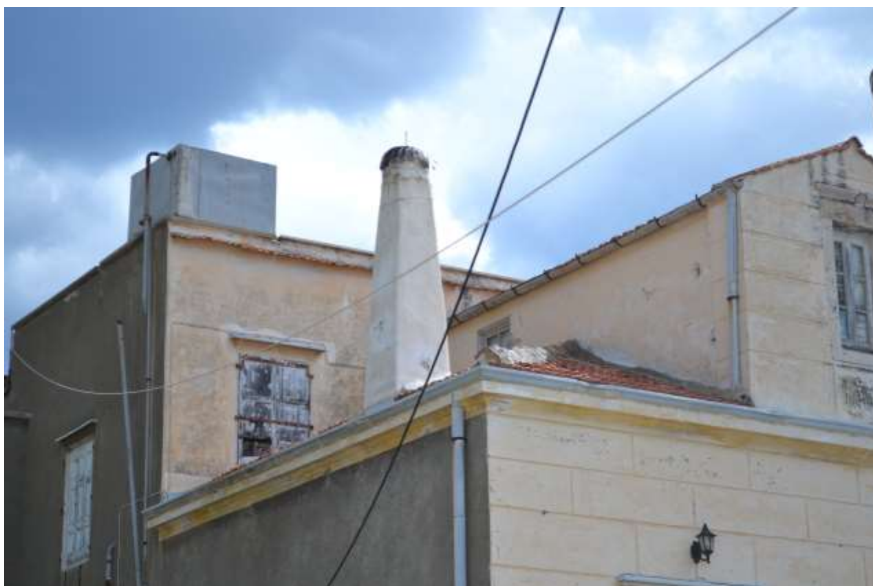
Εικ.92: ΒΔ όψη Β' ορόφου
