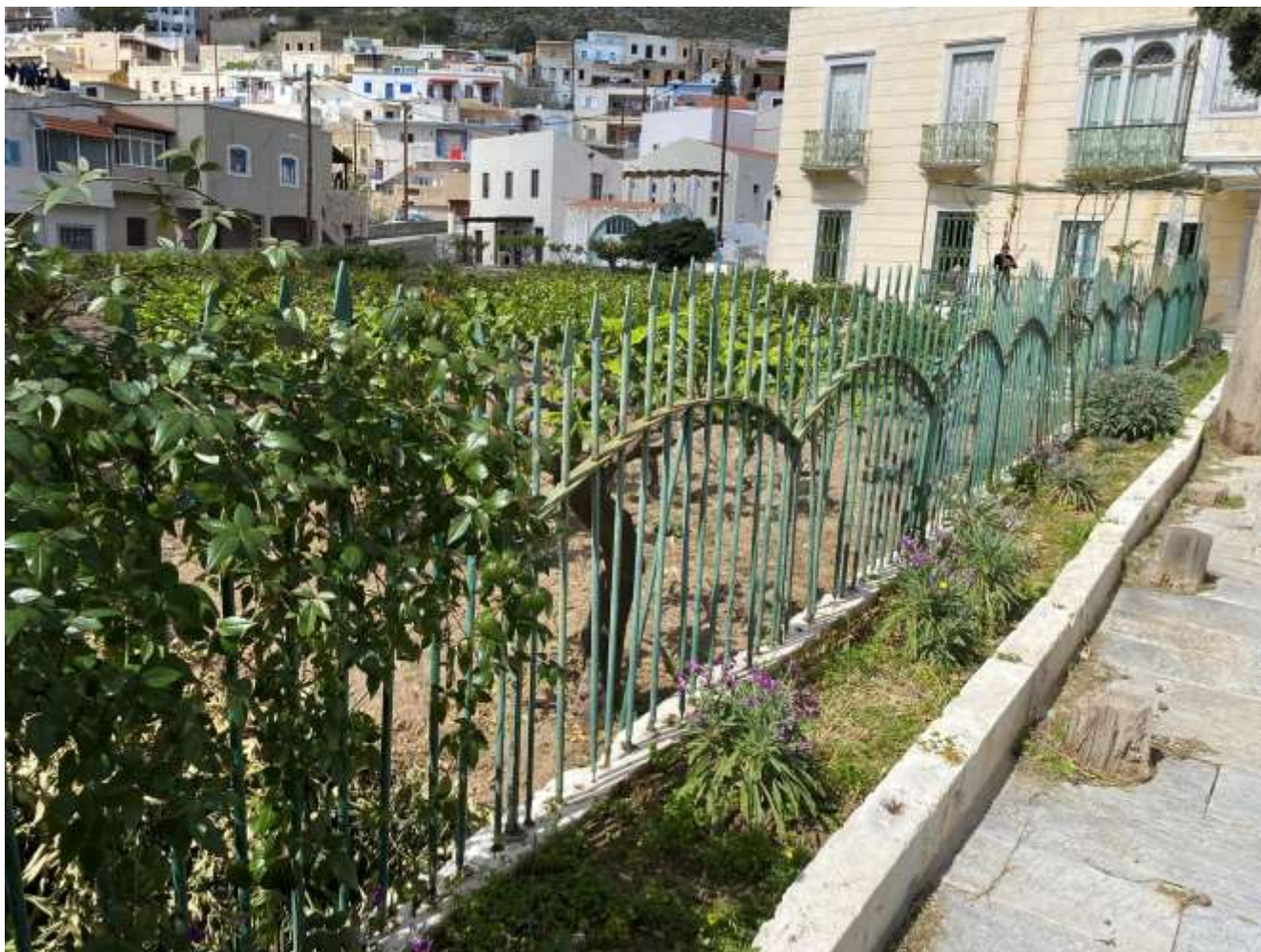
Εικ.127: Κιγκλίδωμα περιβολιού, άποψη από Ν
