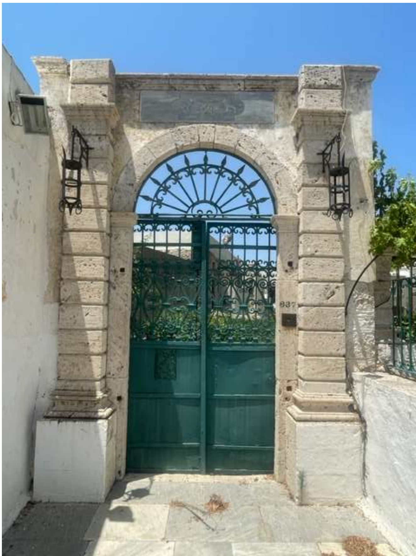
Εικ.98: Εξωτερική όψη αυλόθυρας
