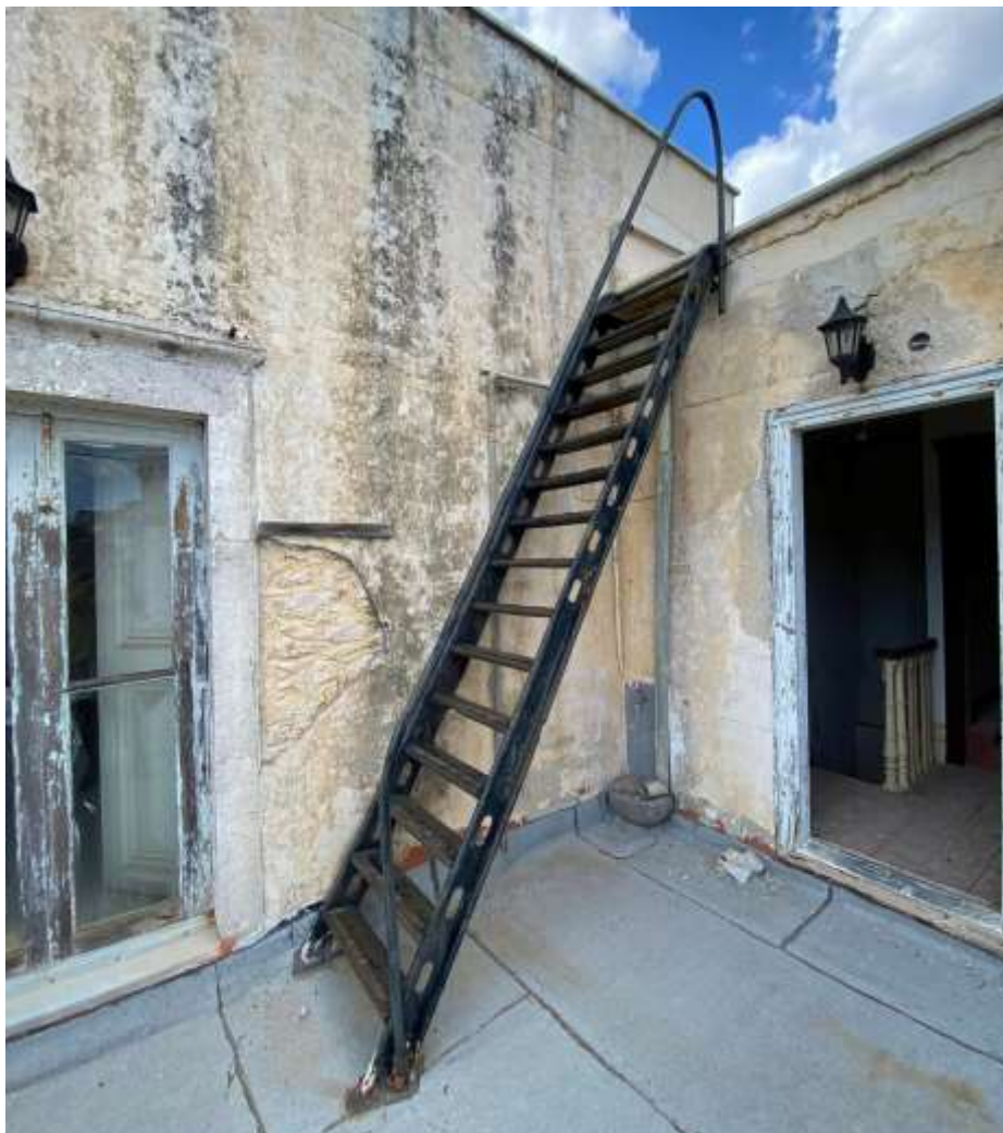
Εικ.58: Μεταλλική σκάλα στο δώμα του χώρου Α5
