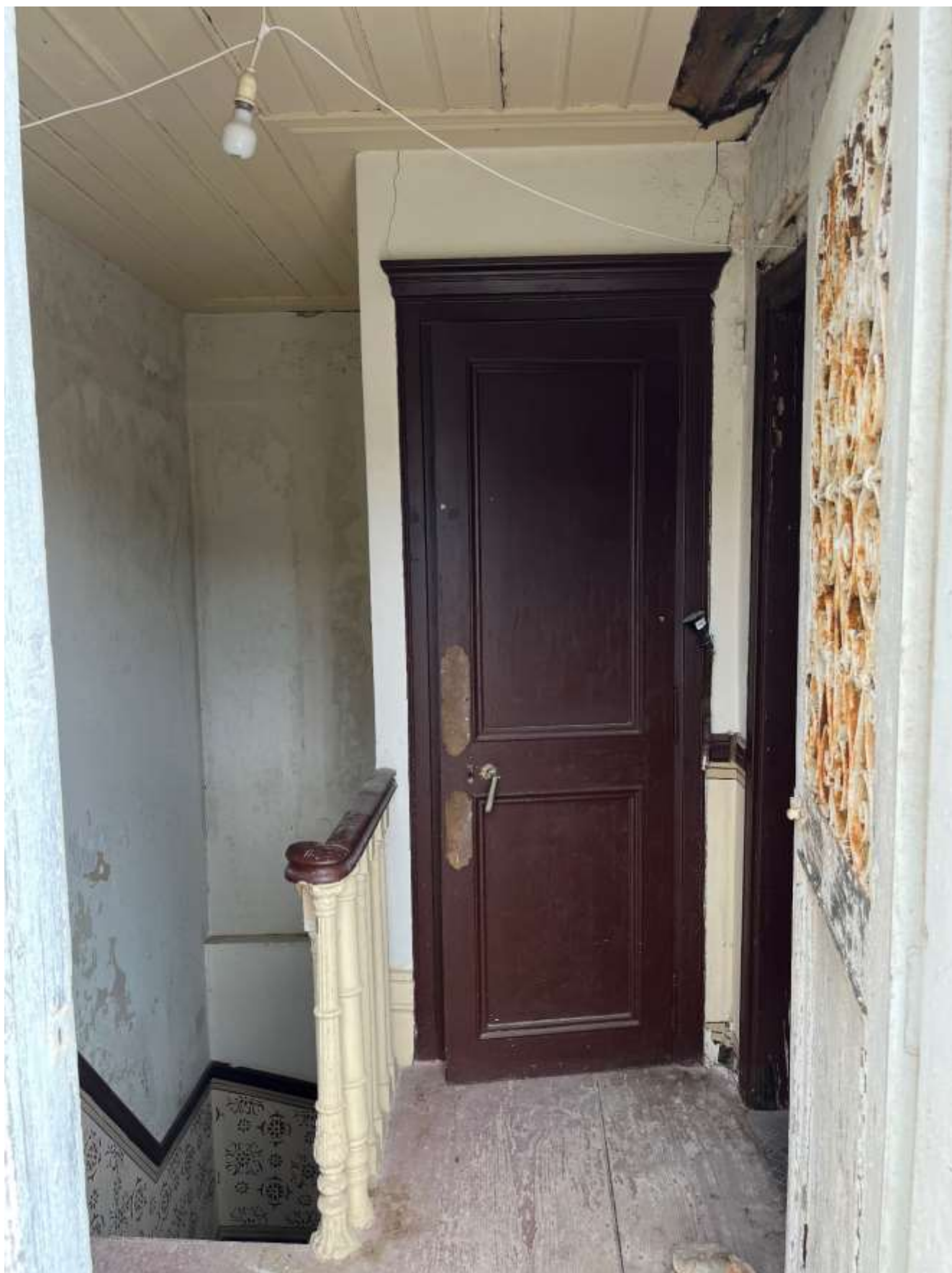
Εικ.224: Χώρος B1
