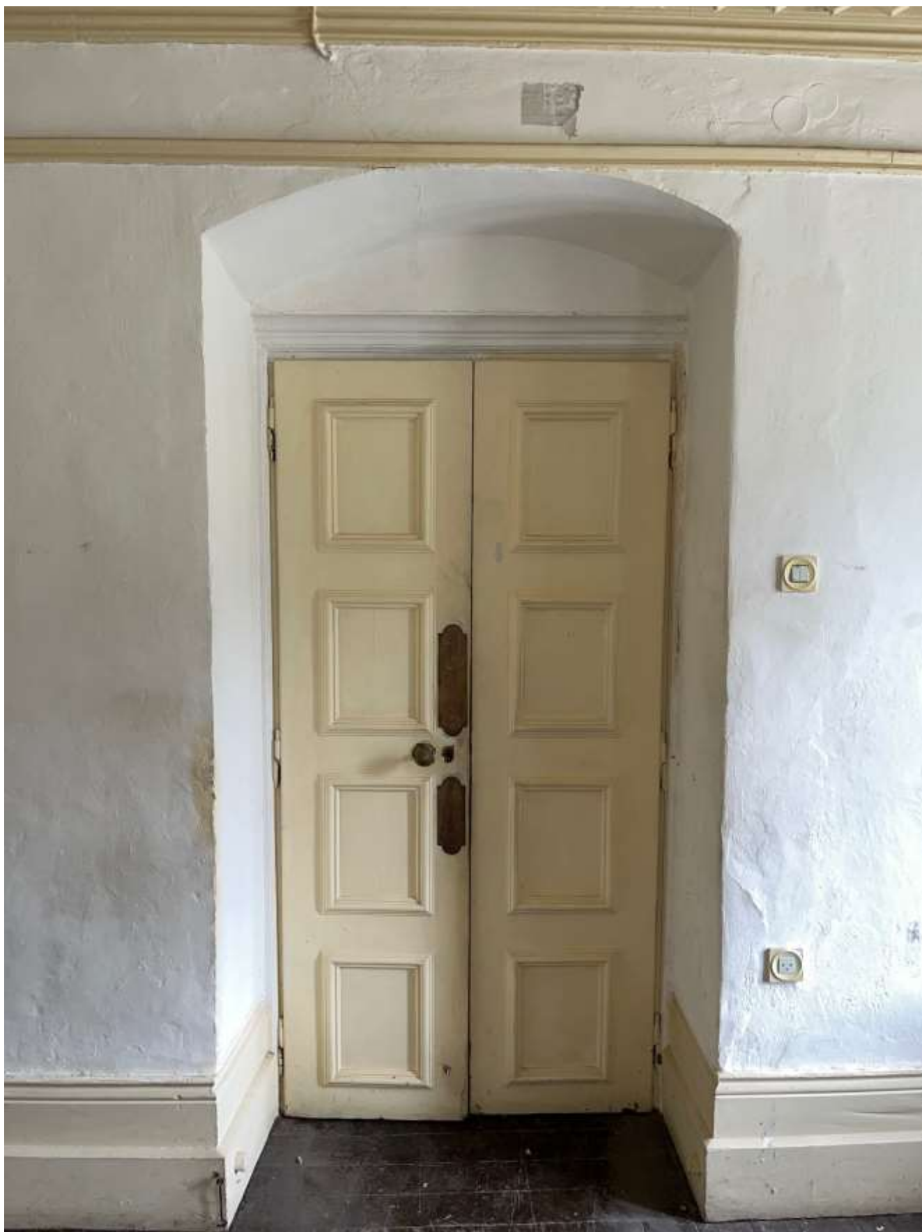
Εικ.174: Θύρα χώρου ΙΣ2 (εσωτερική όψη)
