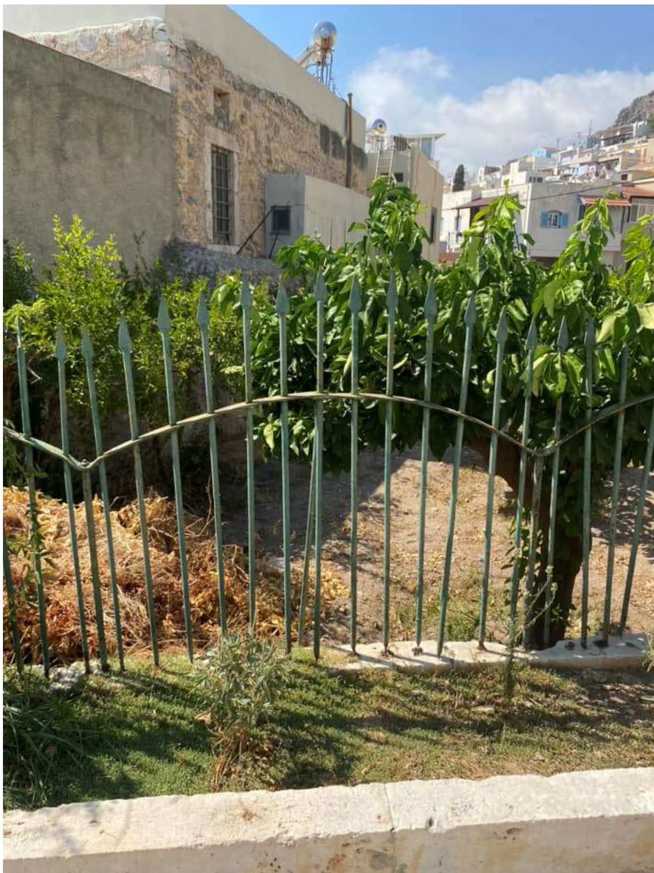
Εικ.130: Κιγκλίδωμα περιβολιού, 3 ο τμήμα.
