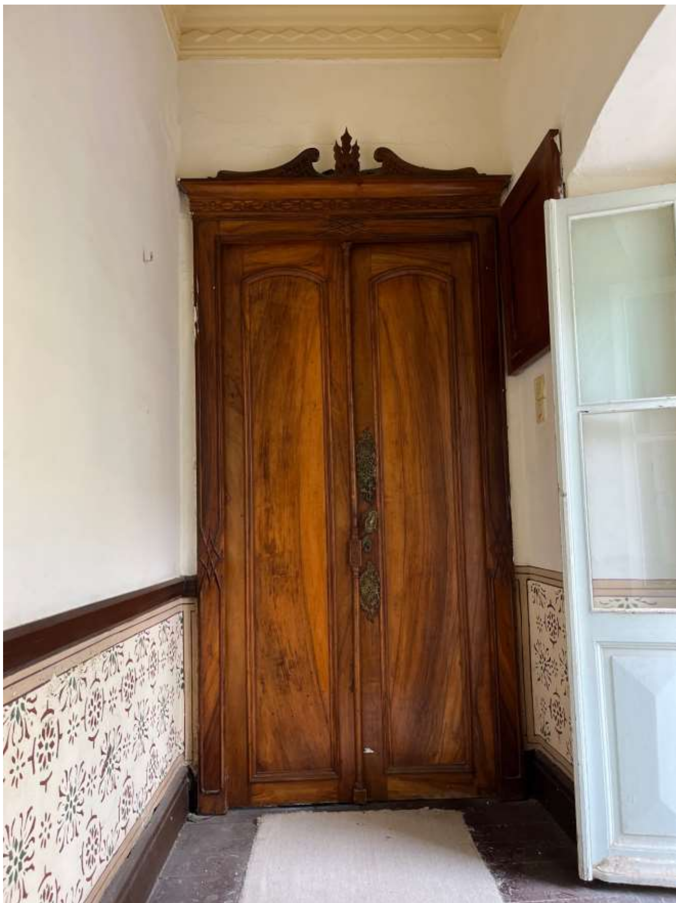
Εικ.209: Ξύλινη πόρτα χώρου Α2
