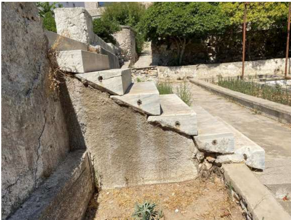
Εικ.162: Σέρα. Μαρμάρινη σκάλα – πλαϊνή όψη – νότια)
