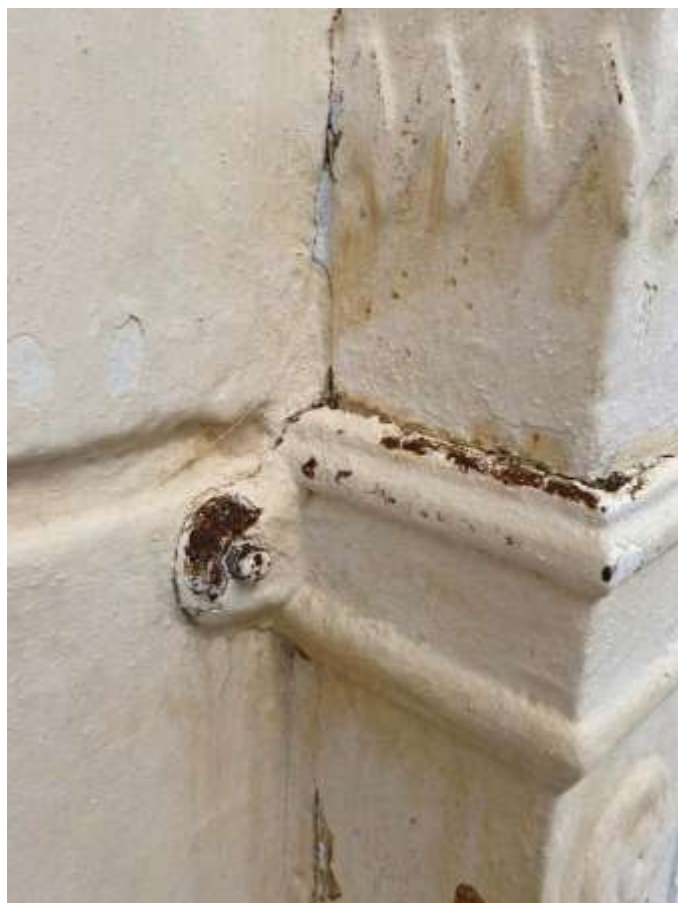
Εικ.48: Υδρορροή νότιας όψης - λεπτομέρεια
