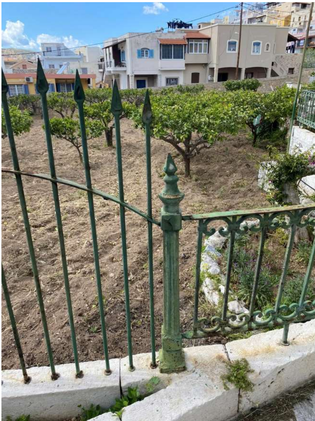
Εικ.142: Κολωνάκι από χυτοσίδηρο μεταξύ κιγκλιδωμάτων περιβολιού και προαυλίου
