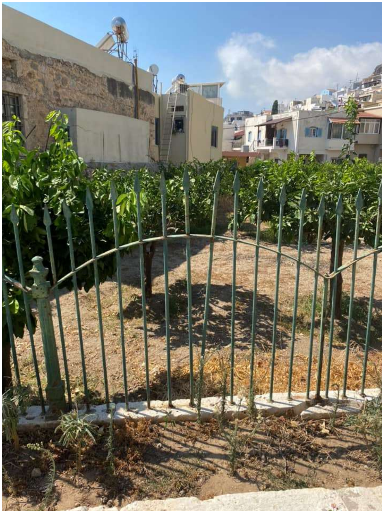
Εικ.132: Κιγκλίδωμα περιβολιού, 5 ο τμήμα.
