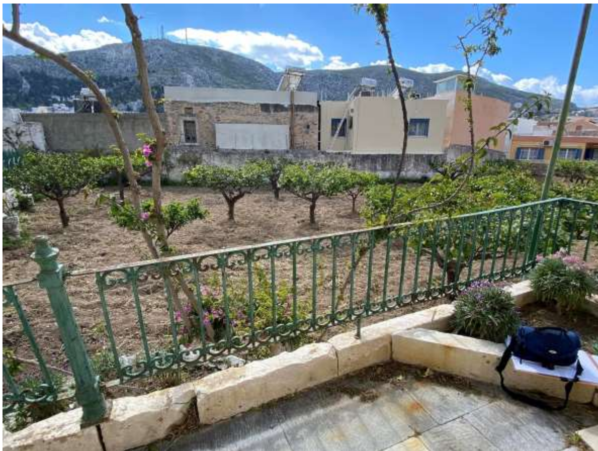
Εικ.148: Κιγκλιδώματα προαύλιου, δυτικό τμήμα, λεπτομέρεια
