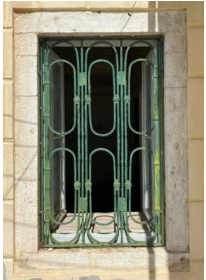
Εικ.29: Παράθυρο νότιας όψης του χώρου ΙΣ2 (2° από δυτικά)
