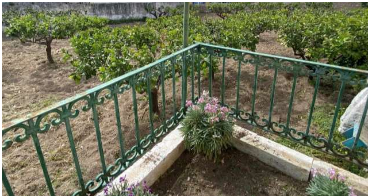
Εικ.149: Κιγκλιδώματα προαύλιου, δυτικό τμήμα, λεπτομέρεια
