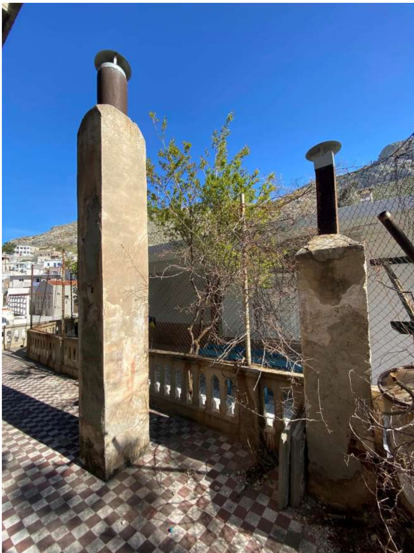
Εικ.86: Βεράντα βόρειας όψης, βόρειο τμήμα, άποψη από ΝΑ
