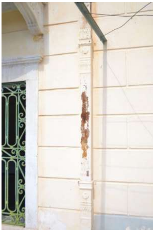
Εικ.47: Υδρορροή νότιας όψης - λεπτομέρεια
