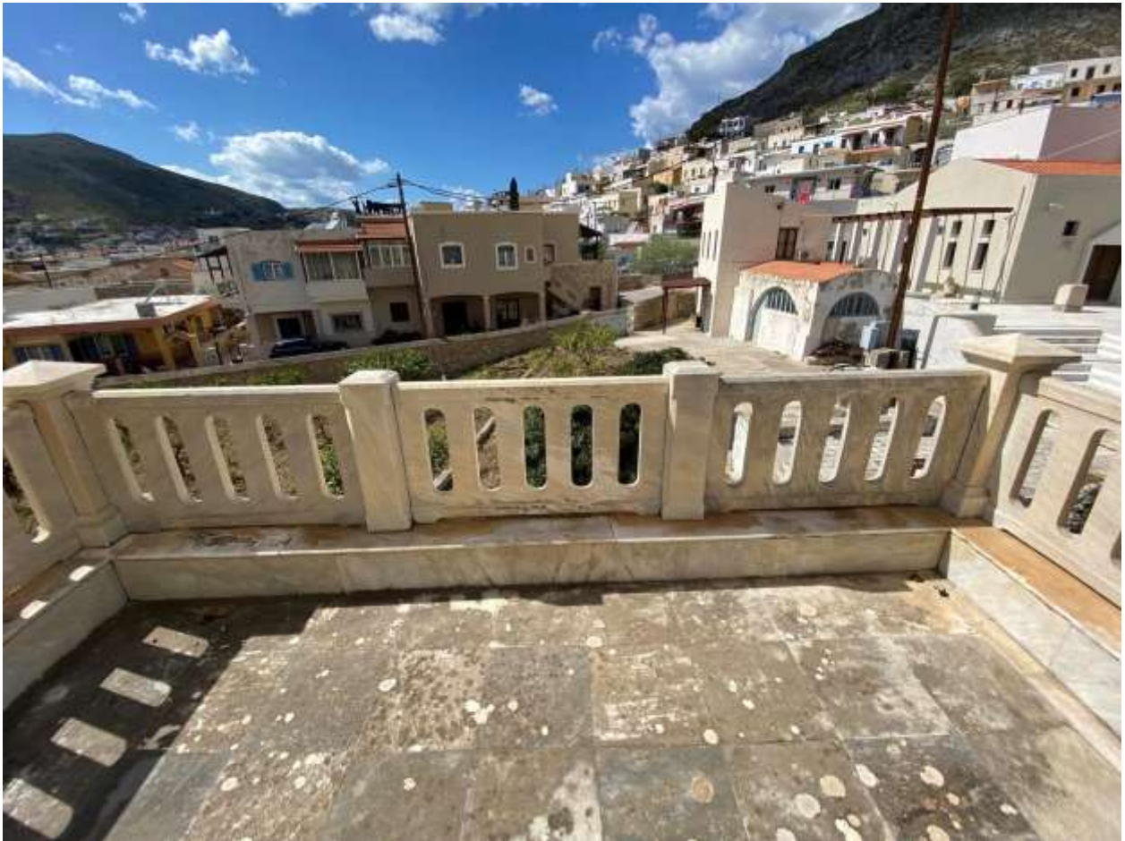
Εικ.70: Δυτικό τμήμα βεράντας δυτικής όψης
