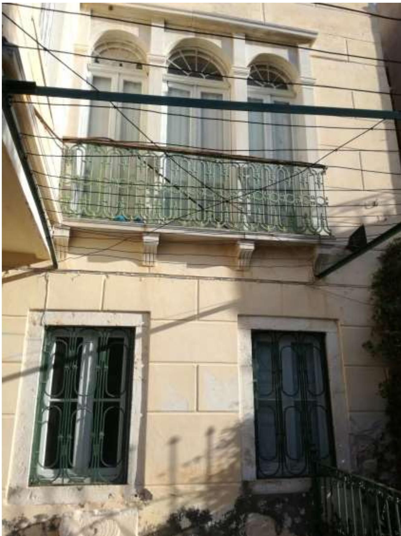
Εικ.54: Νότια όψη, ανατολικό τμήμα
