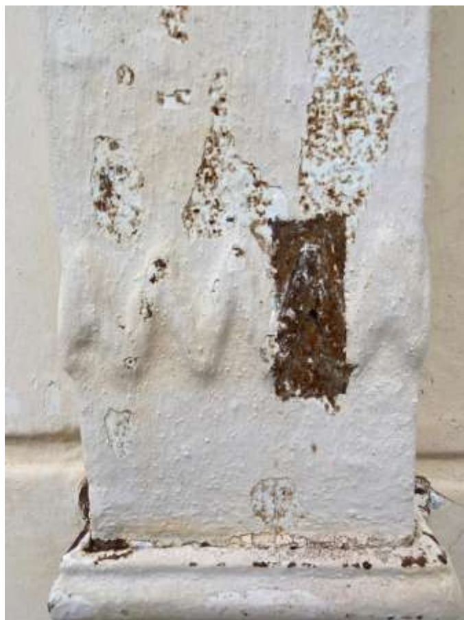
Εικ.49: Υδρορροή νότιας όψης - λεπτομέρεια
