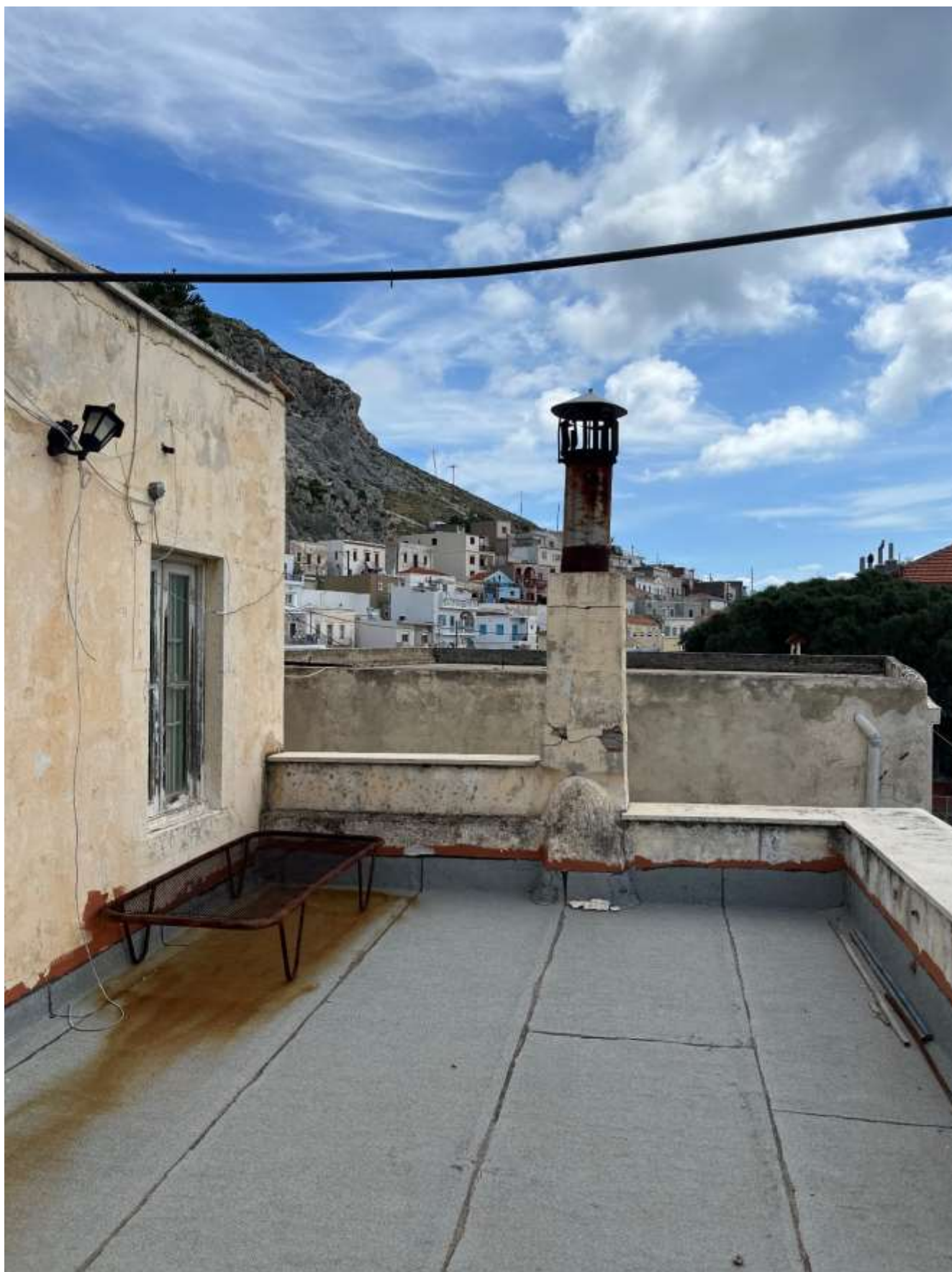
Εικ.62: Δώμα χώρου A5 – μεταλλική καμινάδα
