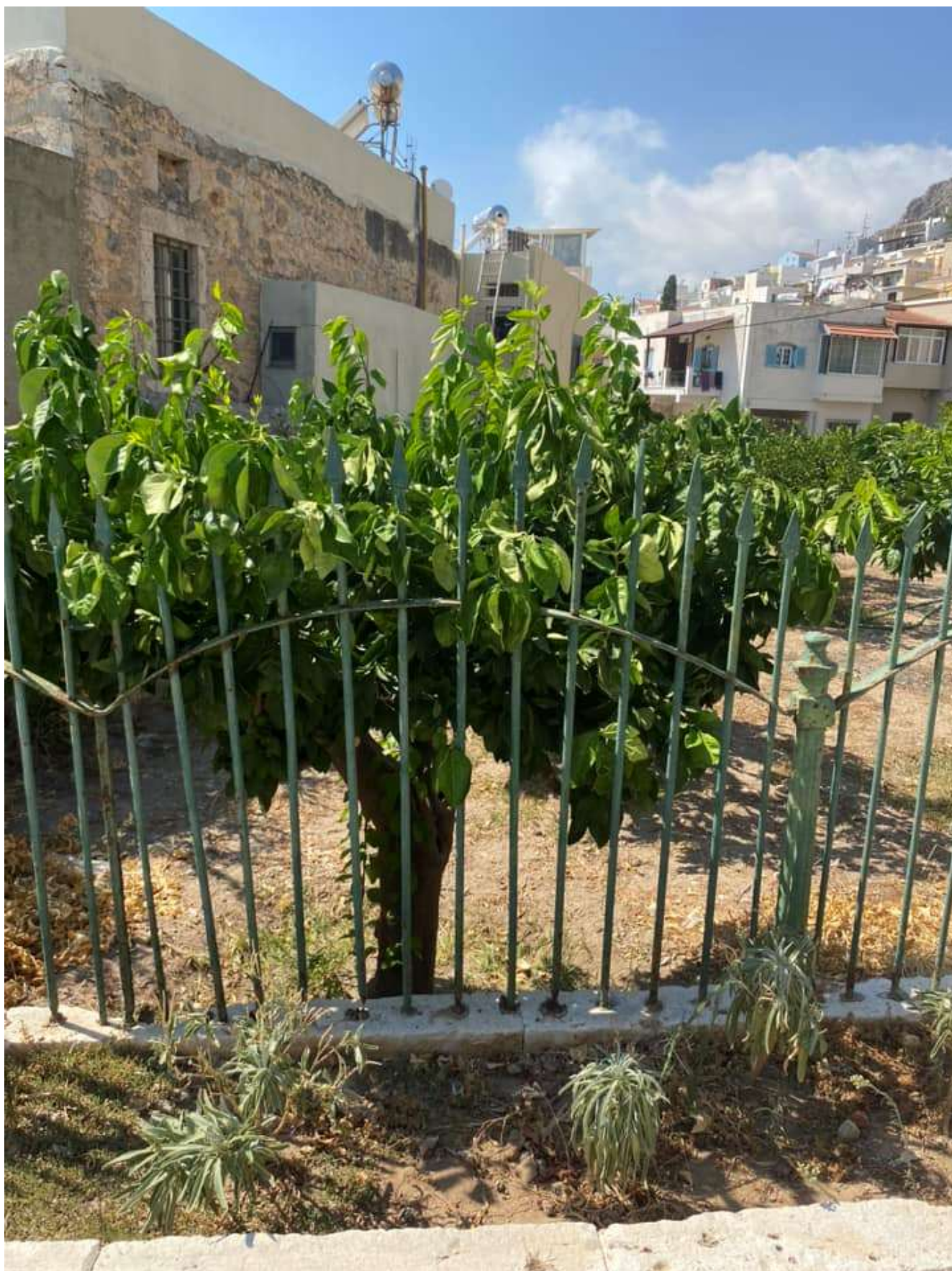
Εικ.131: Κιγκλίδωμα περιβολιού, 4 ο τμήμα.
