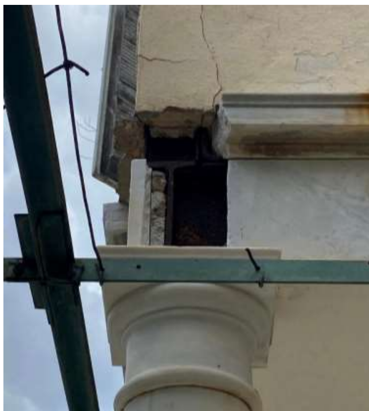
Εικ.18: Μαρμάρινη επένδυση προστώου – λεπτομέρεια: απώλεια τμήματος πάνω από την ανατολική γωνία
