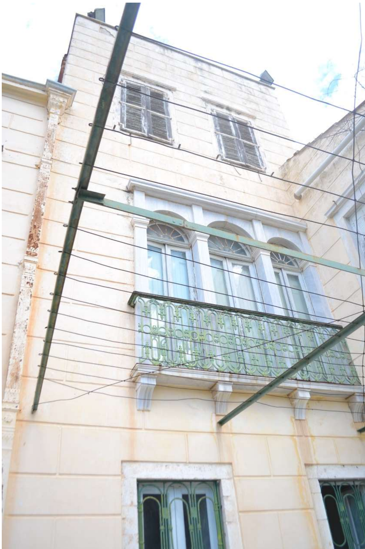
Εικ.50: Νότια όψη, εξώστης χώρου Α3
