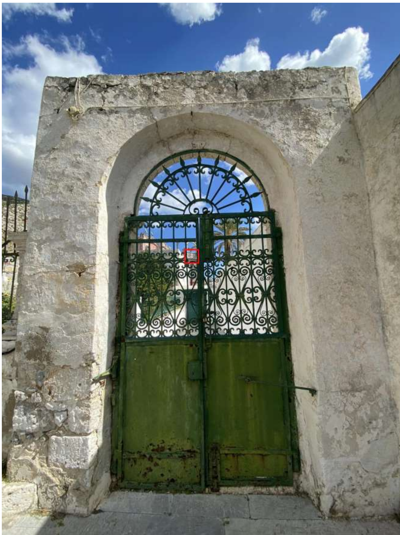
Εικ.99: Εσωτερική όψη αυλόθυρας. Σε κόκκινο πλαίσιο τα απολεσθέντα τμήματα του κιγκλιδώματος.
