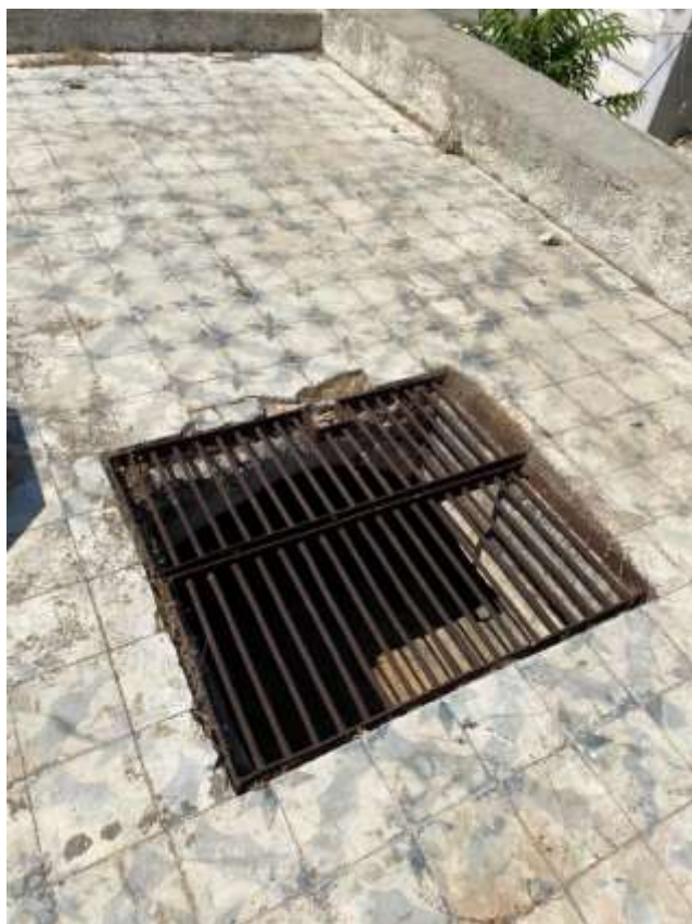
Εικ.160: Σέρα. Δάπεδο με τσιμεντοπλακίδια.
