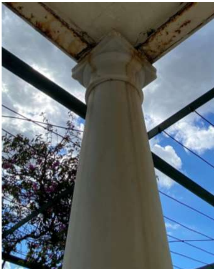
Εικ.19: Δυτικός πεσσός προστώου – λεπτομέρεια εσωτερικής όψης
