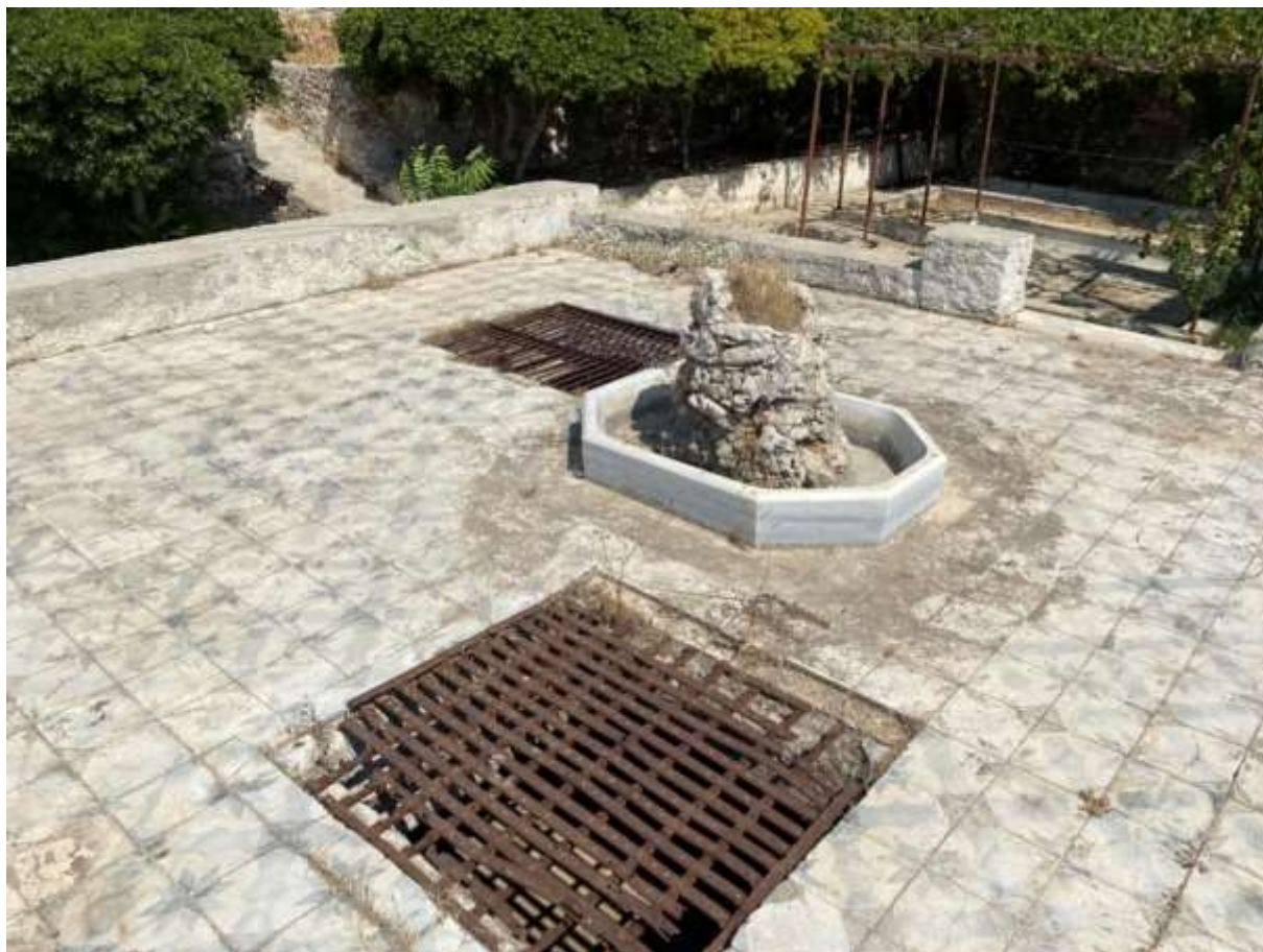
Εικ.159: Σέρα. Δάπεδο με τσιμεντοπλακίδια.
