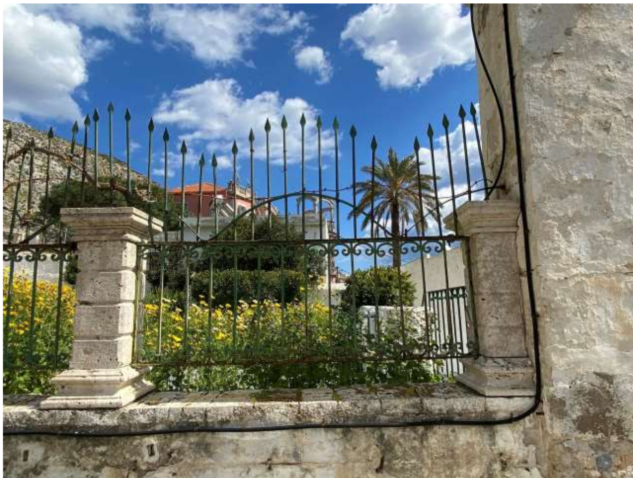
Εικ.118: Κιγκλίδωμα αυλόγυρου, τμήμα μεταξύ 10 ου και 11 ου πεσσού
