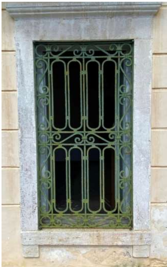
Εικ.22: Παράθυρο νότιας όψης του χώρου ΙΣ5 (1° από δυτικά)
