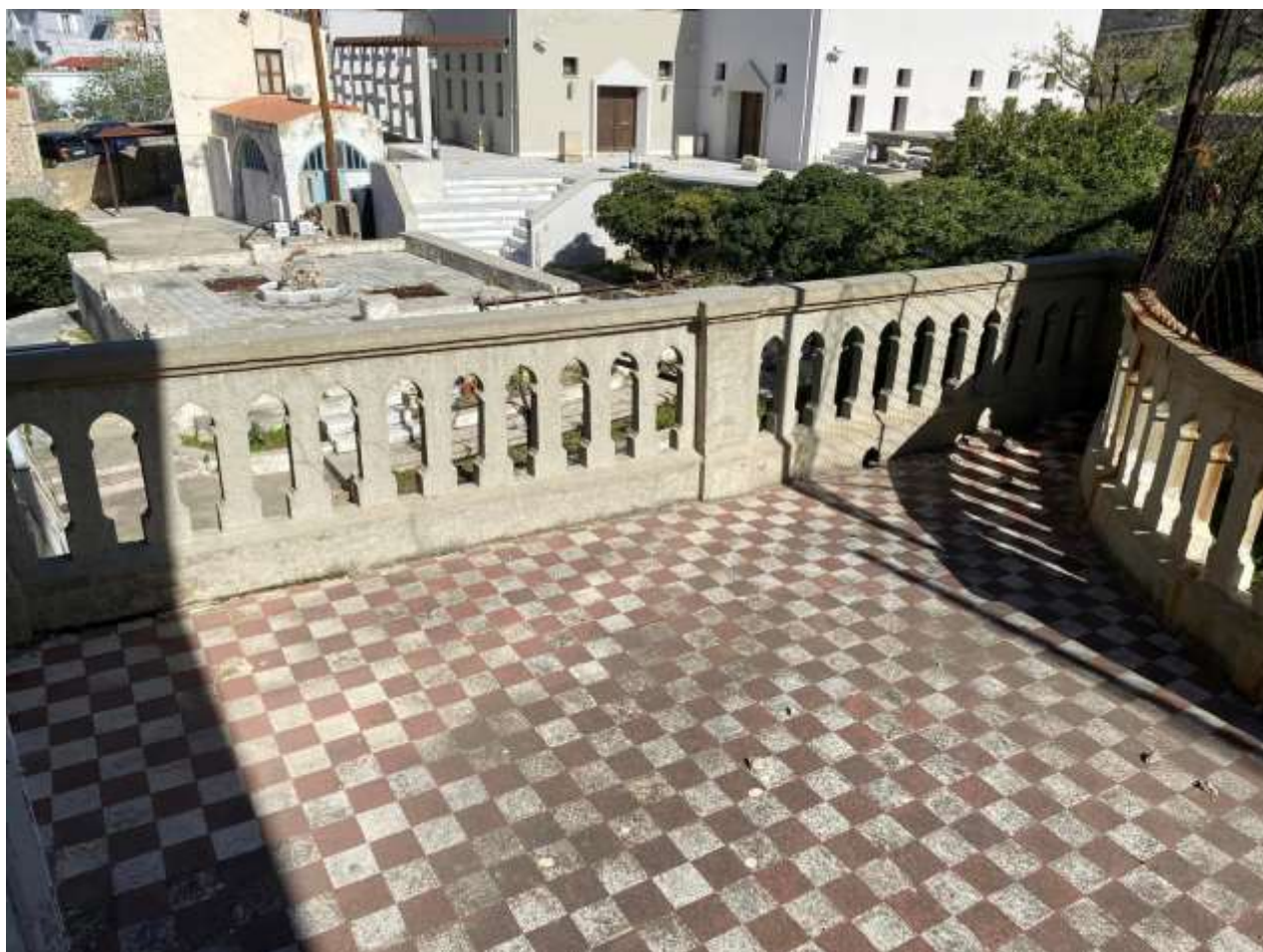
Εικ.83: Βεράντα βόρειας όψης – δυτικό τμήμα, άποψη από Α
