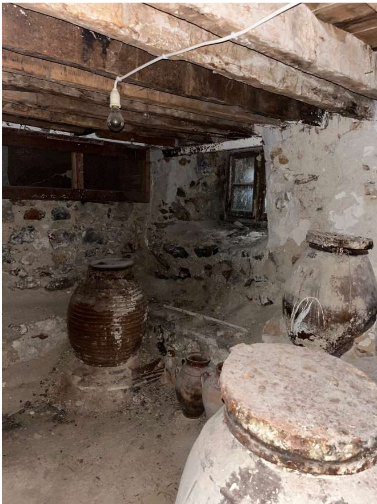
Εικ.167: Άποψη χώρου ΥΠ3
