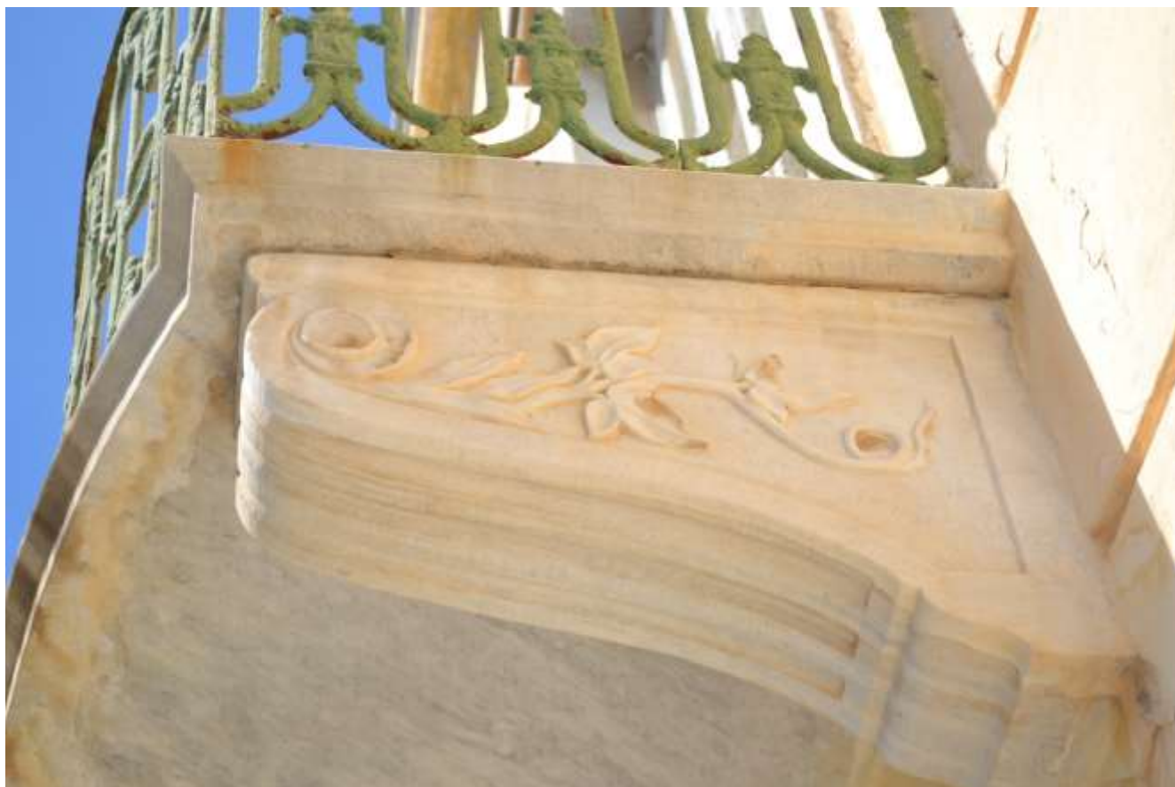
Εικ.42: Ανατολικό φουρούσι εξώστη νότιας όψης χώρου Α2 (2 ου από δυτικά)
