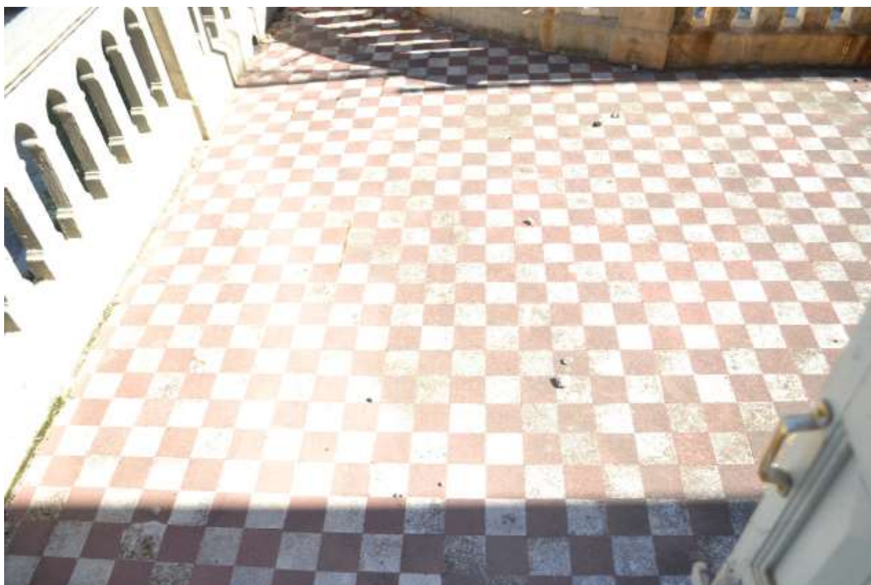
Εικ.84: Βεράντα βόρειας όψης – δυτικό τμήμα, άποψη από Ν
