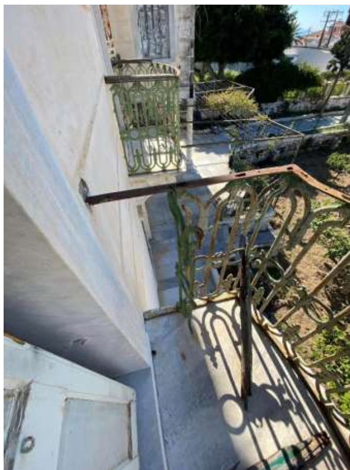
Εικ.39: Εσωτερική όψη εικ. 38
