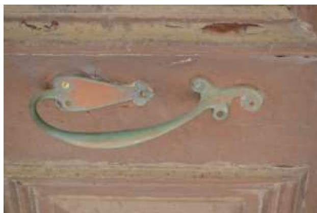
Εικ.14α-β: Λεπτομέρειες κεντρικής εισόδου – μπρούτζινα πόμολα
