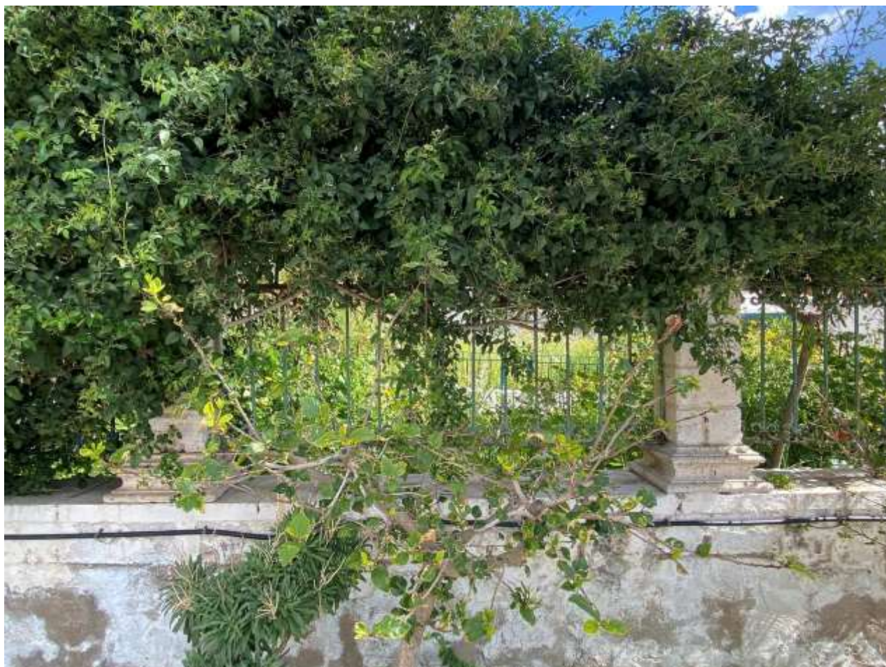
Εικ.112: Κικκλίδωμα αυλόγυρου, τμήμα μεταξύ 6 ου και 7 ου πεσσού
