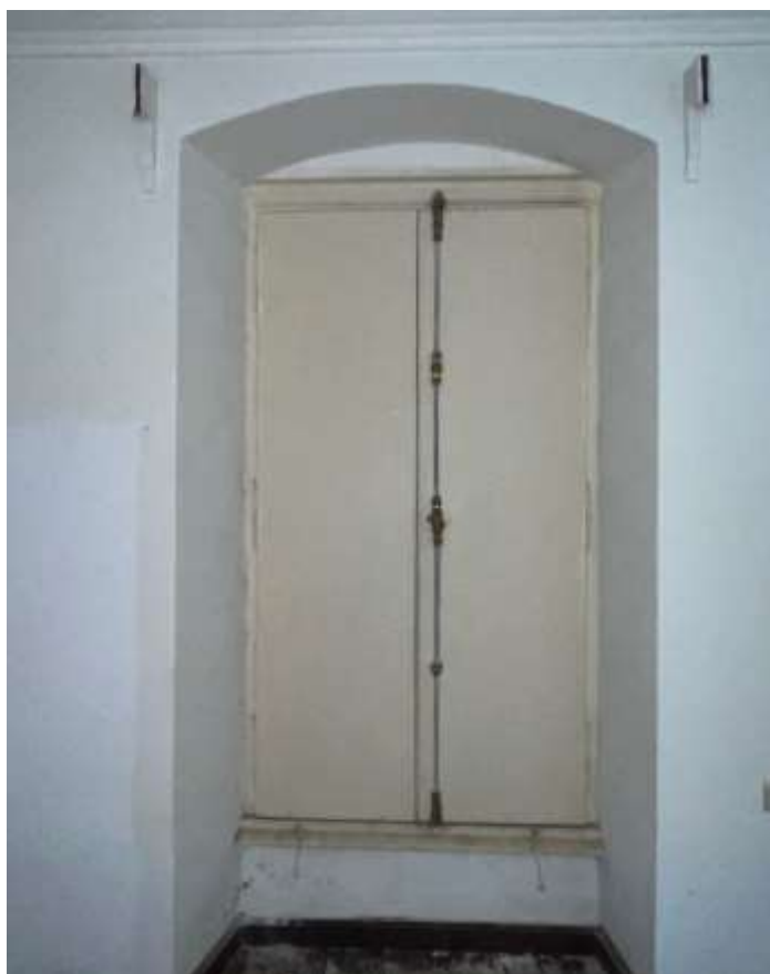
Εικ.190: Δεξί παράθυρο νότιου τοίχου χώρου ΙΣ5
