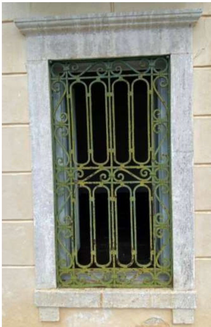
Εικ.23: Παράθυρο νότιας όψης του χώρου ΙΣ5 (2° από δυτικά)
