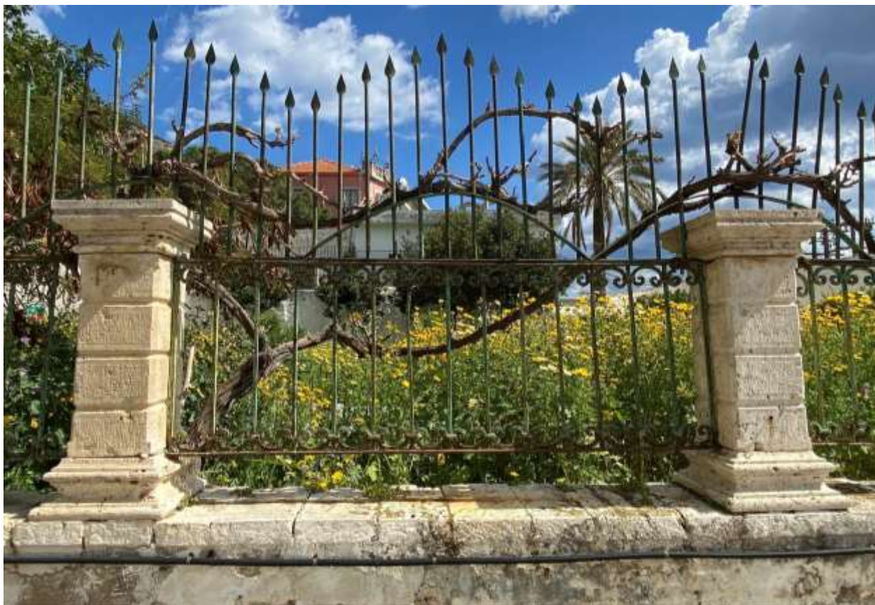
Εικ.114: Κιγκλίδωμα αυλόγυρου, τμήμα μεταξύ 8 ου και 9 ου πεσσού
