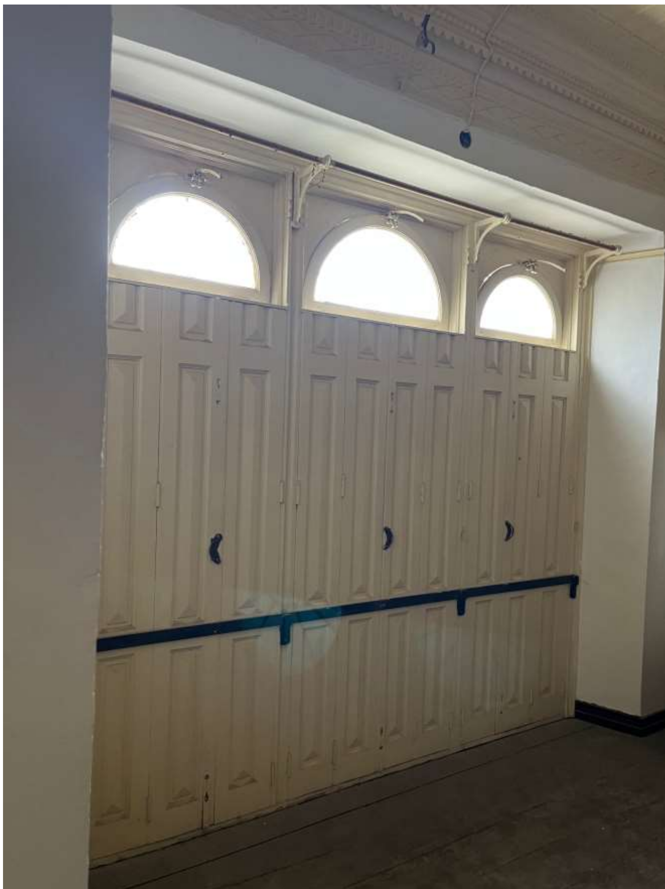
Εικ.222: Εξωστόθυρες χώρου Α3 (όμοιες με αυτές του χώρου Α5)
