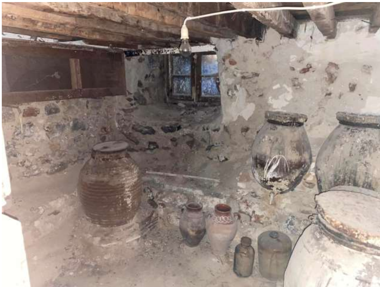
Εικ.168: Άποψη χώρου ΥΠ3
