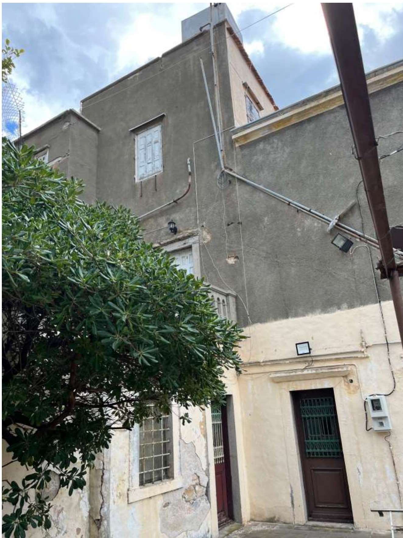
Εικ.79: Τμήμα βόρειας όψης.
