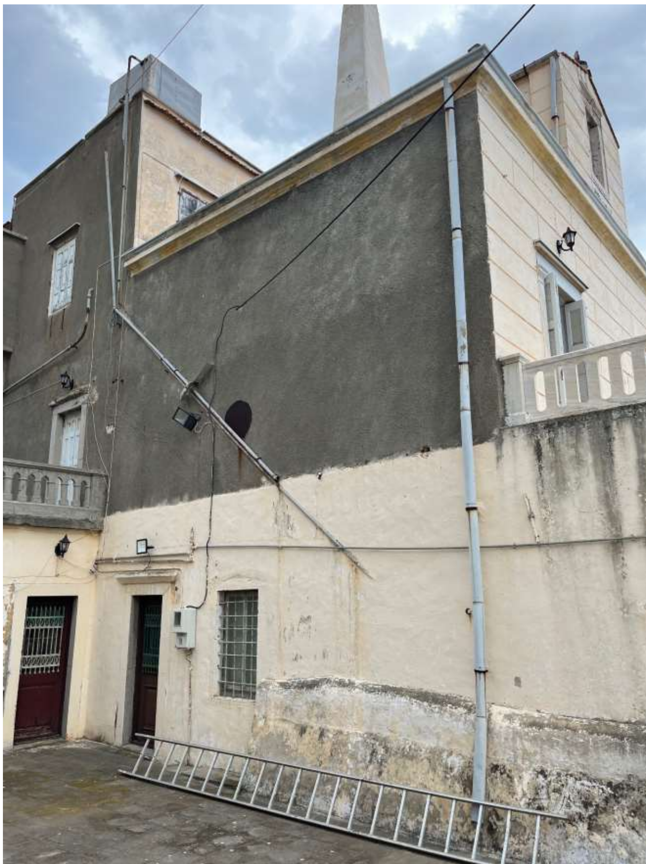
Εικ.78: Δυτικό τμήμα βόρειας όψης
