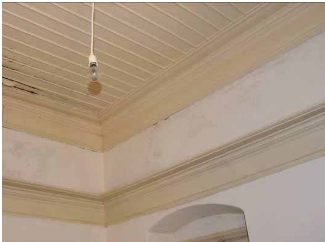
Φωτ. 293 Το γείσο της οροφής του χώρου Α6.
