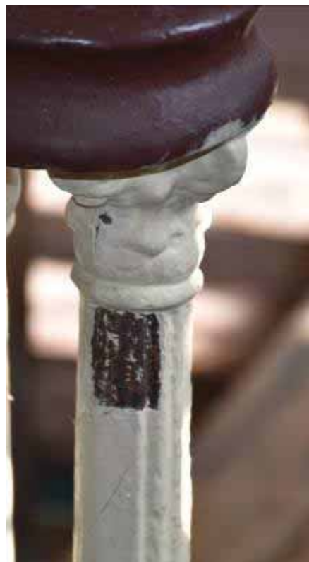
Φωτ. 239 Τα δείγματα αποκάλυψης που περικλείονται με κόκκινο πλαίσιο στην προηγούμενη φωτογραφία. Το συγκεκριμένο κιγκλίδωμα που βρίσκεται στον χώρο Β1 είναι μεταλλικό.
