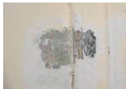
Φωτ. 396 Τα δείγματα αποκάλυψης στην ξύλινη θύρα και το κάσωμα του χώρου Β4.
