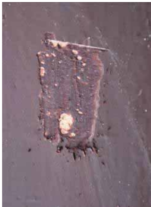
Φωτ. 389 Τα δείγματα αποκάλυψης στην ξύλινη θύρα και το κάσωμα του χώρου Α4.
