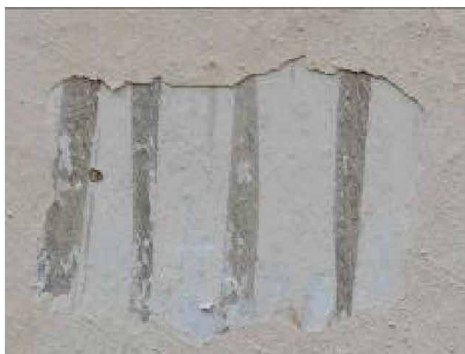
Φωτ. 21 Οι τέσσερις διερευνητικές- στρωματογραφικές τομές που πραγματοποιήθηκαν στην βόρεια όψη.
