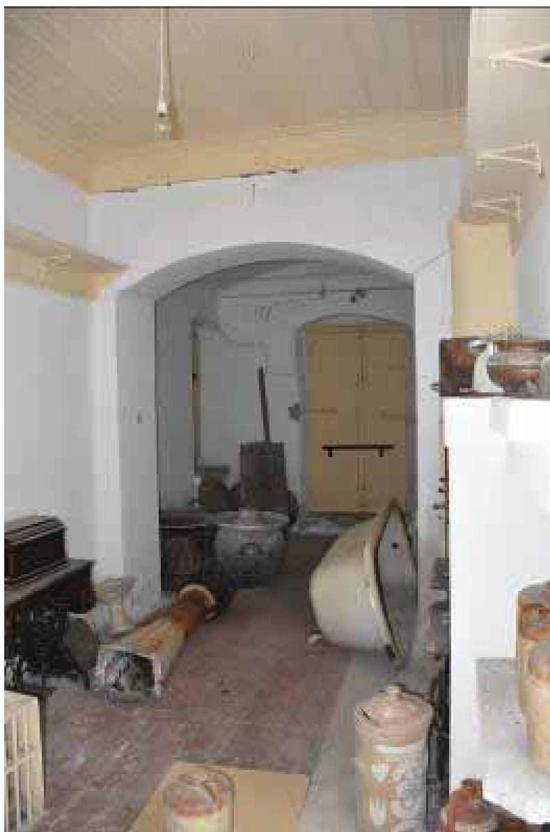
Φωτ. 115 Άποψη του χώρου ΙΣ6α-β.
