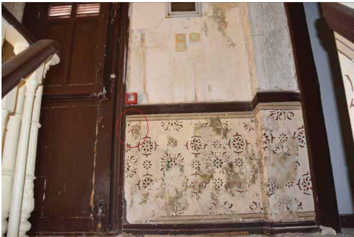
Φωτ. 155 Διερευνητική τομή στο μέσο των κατακόρυφων τοίχων του χώρου Β1.
