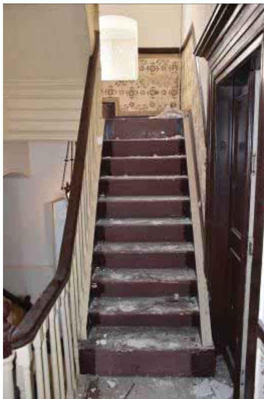
Φωτ. 182 Άποψη του κλιμακοστασίου από τον α΄ όροφο προς τον β΄.
