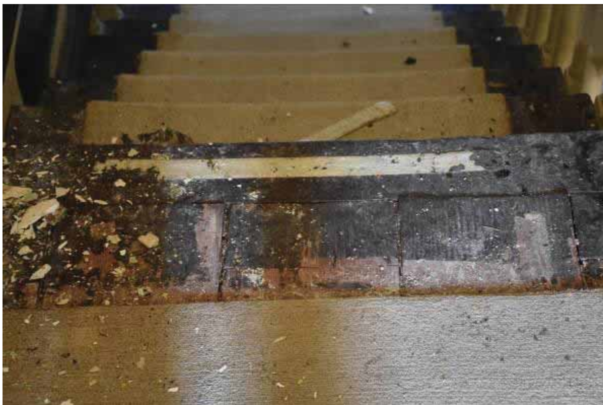
Φωτ. 335 Τμήμα του ξύλινου πατώματος του χώρου Α1α το οποίο δεν είναι καλυμμένο με μοκέτα.
