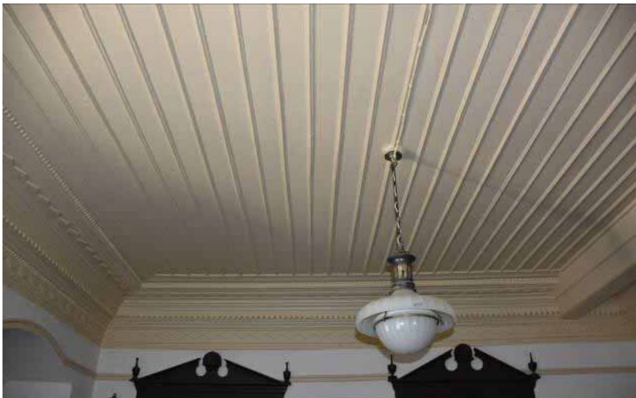
Φωτ. 267 Η ξύλινη οροφή του χώρου ΙΣ2.
