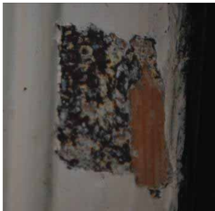
Φωτ. 375 Το δείγμα αποκάλυψης στην ξύλινη θύρα του χώρου ΙΣ5.
