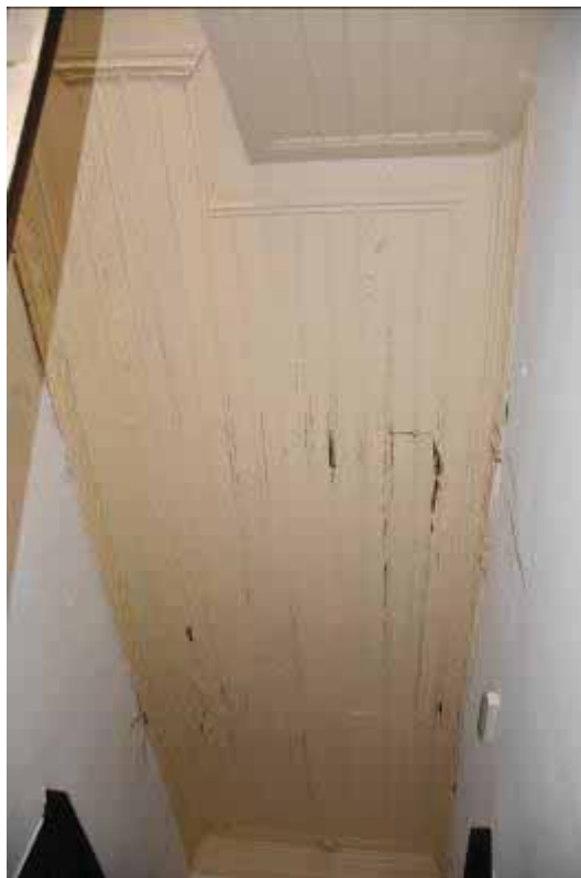
Φωτ. 278 Η ξύλινη οροφή του χώρου Α1α.
