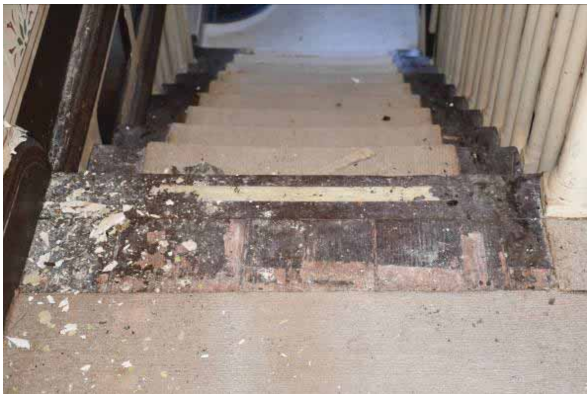
Φωτ. 356 Εκδορές και υπολείμματα της συγκολλητικής από την τοποθέτηση μοκετών στο δάπεδο του χώρου Α1.
