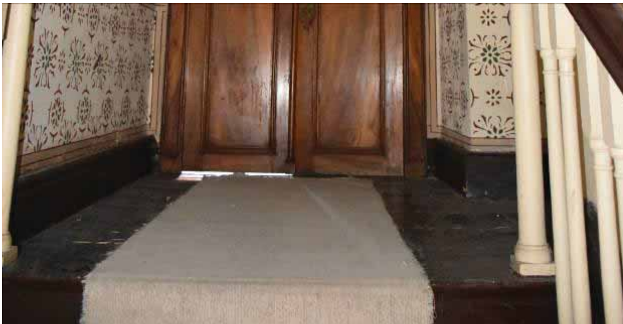
Φωτ. 336 Το ξύλινο δάπεδο του χώρου Α1β.
