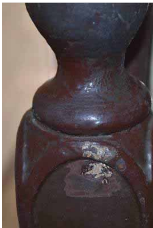
Φωτ. 237 Δείγμα αποκάλυψης στα κιγκλιδώματα της ξύλινης κλίμακας.
