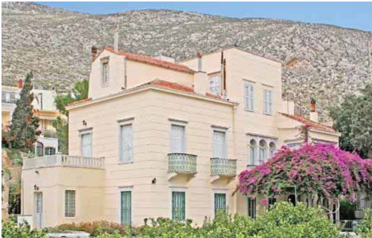
Φωτ. 1 Άποψη του Αρχοντικού Βουβάλη, όπου μπορούμε να διακρίνουμε τη σύνθετη κατασκευή με την παρουσία δώματος και ξύλινης στέγης καλυμμένη από κεραμίδια γαλλικού τύπου
