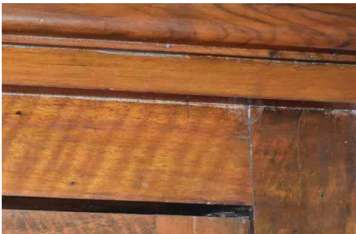
Φωτ. 470 Ρωγματώσεις και επικαθίσεις ρύπων στην ξύλινη ντουλάπα του χώρου Α3.
