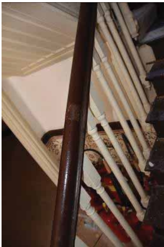
Φωτ. 236 Δείγμα αποκάλυψης στην κουπαστή της ξύλινης κλίμακας.
