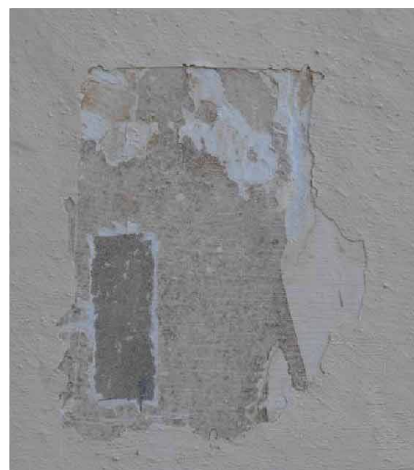
Φωτ. 22 Λεπτομέρειες των τομών τις προηγούμενης φωτογραφίας. Οι γκρι γραμμές που αποκαλύφθηκαν στα δείγματα είναι μίγμα υγρών και σκουριάς που προέρχονται από τις μεταλλικές σωληνώσεις.
