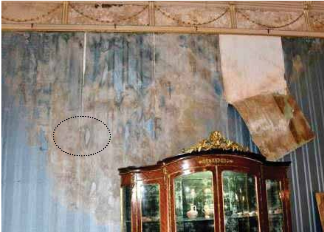
Φωτ. 223 Σκισίματα, αποκολλήσεις, αποχρωματισμοί, λεκέδες υγρασίας και ανάπτυξη μυκήτων στην ταπετσαρία των τοίχων.
