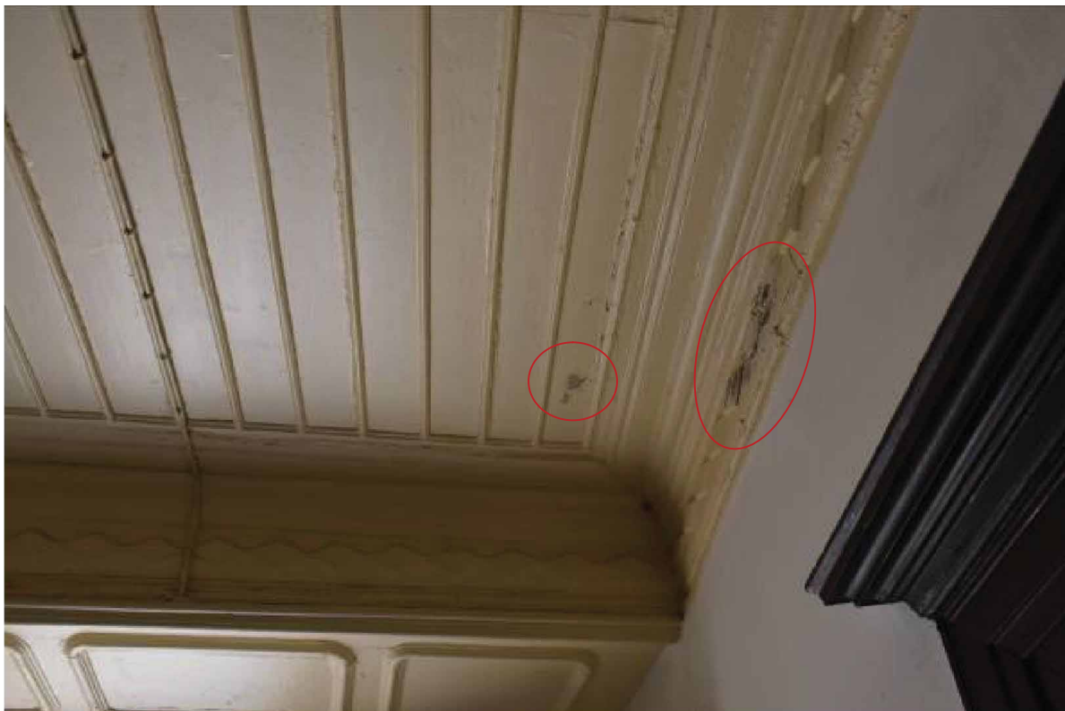
Φωτ. 261 Δείγματα αποκάλυψης στην ξύλινη οροφή του χώρου ΙΣ1α.
