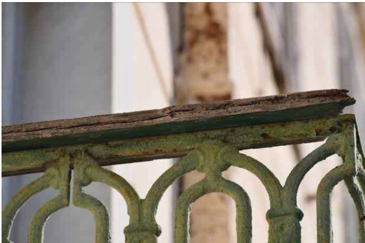
Φωτ. 480 Λεπτομέρεια της υδρολυμένης και αποσαθροποιημένης ξύλινης κουπαστής.
