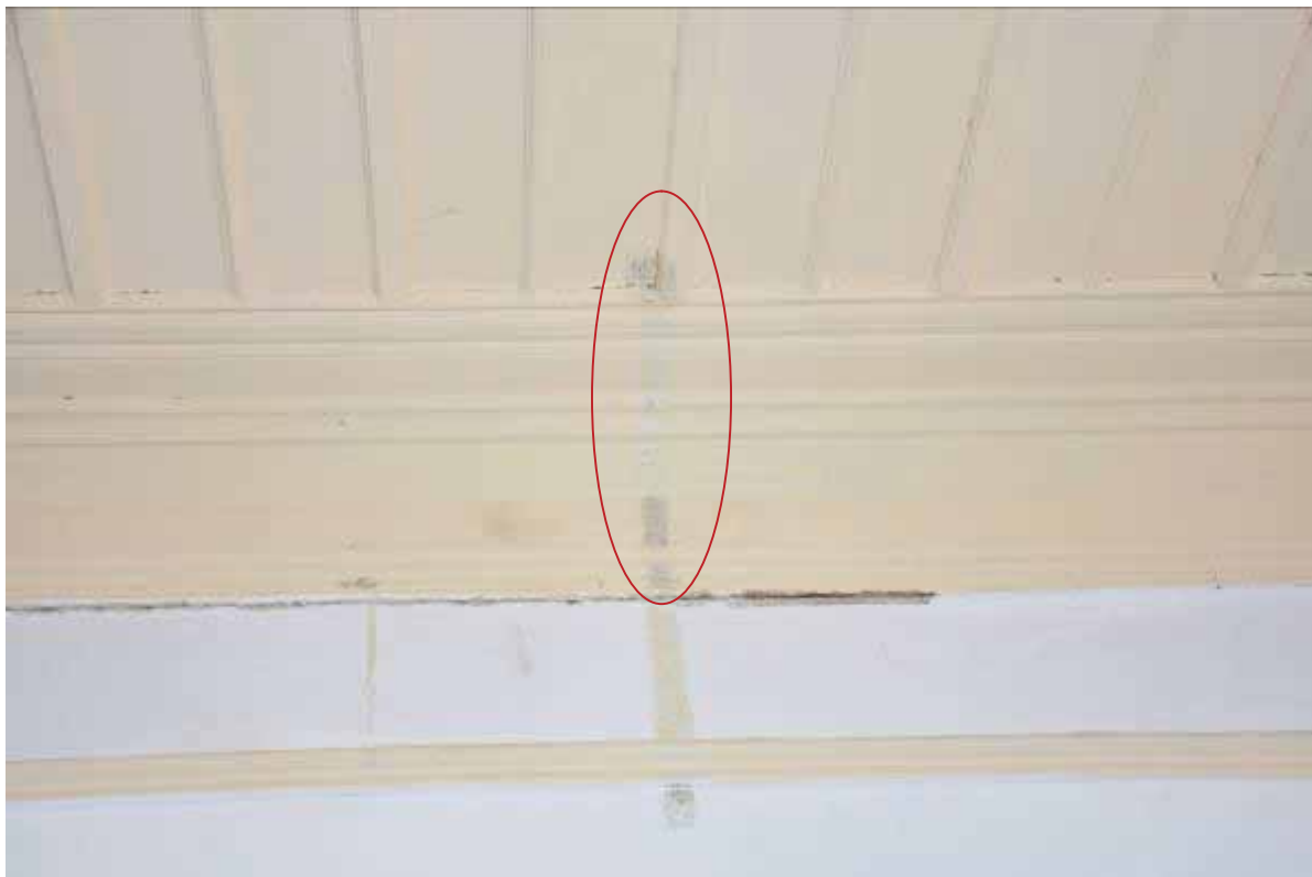
Φωτ. 304 Δείγματα αποκάλυψης στην ξύλινη οροφή του χώρου Β4.
