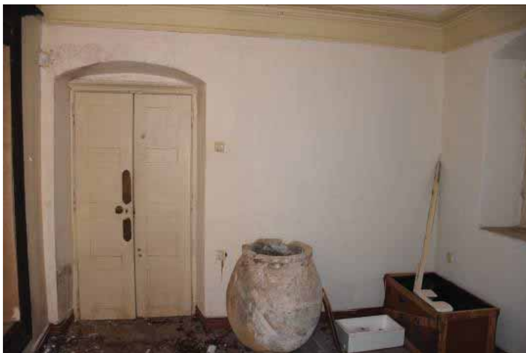
Φωτ. 150 Άποψη του χώρου Α6.
