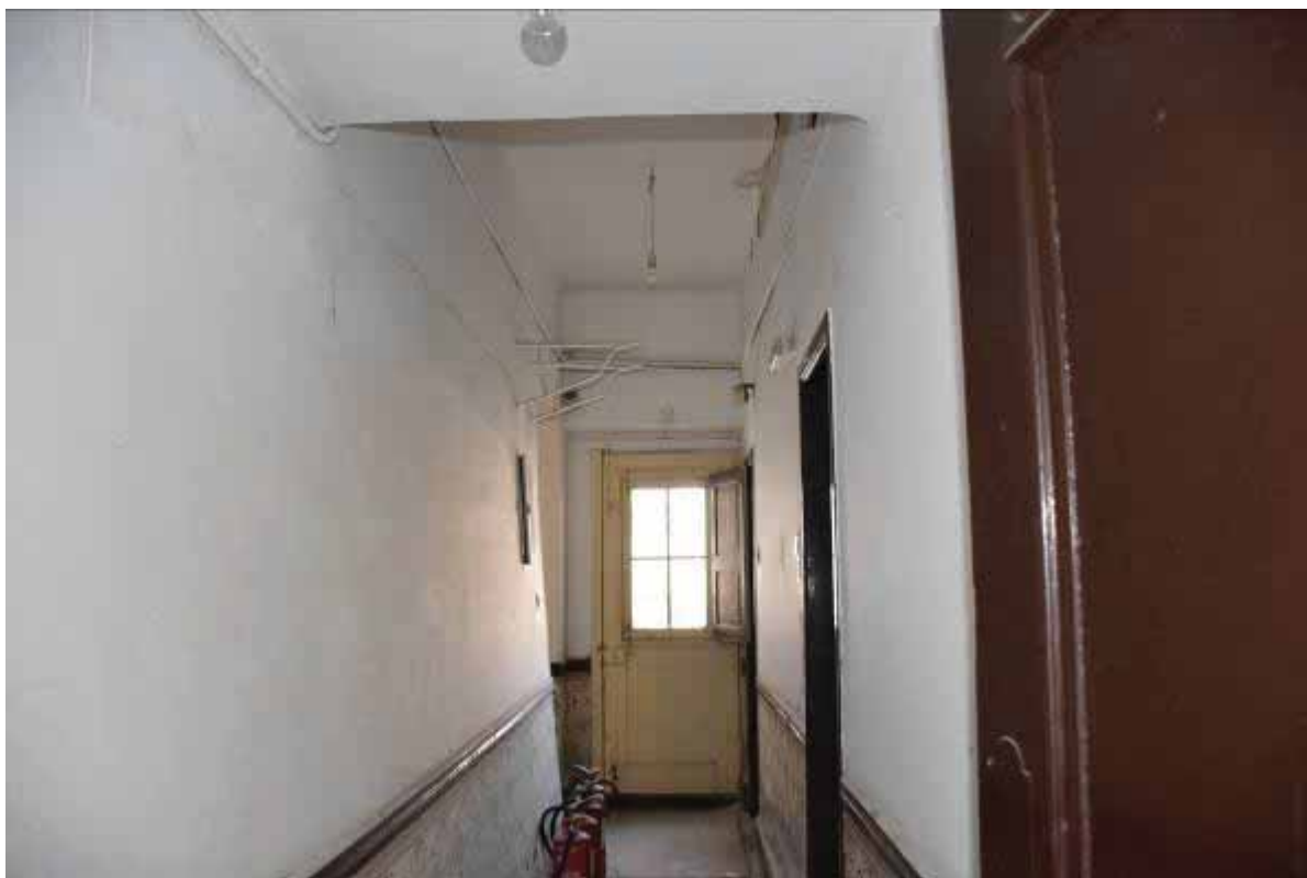
Φωτ. 117 Άποψη του χώρου ΙΣ7.
