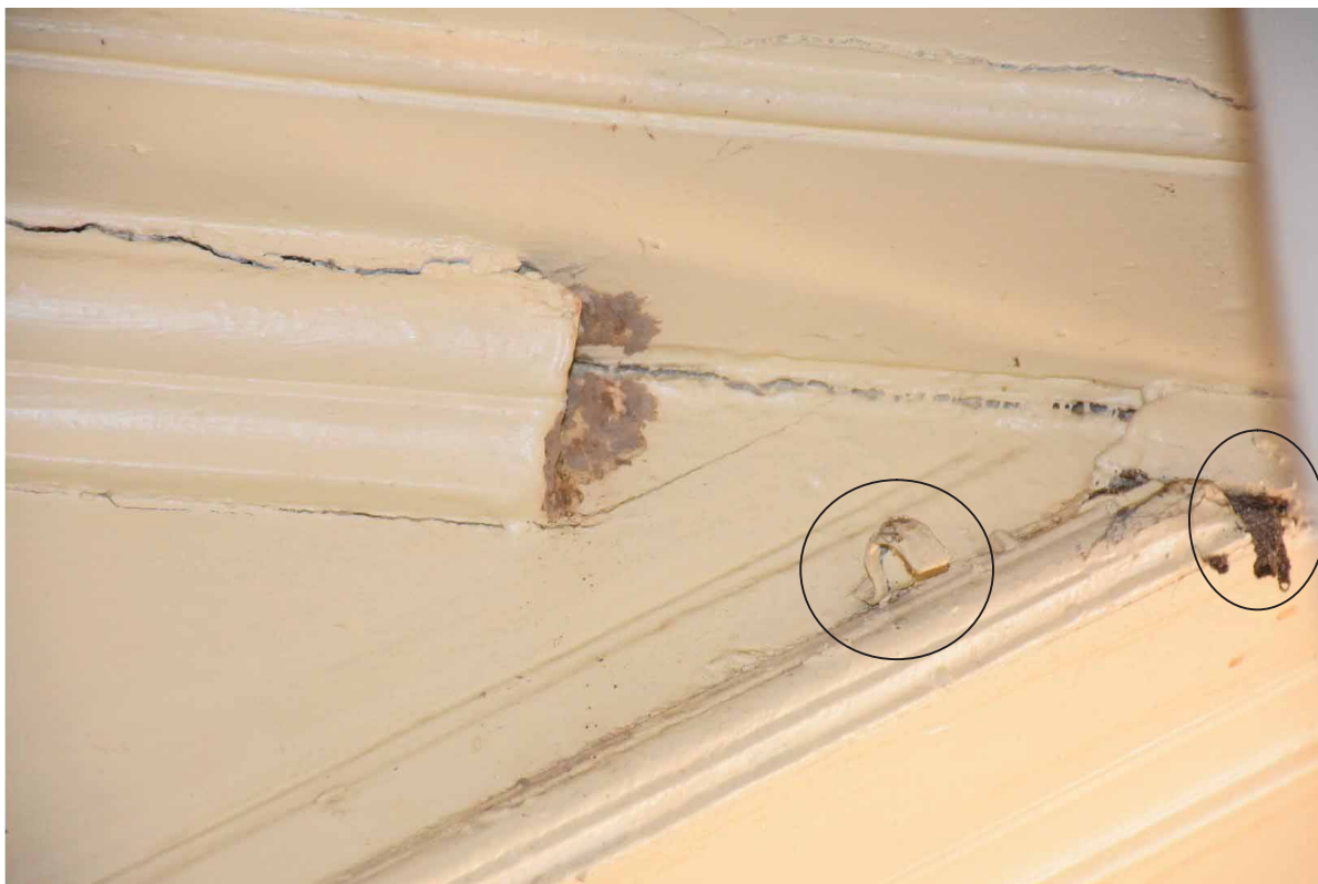
Φωτ. 251 Ρωγματώσεις και αποκολλήσεις ξύλινων στοιχείων. Τοποθετήσεις μεταλλικών συνδέσμων στήριξης καλωδιώσεων και παρουσία περιττωματικών υλικών (φαγωμένο ξύλο και ακαθαρσίες) από ξυλοφάγα έντομα (τερμίτες).
