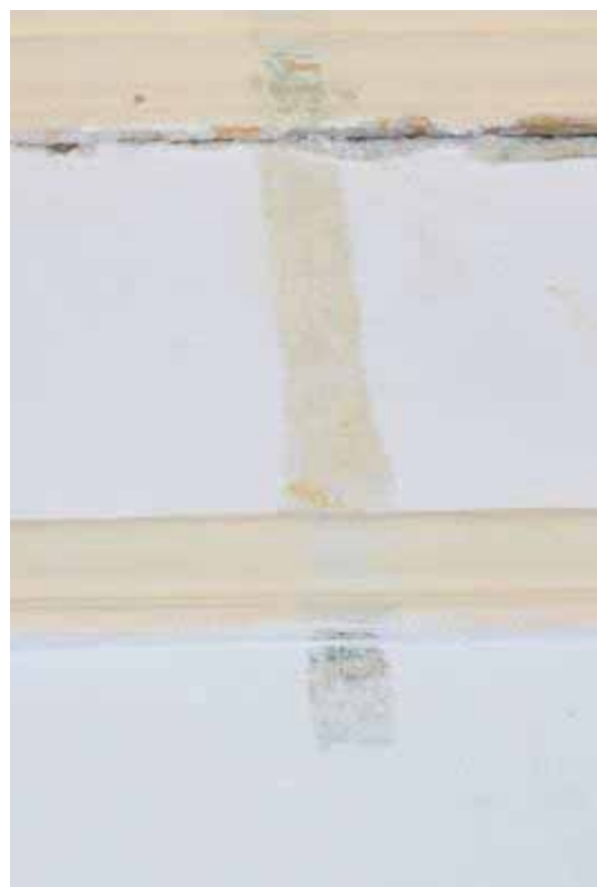
Φωτ. 171 Διερευνητική τομή στην ανώτερη περιοχή των κατακόρυφων τοίχων, κάτω από την ξύλινη οροφή του χώρου Β4.
