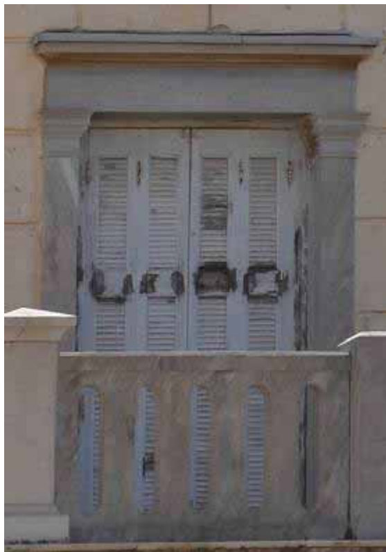
Φωτ. 420 Η εξωστόθυρα της δυτικής όψης του χώρου Α2.
