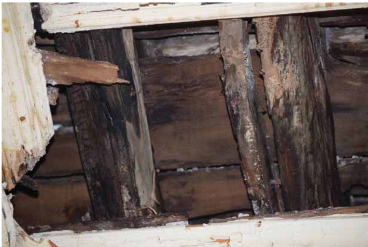
Φωτ. 9 Λεπτομέρεια της παραπάνω φωτογραφίας, όπου διακρίνονται οι φέροντες ξύλινοι δοκοί πάνω στις οποίες καρφώνονται τα σανιδώματα των πατωμάτων και των οροφών.
