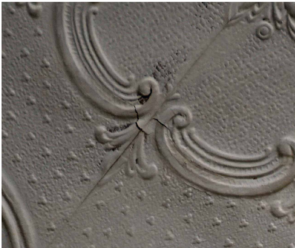
Φωτ. 209 Μικροσκιζήματα και ανάπτυξη βιολογικών επικαθίσεων.
