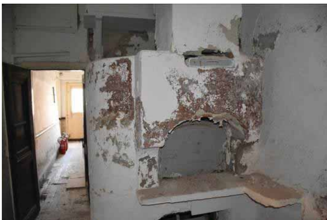
Φωτ. 123 Άποψη του χώρου ΙΣ8.
