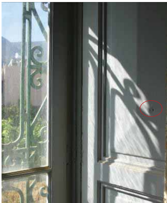
Φωτ. 412 Το δείγμα αποκάλυψης στο σκούρο του ανοίγματος του χώρου ΙΣ5.
