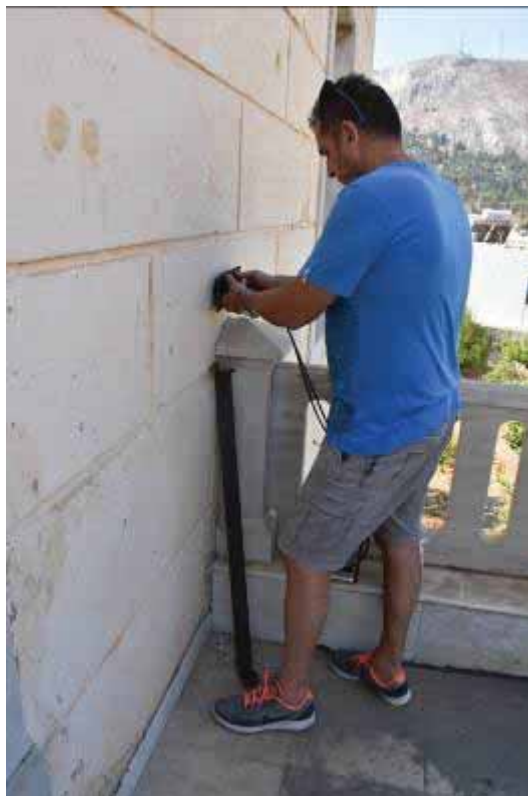
Φωτ. 29 Μέτρηση με τη συσκευή υπερήχων για τον έλεγχο στερεότητας των κονιαμάτων.
