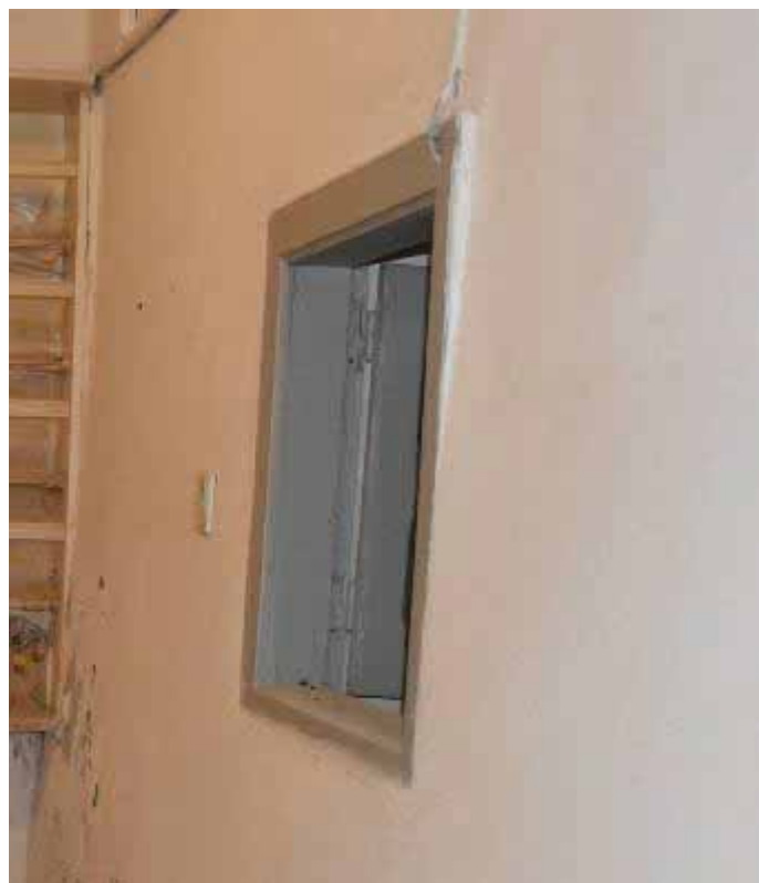
Φωτ. 416 Το άνοιγμα στον νότιο τοίχο του χώρου ΙΣ8 το οποίο επικοινωνεί με τον χώρο ΙΣ4.
