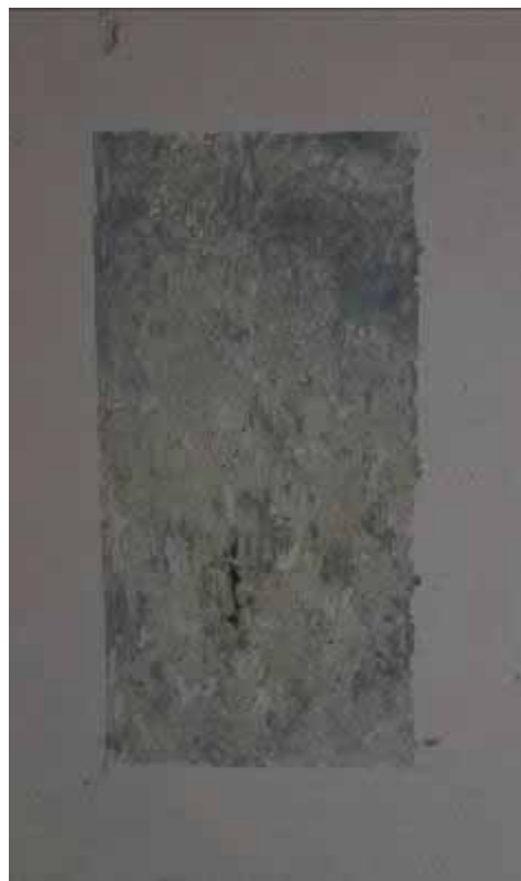
Φωτ. 170 Διερευνητική τομή στο μέσο των κατακόρυφων τοίχων του χώρου Β4.
