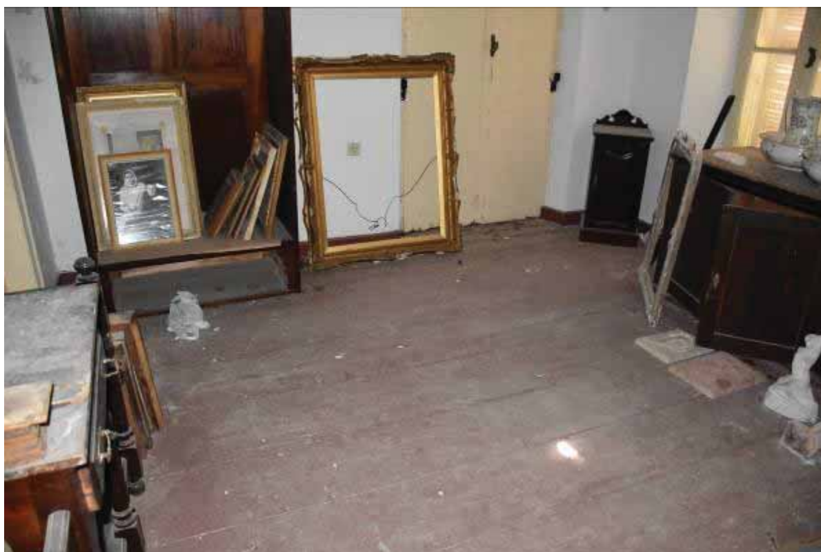
Φωτ. 347 Το ξύλινο δάπεδο του χώρου Β4.
