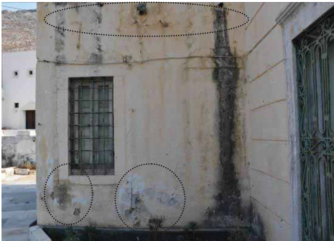
Φωτ. 45 Ρηγματώσεις, αποκολλήσεις, κονιορτοποιήσεις, απώλειες και ανάπτυξη βιολογικών επικαθίσεων στο επίχρυσμα της δυτικής όψης.
