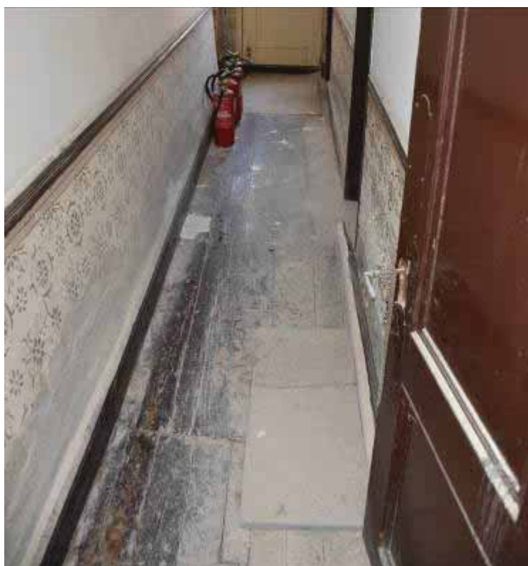
Φωτ. 333 Το ξύλινο δάπεδο του χώρου ΙΣ7.
