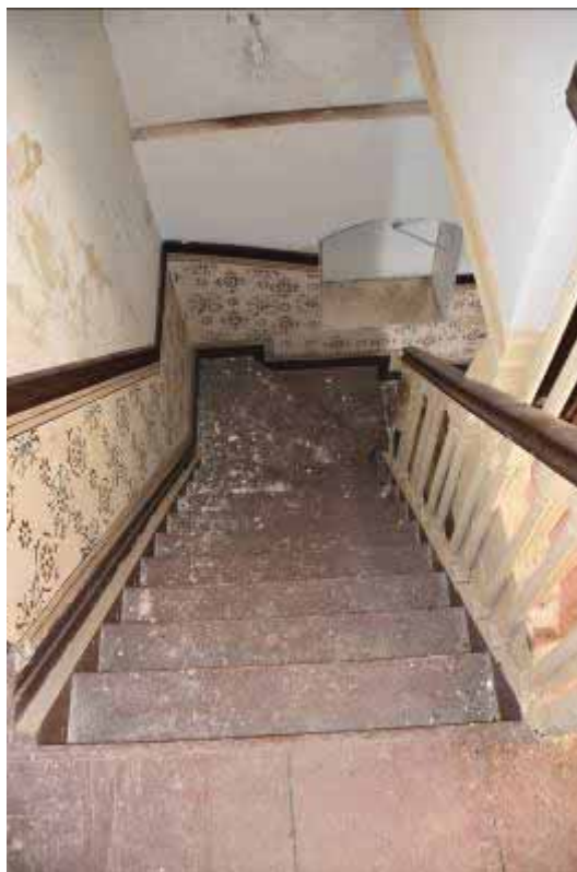
Φωτ. 183 Άποψη του κλιμακοστασίου από τον α΄ όροφο προς τον β΄.
