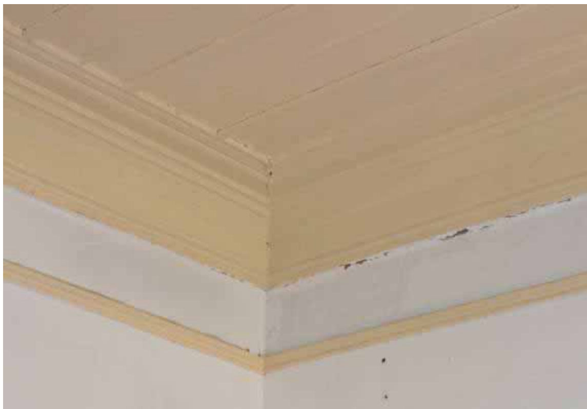
Φωτ. 303 Το γείσο της οροφής του χώρου Β4.
