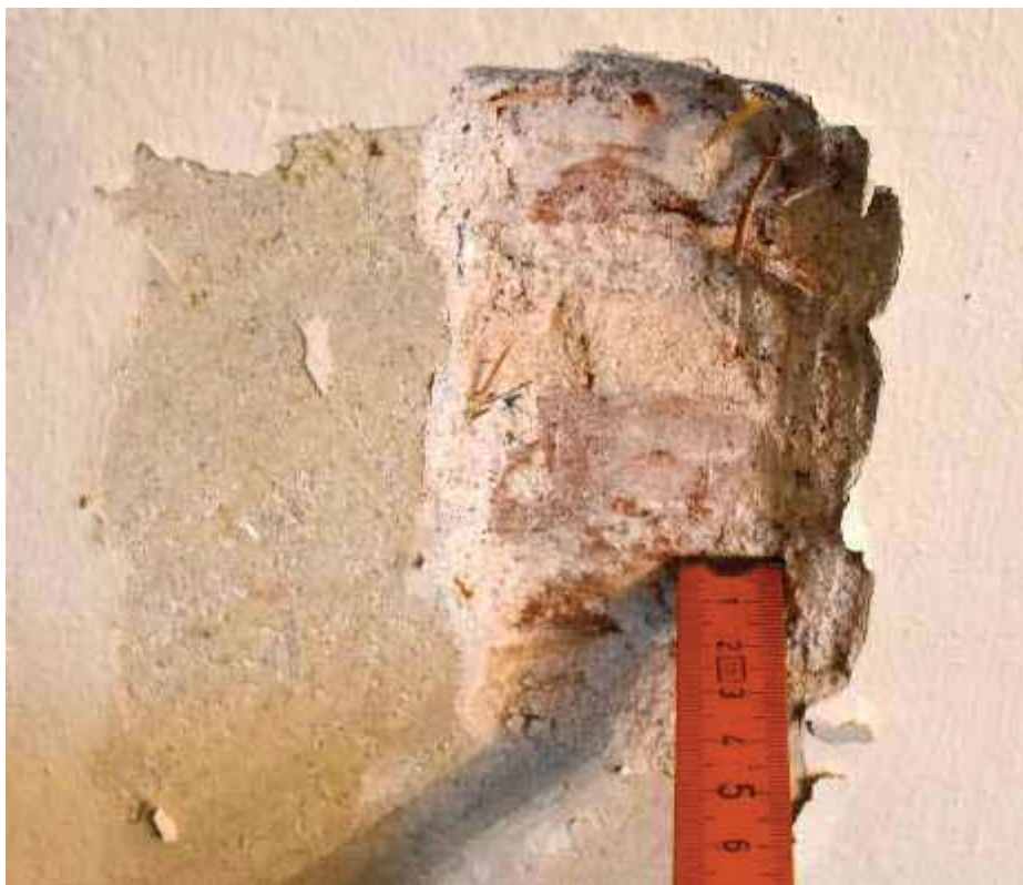
Φωτ. 63 Πλινθοδομή με ασβεστοκονίαμα που περιέχει αδρανή και άχυρο σε κατακόρυφο τοίχο του χώρου ΙΣ5.
