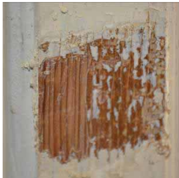
Φωτ. 442 Τα δείγματα αποκάλυψης στο άνοιγμα του χώρου Β3 σε απομίμηση ξύλου σε σχέδια κωνοφόρου ξύλου.
