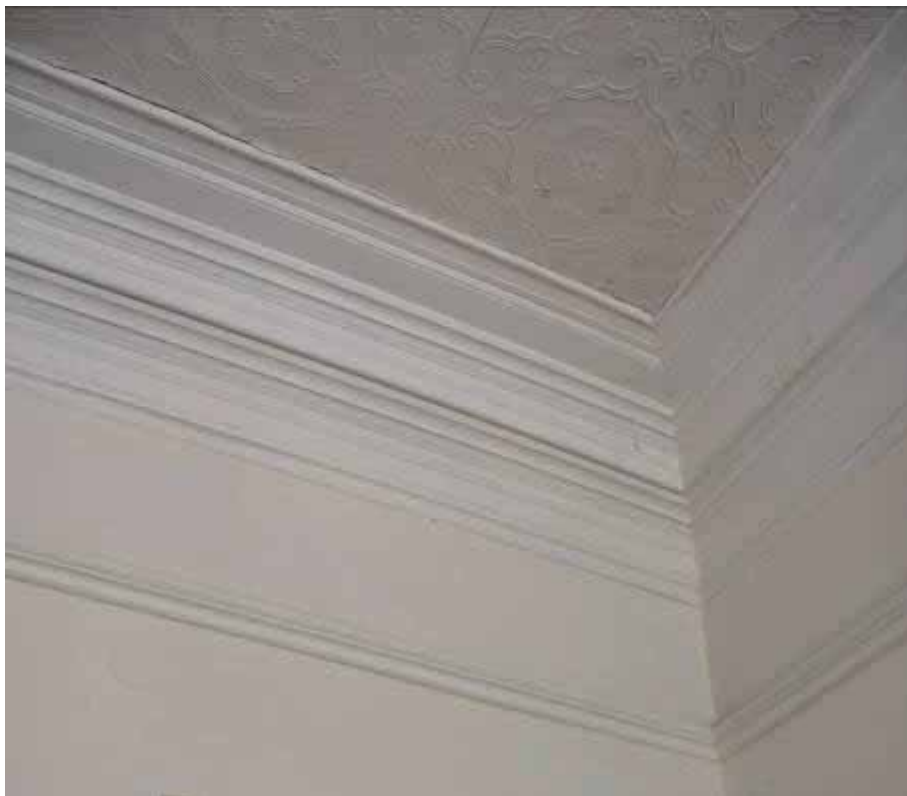
Φωτ. 275 Το ξύλινο γείσο της οροφής του χώρου ΙΣ5.
