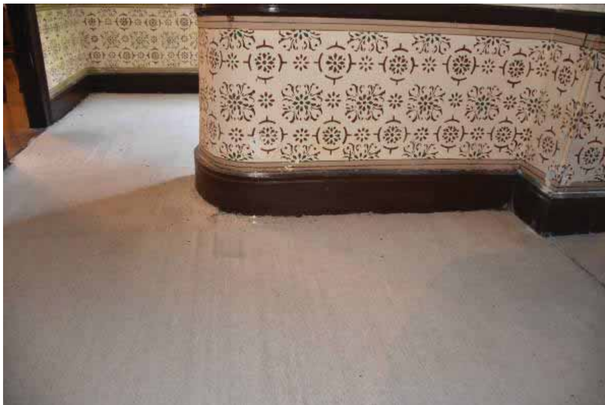
Φωτ. 322 Το ξύλινο δάπεδο του χώρου ΙΣ1β, το οποίο είναι καλυμμένο με μοκέτα.
