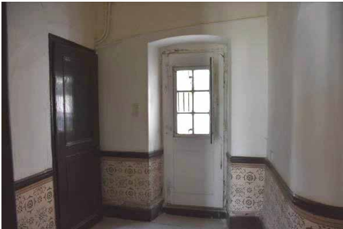
Φωτ. 83 Άποψη του χώρου ΙΣ γ.
