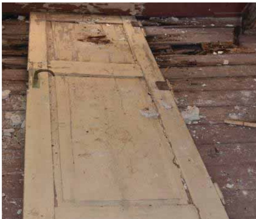
Φωτ. 393 Η ξύλινη θύρα του χώρου Β2.
