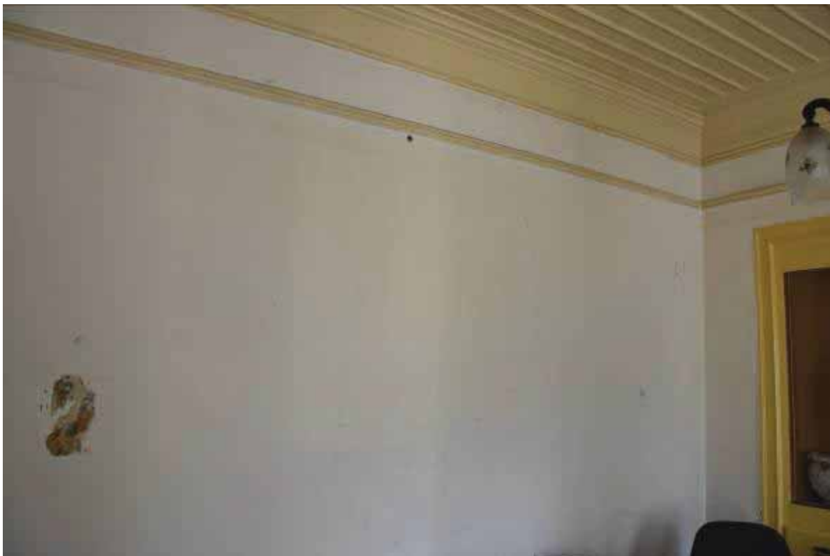
Φωτ. 105 Διερευνητική τομή στο μέσο των κατακόρυφων τοίχων του χώρου ΙΣ3.
