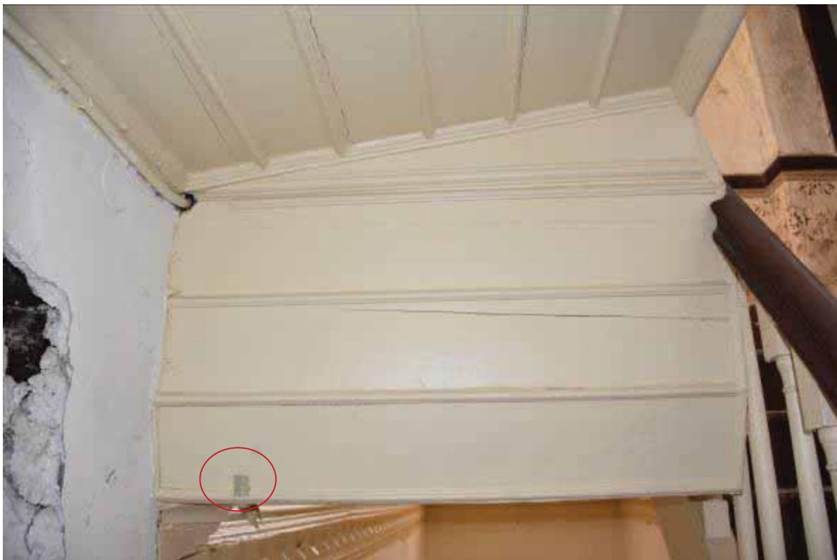
Φωτ. 248 Δείγμα αποκάλυψης στον ουρανό της ξύλινης κλίμακας.
