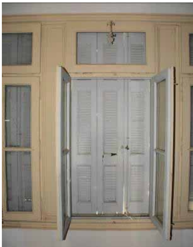
Φωτ. 428 Τα ανοίγματα στον νότιο τοίχο του χώρου Α4.
