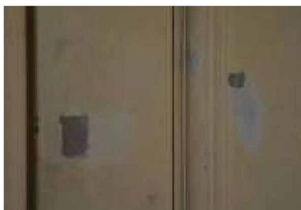
Φωτ. 396 Τα δείγματα αποκάλυψης στην ξύλινη θύρα και το κάσωμα του χώρου Β4.
