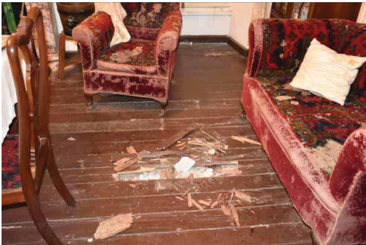
Φωτ. 328 Το ξύλινο δάπεδο του χώρου ΙΣ5.
