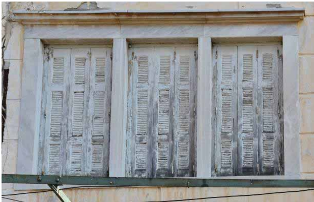
Φωτ. 427 Τα ανοίγματα στον νότιο τοίχο του χώρου Α4.
