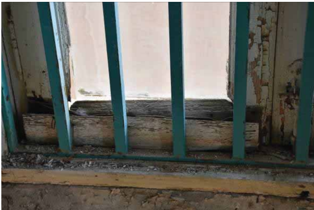
Φωτ. 461 Υδρόλυση του ξύλινου φορέα, αποχρωματισμός των εξωτερικών ξύλινων επιφανειών και απώλειες, αποκολλήσεις και κρακελαρίσματα των χρωματικών στρωμάτων σε άνοιγμα του χώρου Β2.
