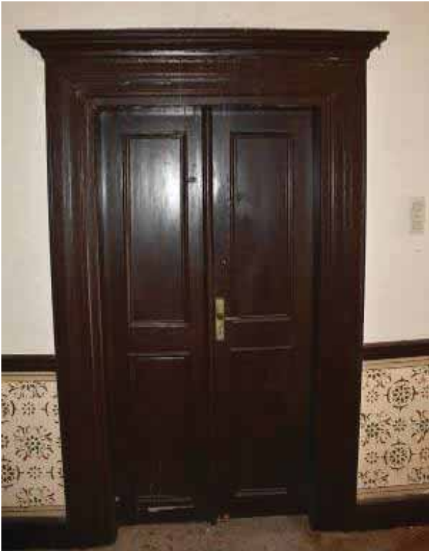
Φωτ. 387 Η ξύλινη θύρα του χώρου Α3.
