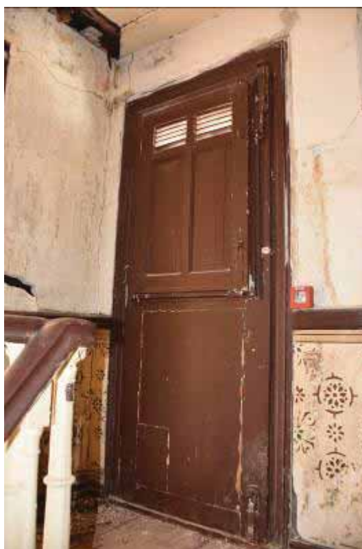
Φωτ. 154 Άποψη του χώρου Β1.
