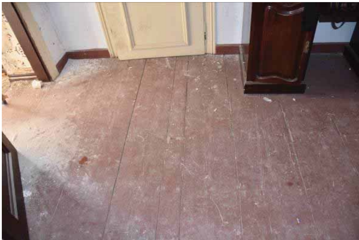
Φωτ. 345 Το ξύλινο δάπεδο του χώρου Β3.
