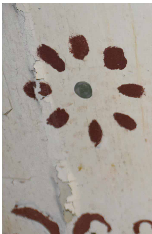
Φωτ. 135 Αποκολλημένο και ρωγματωμένο ζωγραφικό στρώμα στο πασαμέντο του χώρου Α1α.
