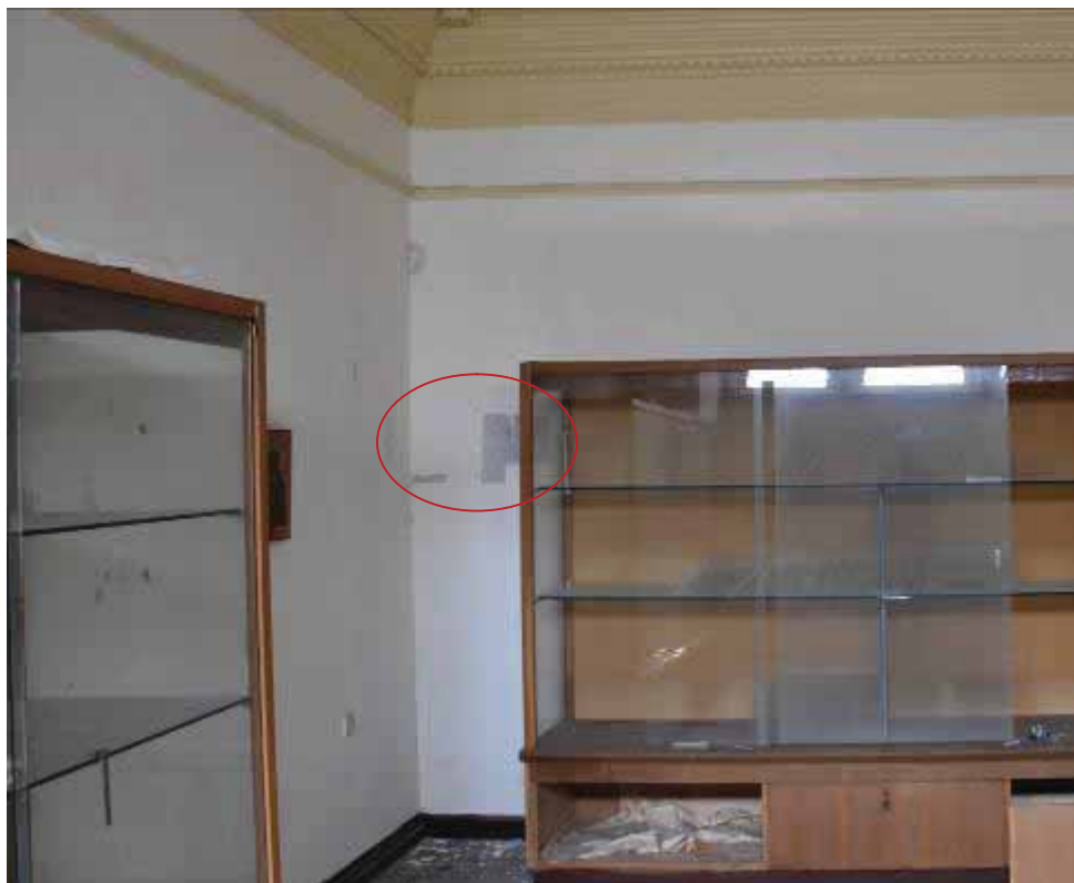
Φωτ. 138 Διερευνητική τομή στο μέσο των κατακόρυφων τοίχων του χώρου Α3.
