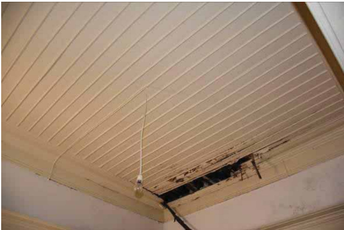
Φωτ. 292 Η ξύλινη οροφή του χώρου Α6.
