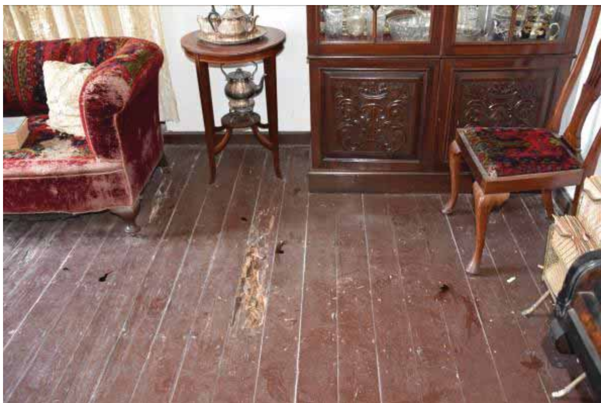
Φωτ. 329 Το ξύλινο δάπεδο του χώρου ΙΣ5.
