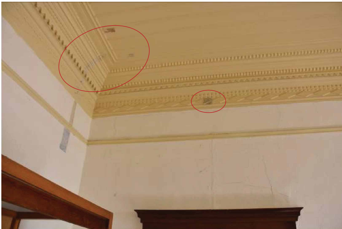
Φωτ. 287 Δείγματα αποκάλυψης στην ξύλινη οροφή του χώρου Α3.
