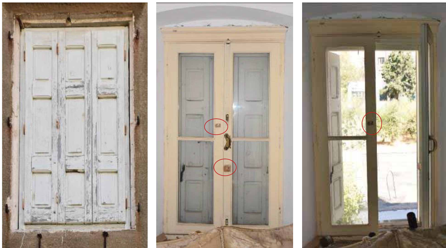
Φωτ. 441 Το άνοιγμα στον βόρειο τοίχο του χώρου Β3.
