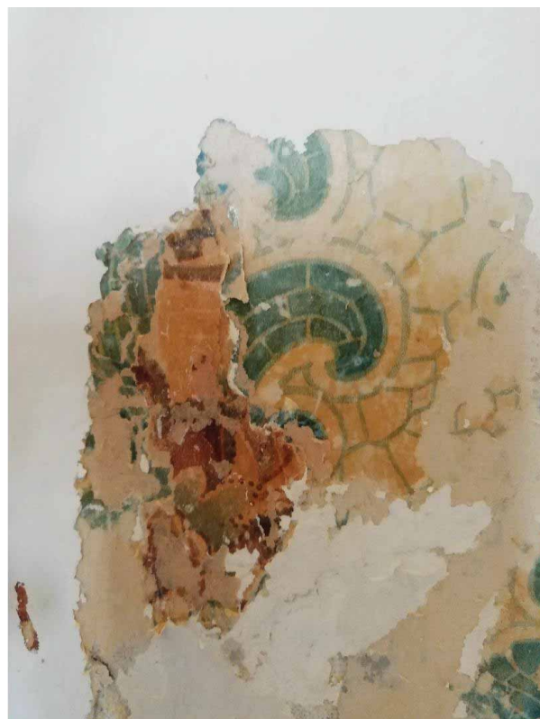
Φωτ. 202 Διερευνητική τομή στο μέσο των κατακόρυφων τοίχων του χώρου ΙΣ3, όπου βρέθηκε τμήμα των δύο ταπετσαριών.
