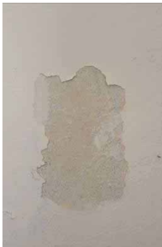
Φωτ. 113 Διερευνητική τομή στο μέσο των κατακόρυφων τοίχων του χώρου ΙΖ5.
