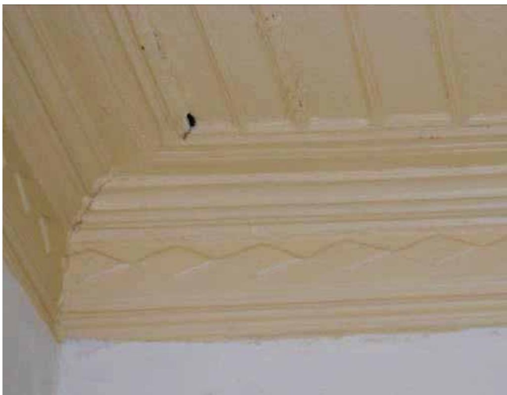
Φωτ. 260 Το γείσο της οροφής του χώρου ΙΣ1α.
