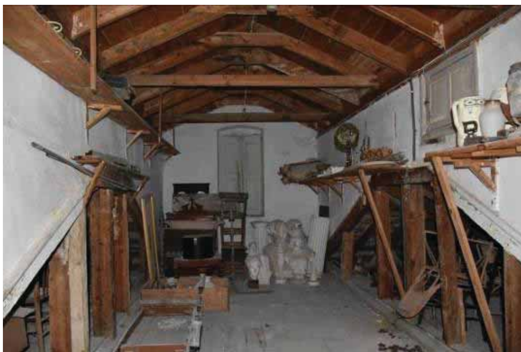
Φωτ. 172 Άποψη του χώρου Β5.
