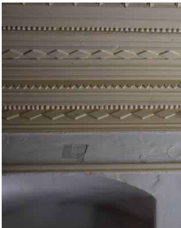
Φωτ. 99 Διερευνητική τομή στην ανώτερη περιοχή των κατακόρυφων τοίχων, κάτω από την ξύλινη οροφή του χώρου ΙΣ2.
