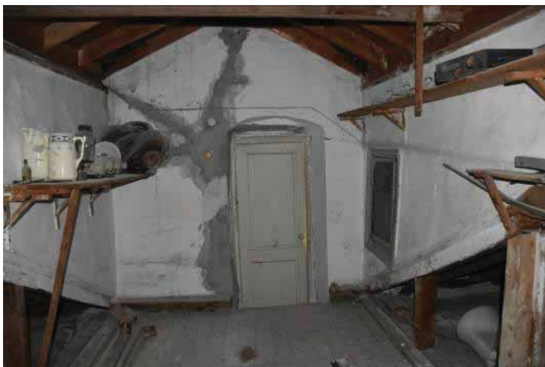
Φωτ. 173 Άποψη του χώρου Β5.
