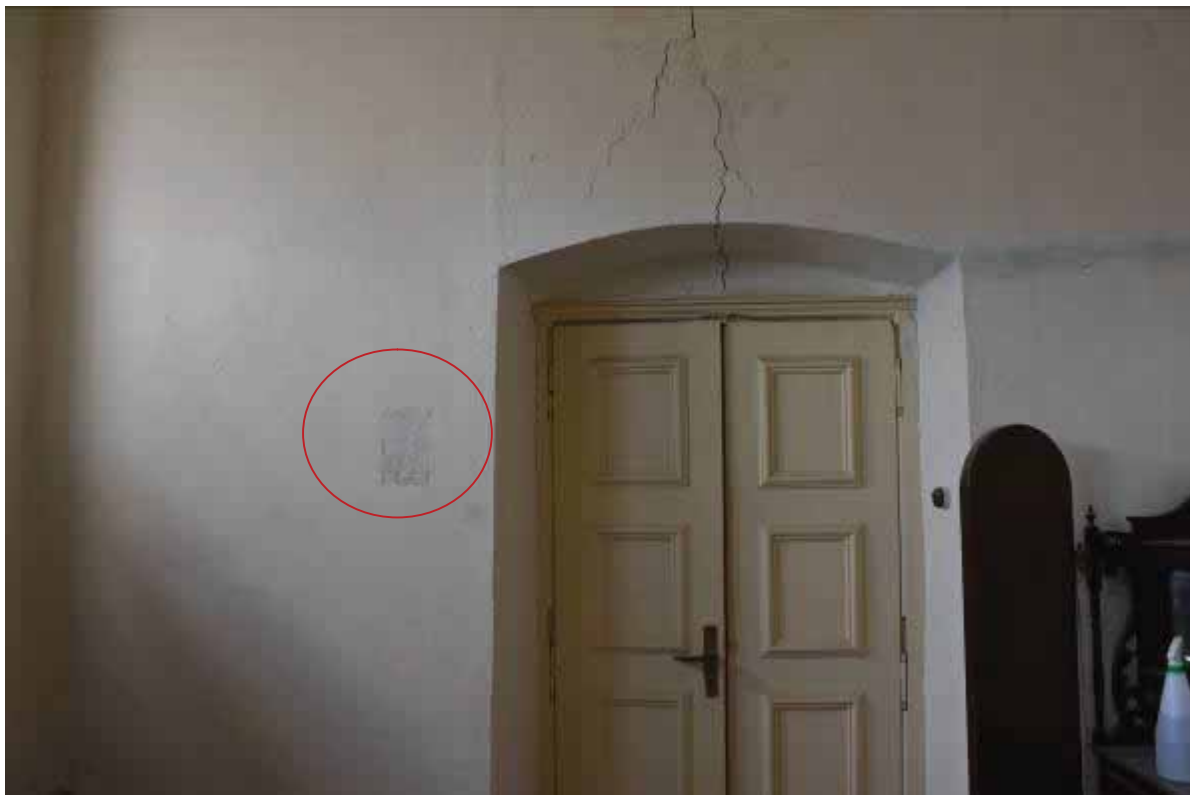
Φωτ. 147 Διερευνητική τομή στο μέσο των κατακόρυφων τοίχων του χώρου Α5.
