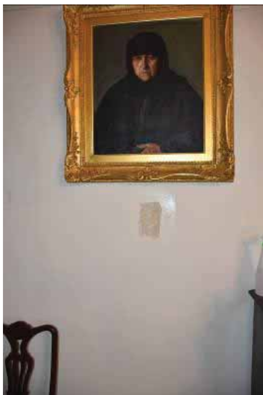
Φωτ. 114 Διερευνητική τομή – στρωματογραφία στο μέσο των κατακόρυφων τοίχων του χώρου ΙΖ5.
