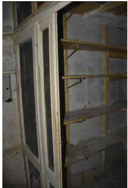
Φωτ. 125 Άποψη του χώρου ΙΣ9.
