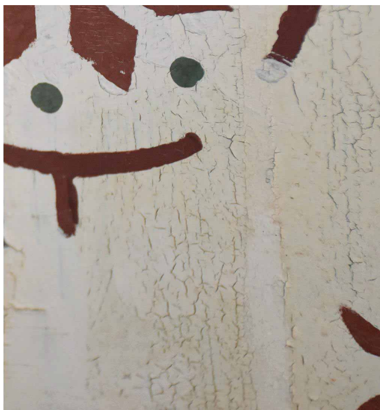
Φωτ. 135 Αποκολλημένο και ρωγματωμένο ζωγραφικό στρώμα στο πασαμέντο του χώρου Α1α.
