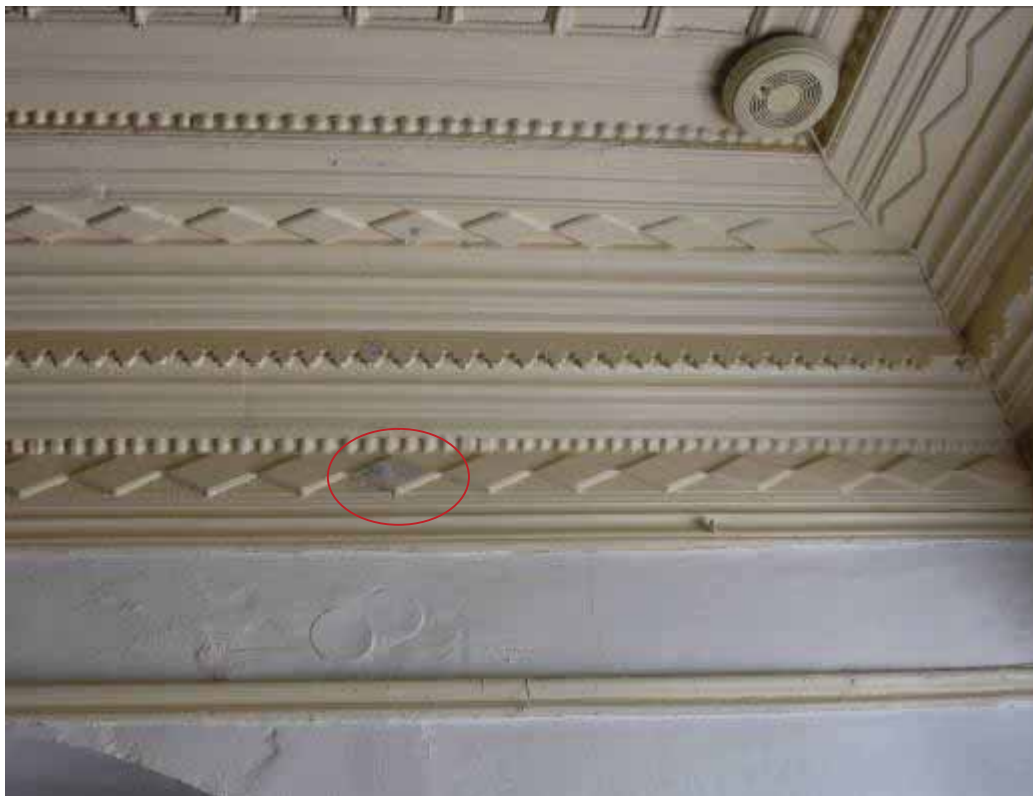
Φωτ. 269 Δείγμα αποκάλυψης στην ξύλινη οροφή του χώρου ΙΣ2.
