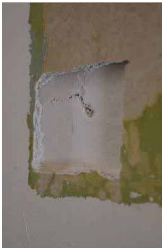
Φωτ. 131 Λεπτομέρεια της διερευνητικής τομής – στρωματογραφίας σε κατακόρυφο τοίχο του χώρου Α1α
