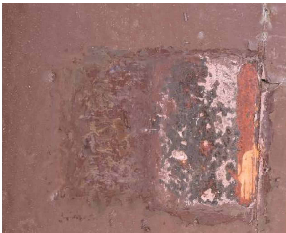
Φωτ. 365 Τα δείγματα αποκάλυψης στην εξωτερική όψη της ξύλινης κεντρικής εξώθυρας.
