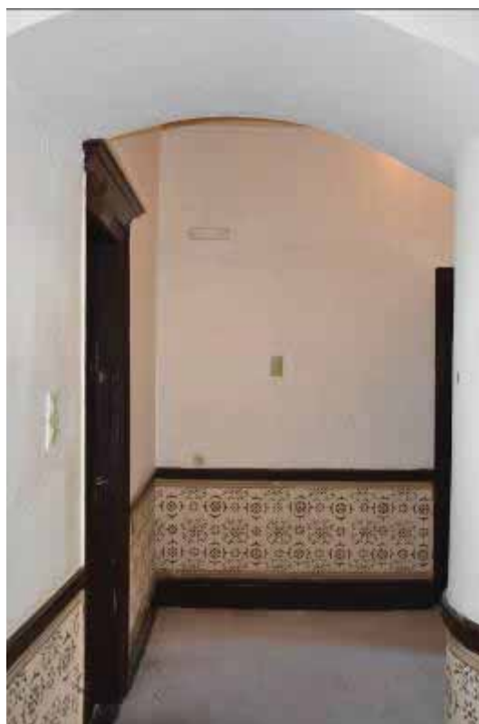
Φωτ. 84 Άποψη του χώρου ΙΣ γ.
