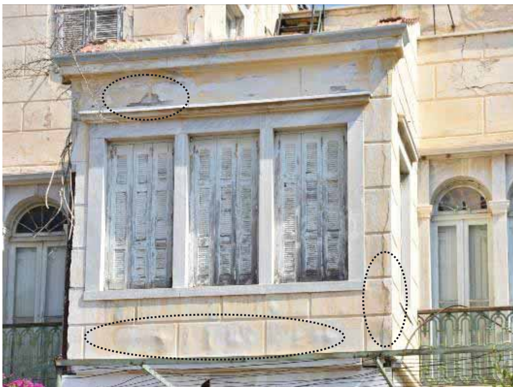
Φωτ. 35 Ρηγματώσεις, αποκολλήσεις, κονιορτοποιήσεις και απώλειες στο επίχρυσμα της νότιας όψης.
