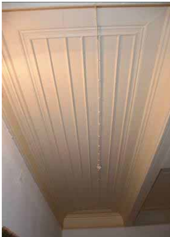
Φωτ. 263 Η ξύλινη οροφή του χώρου ΙΣ1β.
