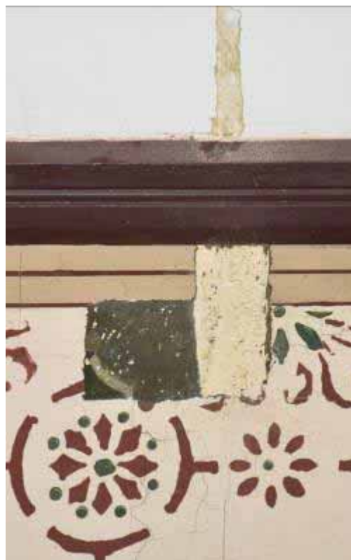
Φωτ. 91 Το υποκείμενο ζωγραφικό στρώμα στη θέση του πασαμέντο στον χώρο ΙΣ1γ.
