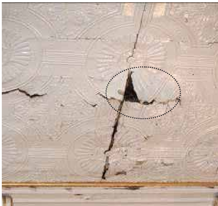
Φωτ. 219 Ρωγματώσεις, απώλειες και αποκολλήσεις στην ταπετσαρία της οροφής.
