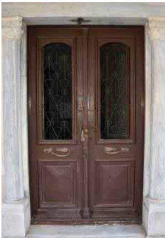
Φωτ. 363 Η κεντρική ξύλινη εξώθυρα.
