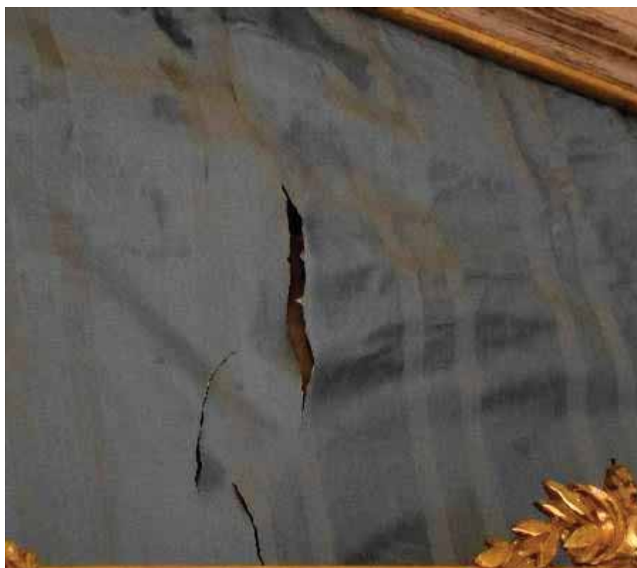
Φωτ. 226 Λεπτομέρεια της φθοράς που βρίσκεται εντός μαύρου πλαισίου στην προηγούμενη φωτογραφία.
