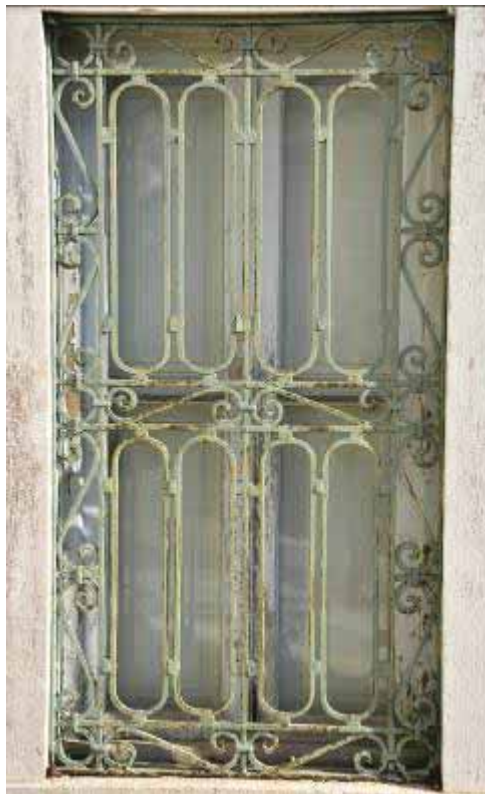
Φωτ. 411 Το άνοιγμα στον δυτικό τοίχο του χώρου ΙΣ5.
