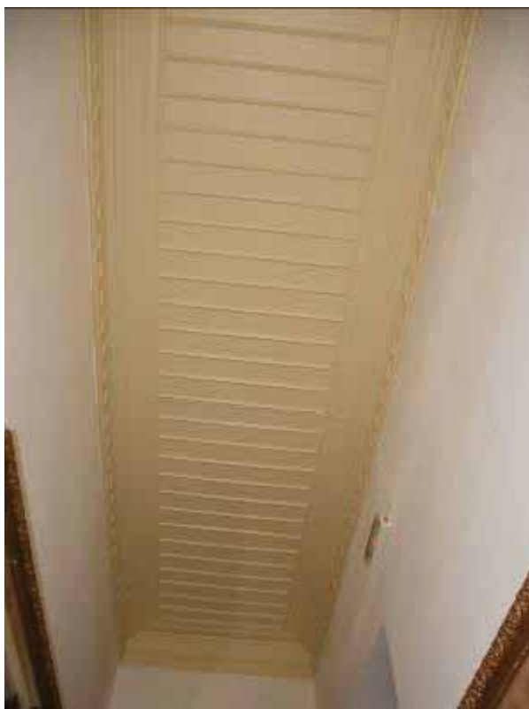
Φωτ. 282 Η ξύλινη οροφή του χώρου Α1β.
