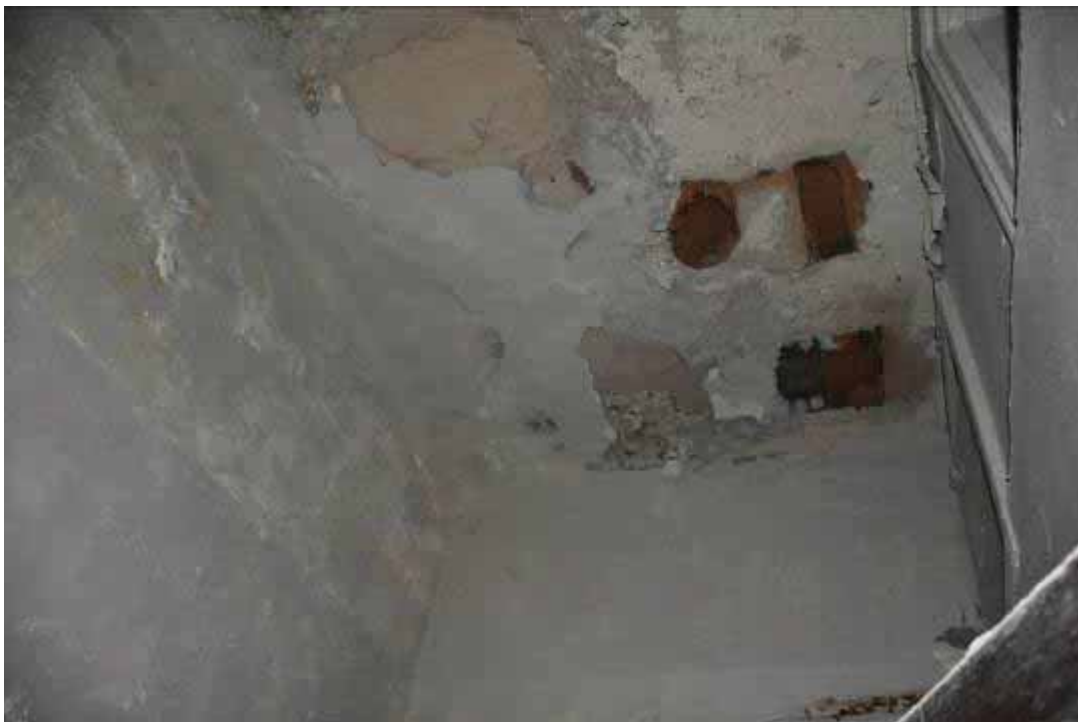
Φωτ. 127 Άποψη του χώρου ΙΣ10.
