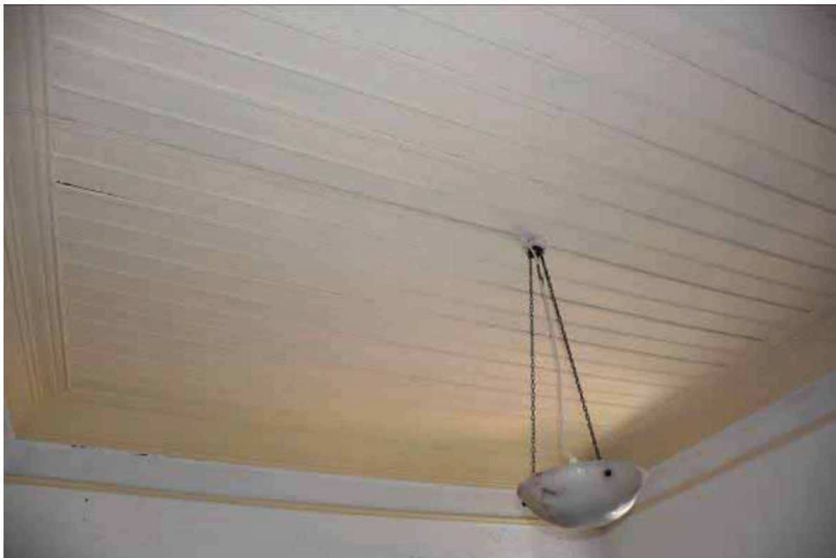
Φωτ. 302 Η ξύλινη οροφή του χώρου Β4.
