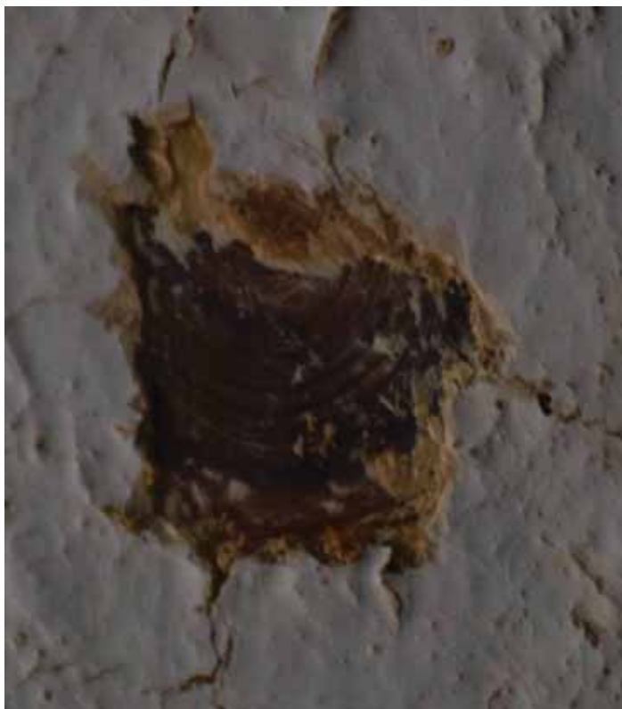
Φωτ. 434 Το δείγμα αποκάλυψης στο σκούρο του ανοίγματος του χώρου Α6.
