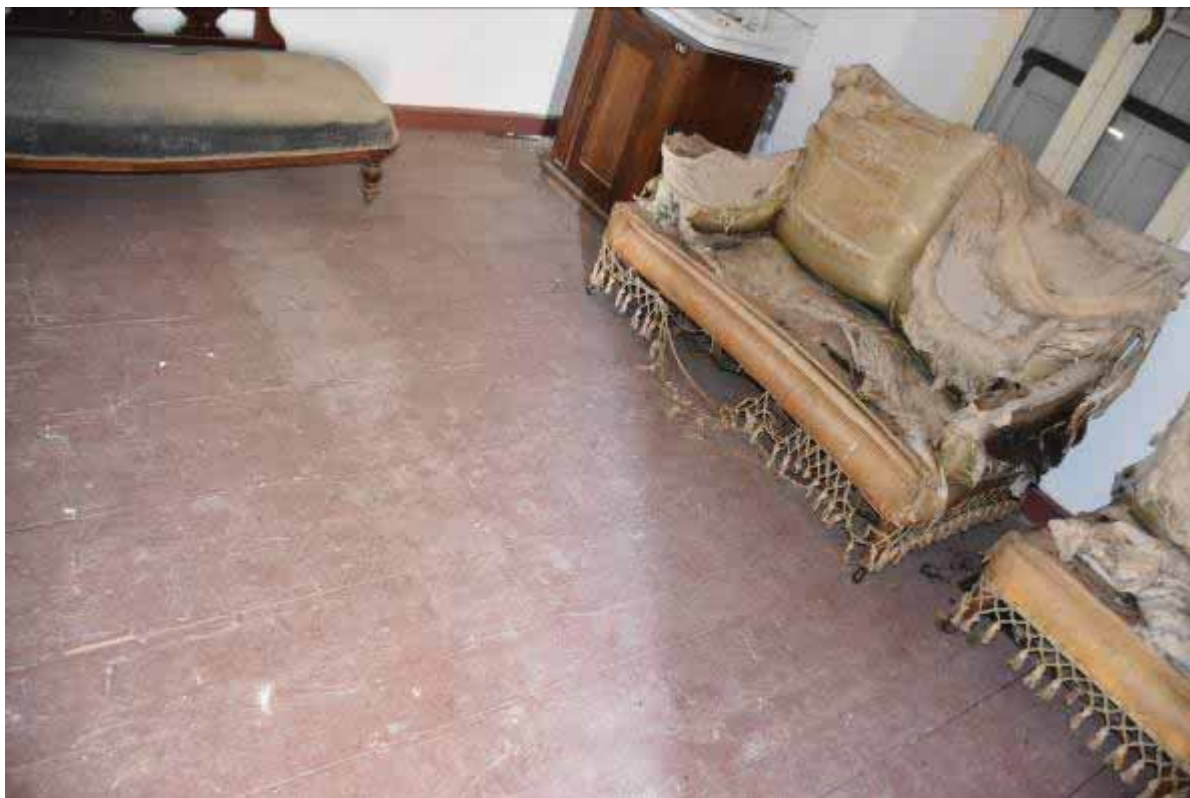
Φωτ. 344 Το ξύλινο δάπεδο του χώρου Β3.
