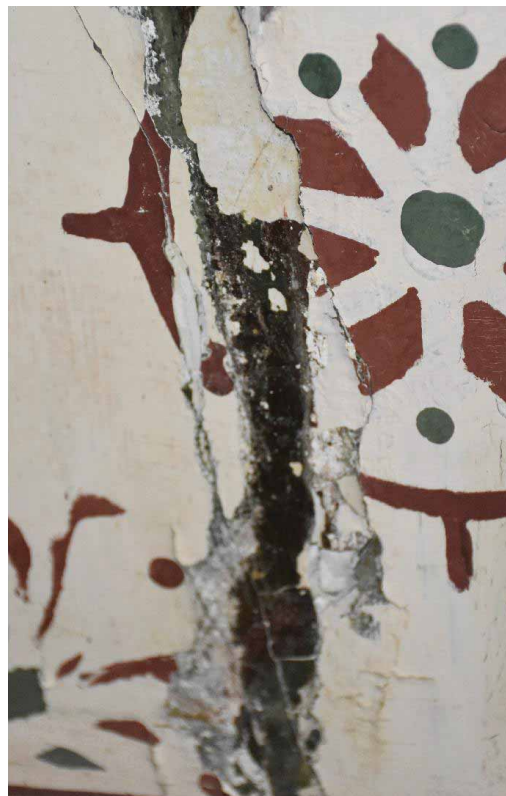
Φωτ. 132 Η διερευνητική τομή και το υποκείμενο ζωγραφικό στρώμα στο πασαμέντο του χώρου Α1α
