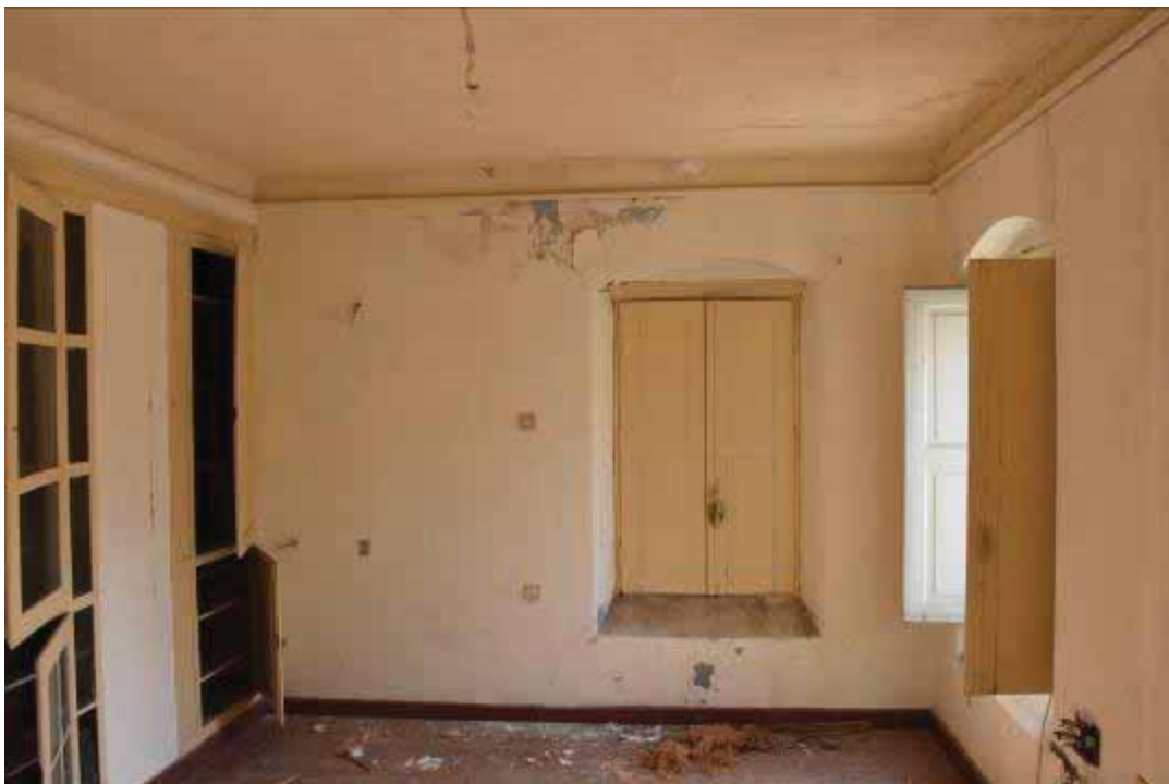
Φωτ. 160 Άποψη του χώρου Β2.
