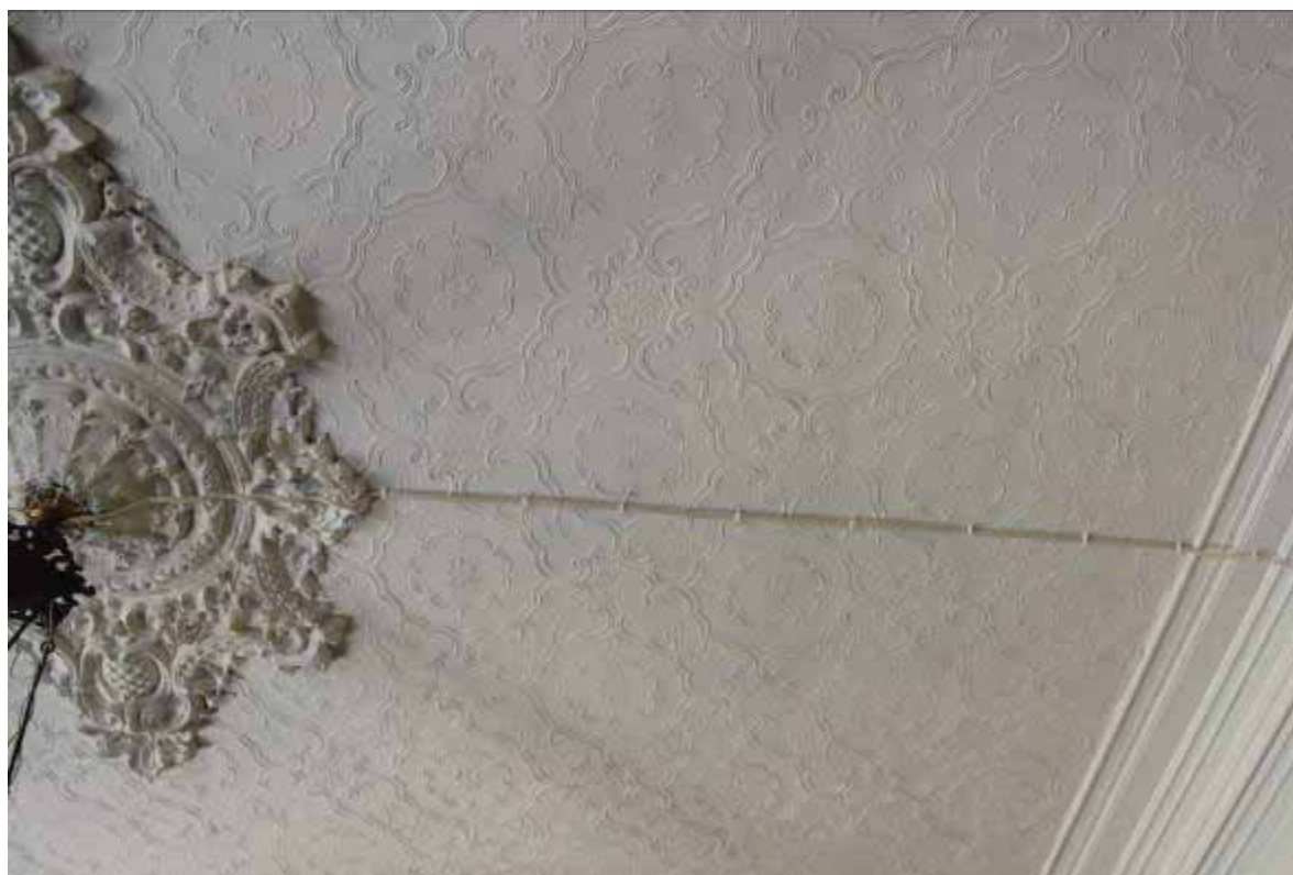
Φωτ. 208 Εγκατάσταση καλωδιώσεων.
