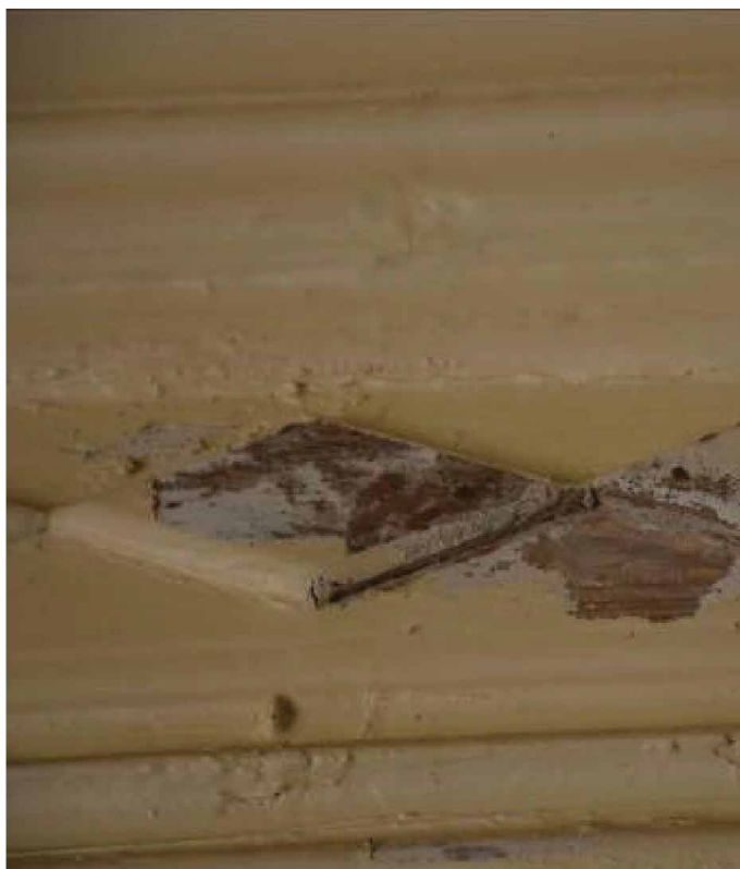
Φωτ. 262 Τα δείγματα αποκάλυψης που περικλείονται με κόκκινο πλαίσιο στην προηγούμενη φωτογραφία.
