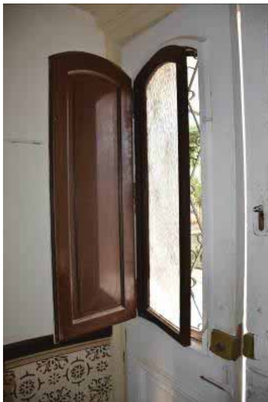
Φωτ. 364 Η κεντρική ξύλινη εξώθυρα.
