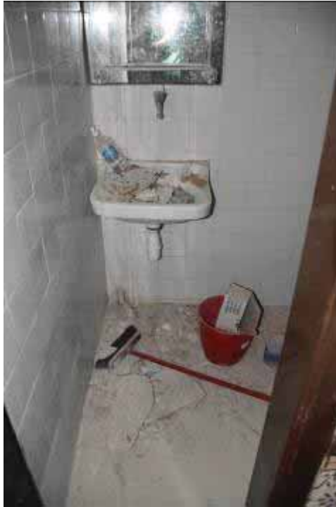
Φωτ. 126 Άποψη του χώρου ΙΣ10.
