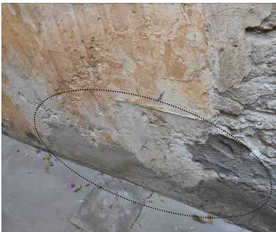
Φωτ. 44 Λεπτομέρεια της προηγούμενης φωτογραφίας. Εντός πλαισίου τα νεότερα τσιμεντοκονιάματα.
