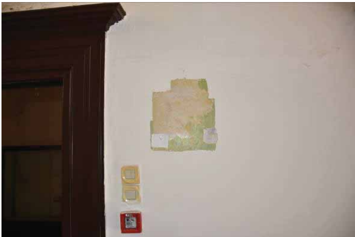
Φωτ. 130 Διερευνητική τομή – στρωματογραφία στο μέσο των κατακόρυφων τοίχων του χώρου ΙΣ1α.
