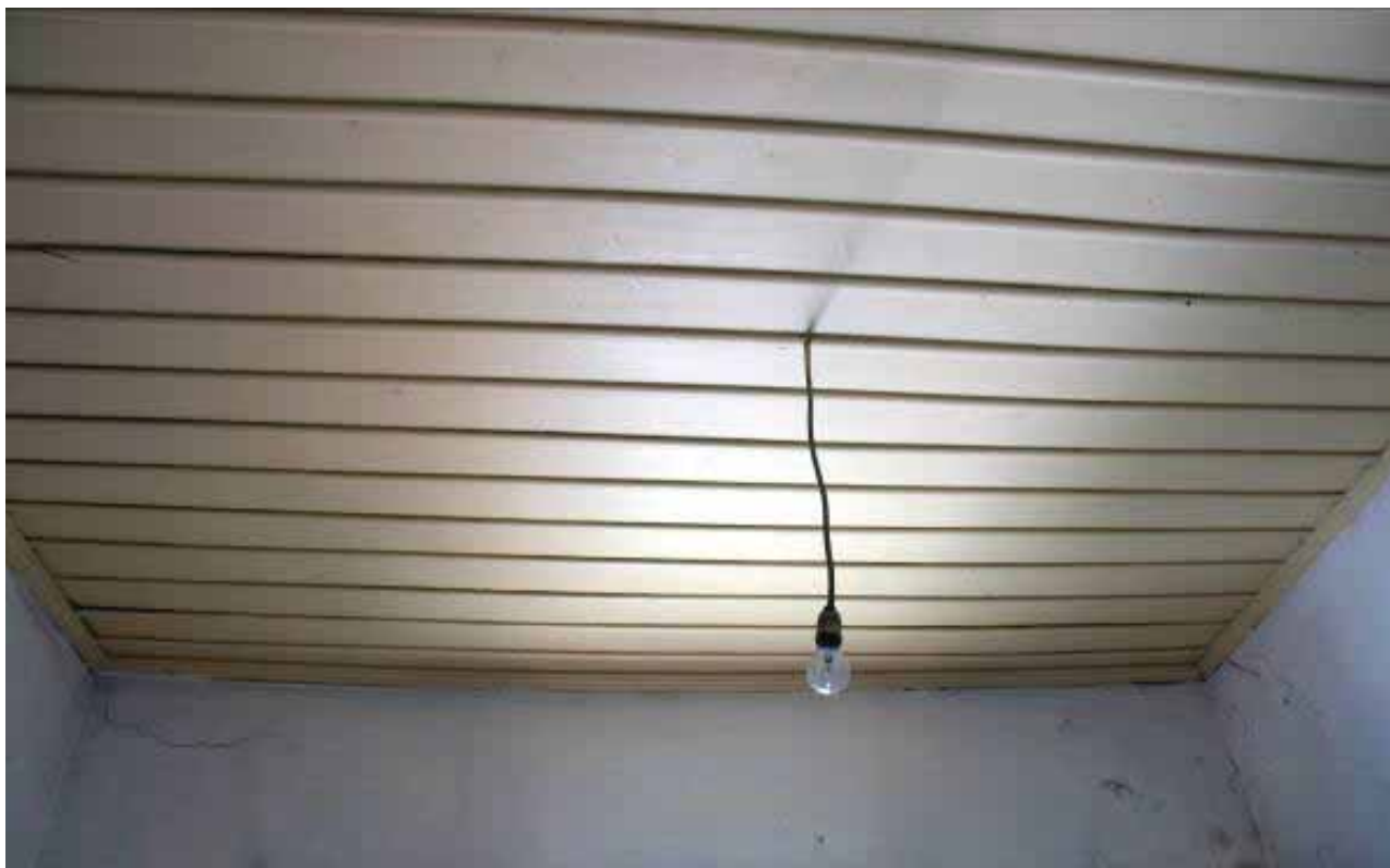
Φωτ. 289 Η ξύλινη οροφή του χώρου Α4.
