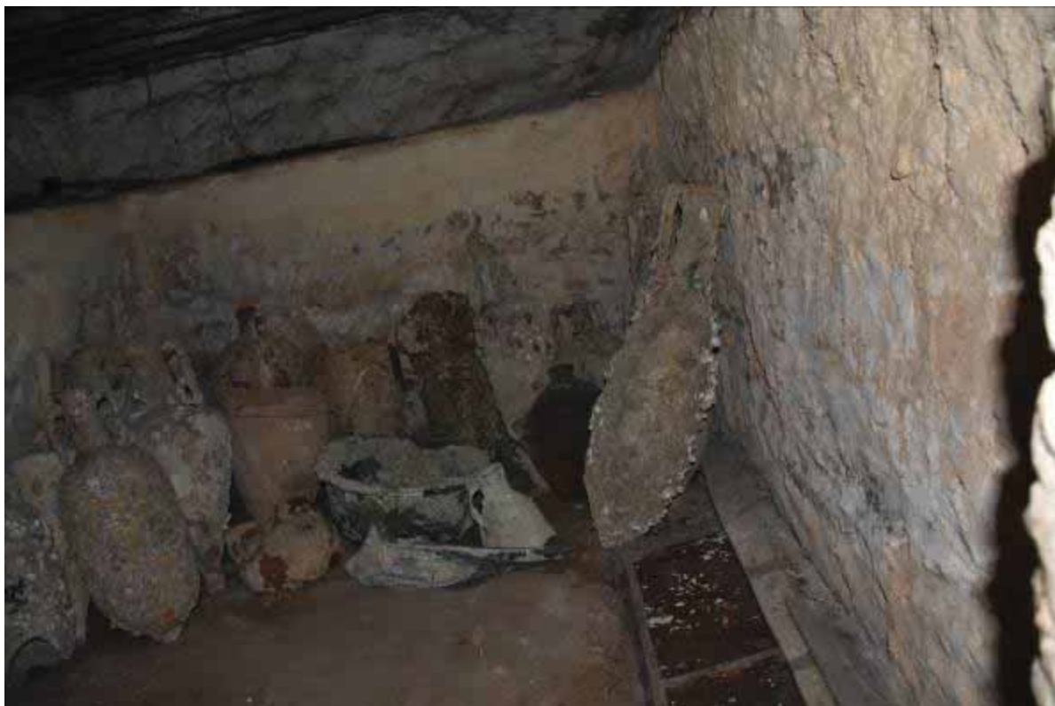
Φωτ. 78 Άποψη των χώρων του υπογείου.
