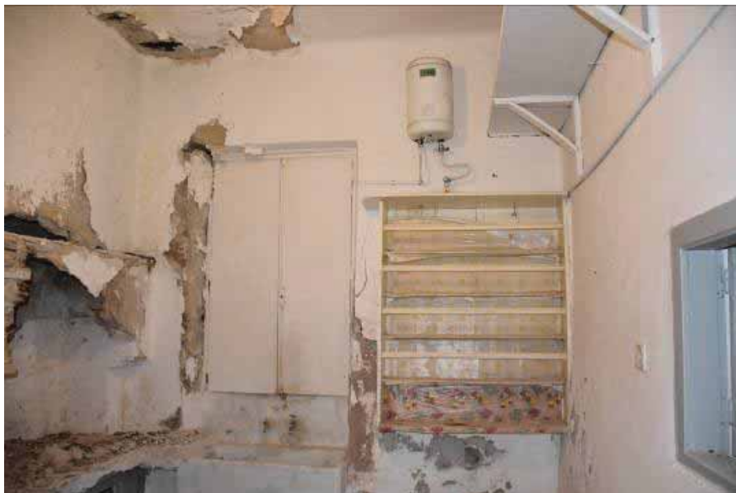
Φωτ. 122 Άποψη του χώρου ΙΣ8.
