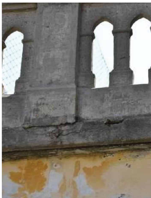
Φωτ. 60 Ρωγματώσεις στα τσιμεντένιο στηθαίο της βόρειας όψης.
