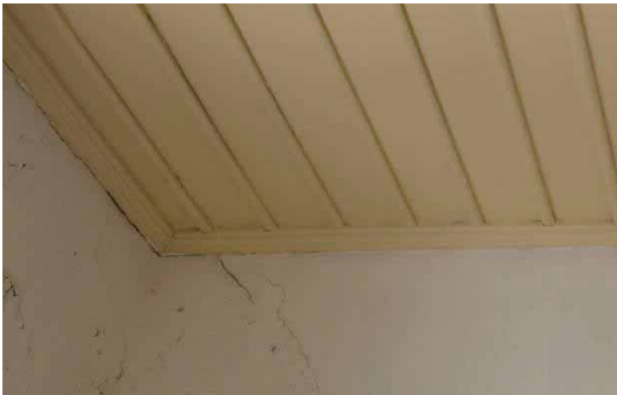
Φωτ. 290 Το γείσο της οροφής του χώρου Α4.
