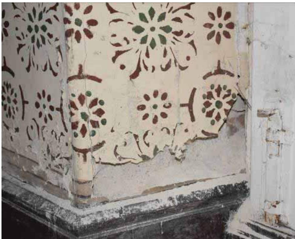
Φωτ. 93 Απώλεια κονιάματος μαζί με τη ζωγραφική επιφάνεια σε αποσαθρωμένο υπόστρωμα στο πασαμέντο του χώρου ΙΣ1γ.
