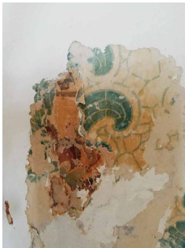
Φωτ. 106 Διερευνητική τομή στο μέσο των κατακόρυφων τοίχων του χώρου ΙΣ3, όπου βρέθηκε τμήμα των δύο ταπετσαριών.
