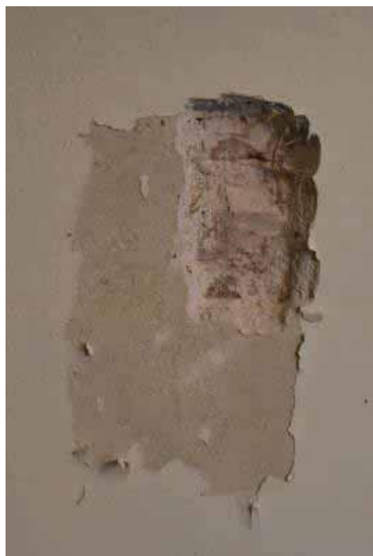
Φωτ. 114 Διερευνητική τομή – στρωματογραφία στο μέσο των κατακόρυφων τοίχων του χώρου ΙΖ5.
