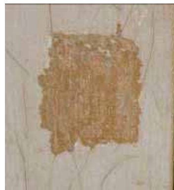
Φωτ. 392 Τα δείγματα αποκάλυψης στην ξύλινη θύρα και το κάσωμα του χώρου Α6.
