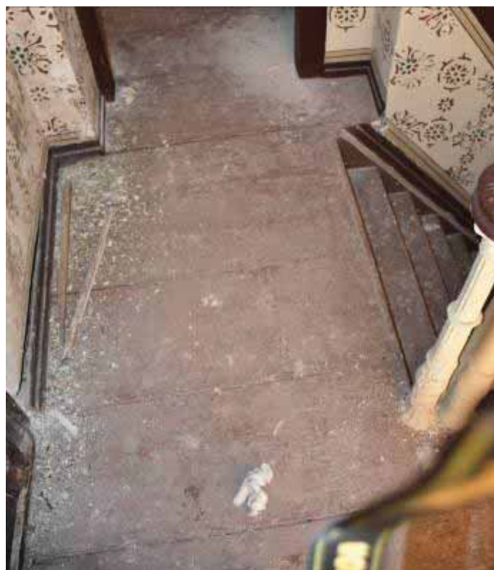
Φωτ. 341 Το ξύλινο δάπεδο του χώρου Β1.
