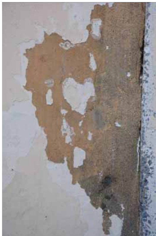
Φωτ. 20 Λεπτομέρεια της παραπάνω φωτογραφίας στην περιοχή του μαύρου πλαισίου, όπου διακρίνεται κάτω από τα αλλεπάλληλα ασβεστοχρίσματα το αρχικό χρώμα του τοίχου.
