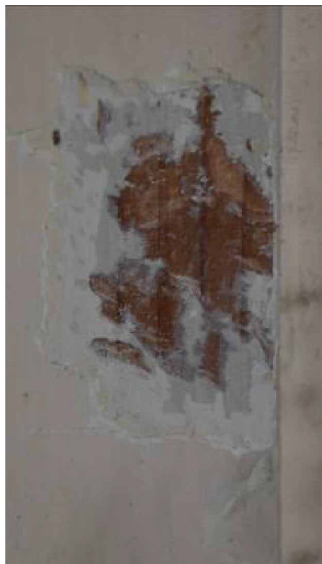
Φωτ. 377 Τα δείγματα αποκάλυψης στην ξύλινη θύρα και το κάσωμα του χώρου ΙΣ6α.
