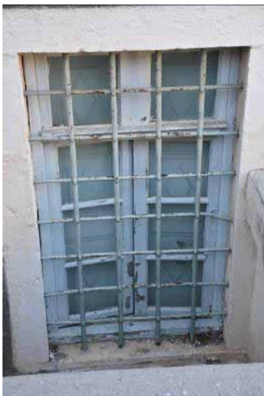
Φωτ. 454 Το άνοιγμα του κλιμακοστασίου ανάμεσα στο ισόγειο και τον α' όροφο.
