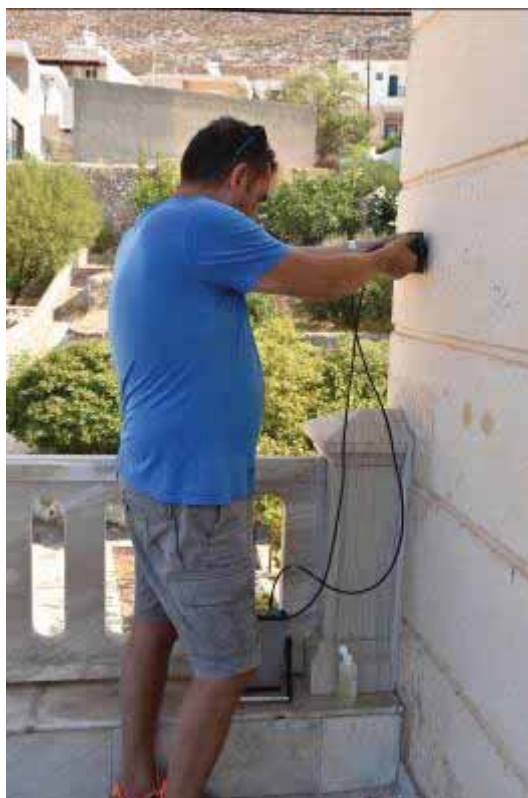
Φωτ. 30 Μέτρηση με τη συσκευή υπερήχων για τον έλεγχο στερεότητας των κονιαμάτων.
