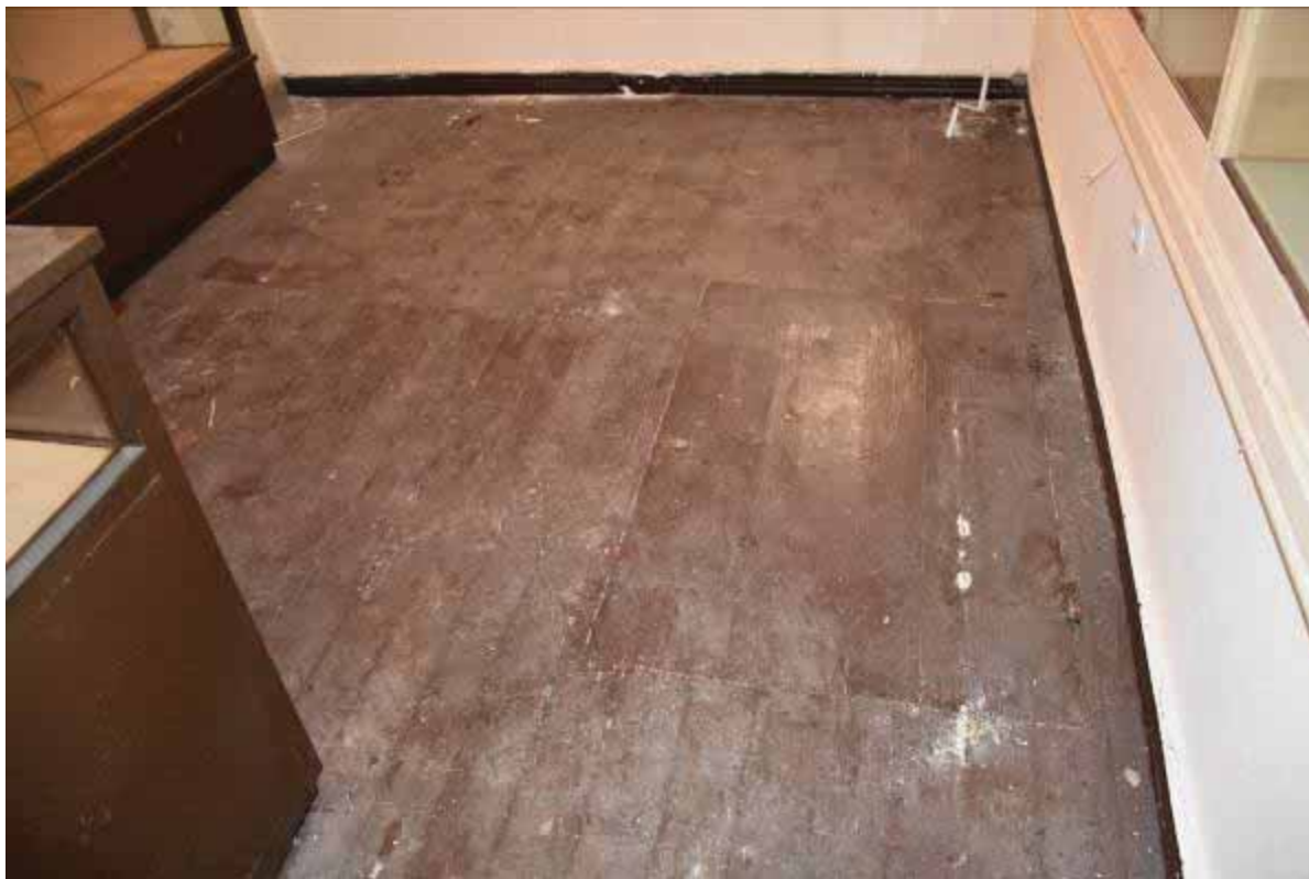
Φωτ. 326 Το ξύλινο δάπεδο του χώρου ΙΣ4.
