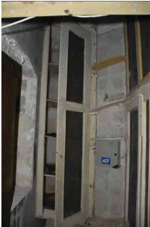
Φωτ. 124 Άποψη του χώρου ΙΣ9.
