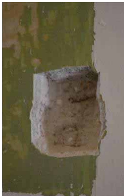
Φωτ. 131 Λεπτομέρεια της διερευνητικής τομής – στρωματογραφίας σε κατακόρυφο τοίχο του χώρου Α1α
