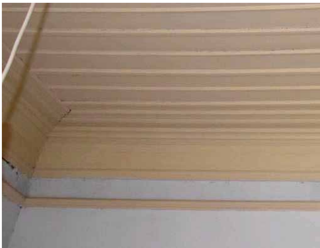
Φωτ. 299 Το γείσο της οροφής του χώρου Β3.
