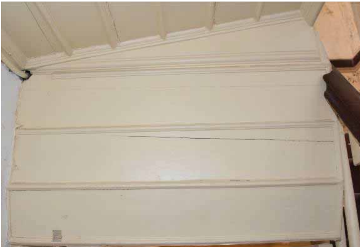
Φωτ. 254 Ρωγματώσεις και διάνοιξη οπών για την τοποθέτηση καλωδιώσεων.
