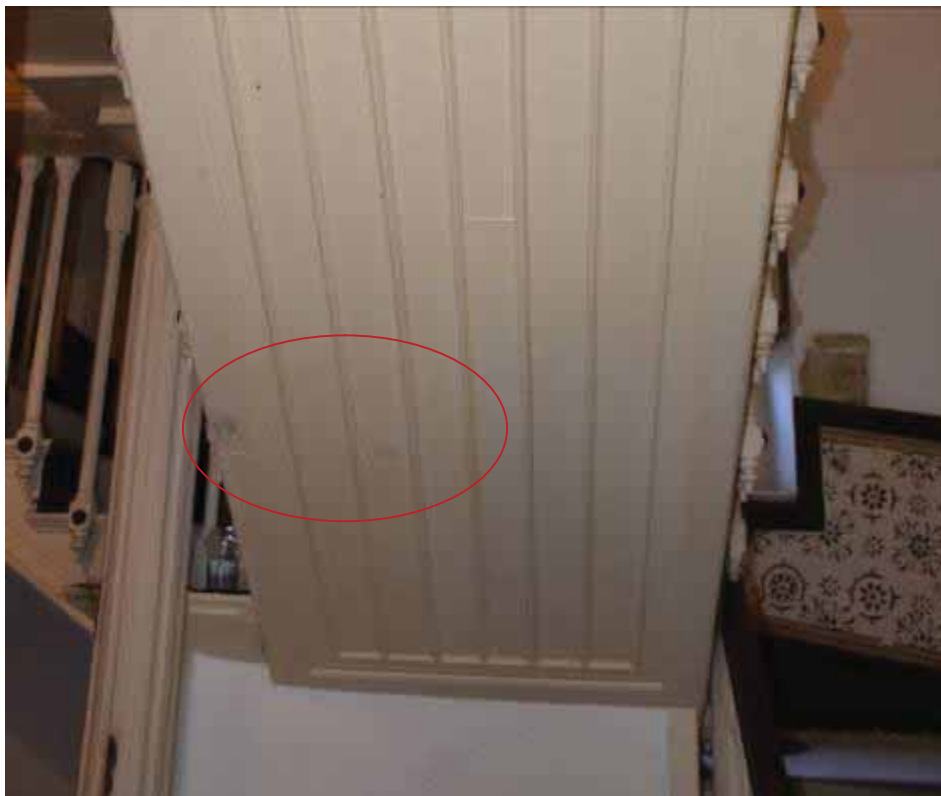
Φωτ. 246 Δείγματα αποκάλυψης στον ουρανό της ξύλινης κλίμακας.
