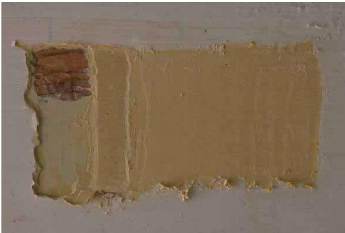
Φωτ. 366 Το δείγμα αποκάλυψης στην εσωτερική όψη της ξύλινης κεντρικής εξώθυρας.
