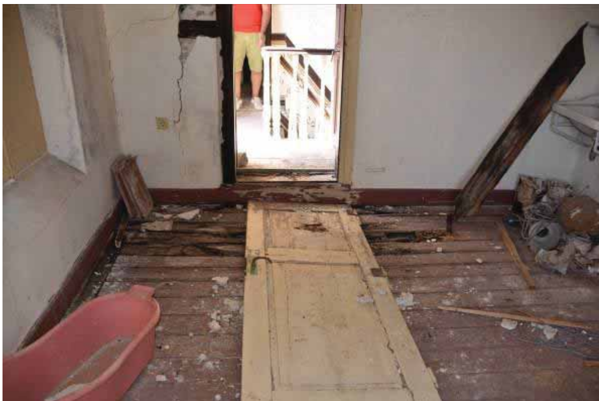
Φωτ. 343 Το ξύλινο δάπεδο του χώρου B2.
