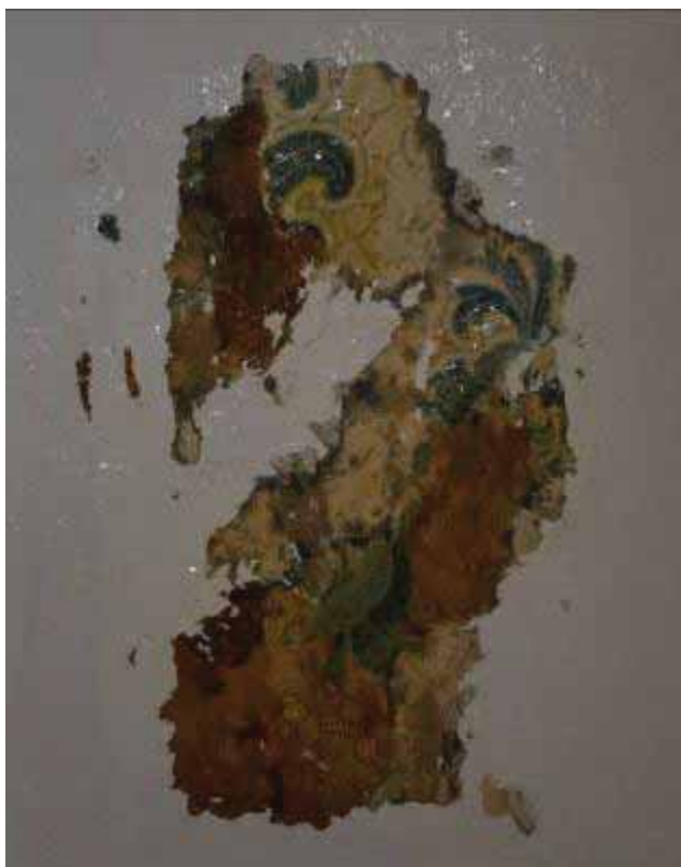
Φωτ. 106 Διερευνητική τομή στο μέσο των κατακόρυφων τοίχων του χώρου ΙΣ3, όπου βρέθηκε τμήμα των δύο ταπετσαριών.
