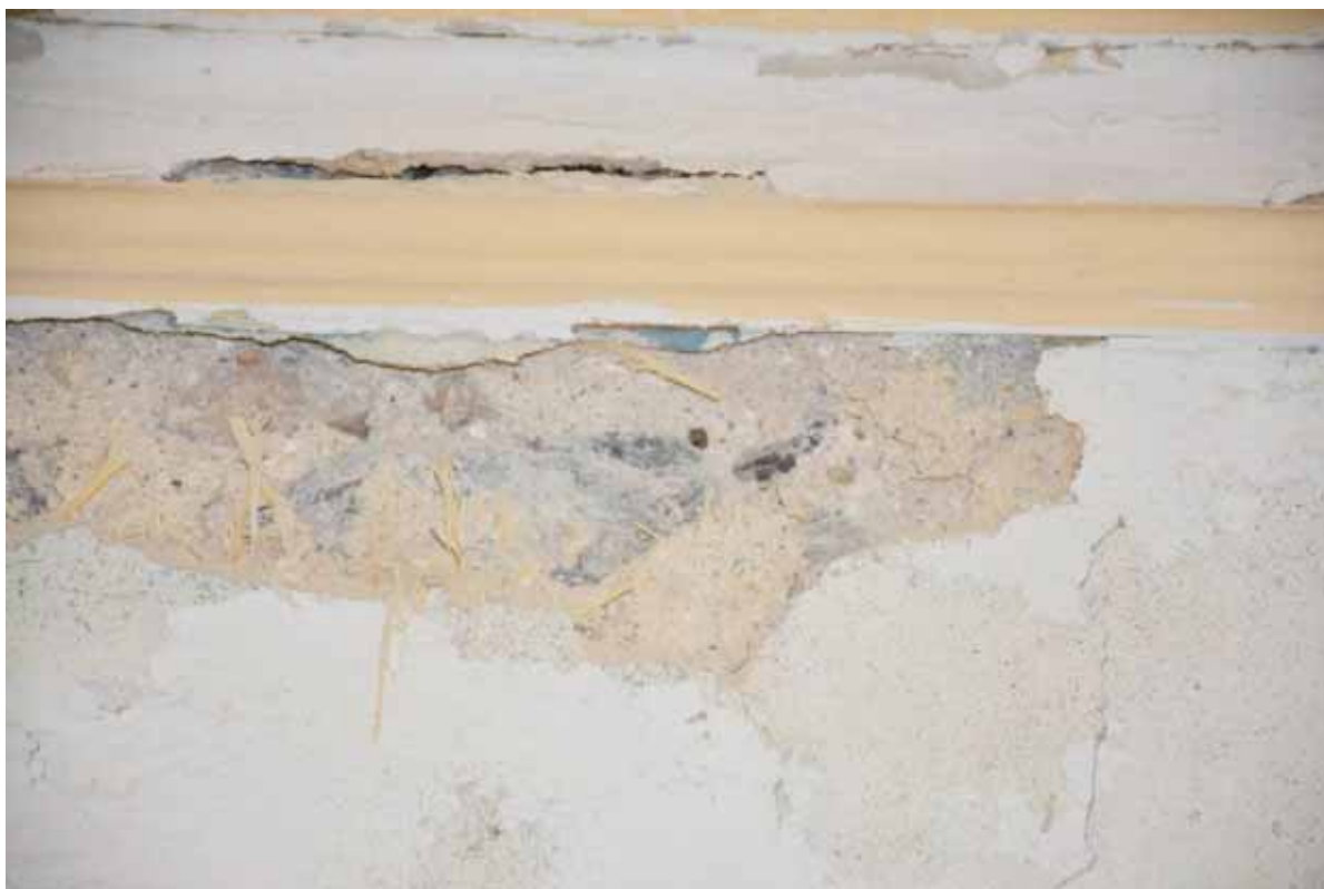
Φωτ. 3 Λίθινη τοιχοποιία η οποία είναι εμφανής από απώλεια κονιάματος στον χώρο Β3. Διακρίνεται επίσης η παρουσία άχυρου στο κονίαμα επίχρσις.
