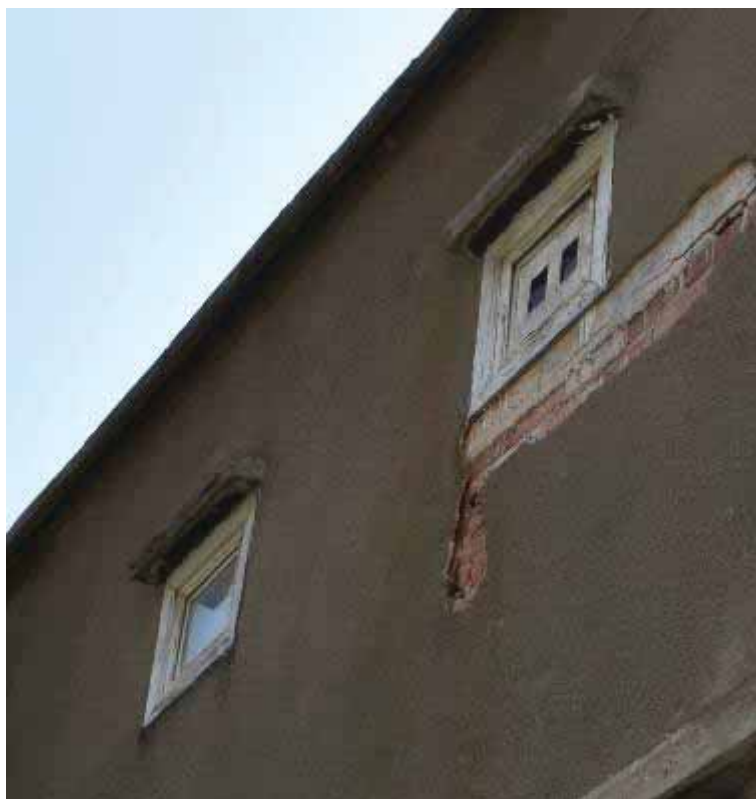
Φωτ. 450 Τα ανοίγματα του χώρου Β6α-β.
