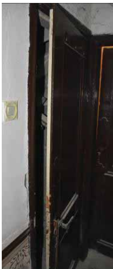
Φωτ. 383 Η ξύλινη θύρα ντουλαπιού στον χώρο ΙΣ7.
