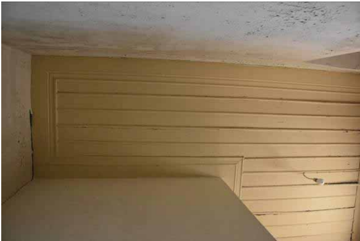
Φωτ. 296 Η ξύλινη οροφή του χώρου Β1.
