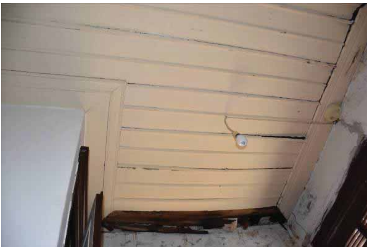
Φωτ. 297 Η ξύλινη οροφή του χώρου Β1.
