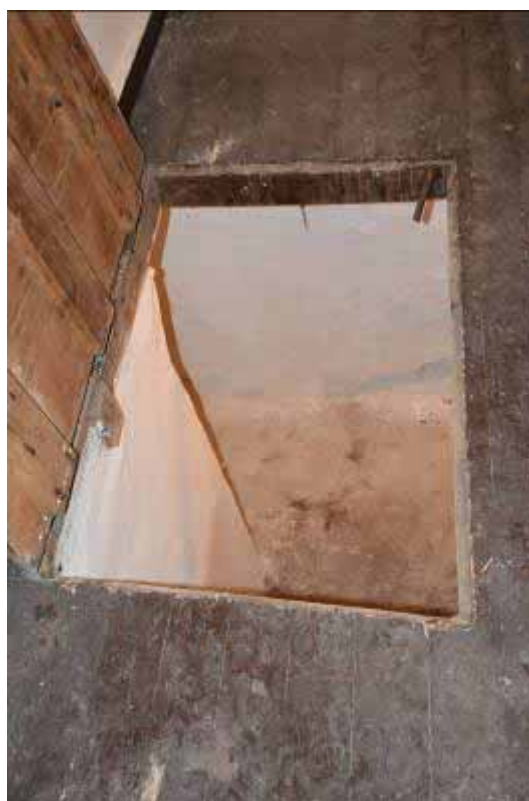
Φωτ. 327 Η καταπακτή στο ξύλινο δάπεδο του χώρου ΙΣ4.
