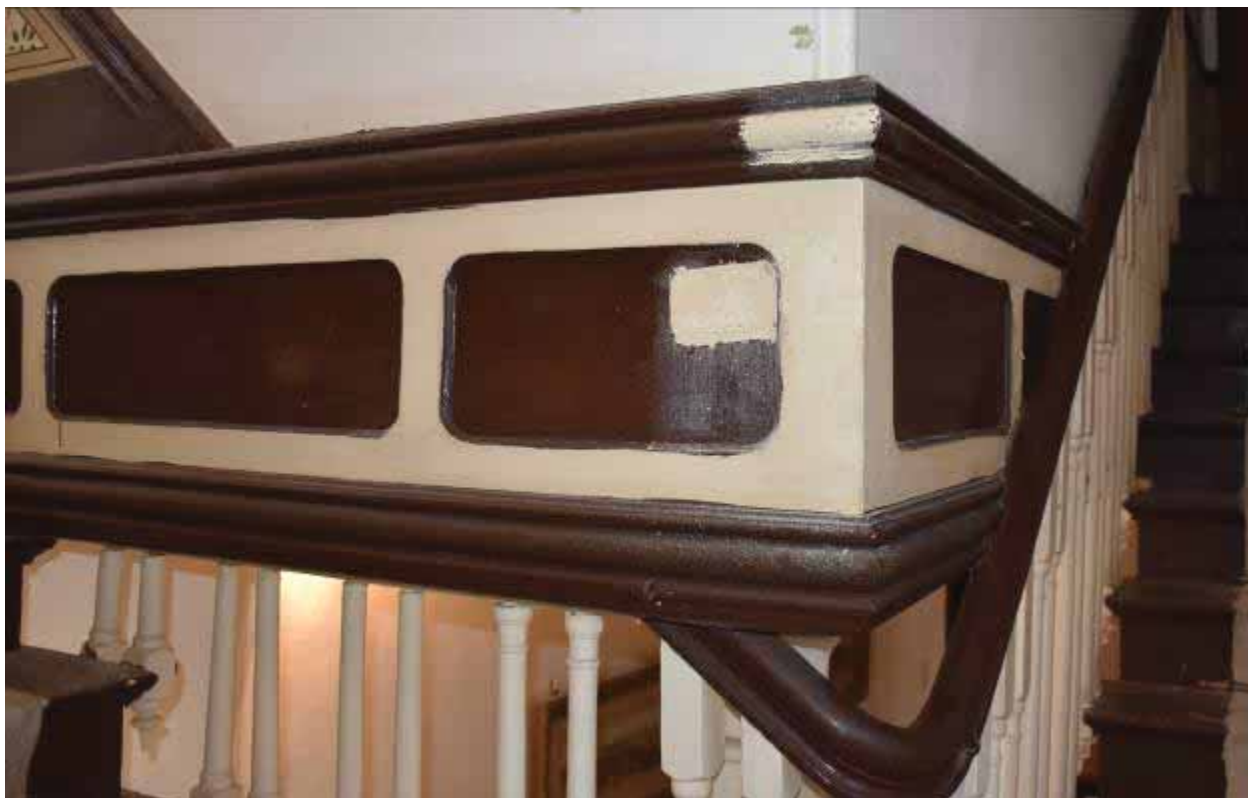
Φωτ. 250 Δείγματα αποκάλυψης στα πλαϊνά ξύλινα διακοσμητικά της ξύλινης κλίμακας.
