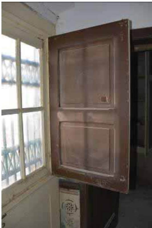
Φωτ. 382 Το δείγμα αποκάλυψης στην ξύλινη εξώθυνα του χώρου ΙΣ7.
