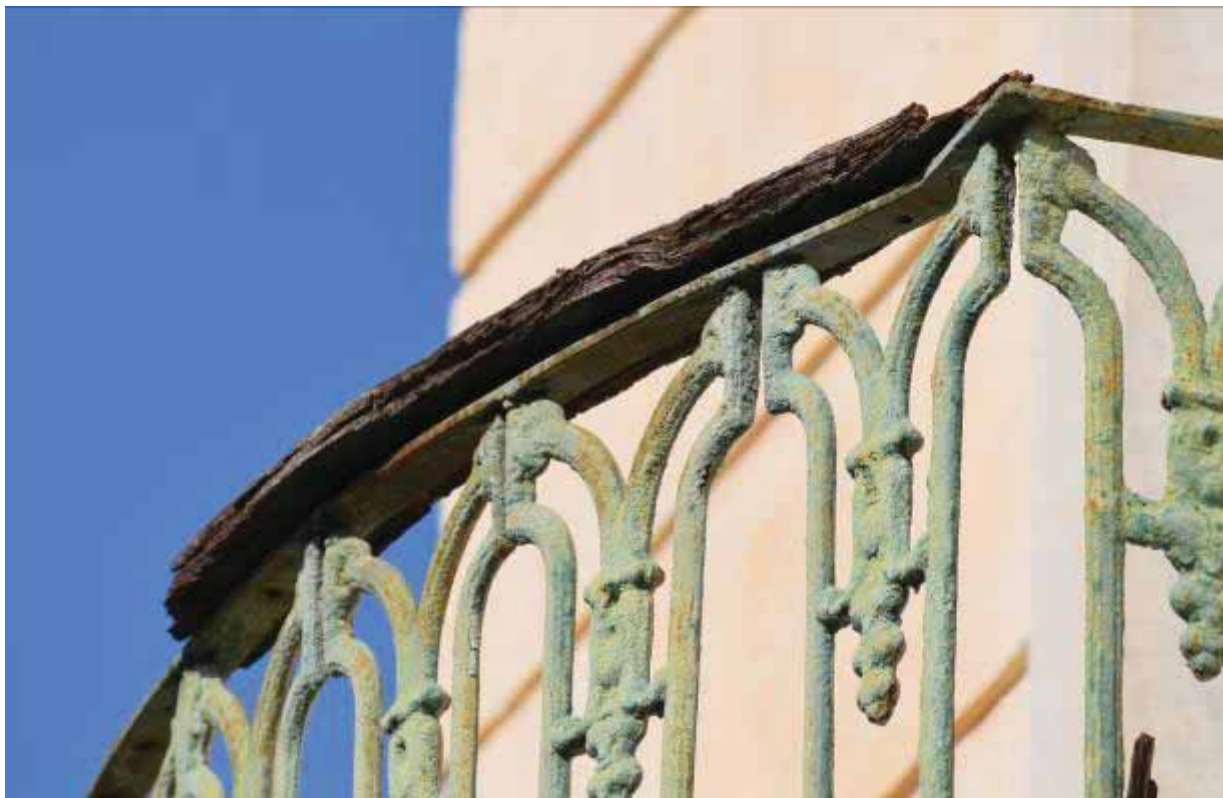
Φωτ. 479 Λεπτομέρεια της υδρολυμένης και αποσαθροποιημένης ξύλινης κουπαστής.
