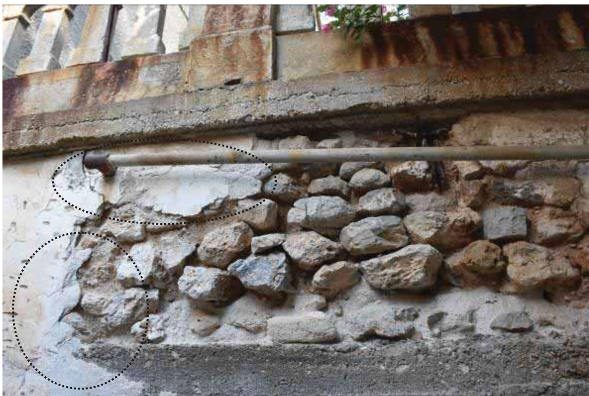
Φωτ. 42 Λεπτομέρεια της προηγούμενης φωτογραφίας. Εντός πλαισίου τα νεότερα τσιμεντοκονιάματα.
