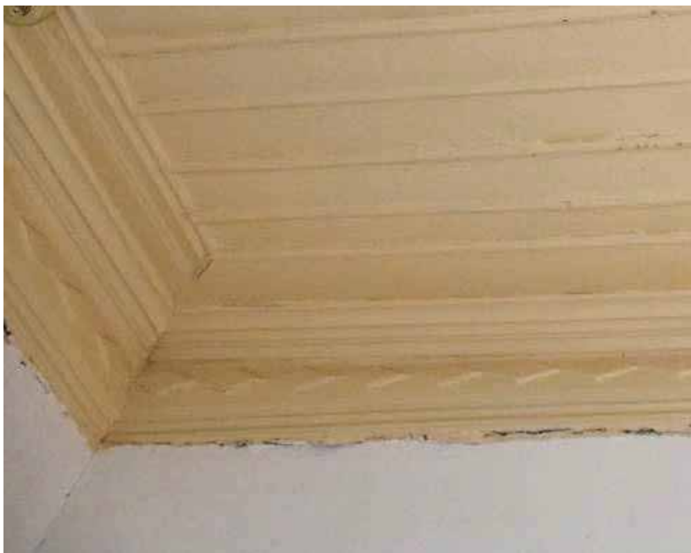
Φωτ. 279 Το γείσο της οροφής του χώρου Α1α.
