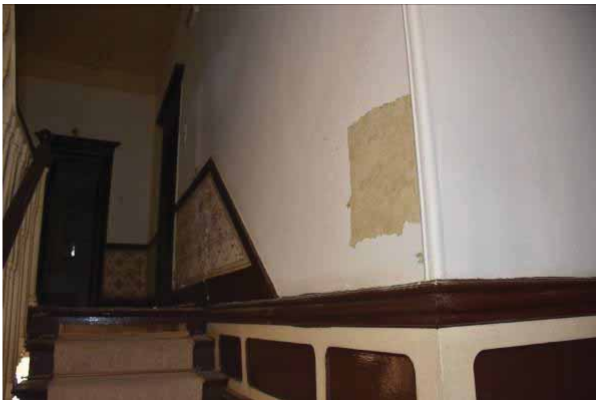
Φωτ. 186 Δείγμα αποκάλυψης πάνω από το πασαμέντο του κλιμακοστασίου.
