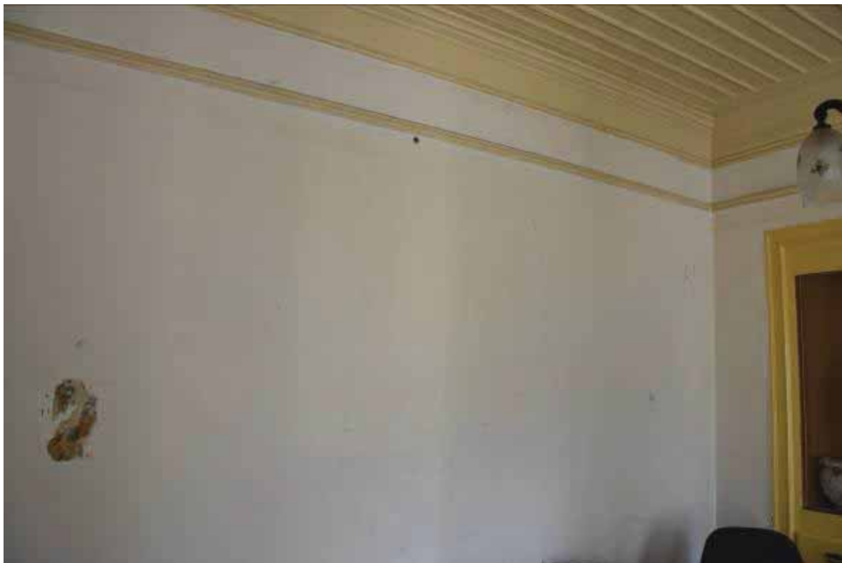
Φωτ. 201 Διερευνητική τομή στο μέσο των κατακόρυφων τοίχων του χώρου ΙΣ3.
