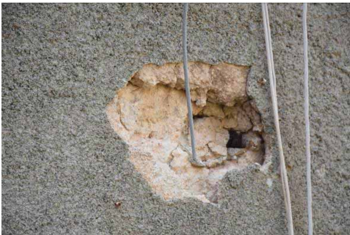
Φωτ. 58 Λεπτομέρεια της περιοχής εντός μαύρου πλαισίου της προηγούμενης φωτογραφίας, όπου διακρίνεται μέσα στην απώλεια ο οξειδωμένος μεταλλικός δοκός.
