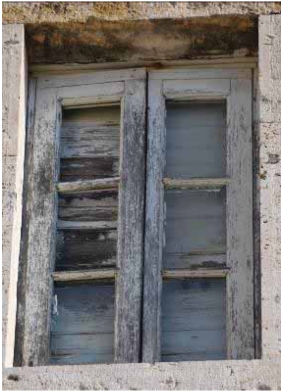
Φωτ. 448 Το άνοιγμα του χώρου Β5.
