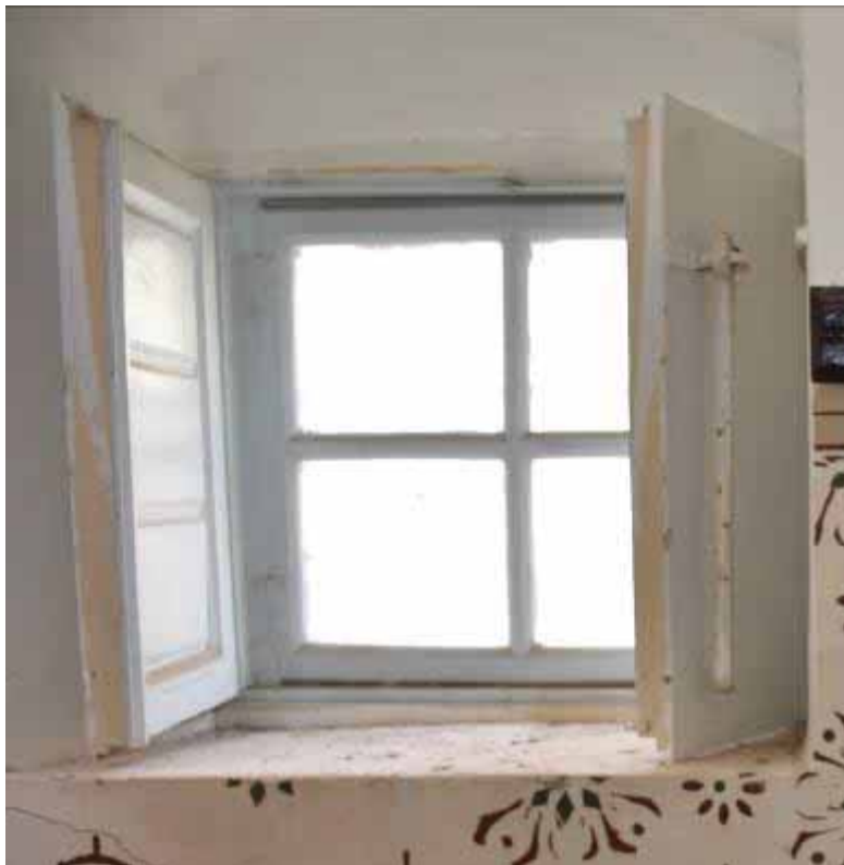
Φωτ. 455 Το άνοιγμα του κλιμακοστασίου ανάμεσα στον α' όροφο και β' όροφο (εσωτερική όψη).
