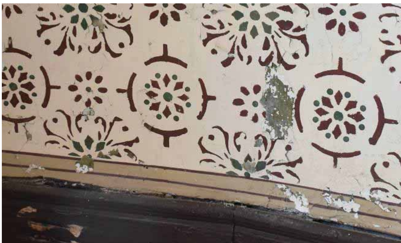
Φωτ. 96 Απολεπισμένο, κονιορτοποιημένο και αποχρωματισμένο ζωγραφικό στρώμα στο πασαμέντο του χώρου ΙΣ1α.
