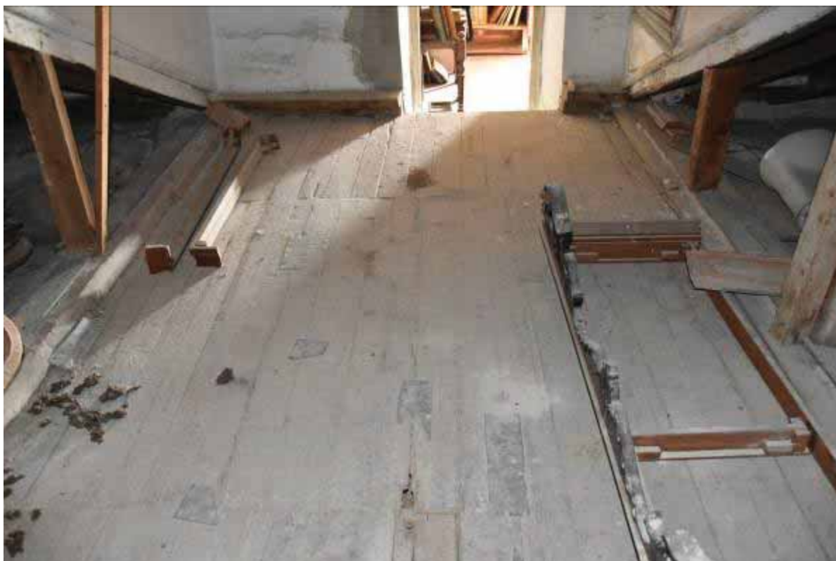
Φωτ. 349 Το ξύλινο δάπεδο του χώρου B5.
