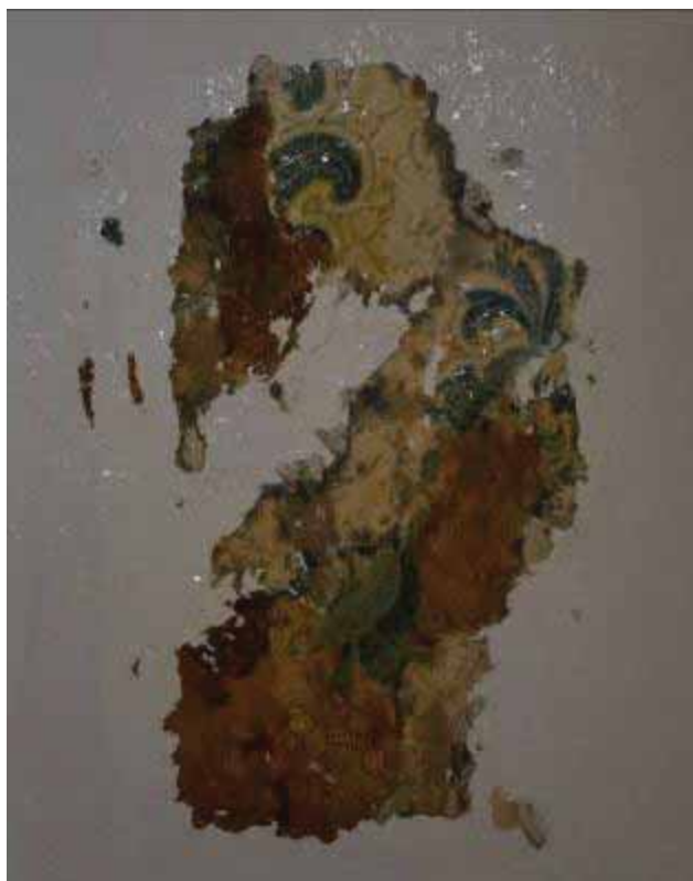
Φωτ. 202 Διερευνητική τομή στο μέσο των κατακόρυφων τοίχων του χώρου ΙΣ3, όπου βρέθηκε τμήμα των δύο ταπετσαριών.
