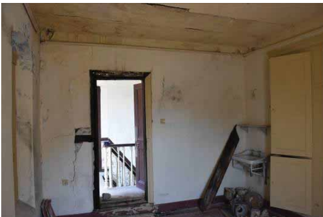
Φωτ. 161 Άποψη του χώρου Β2.
