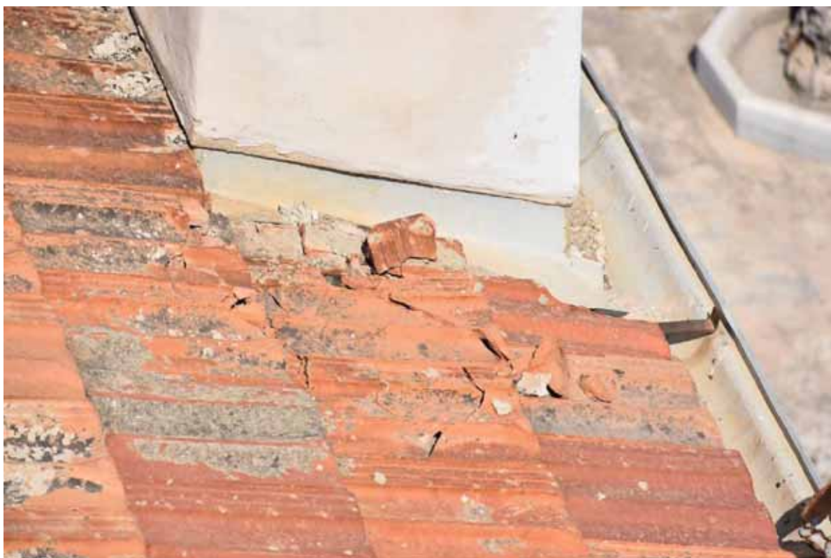
Φωτ. 486 Σπασμένα κεραμίδια στη σκεπή του Αρχοντικού.
