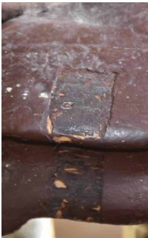
Φωτ. 239 Τα δείγματα αποκάλυψης που περικλείονται με κόκκινο πλαίσιο στην προηγούμενη φωτογραφία. Το συγκεκριμένο κιγκλίδωμα που βρίσκεται στον χώρο Β1 είναι μεταλλικό.
