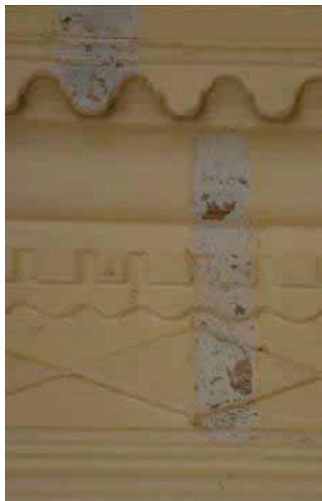
Φωτ. 288 Τα δείγματα αποκάλυψης που περικλείονται με κόκκινο πλαίσιο στην προηγούμενη φωτογραφία.
