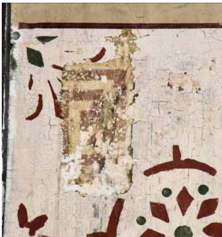
Φωτ. 156 Η διερευνητική τομή που περικλείεται με κόκκινο πλαίσιο στην προηγούμενη φωτογραφία.
