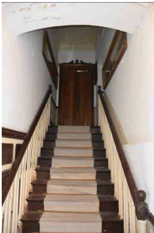
Φωτ. 234 Άποψη της ξύλινης κλίμακας του κτηρίου.
