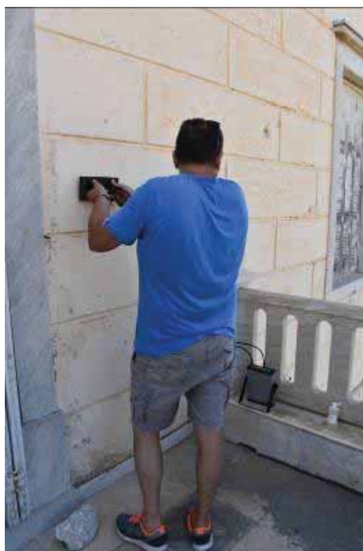
Φωτ. 28 Μέτρηση με τη συσκευή υπερήχων για τον έλεγχο στερεότητας των κονιαμάτων.
