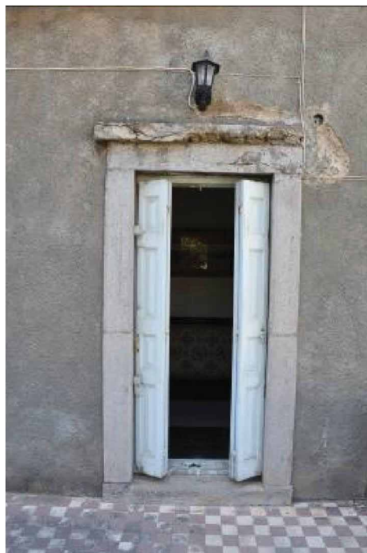
Φωτ. 56 Οξειδωμένοι μεταλλικοί δοκοί, ρηγματώσεις, αποκολλήσεις και απώλειες στη βόρεια όψη.
