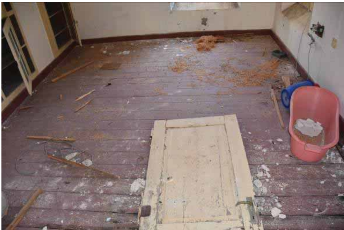
Φωτ. 342 Το ξύλινο δάπεδο του χώρου B2.
