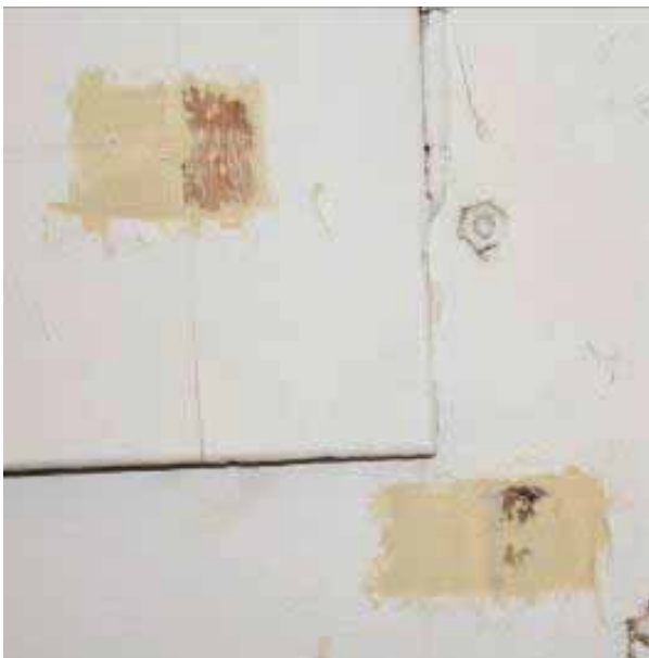
Φωτ. 369 Τα δείγματα αποκάλυψης στην ξύλινη εξώθυρα του χώρου ΙΣ1γ.
