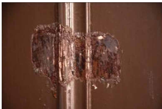
Φωτ. 392 Τα δείγματα αποκάλυψης στην ξύλινη θύρα και το κάσωμα του χώρου Α6.
