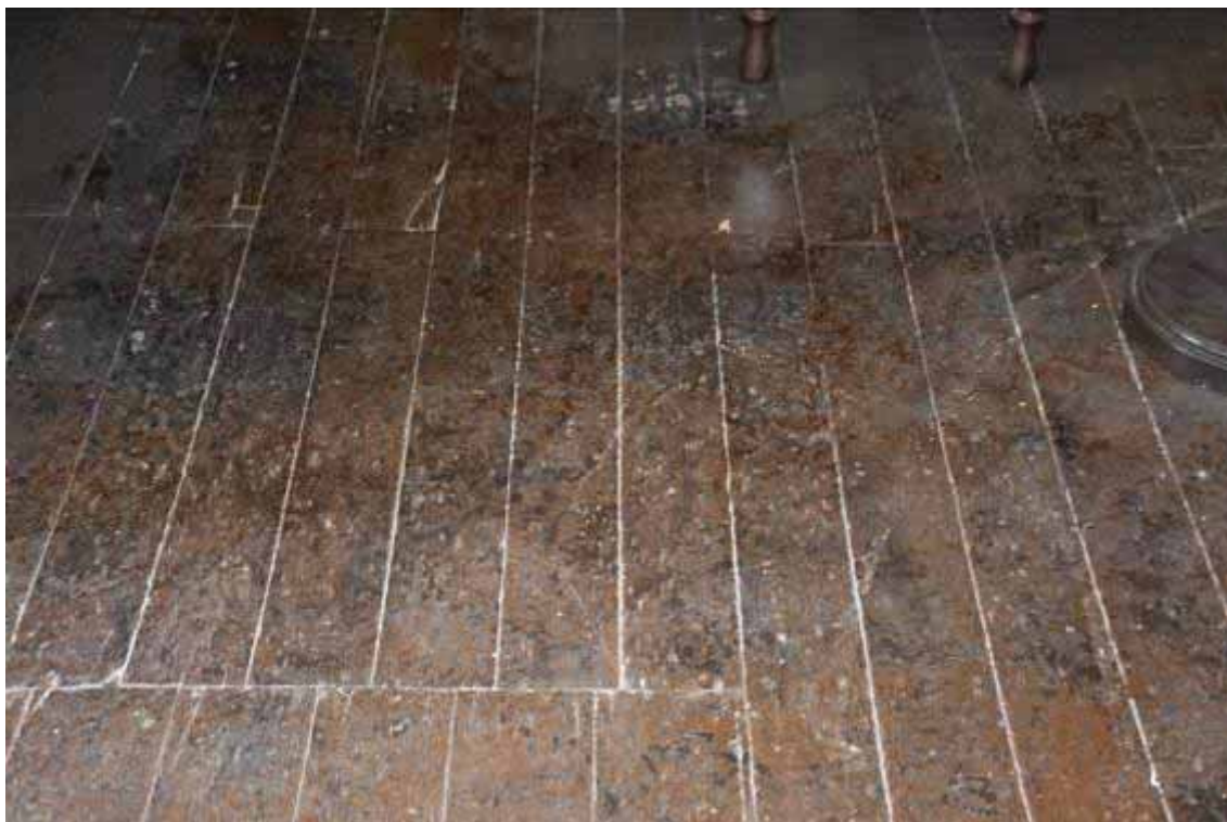
Φωτ. 324 Το ξύλινο δάπεδο του χώρου ΙΣ2.
