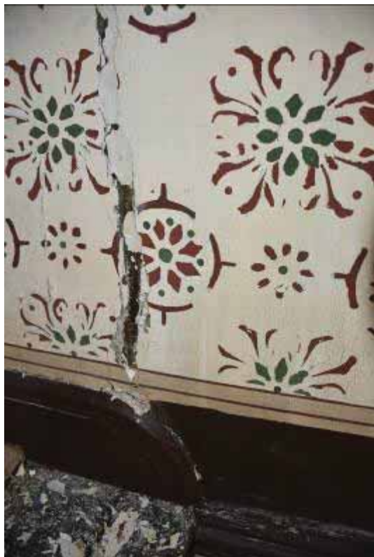
Φωτ. 132 Η διερευνητική τομή και το υποκείμενο ζωγραφικό στρώμα στο πασαμέντο του χώρου Α1α
