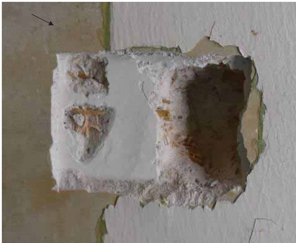
Φωτ. 64 Λιθοδομή με ασβεστοκονίαμα που περιέχει αδρανή και άχυρο σε κατακόρυφο τοίχο του χώρου ΙΣ1α. Ξεχωρίζει η κατασκευή στην 2 η οικοδομική φάση (περιοχή μαύρου βέλους) της τελικής πατητής κονίας, η οποία υποδέχθηκε το ζωγραφικό στρώμα.
