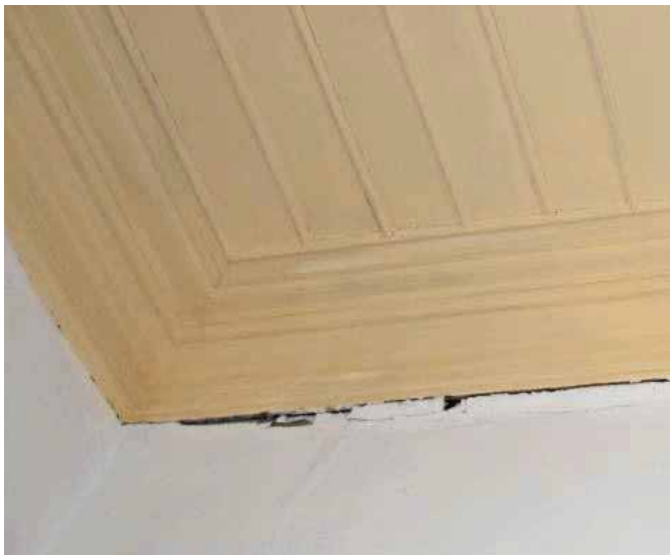
Φωτ. 277 Το γείσο της οροφής του χώρου ΙΣ6α
