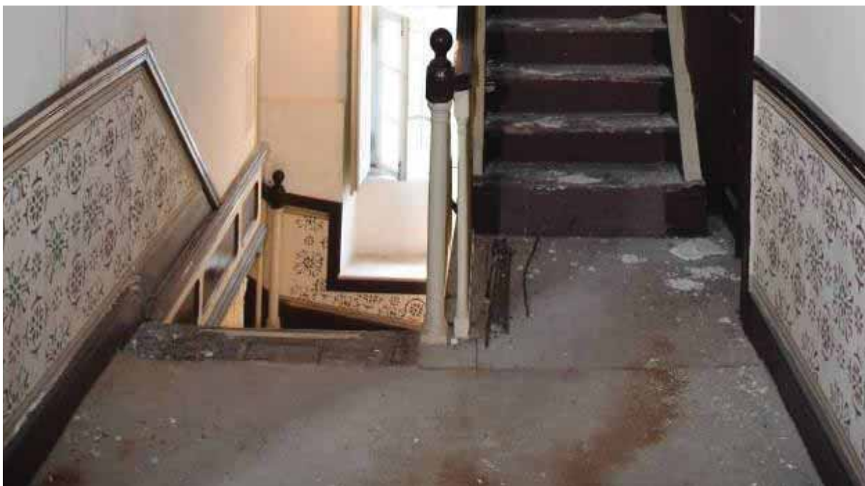
Φωτ. 334 Το ξύλινο δάπεδο του χώρου Α1α, το οποίο είναι καλυμμένο με μοκέτα.
