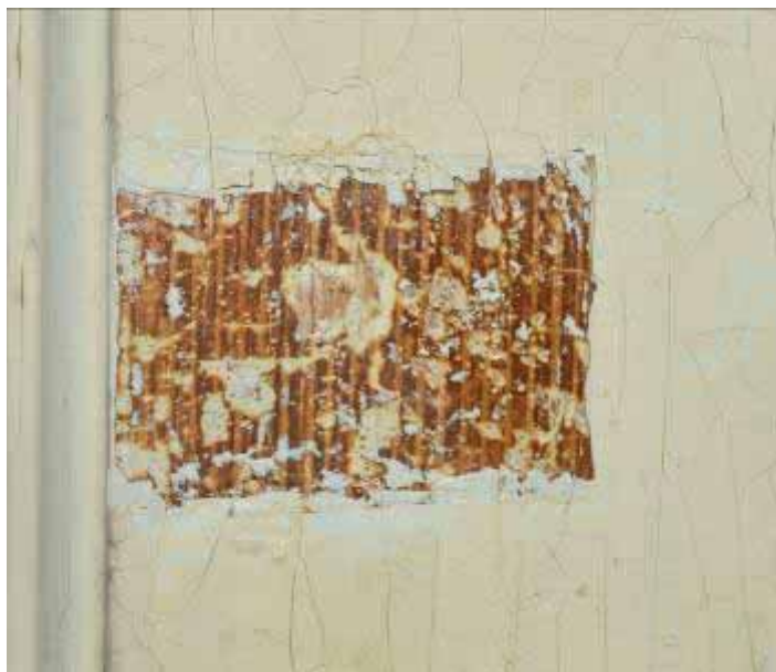
Φωτ. 442 Τα δείγματα αποκάλυψης στο άνοιγμα του χώρου Β3 σε απομίμηση ξύλου σε σχέδια κωνοφόρου ξύλου.
