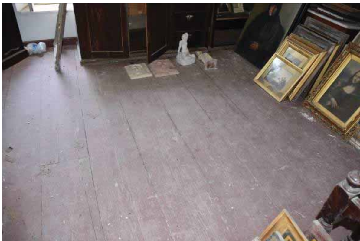
Φωτ. 346 Το ξύλινο δάπεδο του χώρου Β4.
