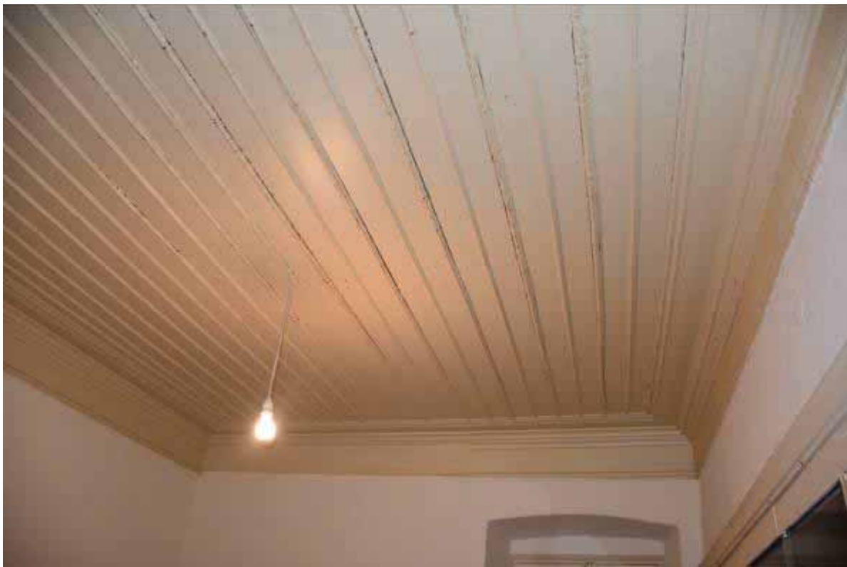
Φωτ. 273 Η ξύλινη οροφή του χώρου ΙΣ4.
