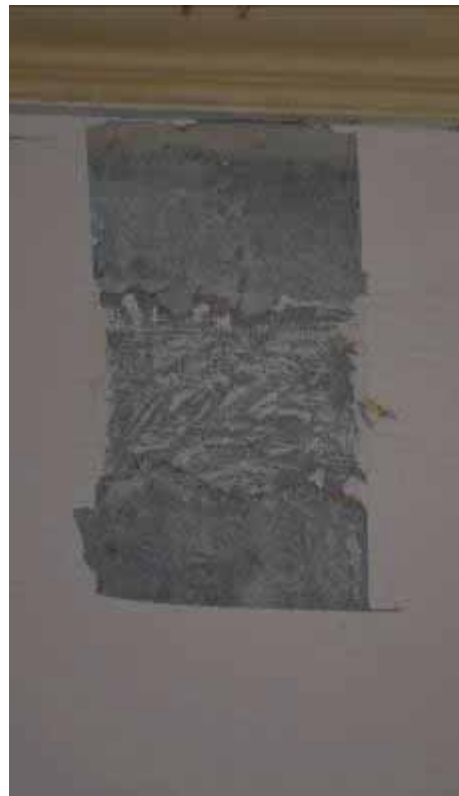
Φωτ. 141 Οι διερευνητικές τομές που περικλείονται με κόκκινο πλαίσιο στην προηγούμενη φωτογραφία.
