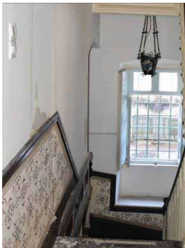
Φωτ. 181 Άποψη του κλιμακοστασίου από το ισόγειο προς τον α' όροφο.
