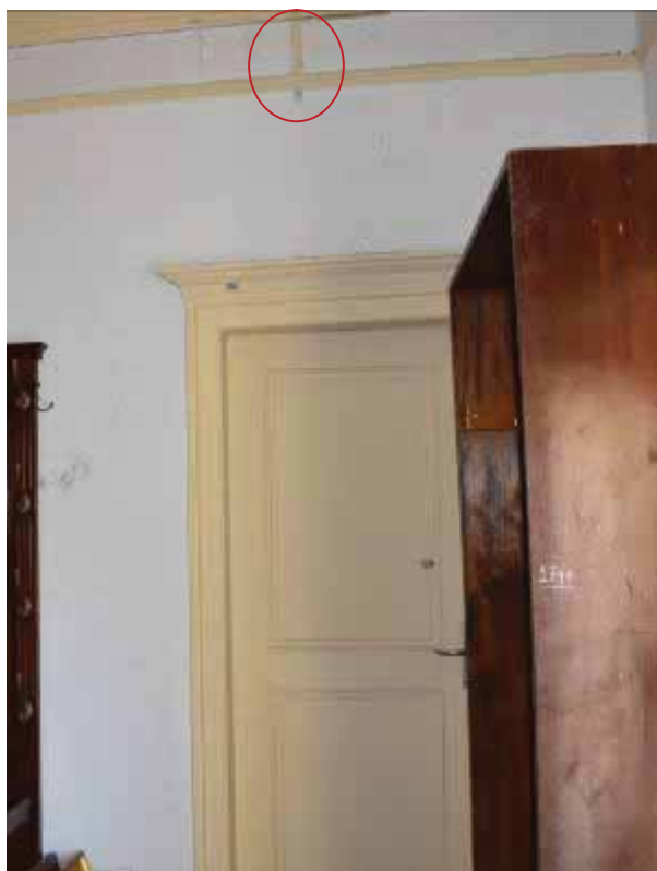
Φωτ. 171 Διερευνητική τομή στην ανώτερη περιοχή των κατακόρυφων τοίχων, κάτω από την ξύλινη οροφή του χώρου Β4.
