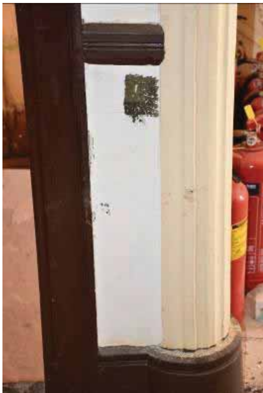
Φωτ. 90 Το υποκείμενο ζωγραφικό στρώμα στη θέση του πασαμέντο στον χώρο ΙΣ1β.
