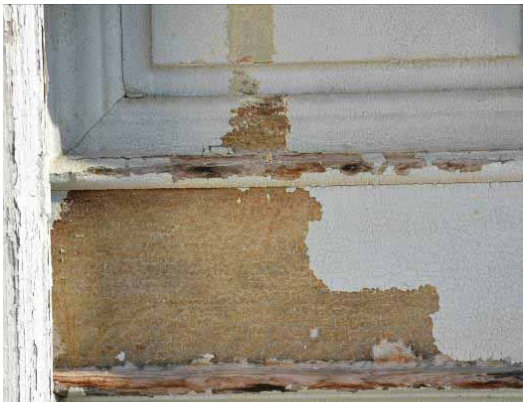
Φωτ. 379 Τα δείγματα αποκάλυψης στην ξύλινη εξώθυρα του χώρου ΙΣ6β.
