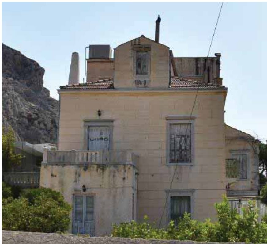
Φωτ. 13 Η πλαϊνή δυτική όψη του Αρχοντικού.
