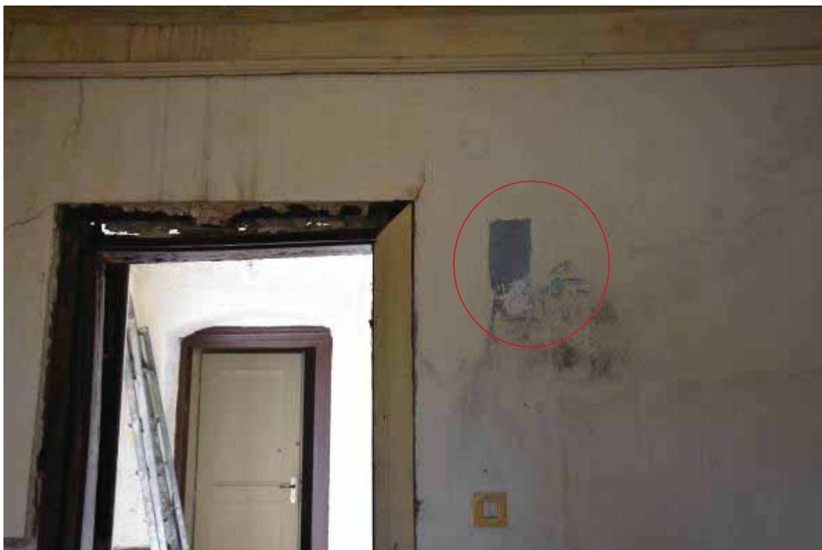
Φωτ. 162 Διερευνητική τομή στο μέσο των κατακόρυφων τοίχων του χώρου Β2.
