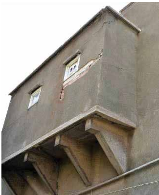
Φωτ. 56 Οξειδωμένοι μεταλλικοί δοκοί, ρηγματώσεις, αποκολλήσεις και απώλειες στη βόρεια όψη.
