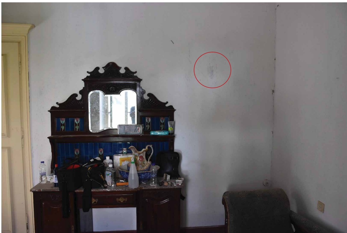
Φωτ. 166 Διερευνητική τομή στο μέσο των κατακόρυφων τοίχων του χώρου Β3.
