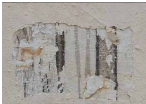
Φωτ. 21 Οι τέσσερις διερευνητικές- στρωματογραφικές τομές που πραγματοποιήθηκαν στην βόρεια όψη.
