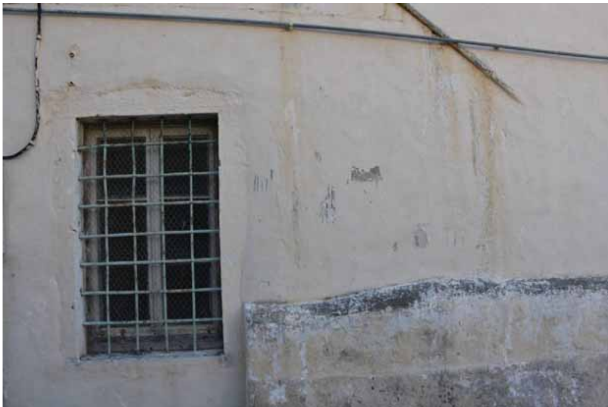
Φωτ. 21 Οι τέσσερις διερευνητικές- στρωματογραφικές τομές που πραγματοποιήθηκαν στην βόρεια όψη.
