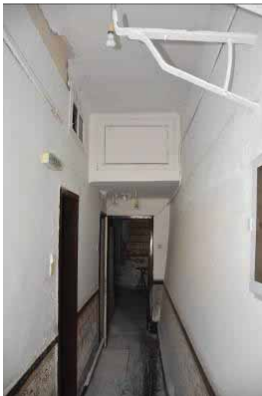
Φωτ. 116 Άποψη του χώρου ΙΣ7.
