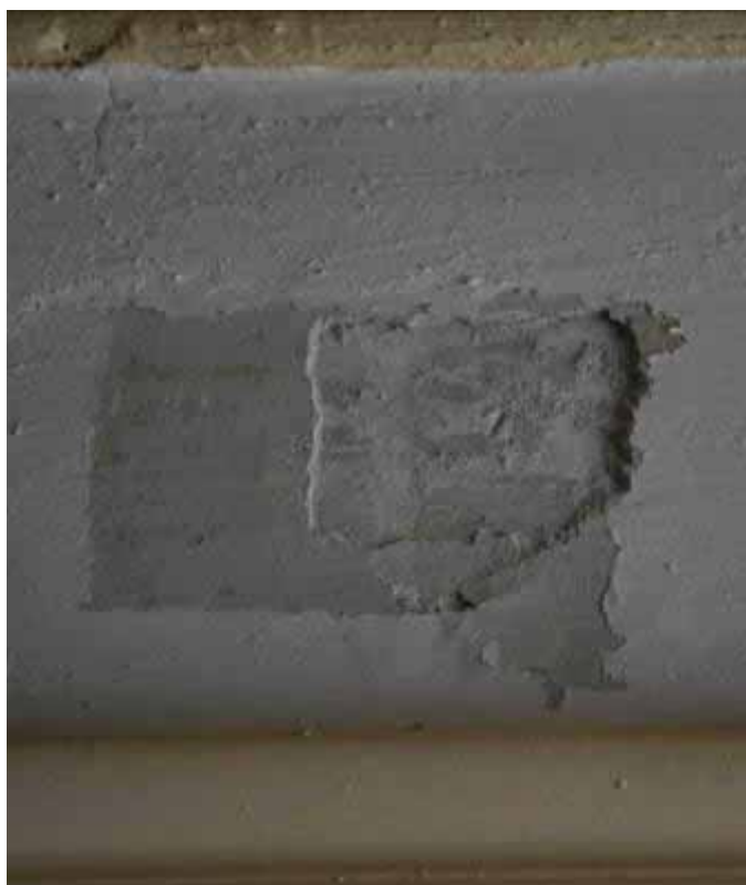
Φωτ. 99 Διερευνητική τομή στην ανώτερη περιοχή των κατακόρυφων τοίχων, κάτω από την ξύλινη οροφή του χώρου ΙΣ2.
