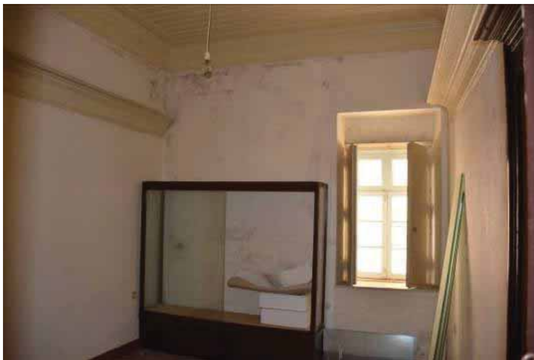
Φωτ. 149 Άποψη του χώρου Α6.
