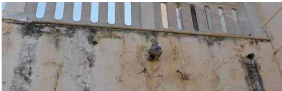
Φωτ. 45 Ρηγματώσεις, αποκολλήσεις, κονιορτοποιήσεις, απώλειες και ανάπτυξη βιολογικών επικαθίσεων στο επίχρυσμα της δυτικής όψης.
