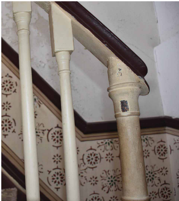
Φωτ. 240 Δείγμα αποκάλυψης στα κιγκλιδώματα της ξύλινης κλίμακας.
