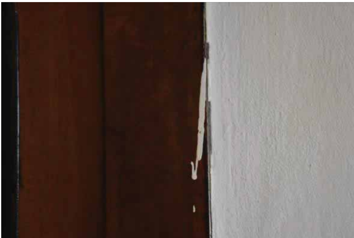
Φωτ. 473 κηλιδώσεις από νεότερες χρωστικές στην ξύλινη εντοιχισμένη ντουλάπα του χώρου Α3.
