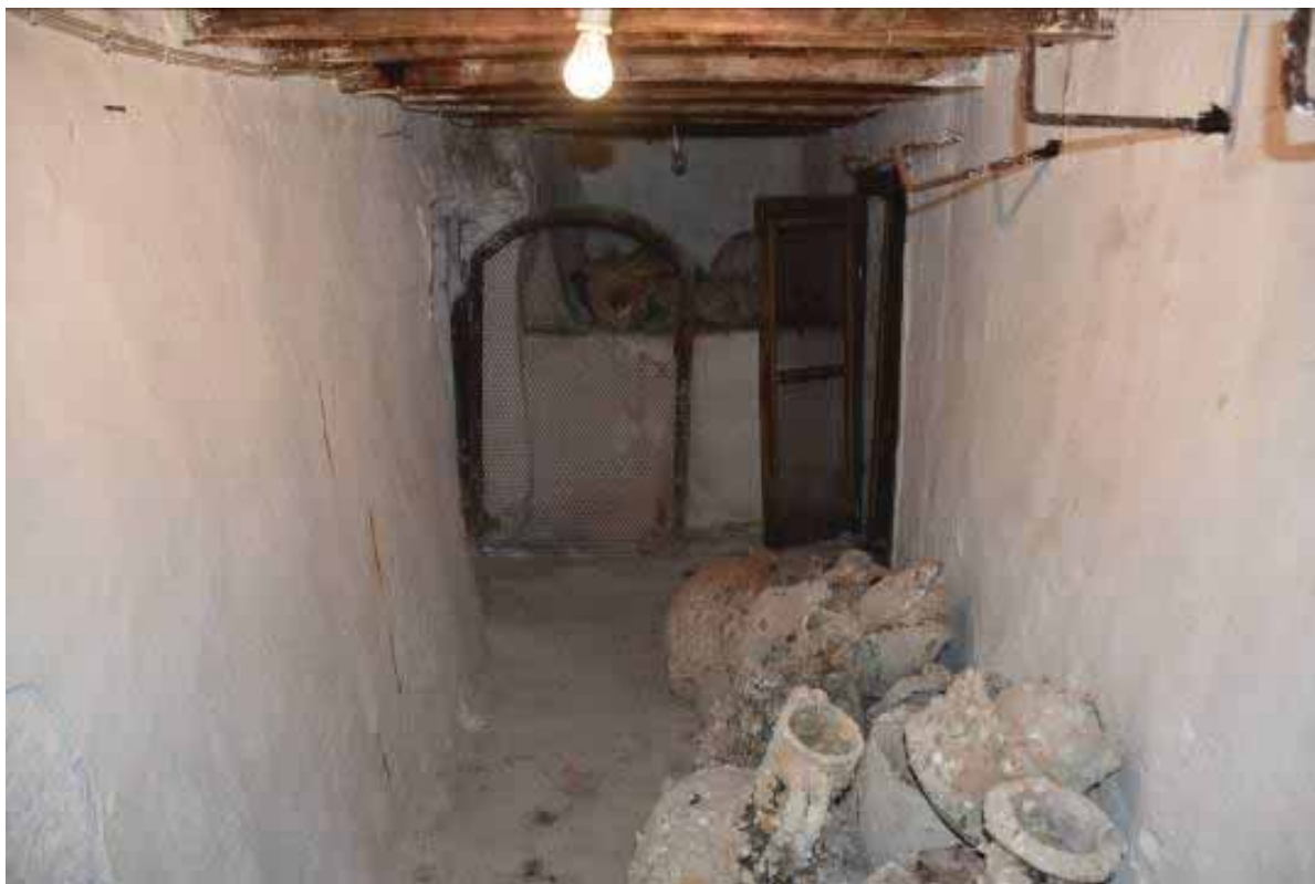
Φωτ. 75 Άποψη των χώρων του υπογείου.
