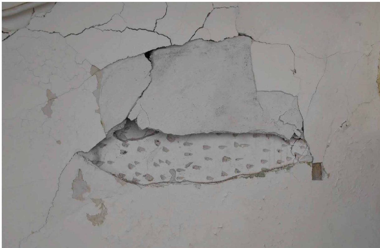
Φωτ. 6 Πατητή κονία με προσθήκη ποζολάνης η οποία είναι εμφανής από απώλεια κονιάματος στον χώρο του κλιμακοστασίου.
