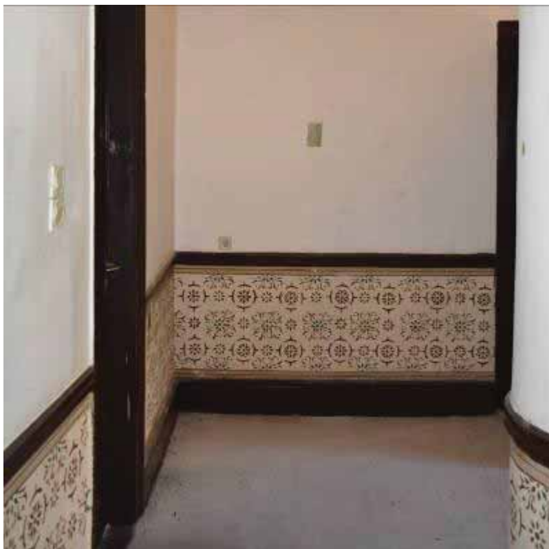
Φωτ. 323 Το ξύλινο δάπεδο του χώρου ΙΣ1γ, το οποίο είναι καλυμμένο με μοκέτα.
