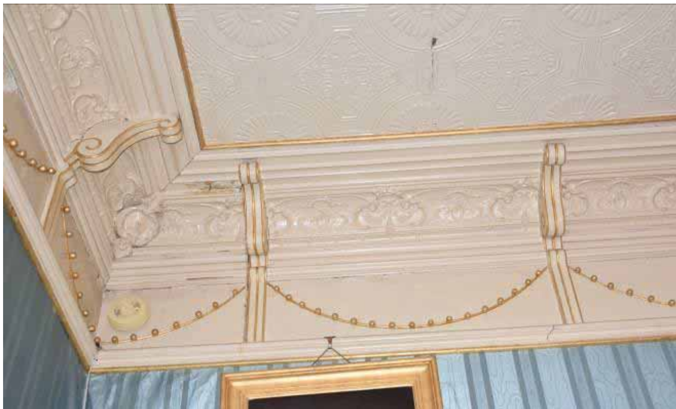
Φωτ. 284 Το ξύλινο γείσο της οροφής του χώρου Α2. Διακρίνονται τα επιχρυσωμένα διακοσμητικά τμήματα.
