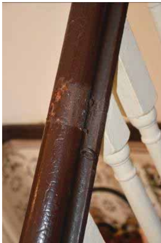
Φωτ. 236 Δείγμα αποκάλυψης στην κουπαστή της ξύλινης κλίμακας.
