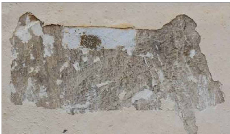
Φωτ. 22 Λεπτομέρειες των τομών τις προηγούμενης φωτογραφίας. Οι γκρι γραμμές που αποκαλύφθηκαν στα δείγματα είναι μίγμα υγρών και σκουριάς που προέρχονται από τις μεταλλικές σωληνώσεις.
