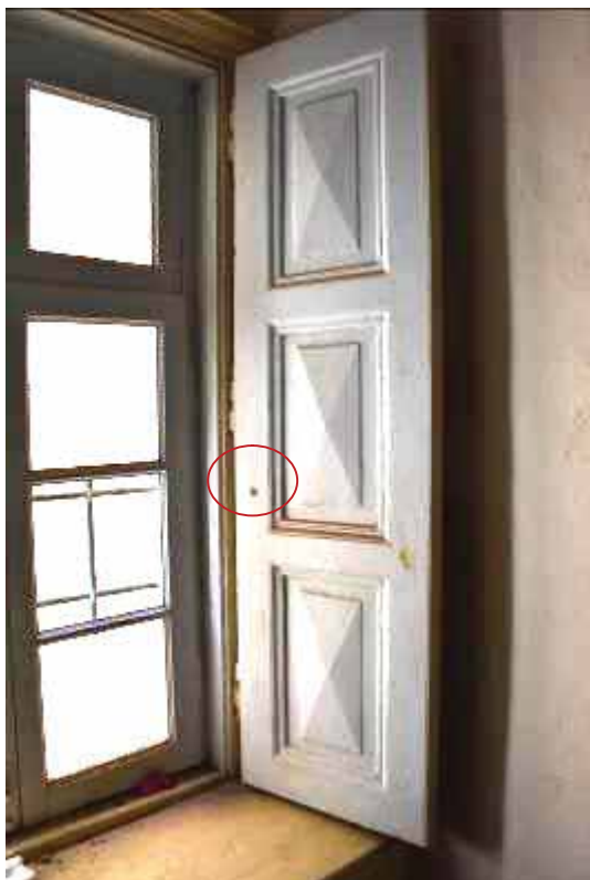
Φωτ. 434 Το δείγμα αποκάλυψης στο σκούρο του ανοίγματος του χώρου Α6.
