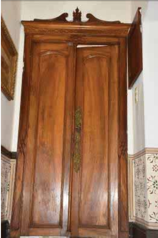
Φωτ. 386 Η ξύλινη θύρα του χώρου Α2.
