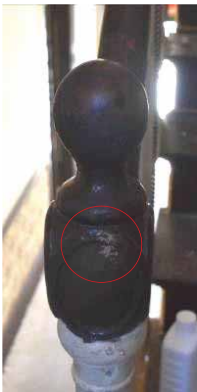
Φωτ. 237 Δείγμα αποκάλυψης στα κιγκλιδώματα της ξύλινης κλίμακας.
