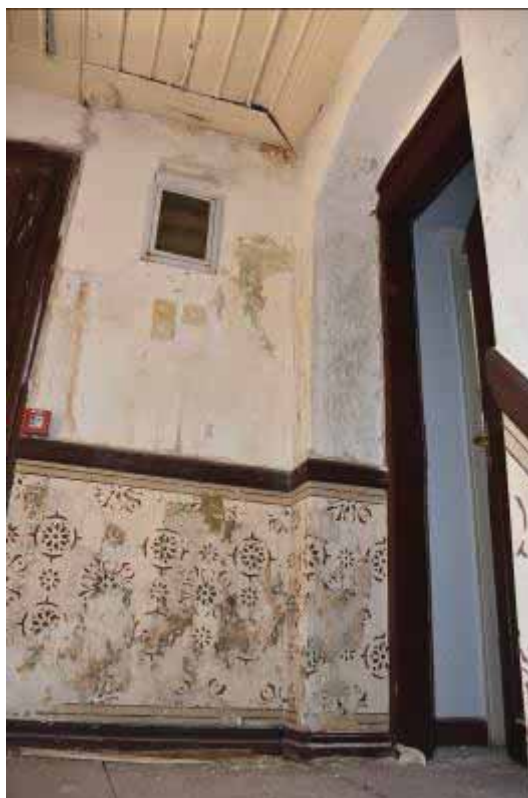
Φωτ. 153 Άποψη του χώρου Β1.
