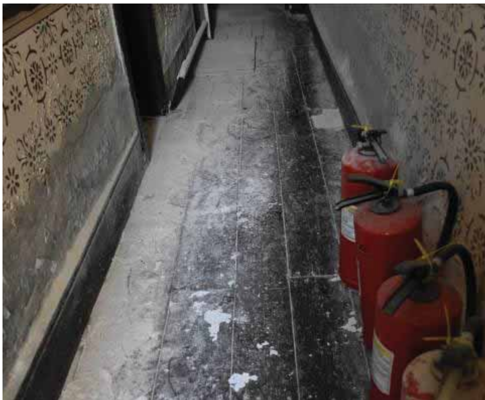
Φωτ. 332 Το ξύλινο δάπεδο του χώρου ΙΣ7.
