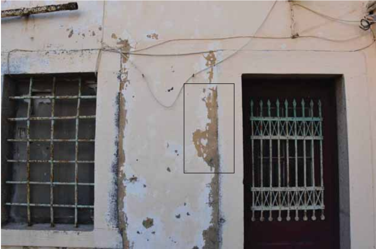
Φωτ. 19 Η νεότερη επέκταση της 3 ης φάσης στη βόρεια όψη του Αρχοντικού.
