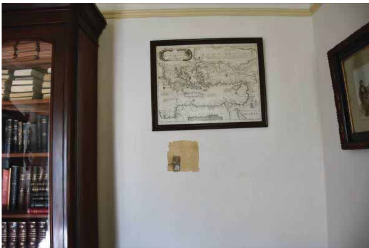
Φωτ. 198 Διερευνητική τομή στο μέσο των κατακόρυφων τοίχων του χώρου ΙΣ2.
