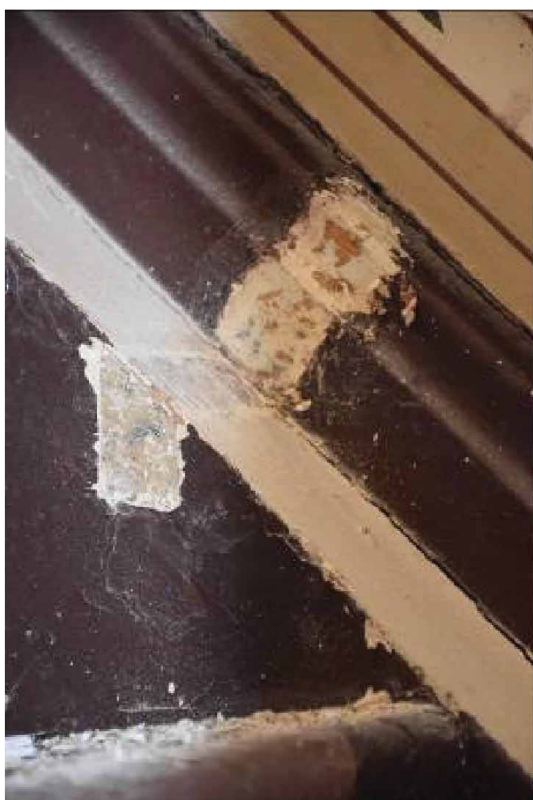
Φωτ. 243 Τα δείγματα αποκάλυψης που περικλείονται με κόκκινο πλαίσιο στην προηγούμενη φωτογραφία.
