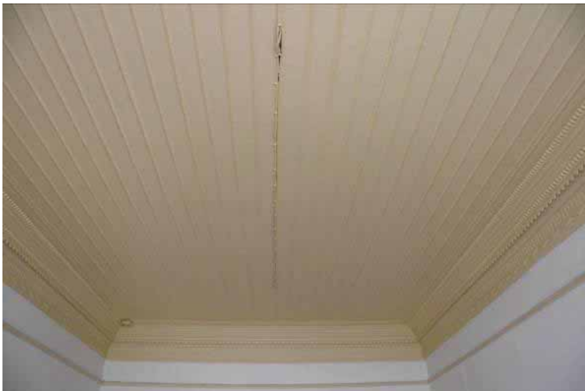
Φωτ. 285 Η ξύλινη οροφή του χώρου Α3.
