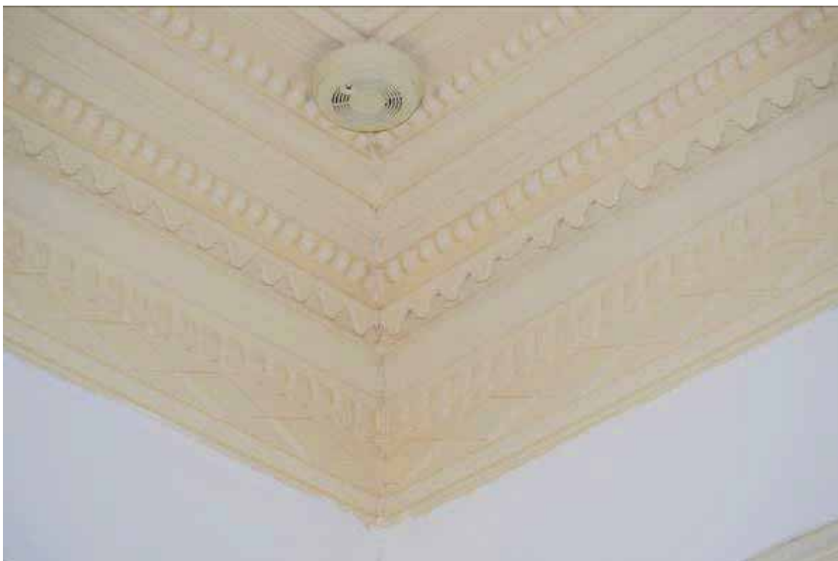
Φωτ. 286 Το γείσο της οροφής του χώρου Α2.
