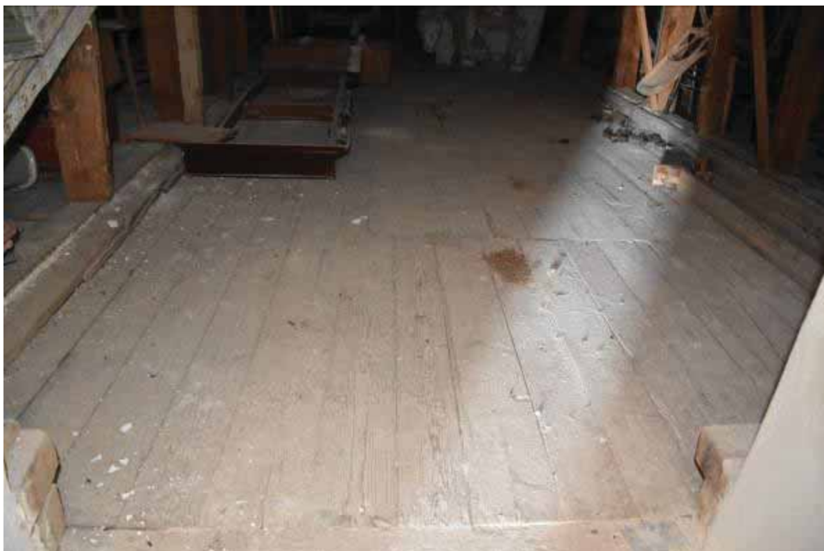
Φωτ. 348 Το ξύλινο δάπεδο του χώρου B5.
