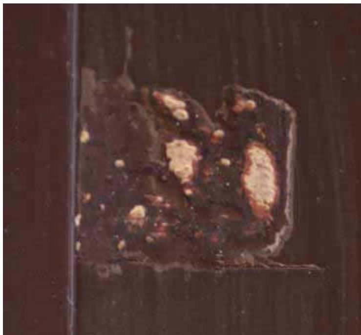
Φωτ. 389 Τα δείγματα αποκάλυψης στην ξύλινη θύρα και το κάσωμα του χώρου Α4.
