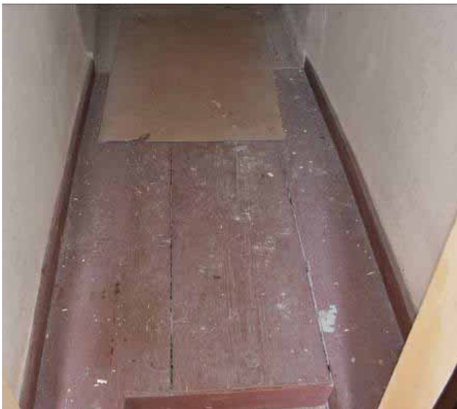
Φωτ. 350 Το ξύλινο δάπεδο του χώρου Β6α.
