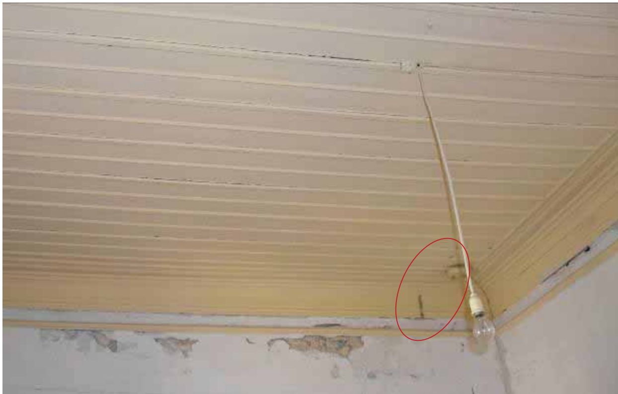
Φωτ. 300 Δείγματα αποκάλυψης στην ξύλινη οροφή του χώρου Β3.
