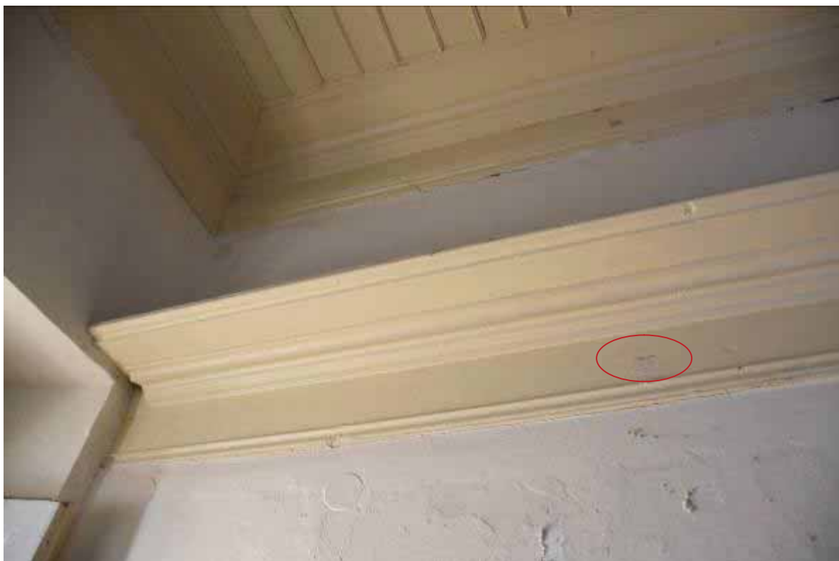
Φωτ. 294 Δείγμα αποκάλυψης στην ξύλινη οροφή του χώρου Α6.
