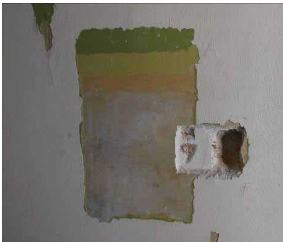
Φωτ. 87 Η διερευνητική τομή – στρωματογραφία σε κατακόρυφο τοίχου, πάνω από το πασαμέντο, στον χώρο ΙΣ1α.
