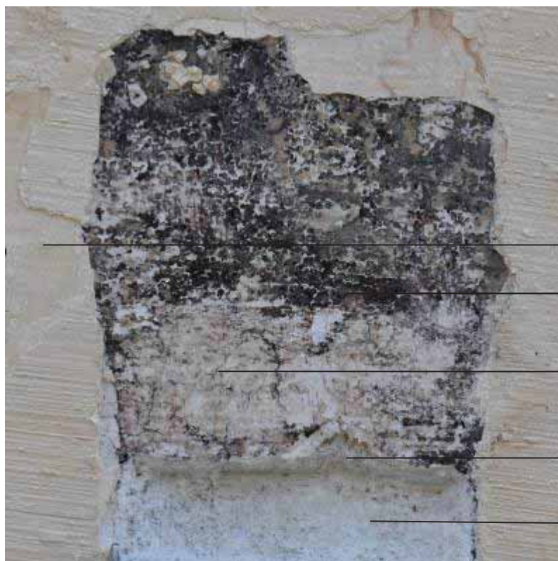
Φωτ. 17 Στρωματογραφία των κονιαμάτων επίχρισης και των χρωματικών στρωμάτων της δυτικής όψης, σε περιοχή όπου υπάρχει η ισόδομη επισήμανση.
