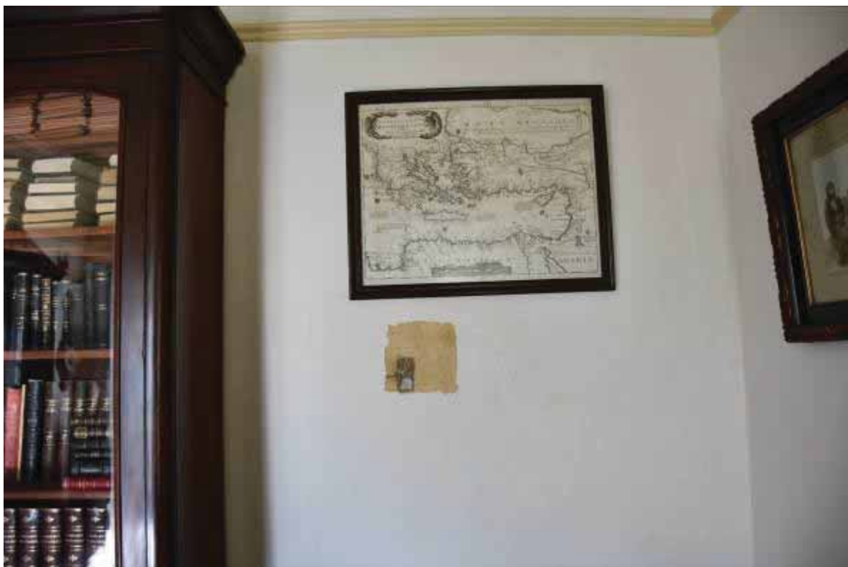
Φωτ. 100 Διερευνητική τομή στο μέσο των κατακόρυφων τοίχων του χώρου ΙΣ2.
