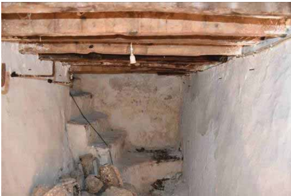
Φωτ. 74 Άποψη των χώρων του υπογείου.
