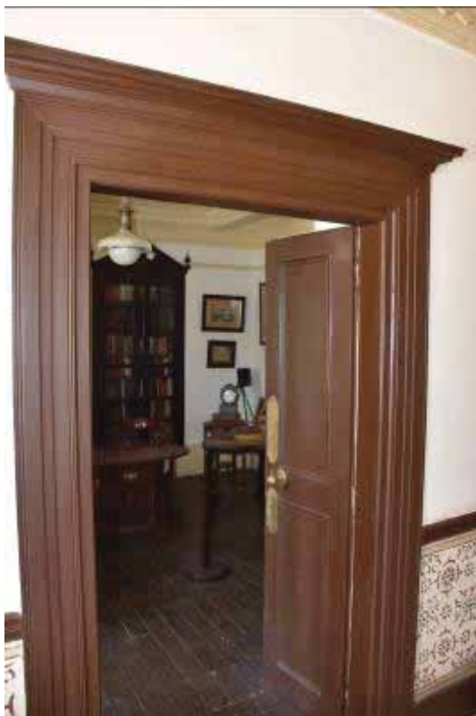
Φωτ. 370 Η ξύλινη θύρα του χώρου ΙΣ2.
