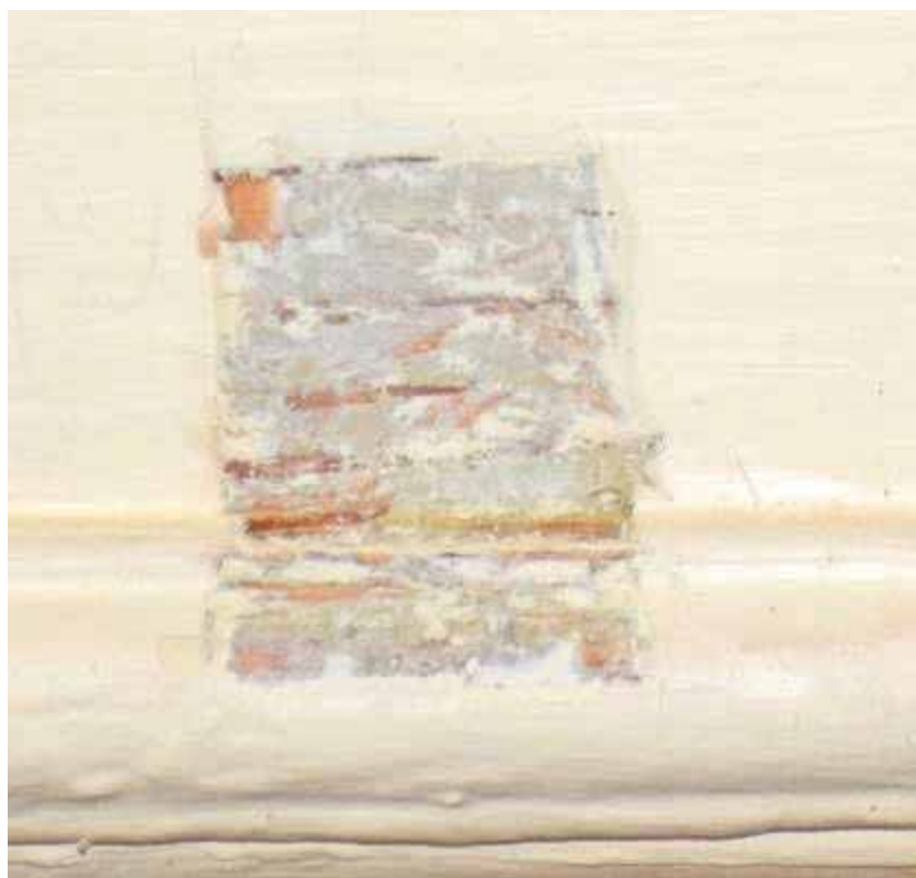
Φωτ. 249 Το δείγμα αποκάλυψης που περικλείεται με κόκκινο πλαίσιο στην προηγούμενη φωτογραφία.
