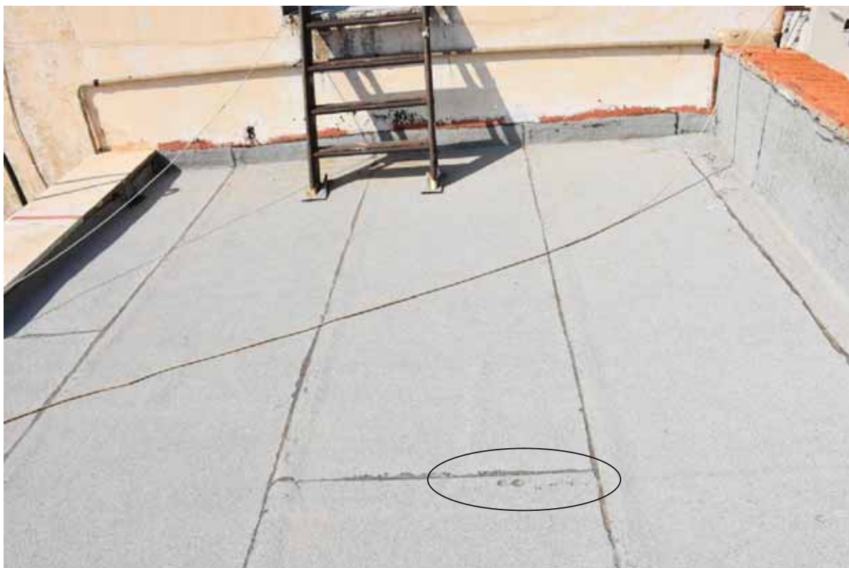
Φωτ. 487 <Κακή διατήρηση της μόνωσης των δωματίων του Αρχοντικού.
