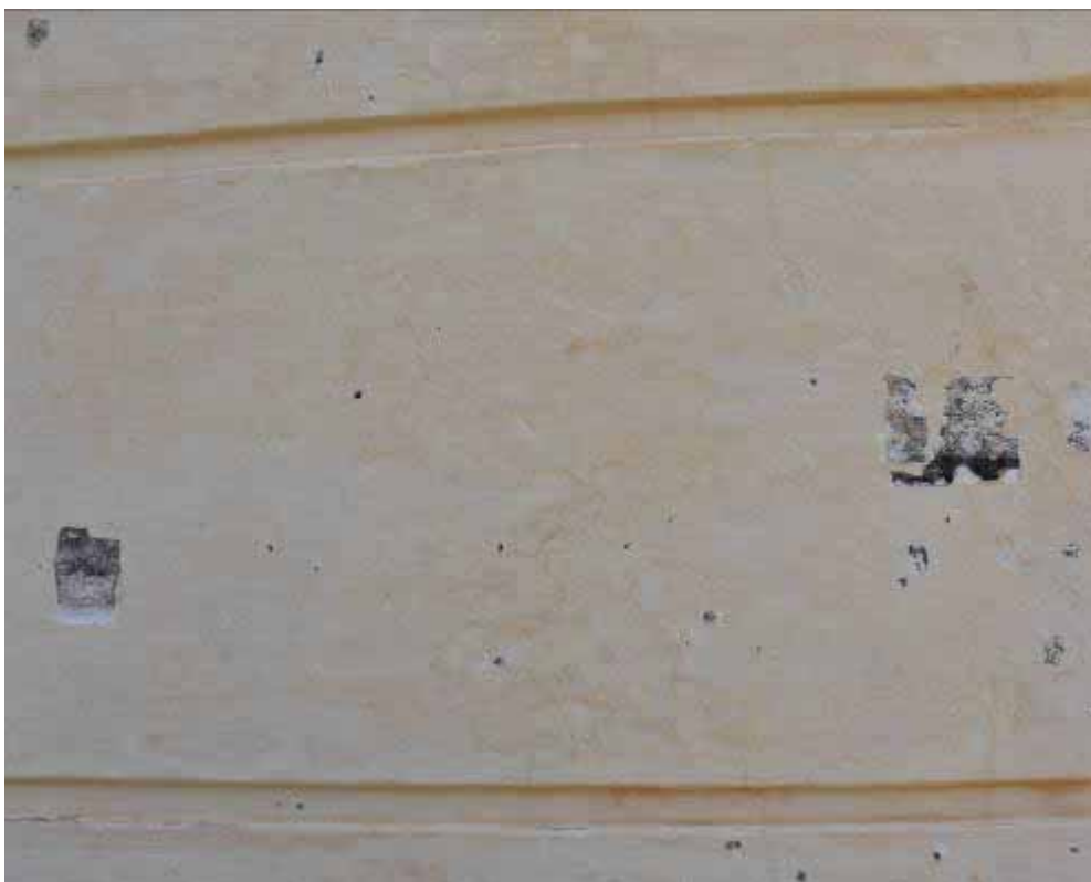
Φωτ. 16 Οι δύο διερευνητικές- στρωματογραφικές τομές που πραγματοποιήθηκαν στην δυτική όψη σε περιοχή όπου υπάρχει η ισόδομη επισήμανση.
