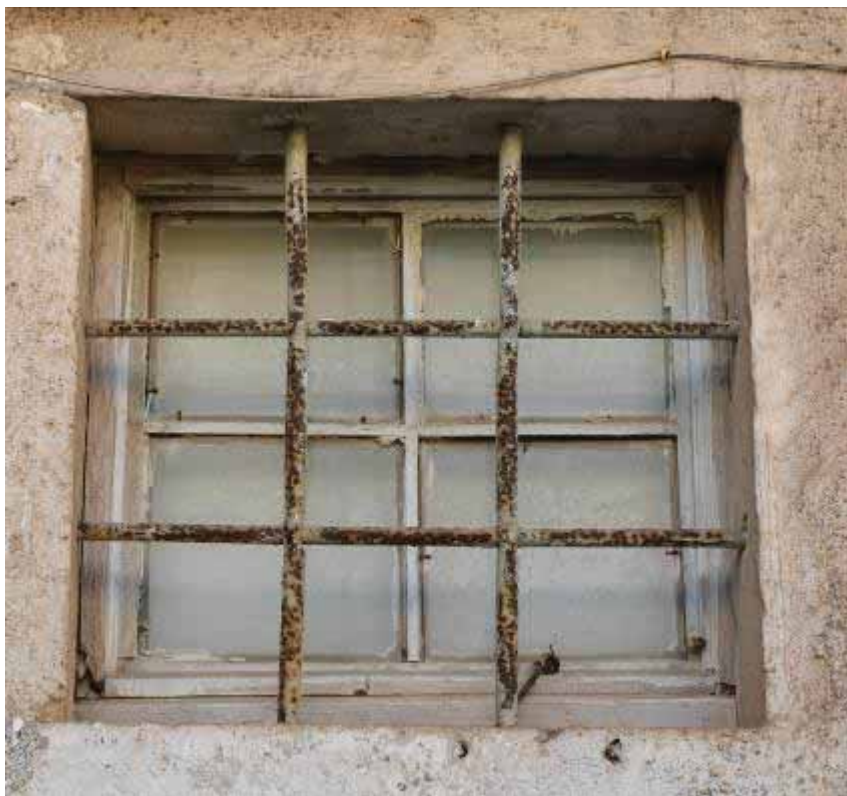
Φωτ. 456 Το άνοιγμα του κλιμακοστασίου ανάμεσα στον α' όροφο και β' όροφο (εξωτερική όψη).
