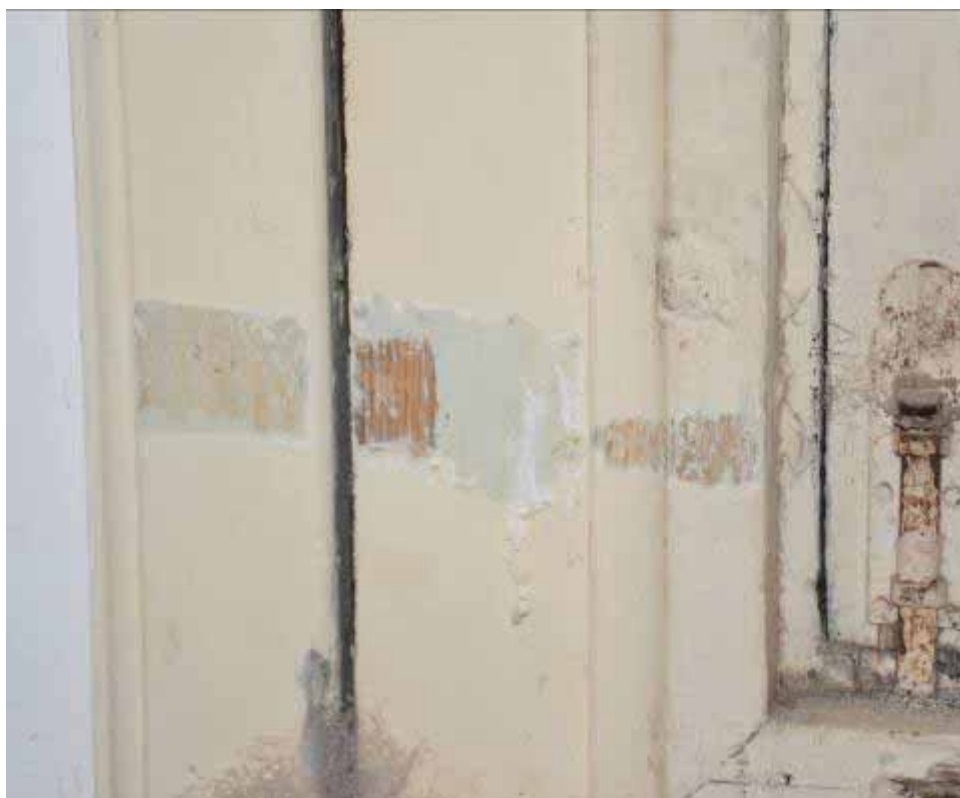
Φωτ. 381 Τα δείγματα αποκάλυψης στην ξύλινη εξώθυρα και το κάσωμα του χώρου ΙΣ7.
