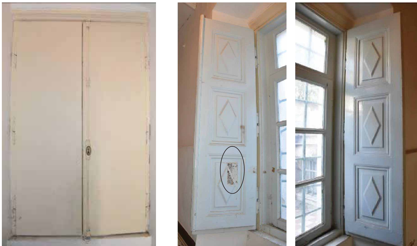
Φωτ. 452 Το άνοιγμα του κλιμακοστασίου ανάμεσα στο ισόγειο και τον α' όροφο.
