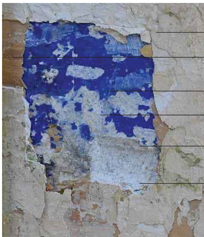
Φωτ. 18 Στρωματογραφία των κονιαμάτων επίχρισης και των χρωματικών στρωμάτων της δυτικής όψης, σε περιοχή όπου δεν υπάρχει η ισόδομη επισήμανση (επέκταση κουζίνας).
