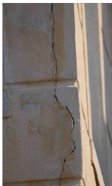
Φωτ. 35 Ρηγματώσεις, αποκολλήσεις, κονιορτοποιήσεις και απώλειες στο επίχρυσμα της νότιας όψης.
