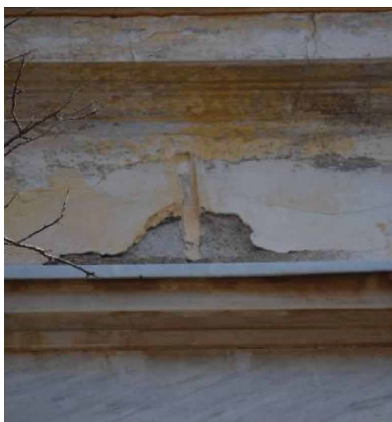
Φωτ. 35 Ρηγματώσεις, αποκολλήσεις, κονιορτοποιήσεις και απώλειες στο επίχρυσμα της νότιας όψης.
