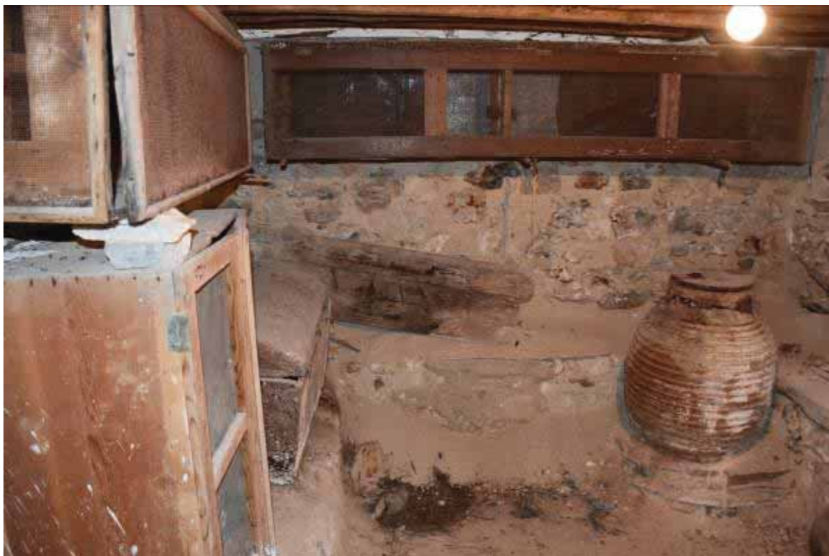
Φωτ. 76 Άποψη των χώρων του υπογείου.
