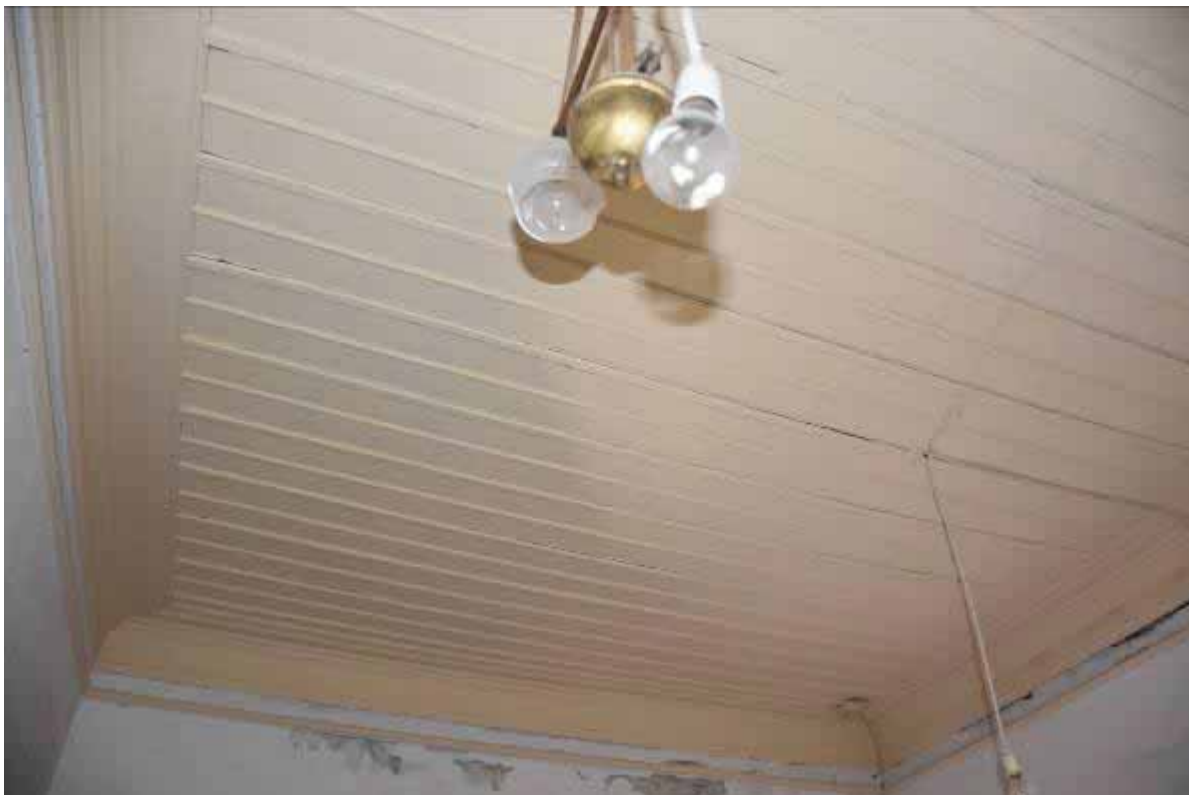
Φωτ. 298 Η ξύλινη οροφή του χώρου Β3.
