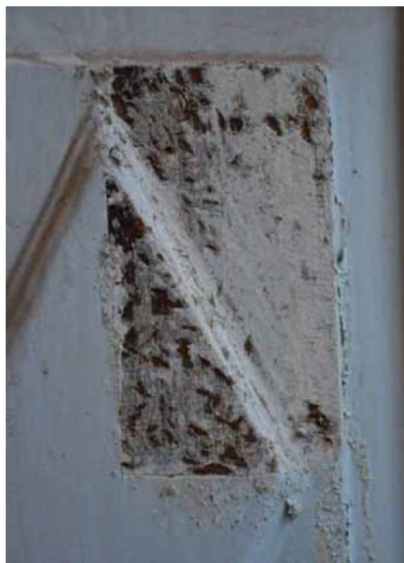
Φωτ. 453 Το δείγμα αποκάλυψης στο σκούρο του ανοίγματος του κλιμακοστασίου..
