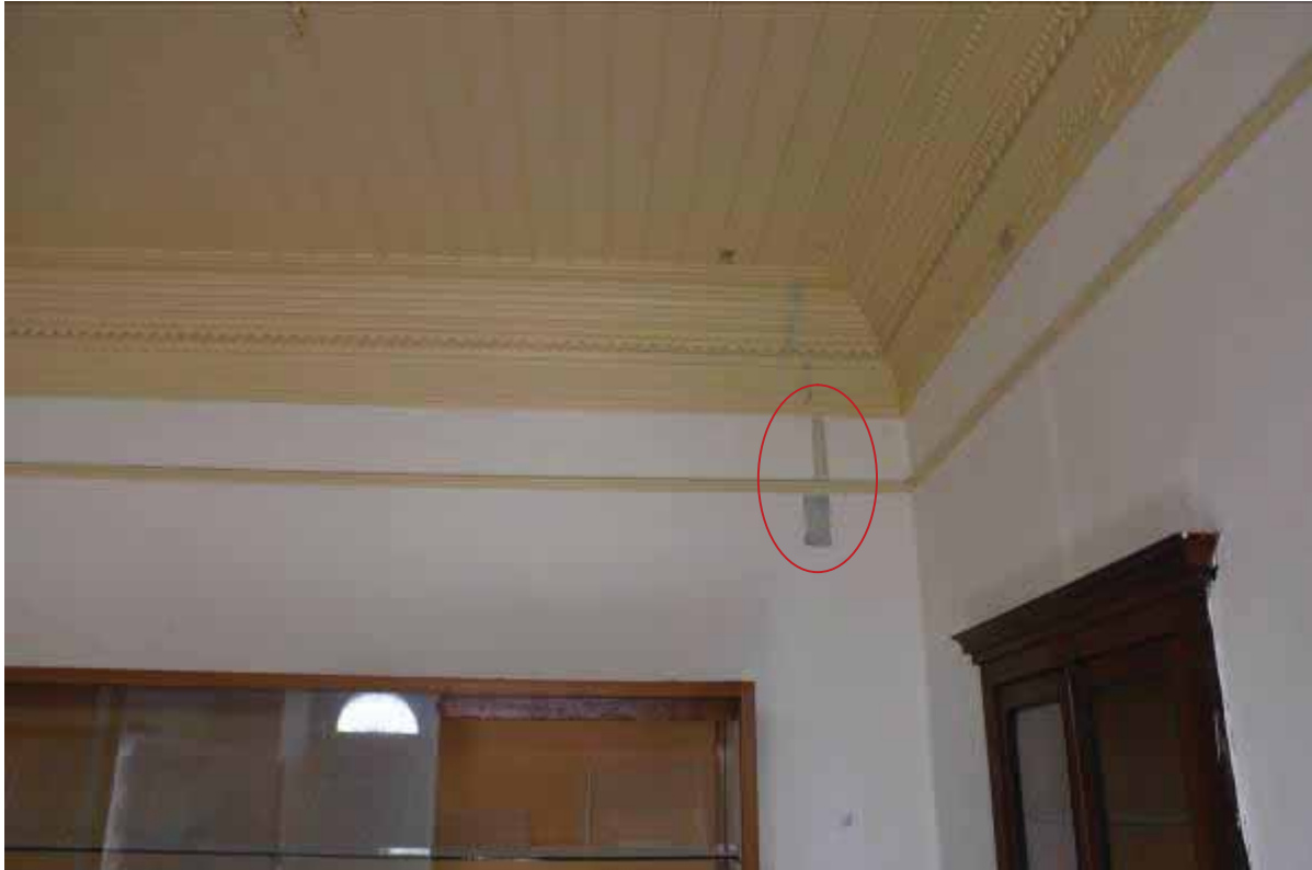
Φωτ. 140 Διερευνητικές τομές στην ανώτερη περιοχή των κατακόρυφων τοίχων, κάτω από την ξύλινη οροφή του χώρου Α3.
