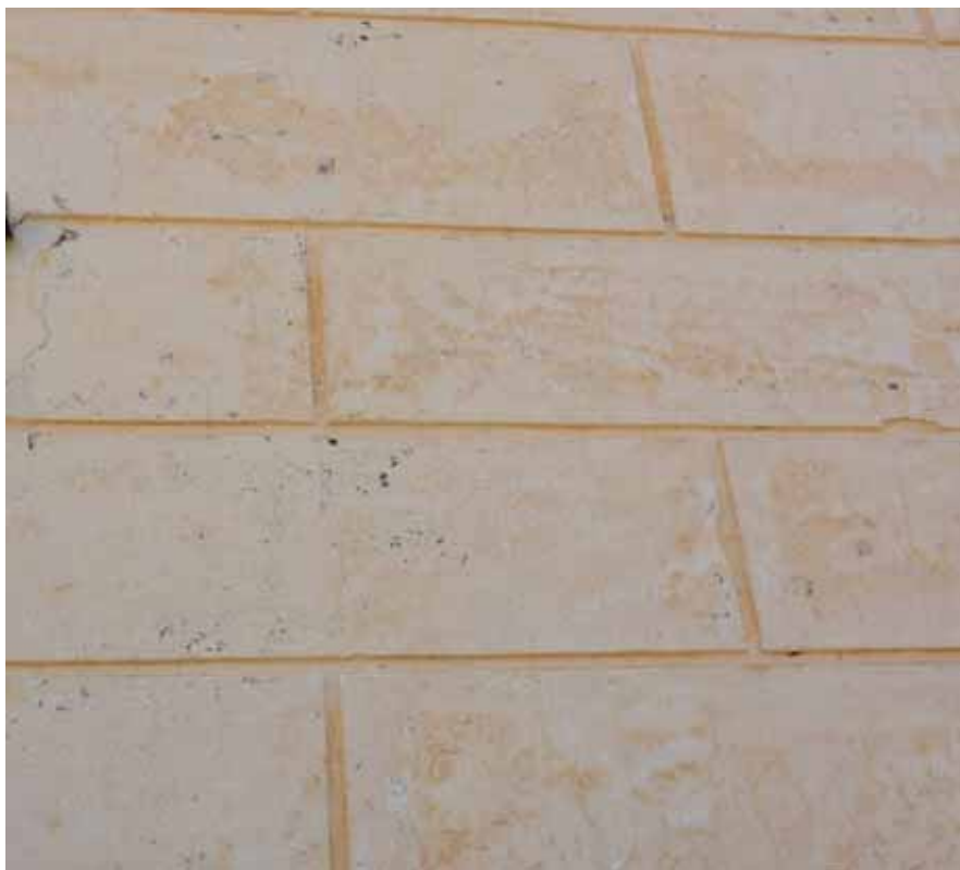
Φωτ. 11 Η επισήμανση του ισόδομου συστήματος δόμησης με επίπλαστο κονίαμα στην νότια και δυτική όψη του ισογείου και του α' ορόφου
