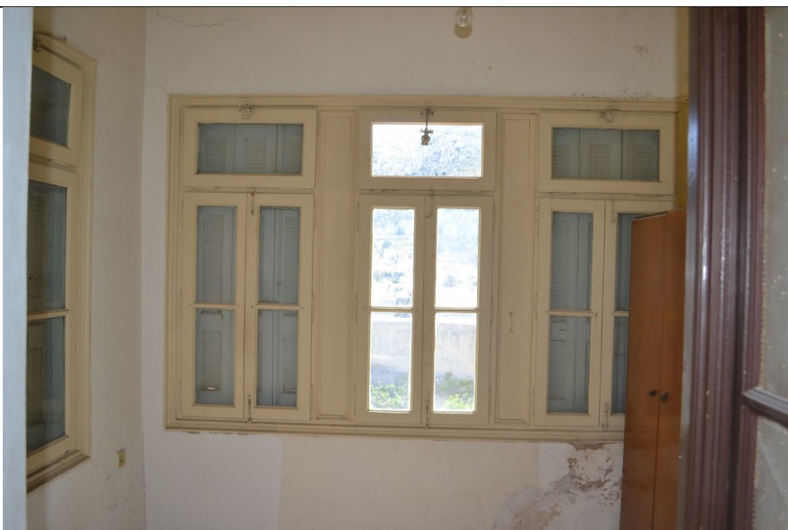
Εικ.135: Χώρος Α4
