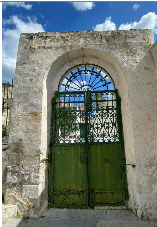
Εικ.13: Εσωτερική όψη αυλόθυρας
