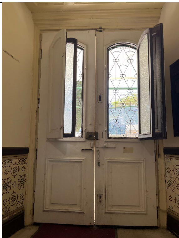
Εικ.58: Κεντρική θύρα εισόδου, εσωτερική όψη
