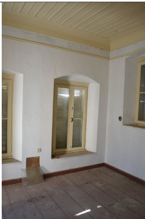
Εικ.155: Χώρος B4
