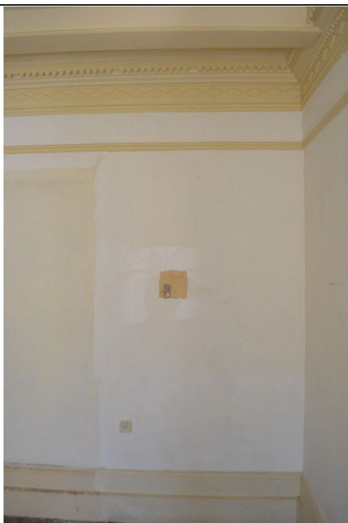
Εικ.65: Χώρος ΙΣ2 (γραφείο)
