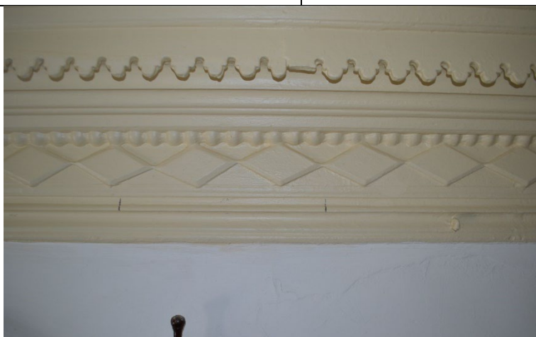
Εικ.67: Χώρος ΙΣ2 (γραφείο) – λεπτομέρεια ταβανιού
