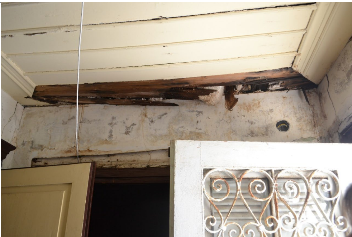
Εικ.150: Χώρος B1
