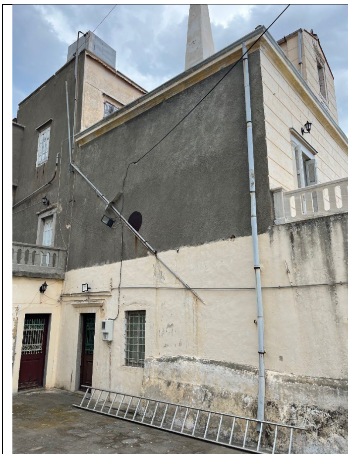
Εικ.47: Δυτικό τμήμα βόρειας όψης
