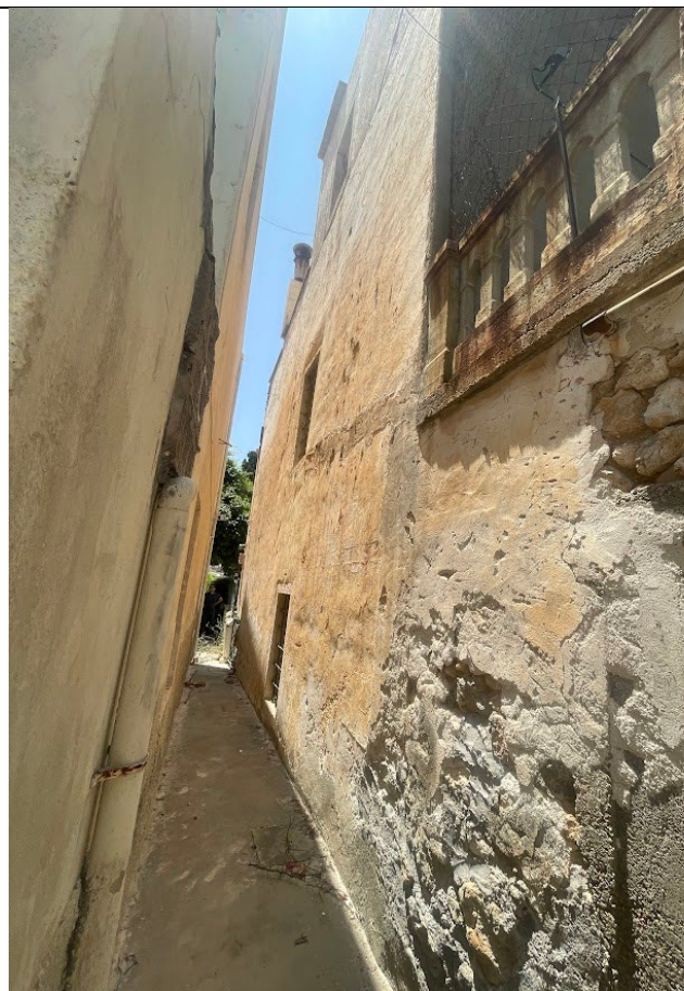
Εικ.52: Ανατολική όψη (άποψη από Β)
