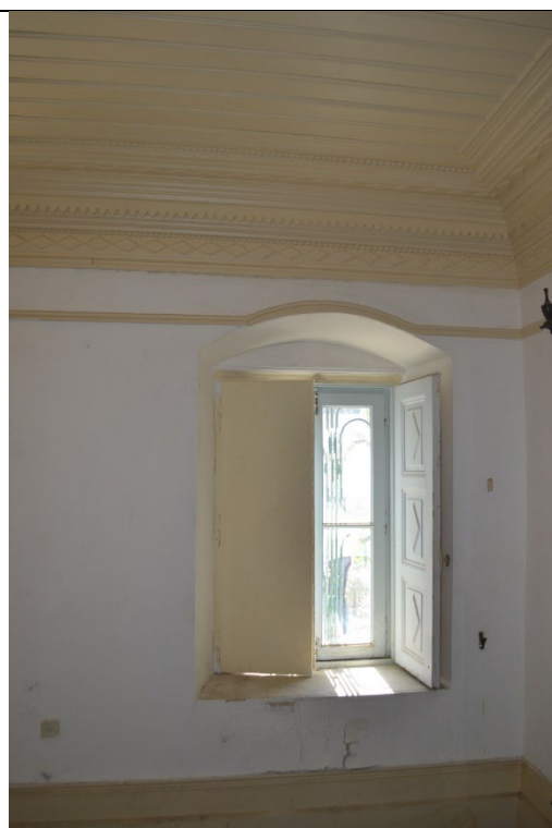
Εικ.64: Χώρος ΙΣ2 (γραφείο)
