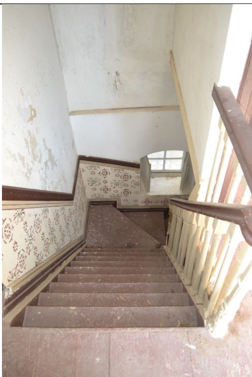
Εικ.142: Χώρος Β1
