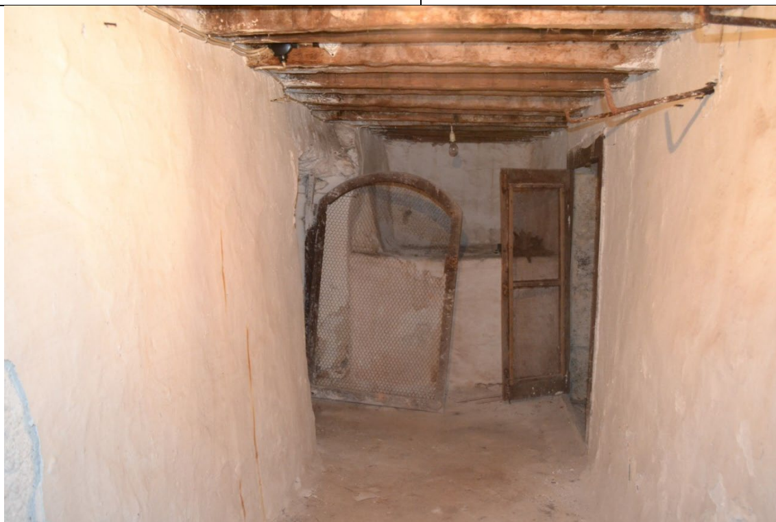
Εικ. 53: Άποψη υπογείου
