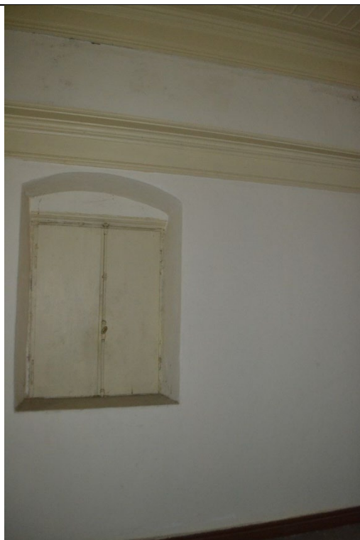
Εικ.119: Χώρος Α5
