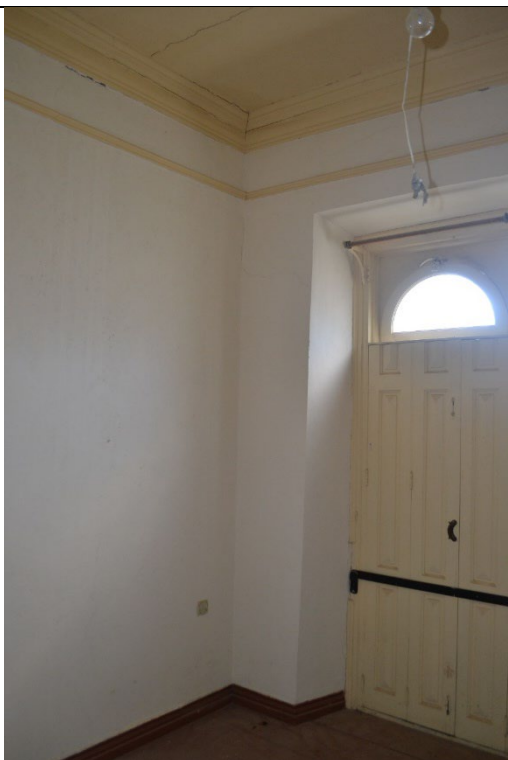
Εικ.123: Χώρος Α5
