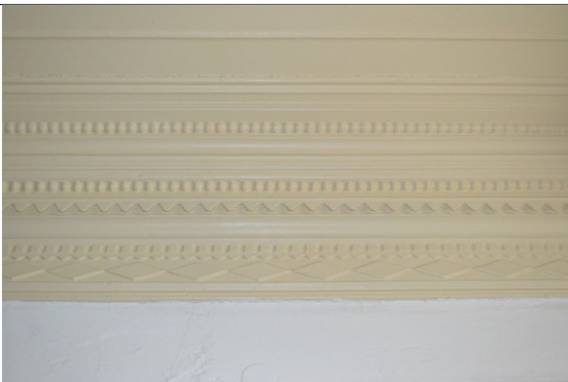
Εικ.134: Χώρος Α3
