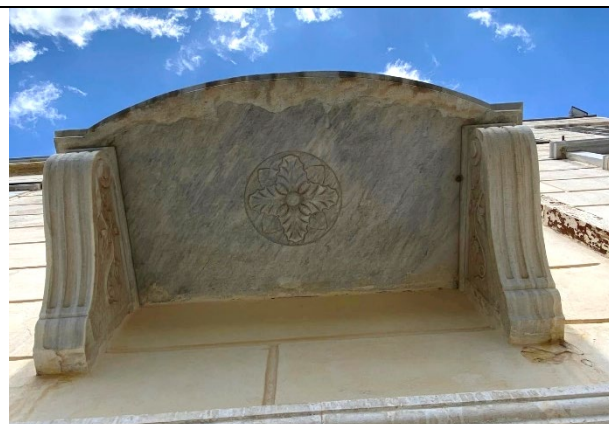
Εικ.26: Κάτω όψη εξώστη νότιας όψης χώρου Α2 (2 ου από δυτικά)
