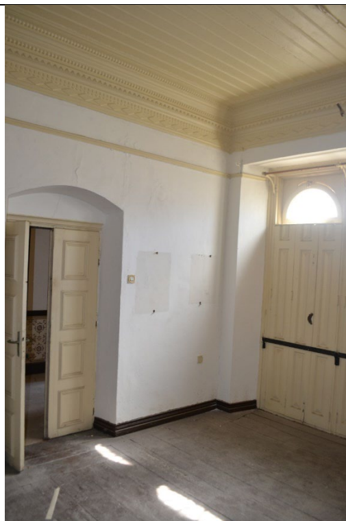
Εικ.132: Χώρος Α3
