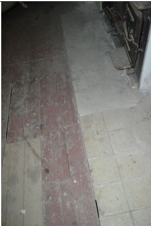
Εικ.93: Δάπεδο χώρου ΙΣ6Α
