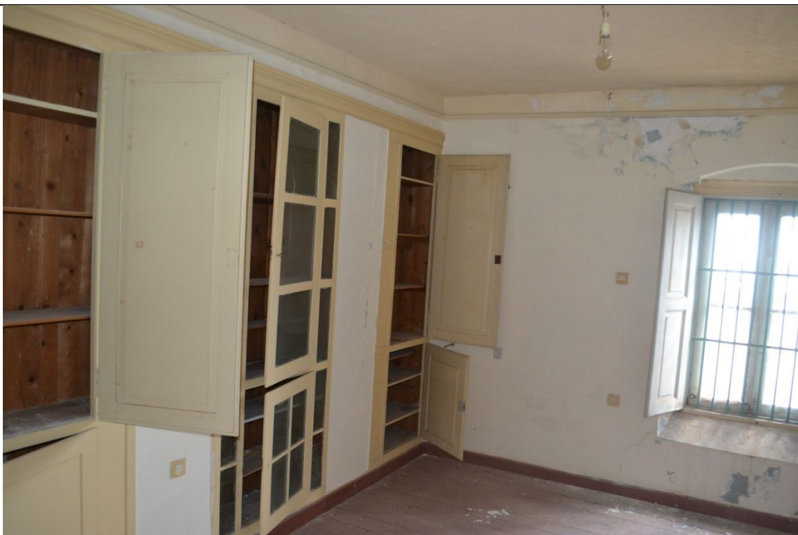
Εικ.144: Χώρος B2
