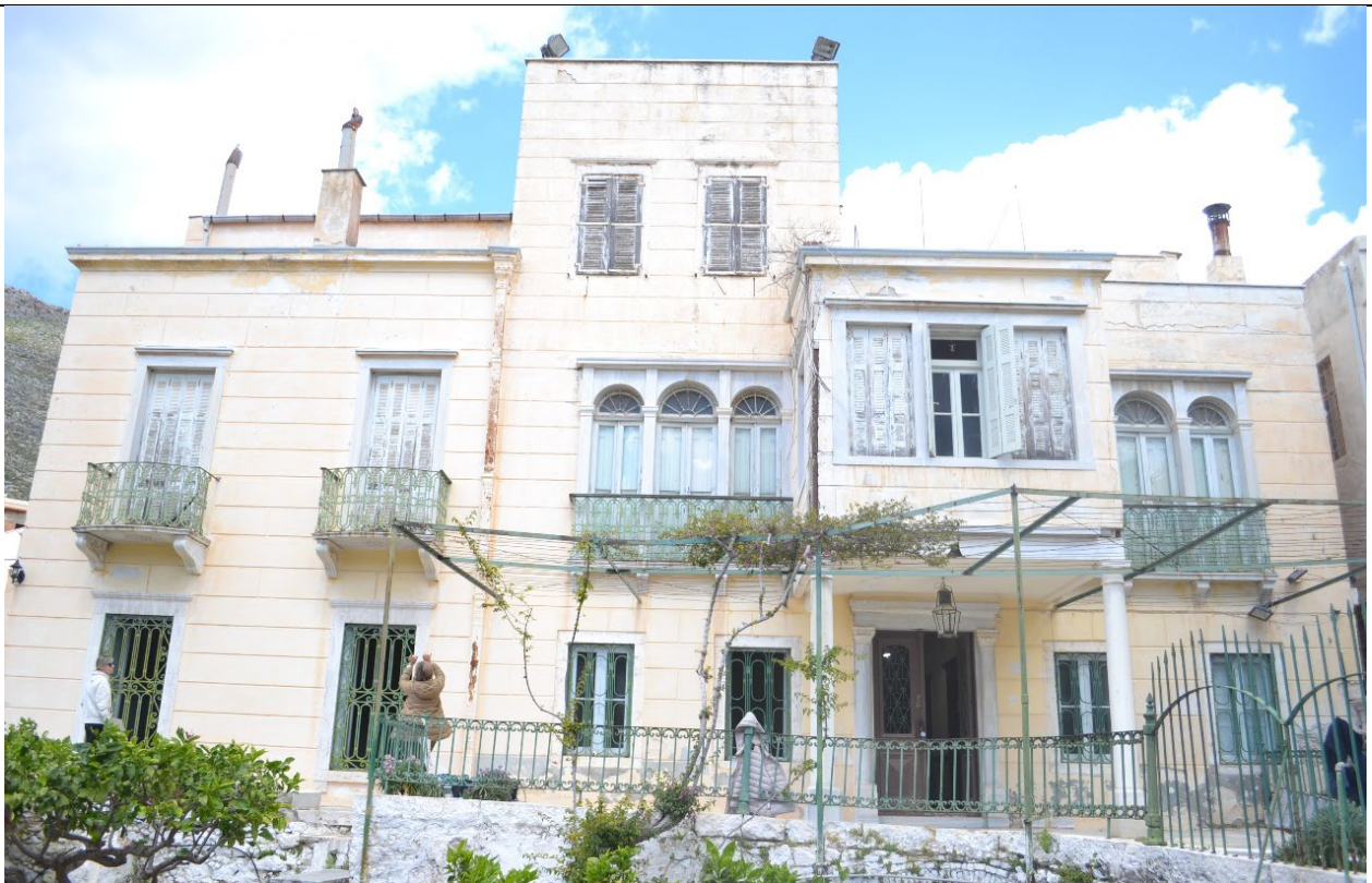
Εικ.10: Ανατολική όψη (πρόσοψη)
