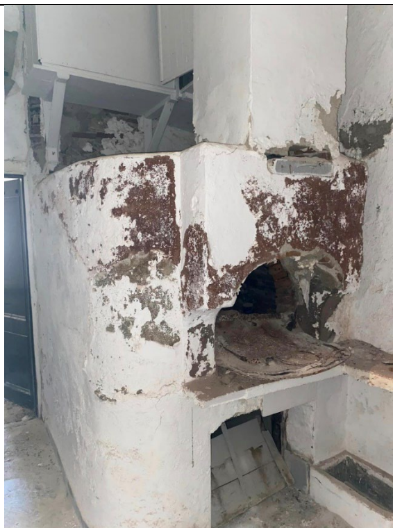
Εικ.102: Κτιστός ξυλόφουρνος του χώρου ΙΣ8
