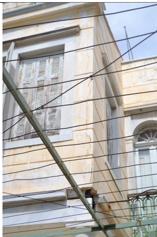
Εικ.17: Κεντρικό τμήμα της νότιας όψης - λεπτομέρεια
