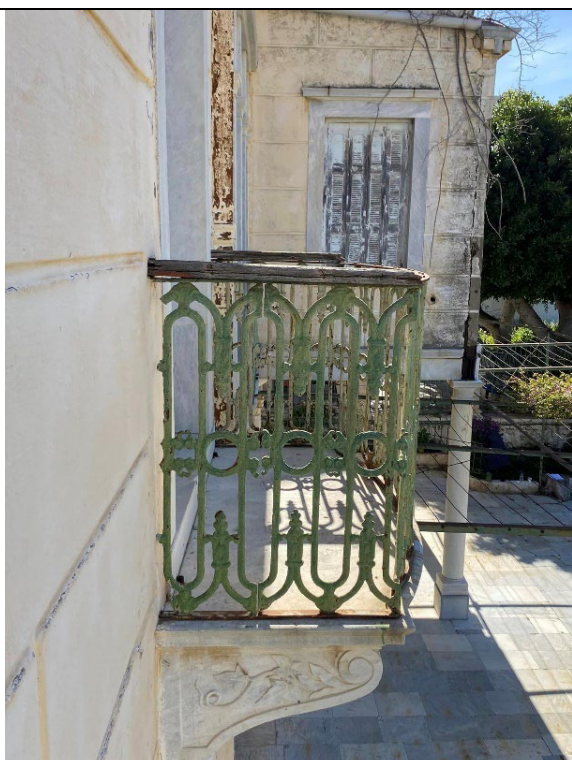
Εικ.29: Δυτική όψη εξώστη νότιας όψης χώρου Α2 (2 ου από δυτικά)
