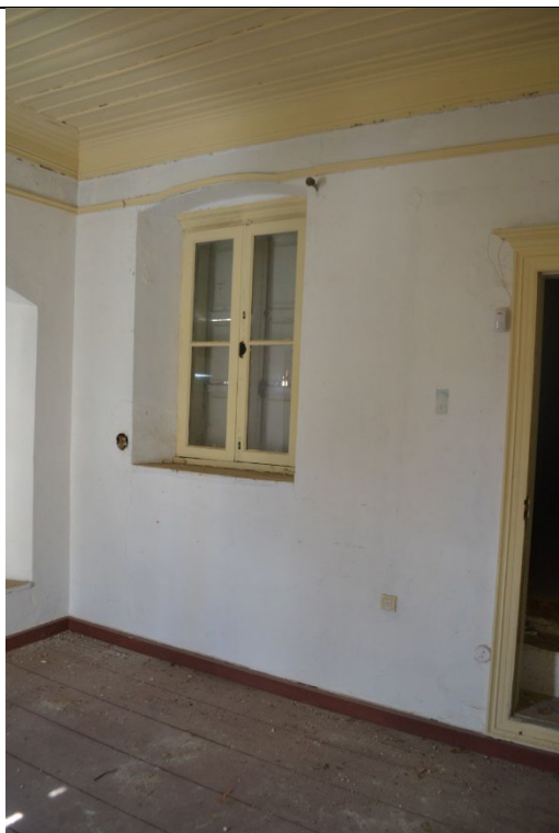
Εικ.156: Χώρος Β4
