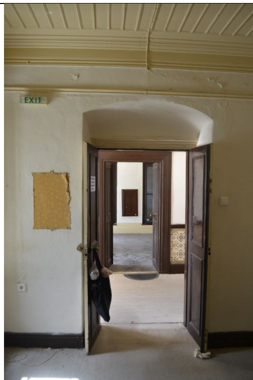
Εικ.70: Θύρα χώρου ΙΣ3 – άποψη προς ΙΣ 1Α και ΙΣ2
