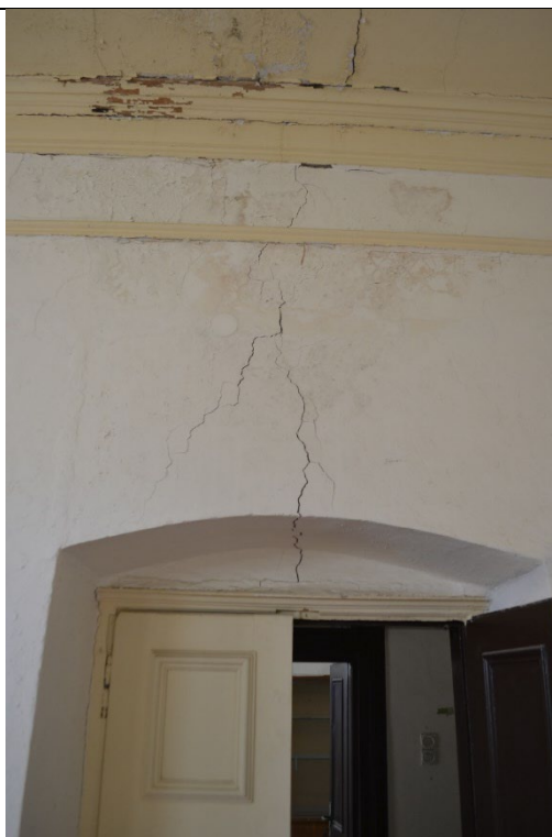
Εικ.126: Χώρος Α5
