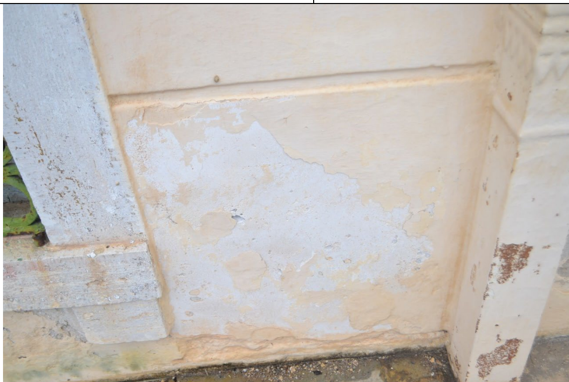
Εικ.23: Δυτικό τμήμα της νότιας όψης - λεπτομέρεια
