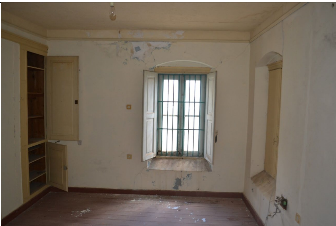
Εικ.145: Χώρος B2
