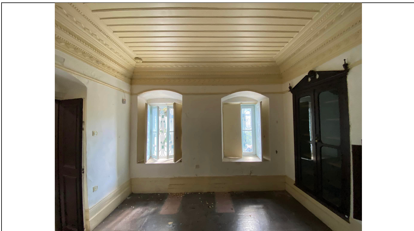
Εικ.62: Χώρος ΙΣ2 (γραφείο)
