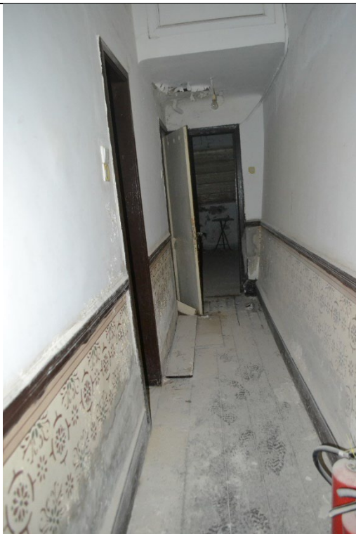
Εικ.97: Διάδρομος ΙΣ7
