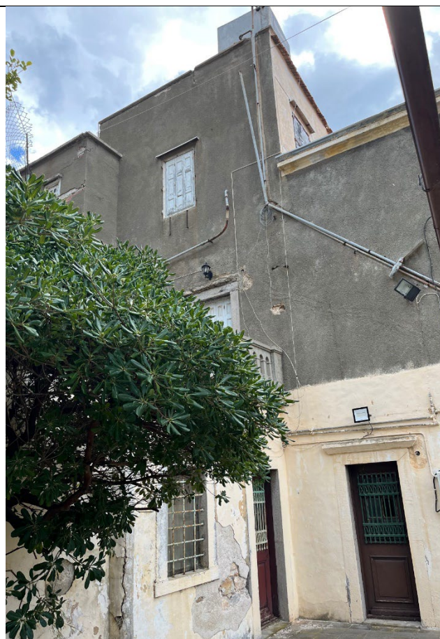
Εικ.48: Τμήμα βόρειας όψης
