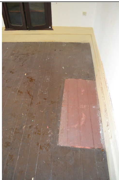
Εικ.66: Χώρος ΙΣ2 (γραφείο)
