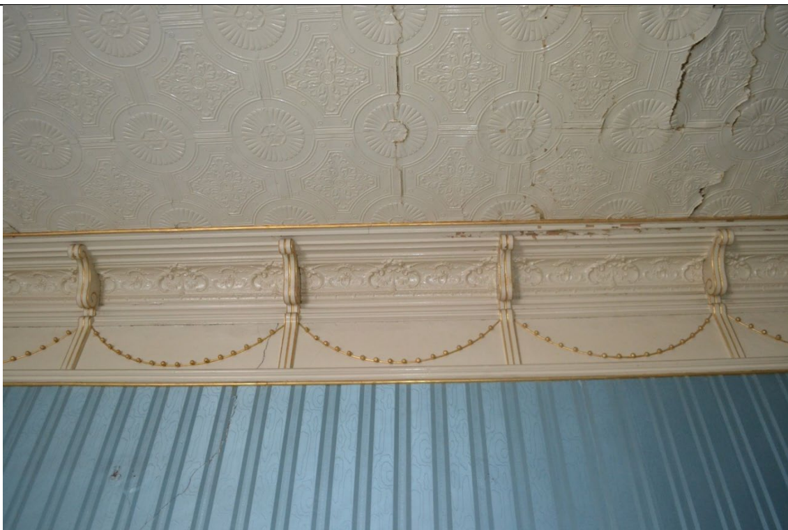
Εικ.115: Λεπτομέρεια οροφής χώρου Α2 (σαλόνι)
