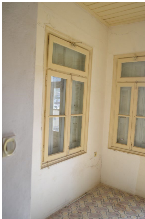
Εικ.137: Χώρος Α4
