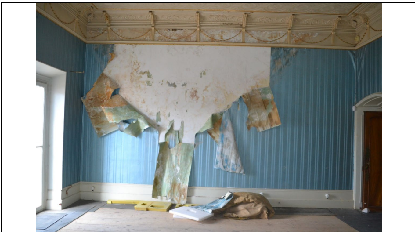
Εικ.105: Χώρος Α2 (σαλόνι) – βόρειος τοίχος
