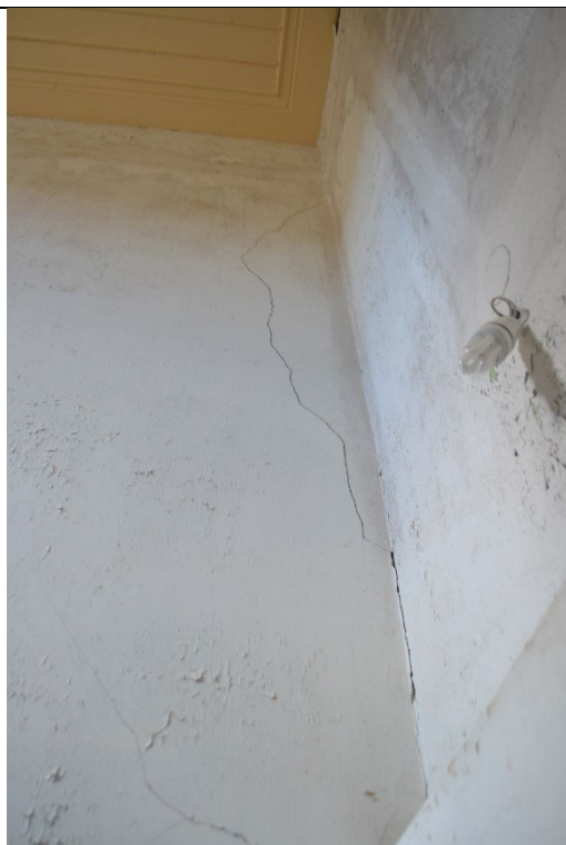
Εικ.140: Χώρος Β1
