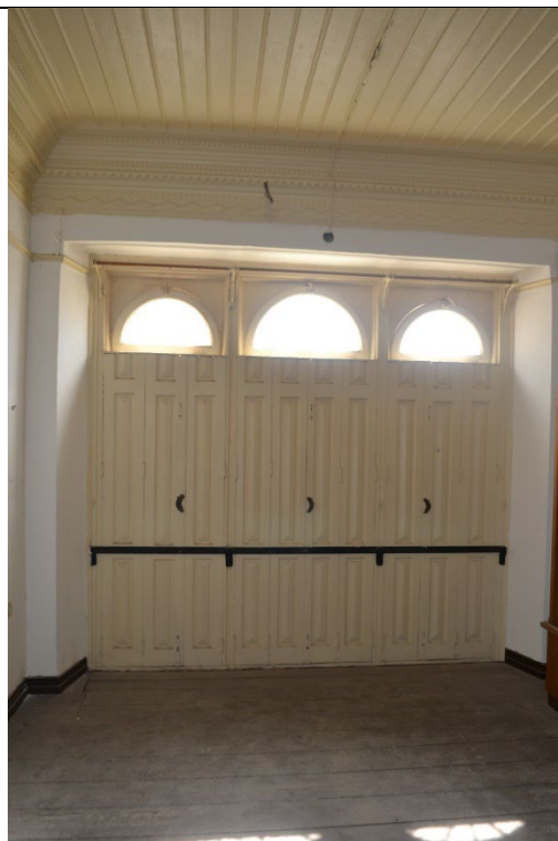
Εικ.128: Χώρος Α3
