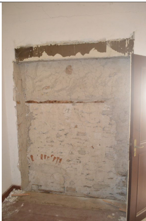
Εικ.153: Χώρος B4
