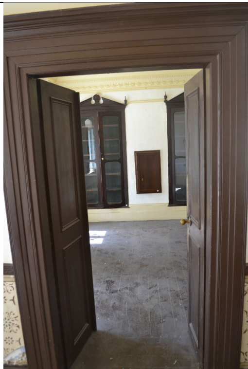
Εικ.60: Χώρος ΙΣ2 (Γραφείο)
