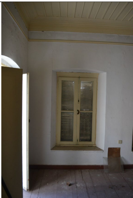
Εικ.154: Χώρος B4
