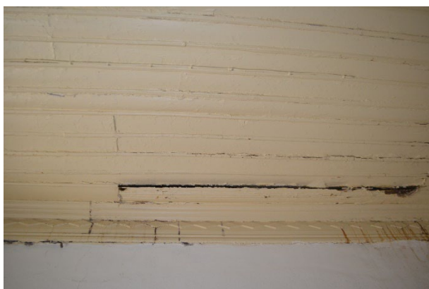
Εικ.125: Χώρος Α5
