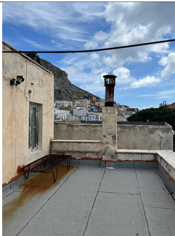
Εικ.36: Δώμα χώρου A5 – μεταλλική καμινάδα
