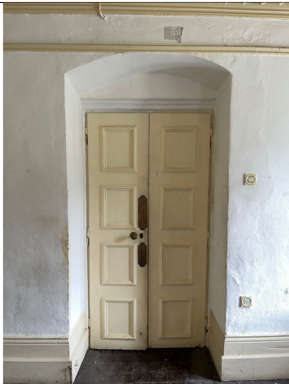
Εικ.61: Θύρα χώρου ΙΣ2 (εσωτερική όψη)
