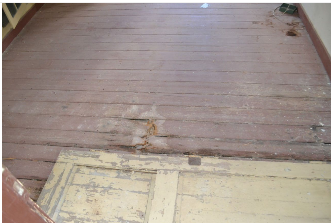
Εικ.147: Χώρος Β2
