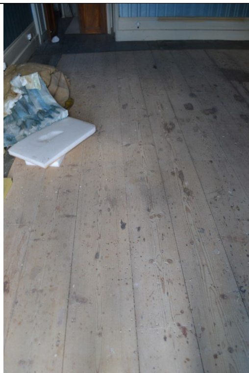
Εικ.113: Δάπεδο χώρου Α2 (σαλόνι)
