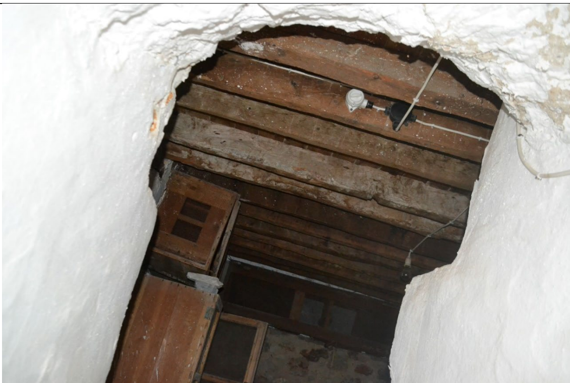
Εικ. 55: Άποψη υπογείου
