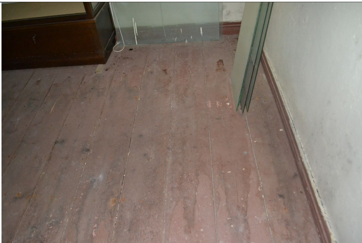
Εικ.121: Χώρος Α5
