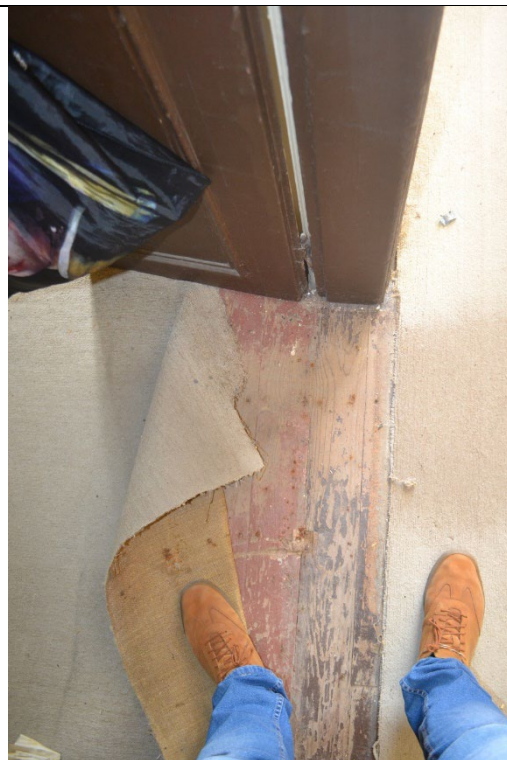
Εικ.72: Δάπεδο χώρου ΙΣ3
