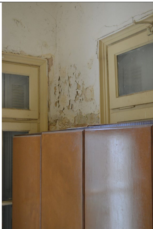
Εικ.136: Χώρος Α4
