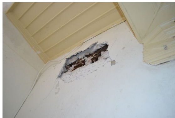
Εικ.141: Χώρος Β1
