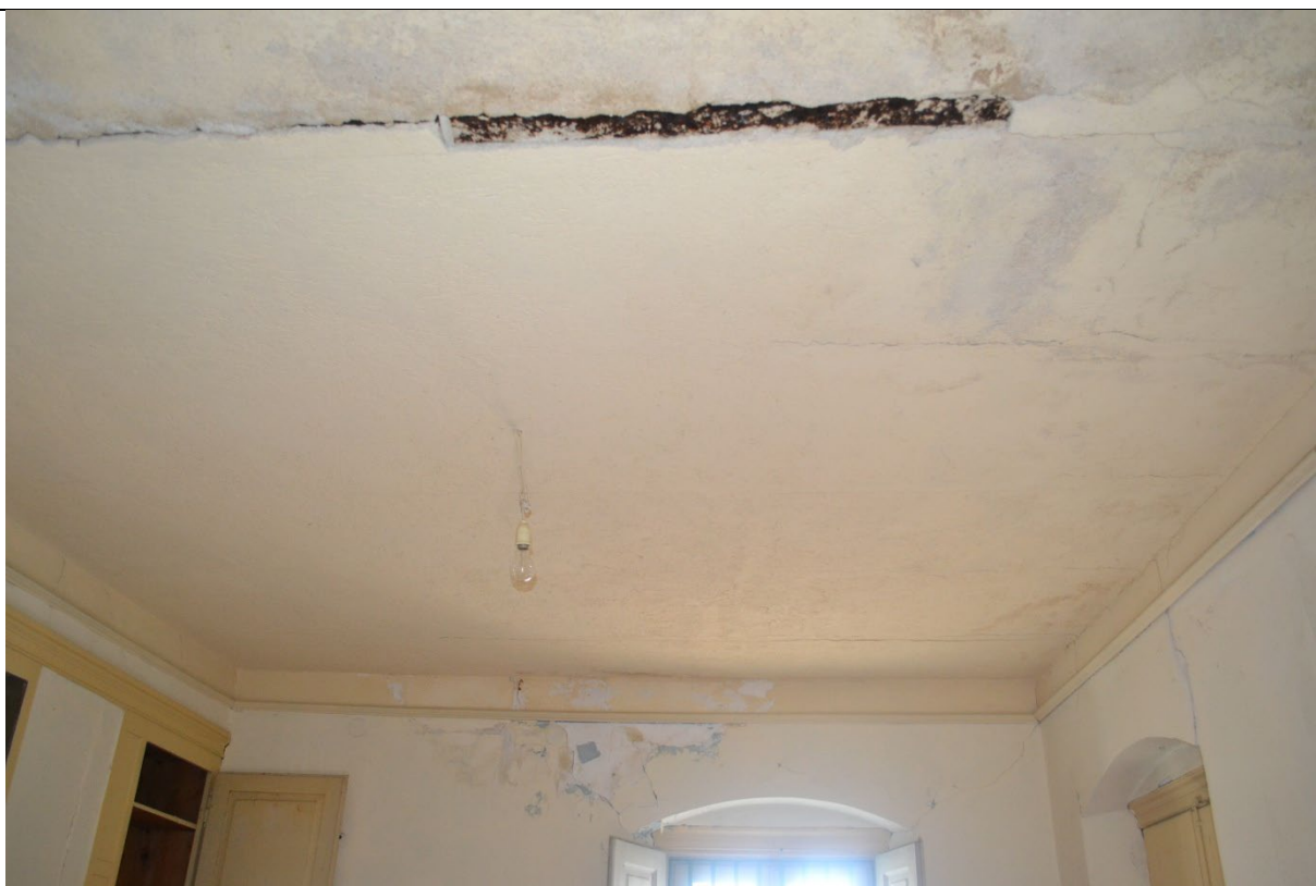
Εικ.148: Χώρος Β2
