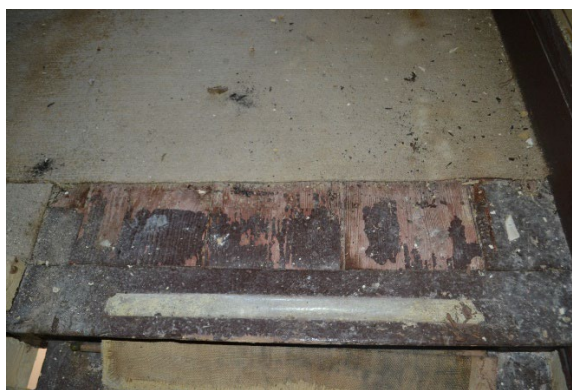
Εικ.117: Διάδρομος Α1Α – λεπτομέρεια δαπέδου
