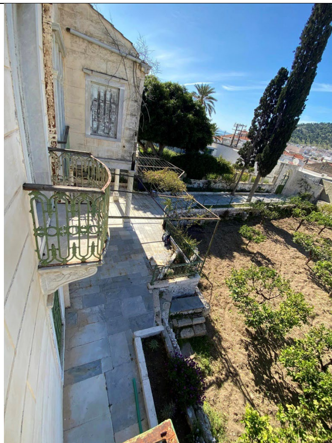
Εικ.11: Περιβάλλον χώρος – νότιο τμήμα
