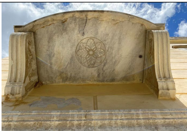
Εικ.25: Κάτω όψη εξώστη νότιας όψης χώρου Α2 (1 ου από δυτικά)
