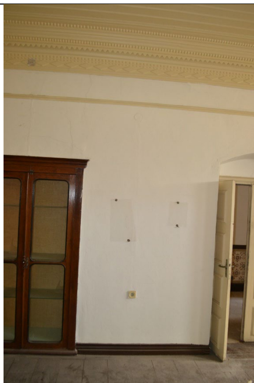
Εικ.130: Χώρος Α3
