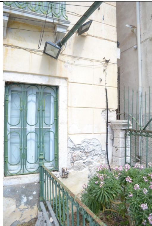
Εικ.32: Νότια όψη, ανατολικό τμήμα - λεπτομέρεια
