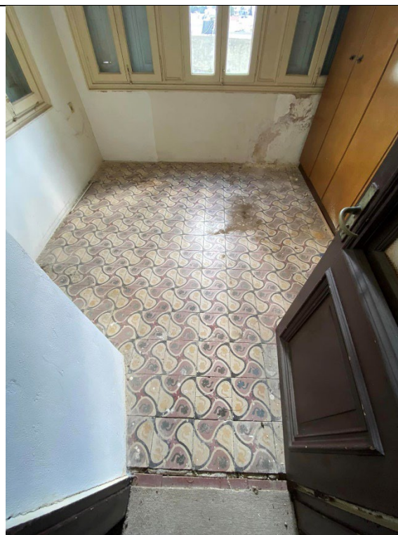
Εικ.139: Τσιμεντοπλακίδια στο δάπεδο του χώρου Α4
