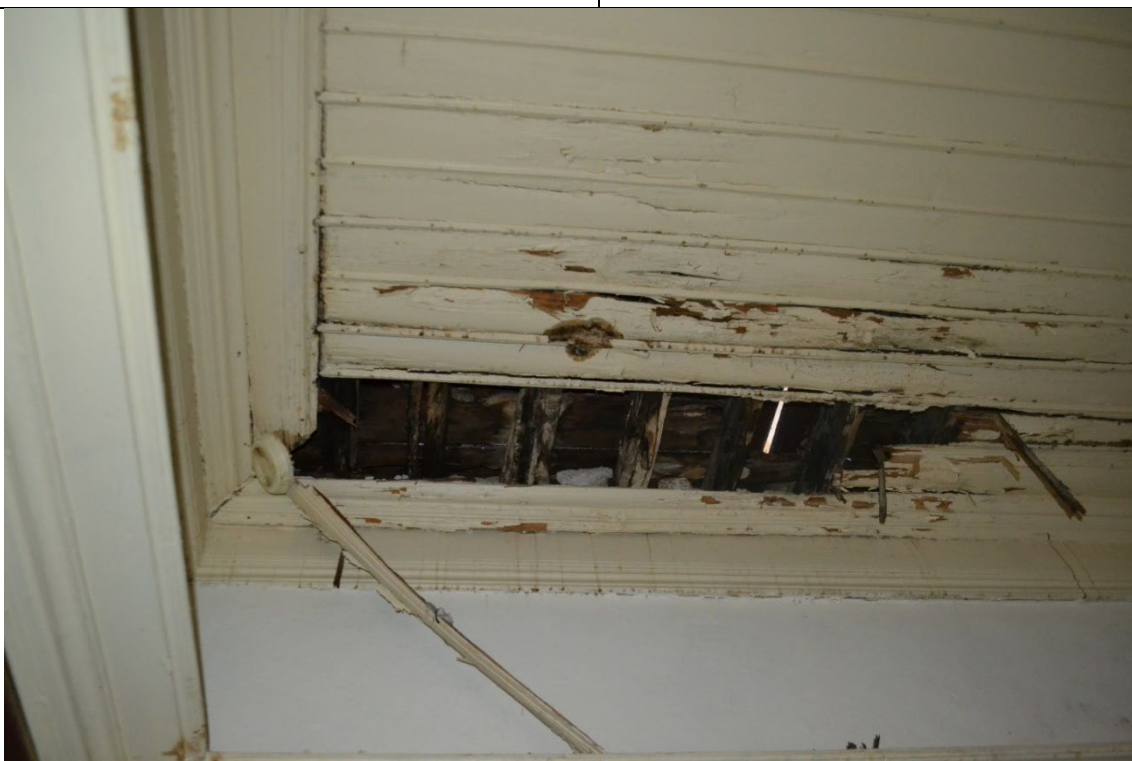
Εικ.120: Χώρος Α5
