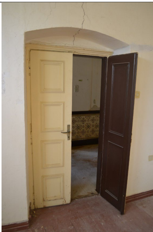
Εικ.124: Χώρος Α5
