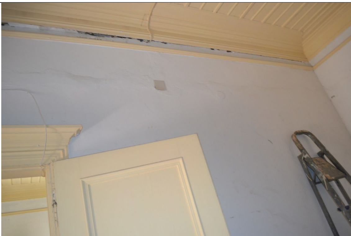
Εικ.151: Χώρος B3
