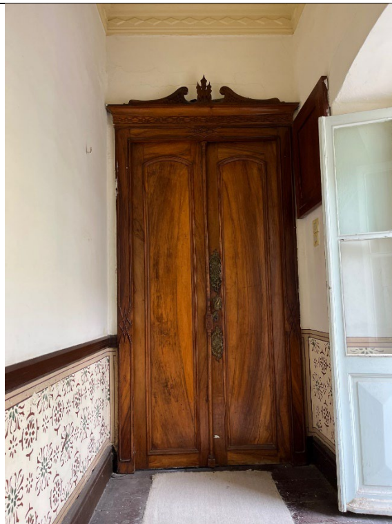
Εικ.104: Ξύλινη πόρτα χώρου Α2
