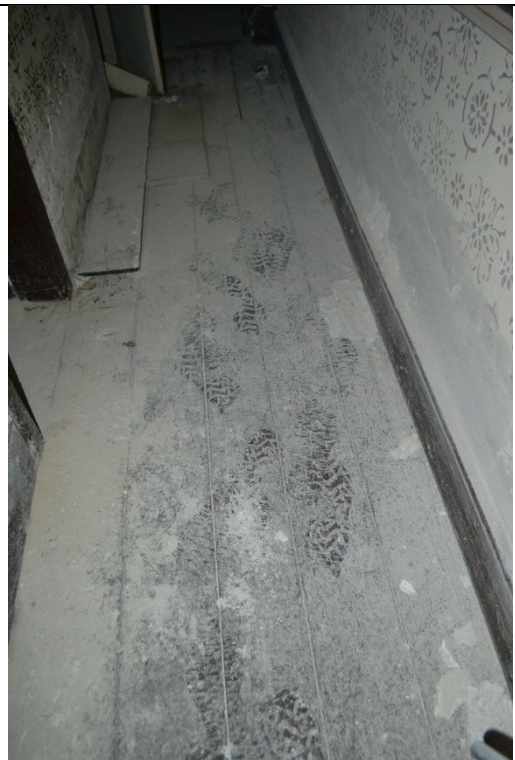
Εικ.98: Διάδρομος ΙΣ7 - δάπεδο
