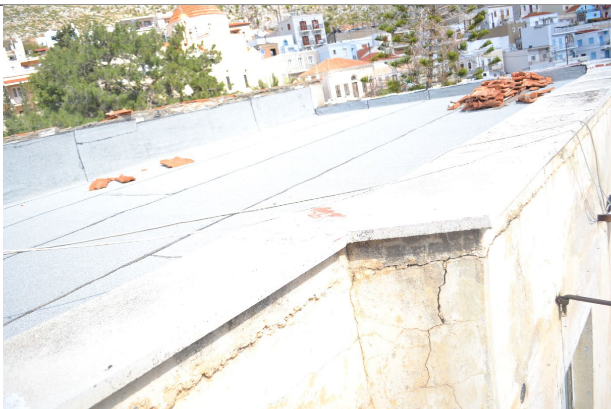
Εικ.38: Δώμα χώρου B2
