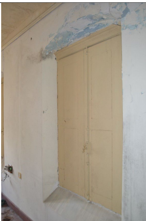
Εικ.146: Χώρος Β2
