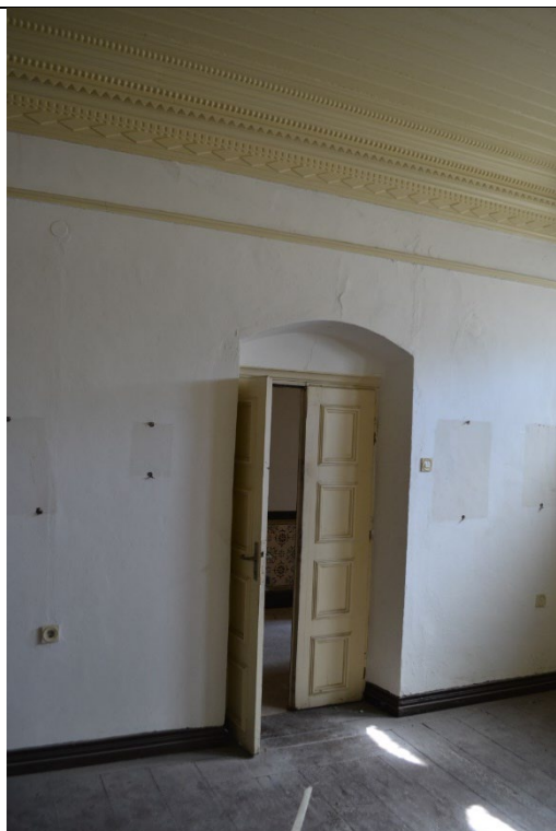
Εικ.131: Χώρος Α3
