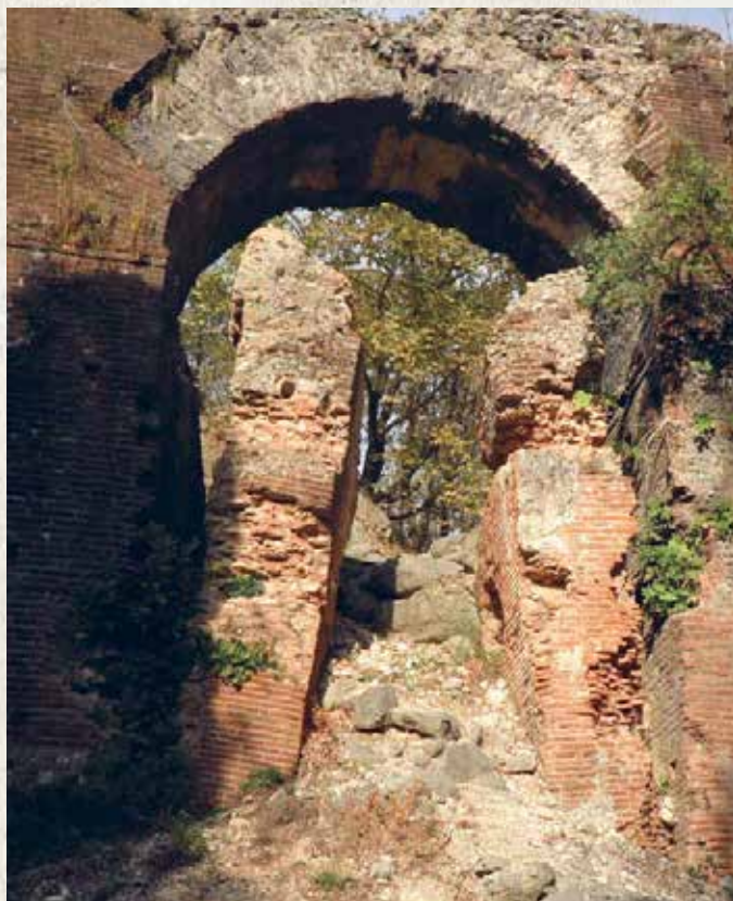
Ανεξάρτητες τοξοειδείς κατασκευές που κατασκευάστηκαν σε μεταγενέστερο στάδιο / Free standing arch - like structures built at a later stage
