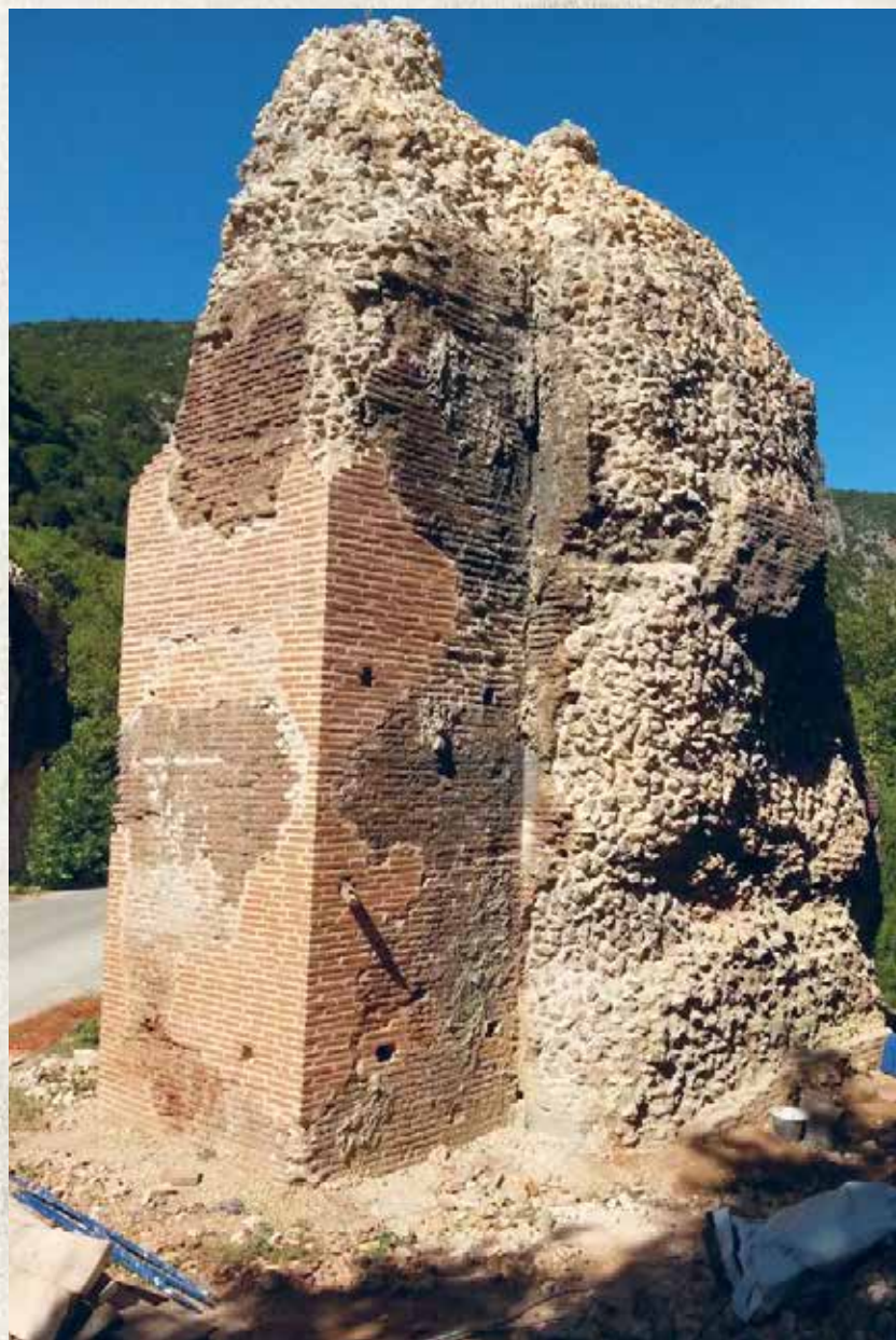
Πεσσός στην περιοχή του Αγίου Γεωργίου μετά τις εργασίες αποκατάστασης / Pier in the area of Aghios Georgios after conservation and restoration works
